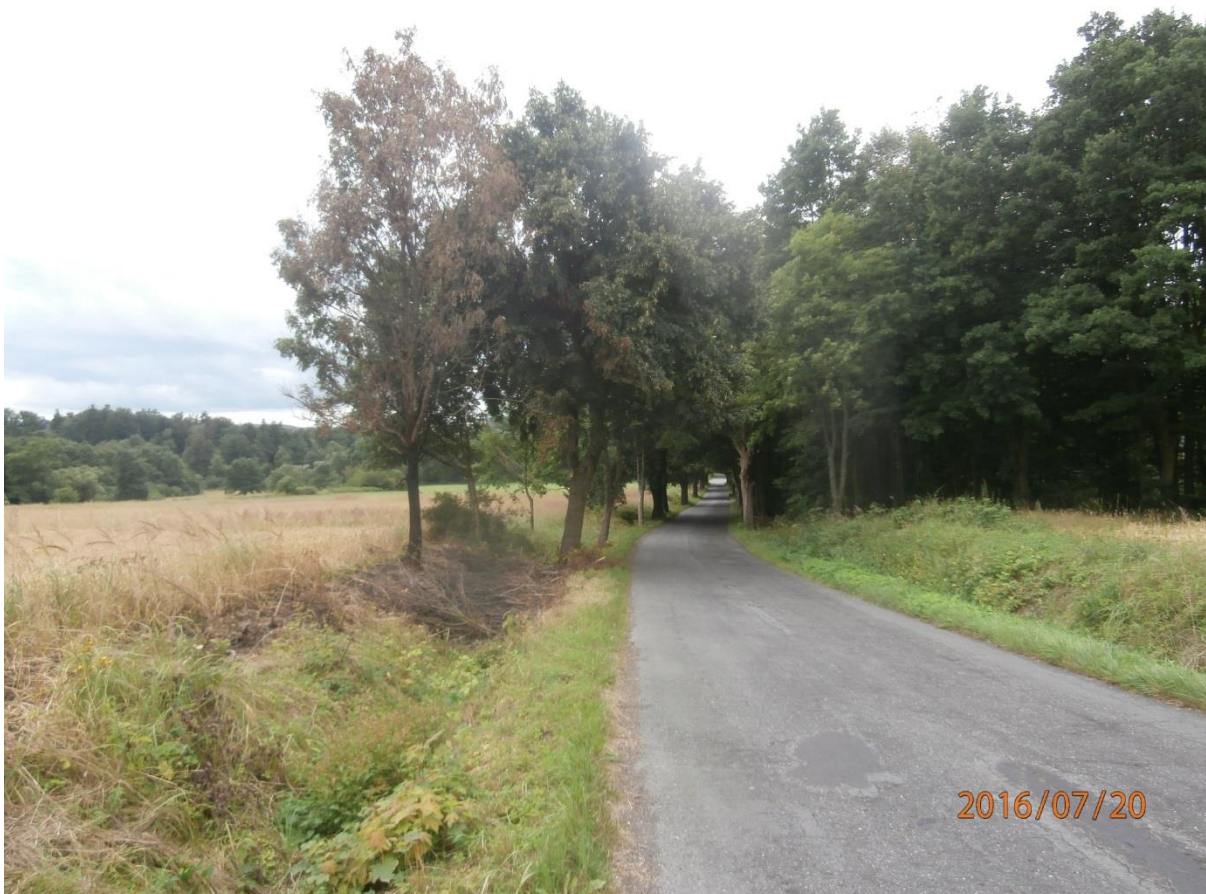
Rysunek 8 – Odcinek drogi powiatowej nr 3233D przebiegający przez obszar prawobrzeżnego przyczółka zapory, widok w kierunku zachodnim.
