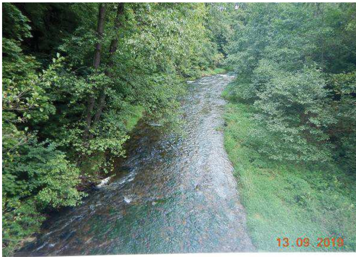
Fot. 78 c.d. Ukształtowanie linii brzegu lewego i budowa umocnienia skarpy na odc. km 24+840 ÷ 25+261 [widok z mostu M-31]
