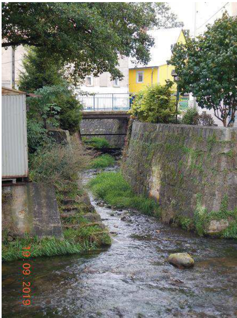
Fot. 18 Remont odcinka ujściowego potoku Rudawka w km 30+935 (BL)
