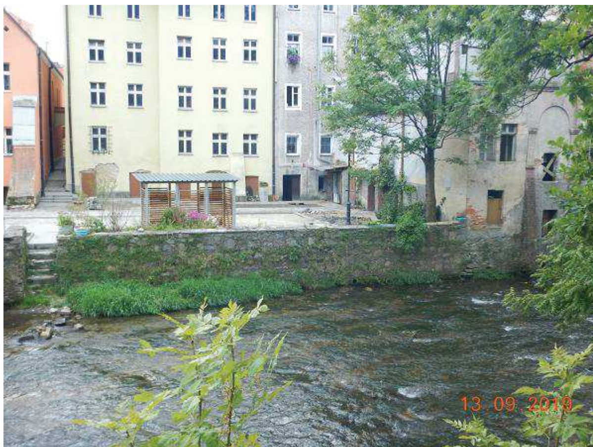
Fot. 29 Reprofilacja muru lewobrzeżnego z odsadzką na odc. km 23+260 ÷ 23+280
