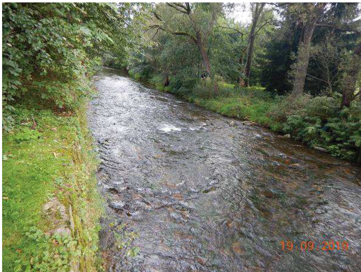
Fot. 5 Ukształtowanie linii brzegu prawego z budową umocnienia skarpy na odc. km 21+560 ÷ 21+945. Reprofilacja muru lewobrzeżnego na odc. km 21+945 ÷ 22+422. Odbudowa i udrożnienie koryta wylotowego przepustu w km 21+920 na BL. [widok koryta od GW]
