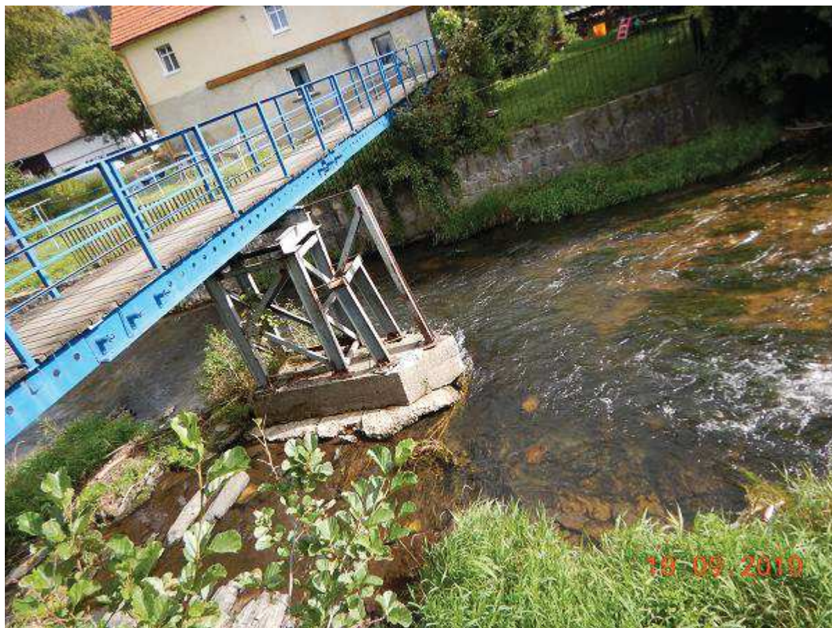
Fot. 15 Usunięcie odkładu wzdłuż brzegu lewego dla udroźnienia światła kładki M-23 w km 22+904 z przebudową filara [widok od GW]
