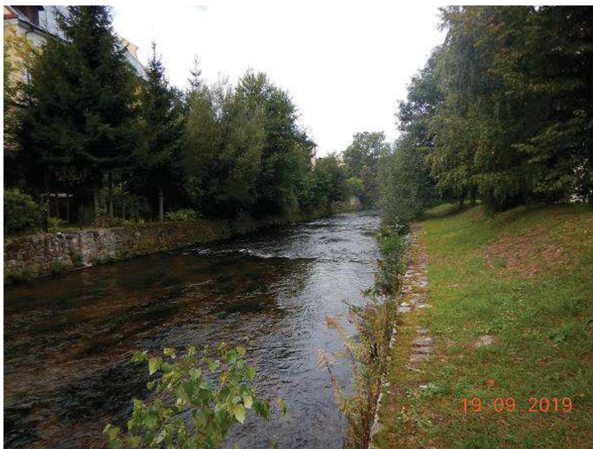
Fot. 22 c.d. Reprofilacja muru prawobrzeżnego na odcinku km 23+000 ÷ 23+200. Usunięcie krzewów i zakrzaczeń. [widok koryta od GW]
