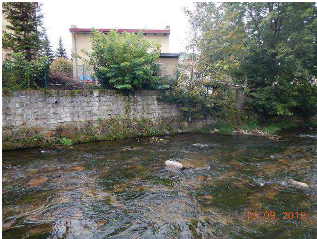
Fot. 19 Reprofilacja muru lewobrzeżnego na odcinku km 22+980 ÷ 23+090. Oczyszczenie z krzewów i zakrzaceń. [widok koryta od GW]
