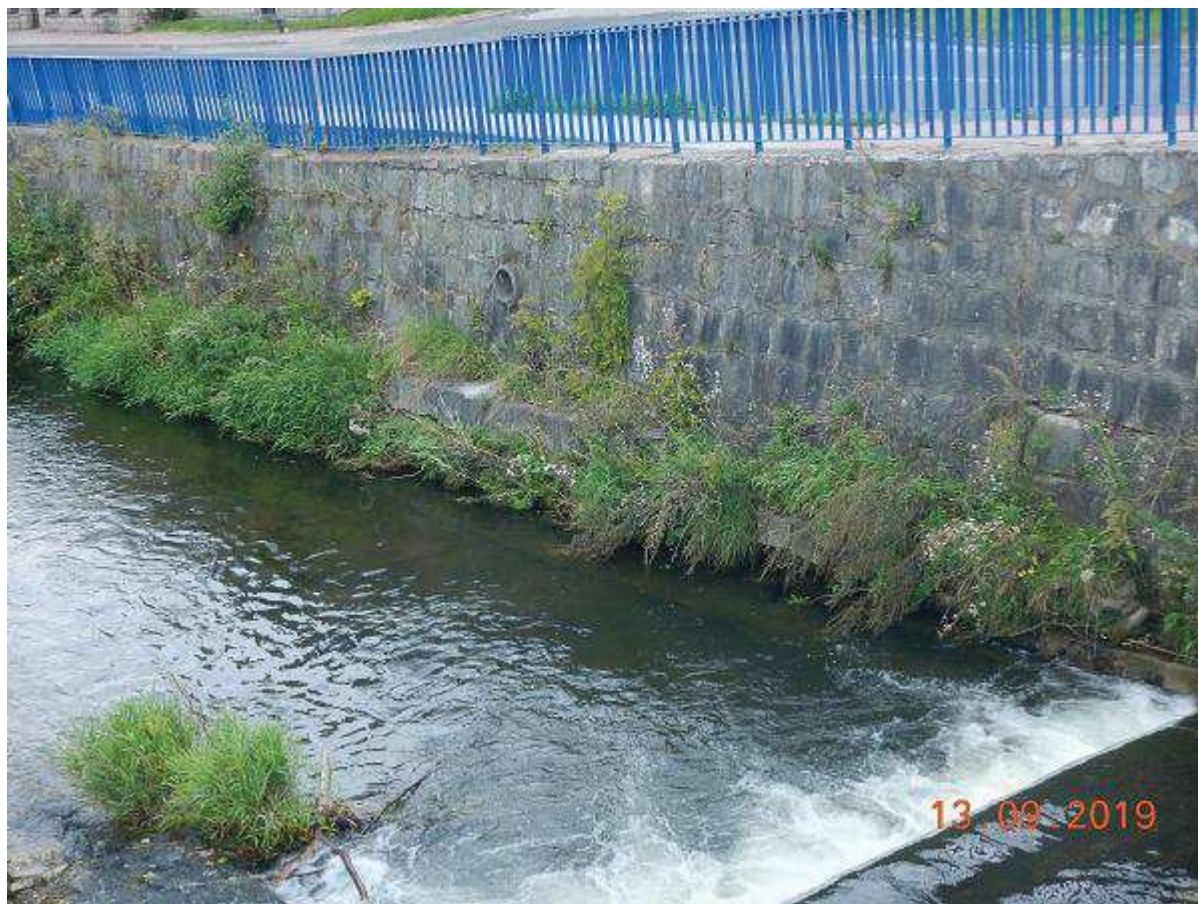
Fot. 52 c.d. Reprofilacja murów korytowych i brzegowych rzeki w obrębie węzła wodnego km 23+685 ÷ 23+800 [widok BP]
