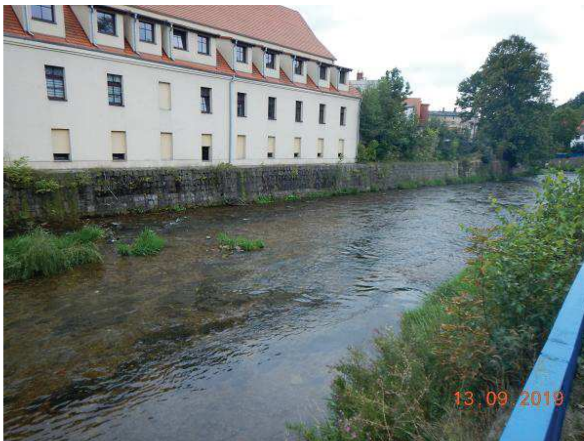
Fot. 41 Reprofilacja muru lewobrzeżnego z odsadzką na odc. km 23+620 ÷ 23+685 [widok od GW]
