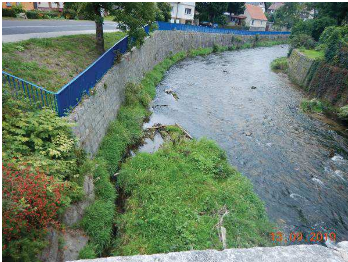
Fot. 37 c.d. Usunięcie odkładu wzdłuż brzegu prawego dla udroźnienia światła mostu M-25 w km 23+506 [widok z mostu od GW]
