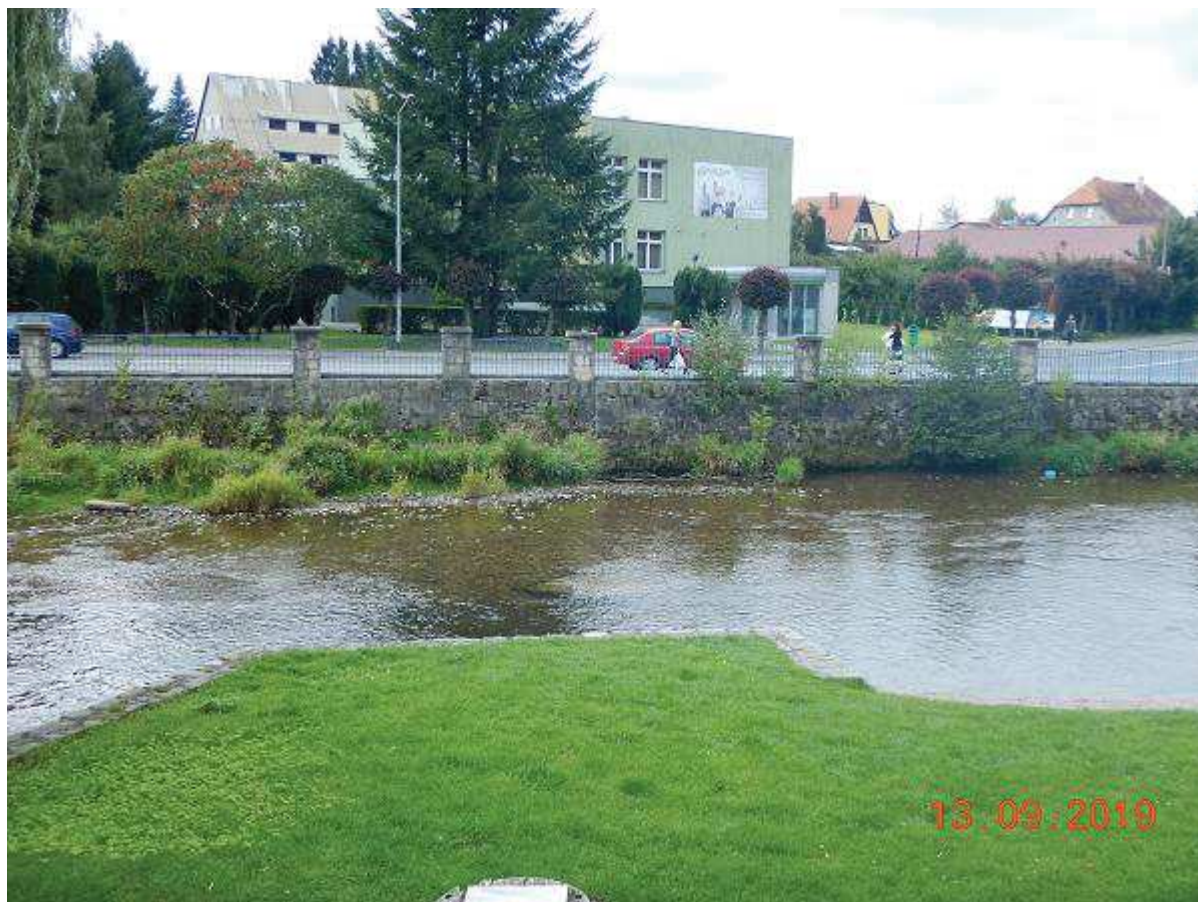
Fot. 54 Reprofilacja lewobrzeżnego muru brzegowego wraz z odsadzką na odc. km 23+800 ÷ 23+900
