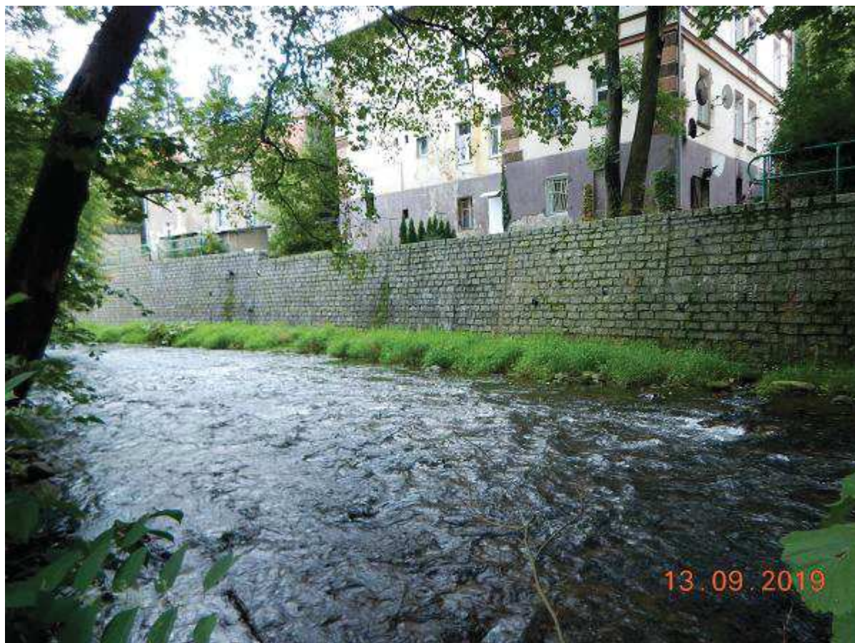
Fot. 74 c.d. Reprofilacja prawego muru brzegowego wraz z odsadzką i odcinkowym usunięciem odsypiska na odc. km 24+667 ÷ 25+100
