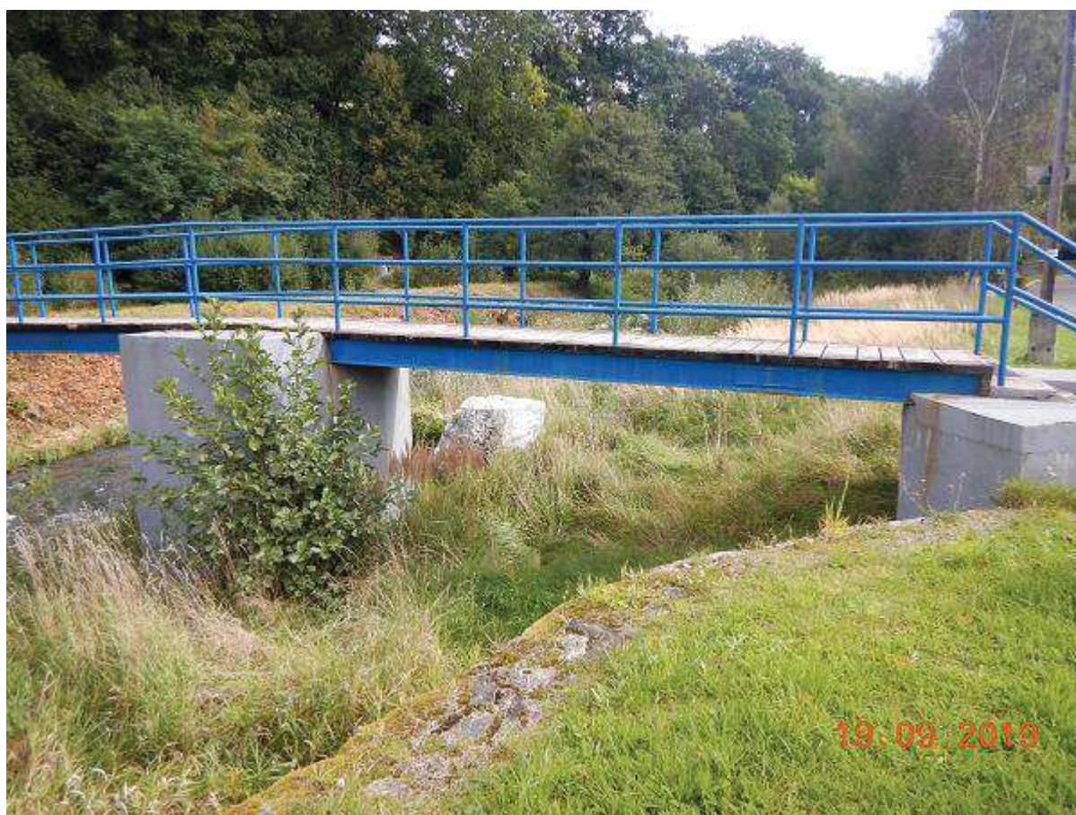
Fot. 8 Usunięcie odkładu wzdłuż brzegu lewego dla udrożnienia światła kładki M-22 w km 22+422 [widok od DW]
