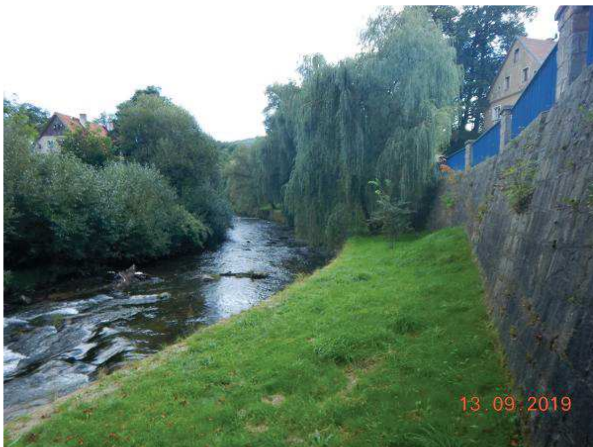
Fot. 61 Wzmocnienie konstrukcji i reprofilacja muru dolinowego (BL) wzdłuż ul. T. Kościuszki na odc. km 23+900 ÷ 24+030 [widok od DW]
