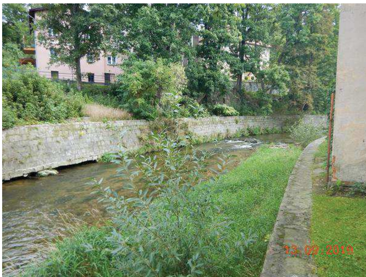
Fot. 59 c.d. Reprofilacja muru prawobrzeżnego wraz z odsadzką w dnie na odc. km 23+942 ÷ 24+350 [widok od DW]
