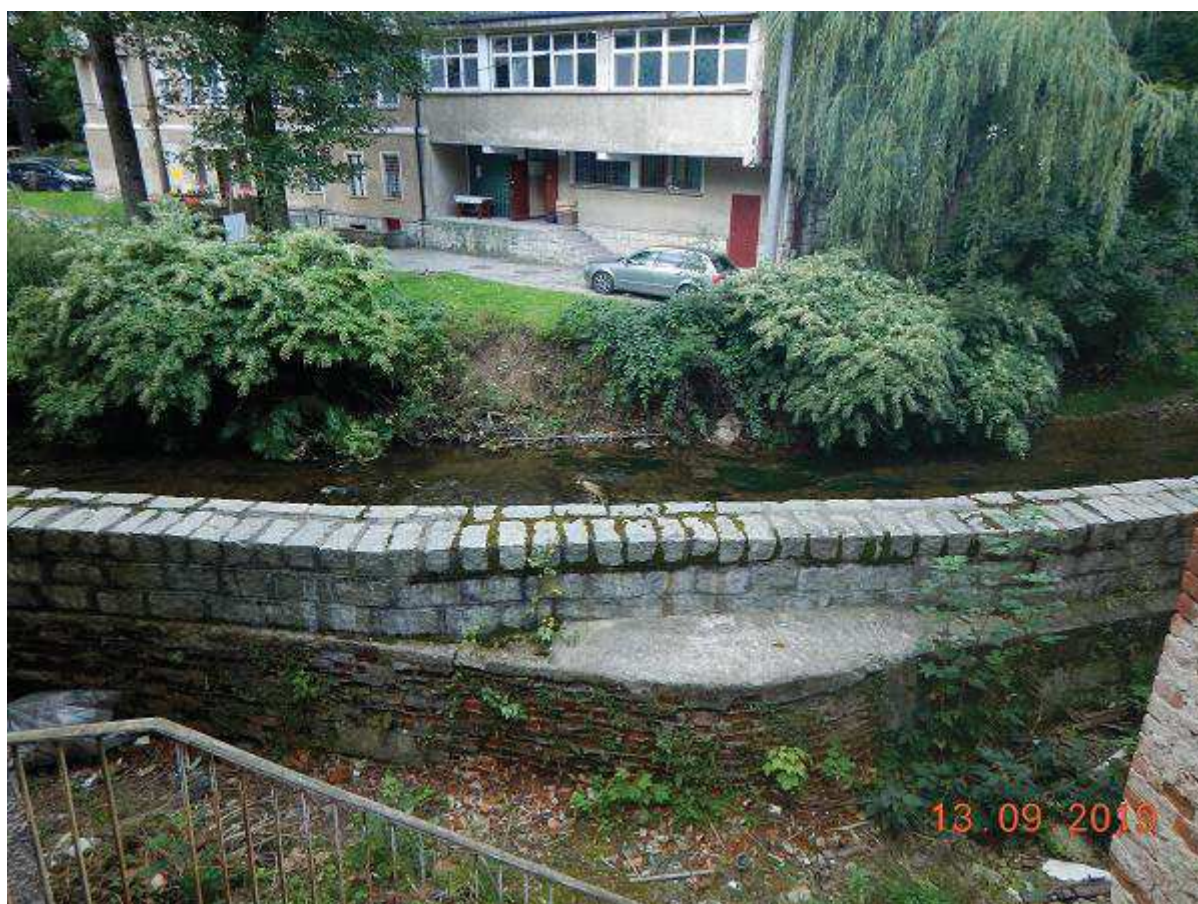
Fot. 75 Ukształtowanie linii brzegu lewego i budowa umocnienia skarpy (układany narzut kamienny z klinowaniem) odc. km 24+675 ÷ 24+760
