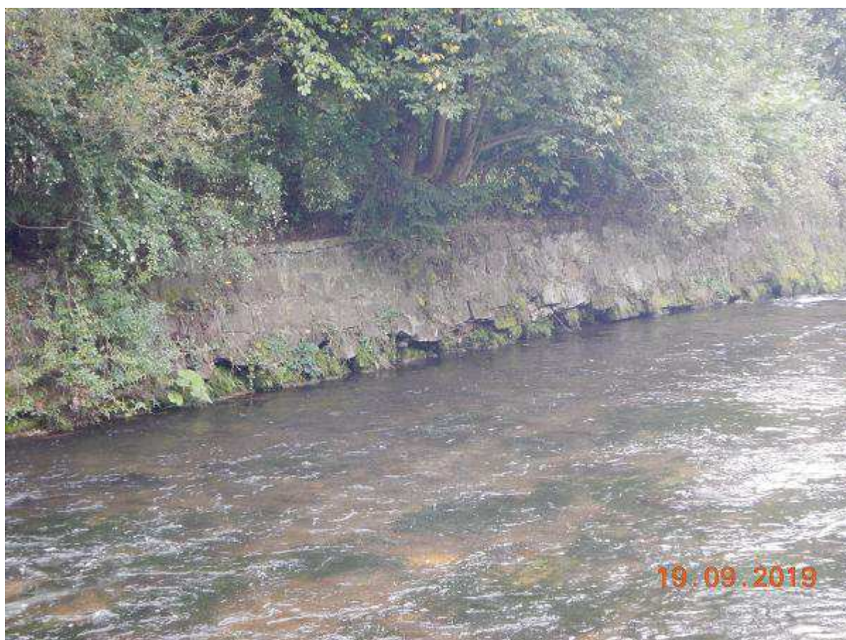
Fot. 20 Reprofilacja muru lewobrzeżnego na odcinku km 23+090 ÷ 23+200. Usunięcie drzew i zakrzaceń. [widok koryta od GW]
