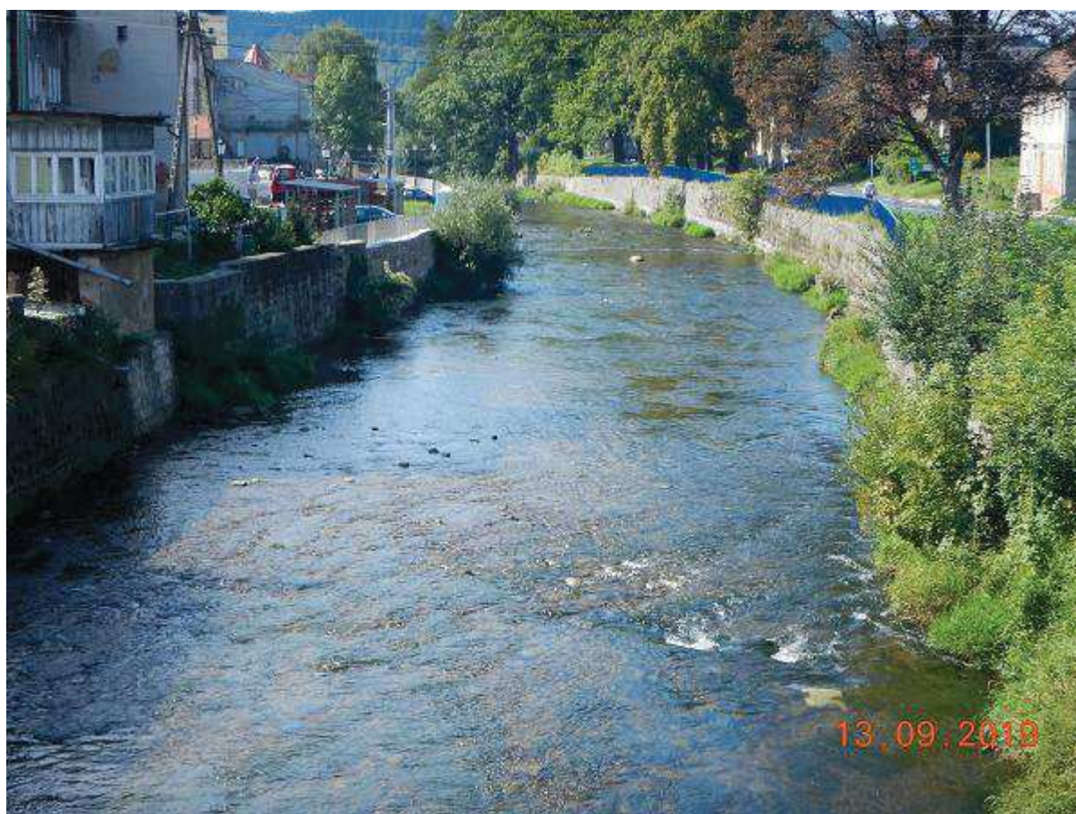
Fot. 26 Reprofilacja muru prawobrzeżnego z odsadzką na odc. km 23+265 ÷ 23+506. Usunięcie krzewów i zakrzaczeń [widok koryta od GW]
