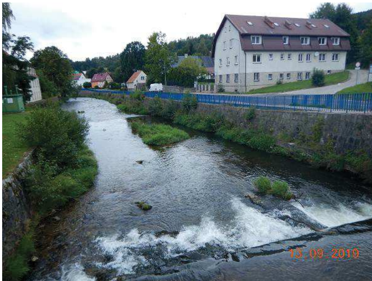
Fot. 43 c.d. Reprofilacja muru prawobrzeżnego z odsadzką w dnie na odc. km 23+511 ÷ 23+685 [widok od GW]
