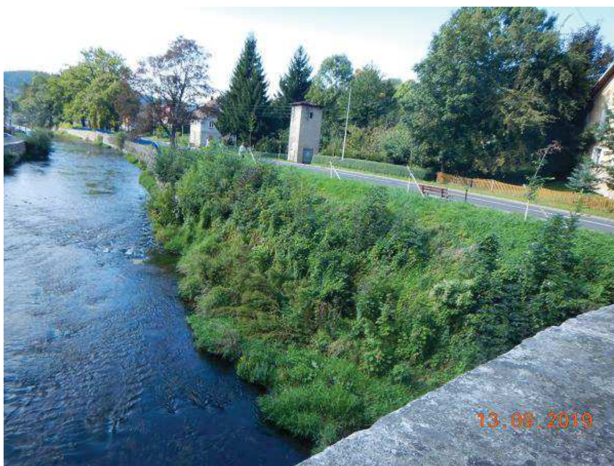
Fot. 36 Usunięcie odkładu wzdłuż brzegu prawego dla udroźnienia światła mostu M-25 w km 23+506 [widok z mostu od DW]
