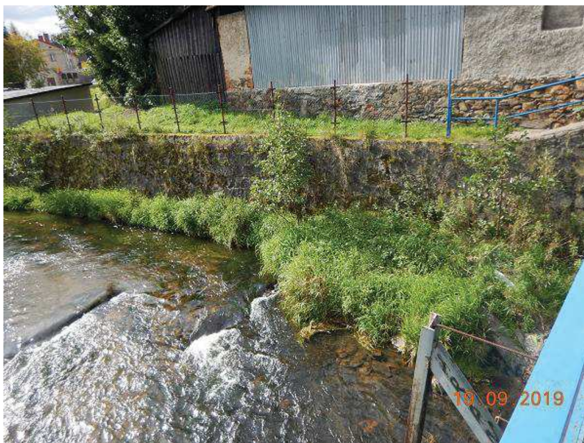
Fot. 16 Reprofilacja muru lewobrzeżnego na odcinku km 22+905 ÷ 22+955 [widok koryta od GW kładki M-23]
