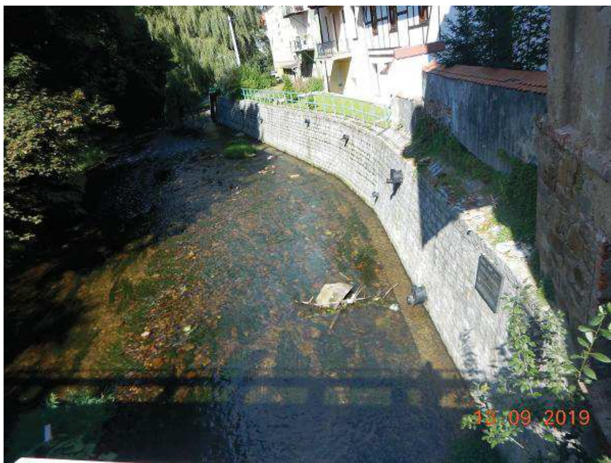
Fot. 67 Reprofilacja prawego muru brzegowego wraz z odsadzką i odcinkowym usunięciem odsypiska na odc. km 24+386 ÷ 24+658
