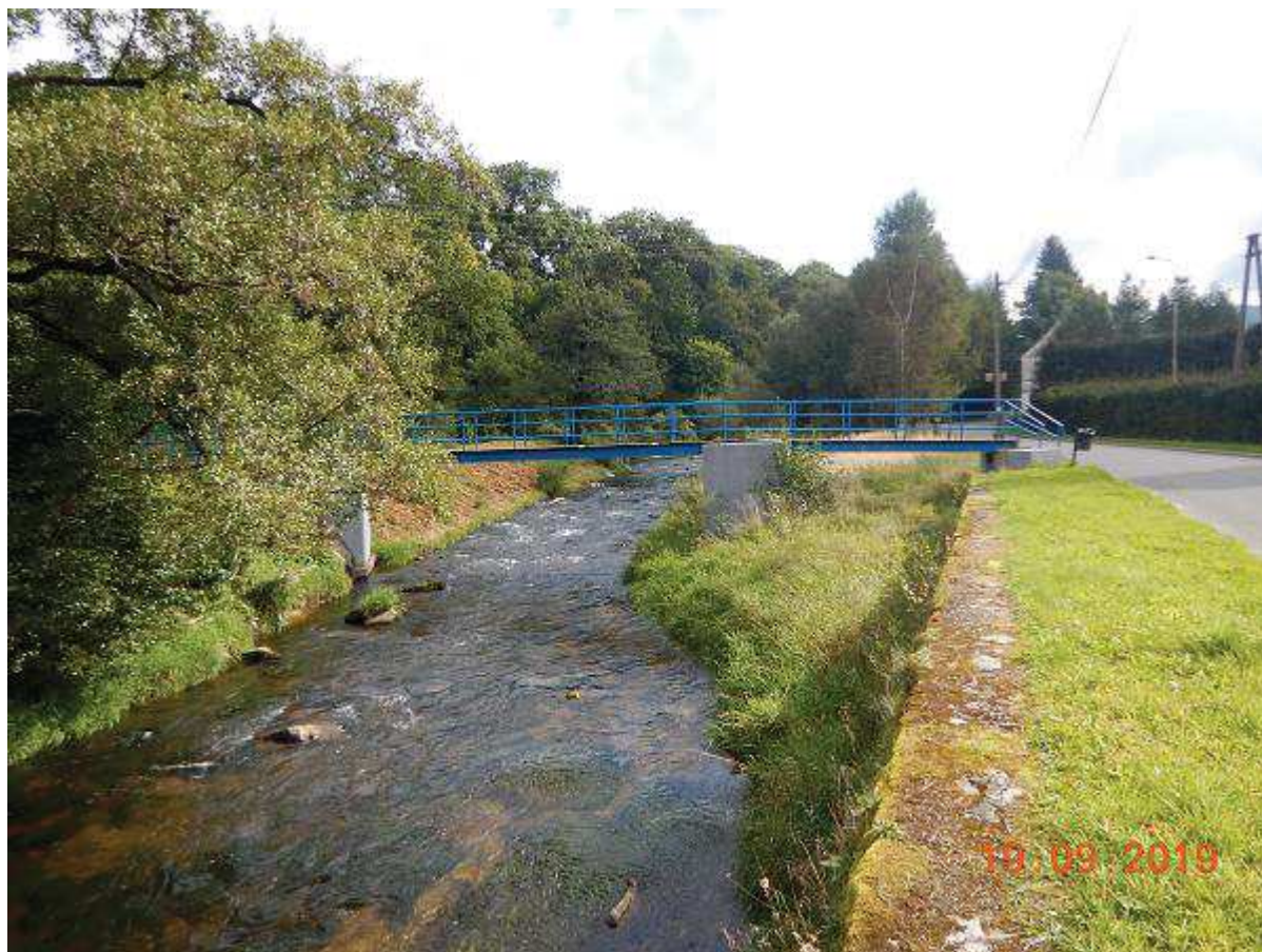
Fot. 7 Reprofilacja kamiennego muru lewobrzeżnego na odc. km 21+945 ÷ 22+422. Udrożnienie lewego światła kładki M-22 [widok od DW]
