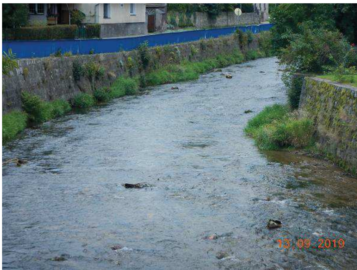
Fot. 42 Reprofilacja muru prawobrzeżnego z odsadzką w dnie na odc. km 23+511 ÷ 23+685 [widok od DW]
