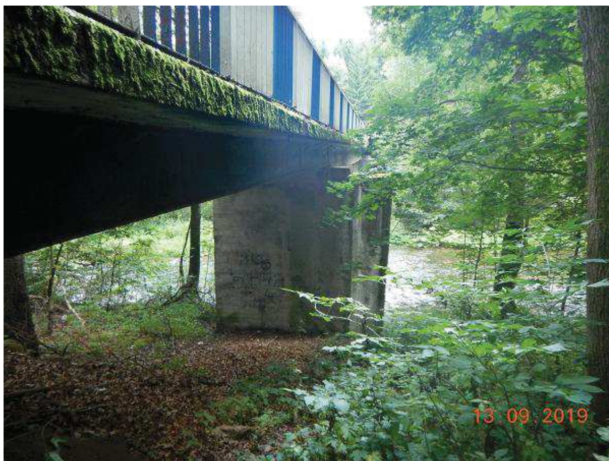
Fot. 79 Most M-31 w km 25+261. Widok od wody górnej (BL) - brak działarń
