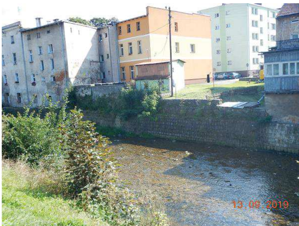
Fot. 34 c.d. Reprofilacja muru lewobrzeżnego z odsadzką na odc. km 23+400 ÷ 23+506
