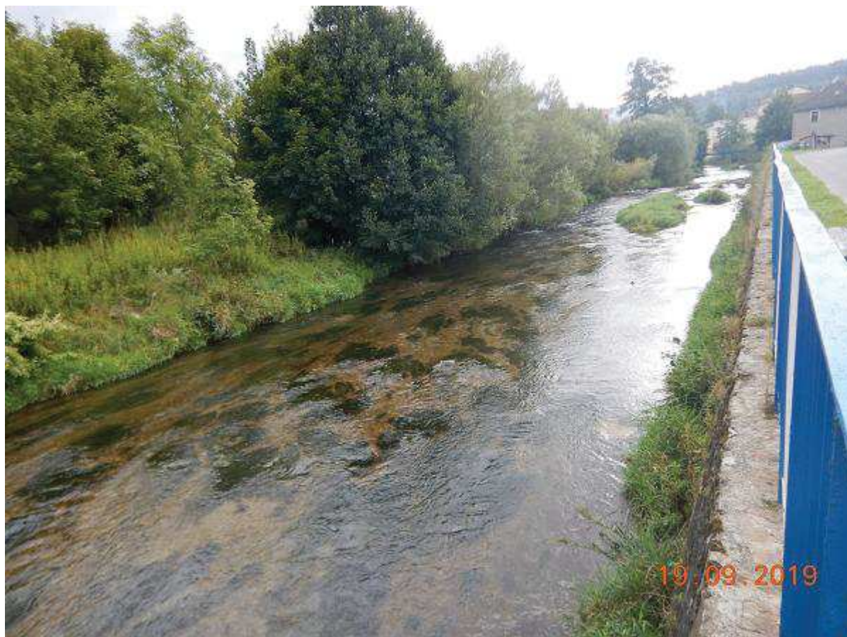
Fot. 11 Reprofilacja kamiennego muru lewobrzeżnego wraz z odsadzką w dnie na odc. km 22+640 ÷ 22+904 [widok od DW]
