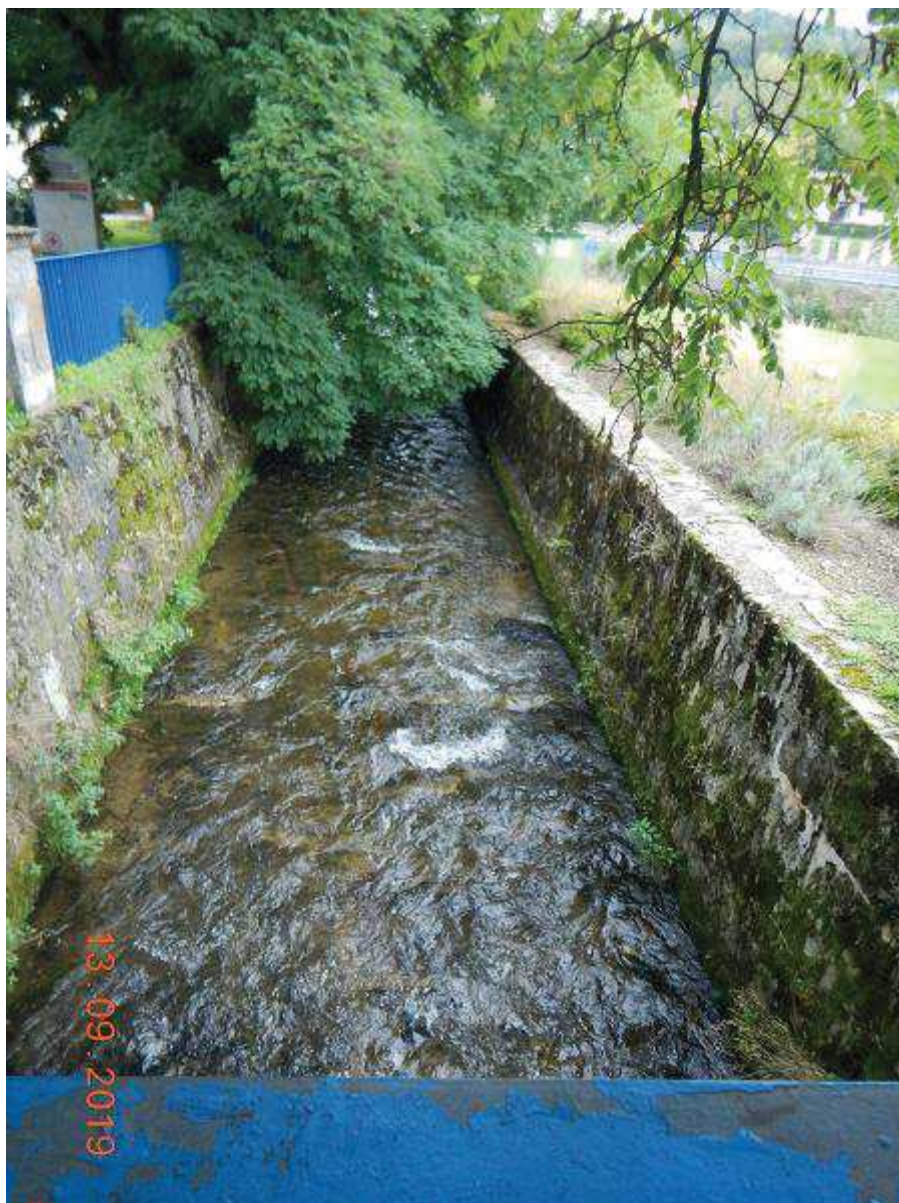
Fot. 44 Budowa przepławki dla ryb w ramach istn. kanału obiegowego węzła wodnego km 23+685 ÷ 23+800 [widok od GW]
