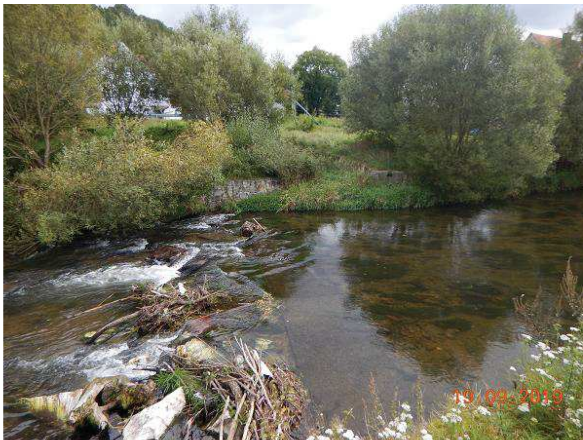
Fot. 13 Remont odcinka ujściowego koryta potoku Wiosennik [BP] w km 22+850
