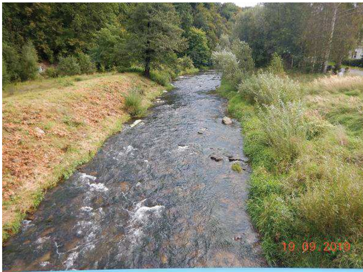
Fot. 9 Ukształtowanie linii brzegu prawego i brzegu lewego z budową umocnienia skarp, np. układany narzut kamienny z klinowaniem na odc. powyżej kładki M-22, tj. km 22+425 ÷ 22+655 (BP) 22+640 (BL) [widok z kładki od GW]
