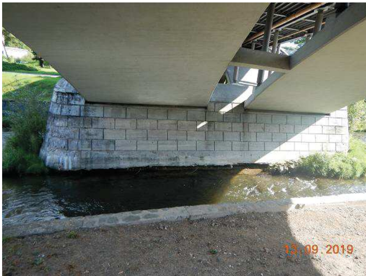
Fot. 56 c.d. Wzmocnienie umocnień dennych w stopie filara nurtowego mostu M-27 w km 23+927 [widok z BL]
