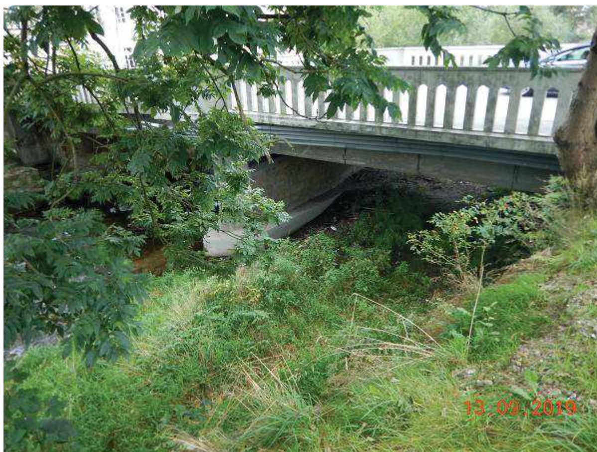
Fot. 24 c.d. Usunięcie odkładu wzdłuż brzegu prawego dla udroźnienia światła mostu M-24 w km 23+200 [widok koryta od GW mostu]
