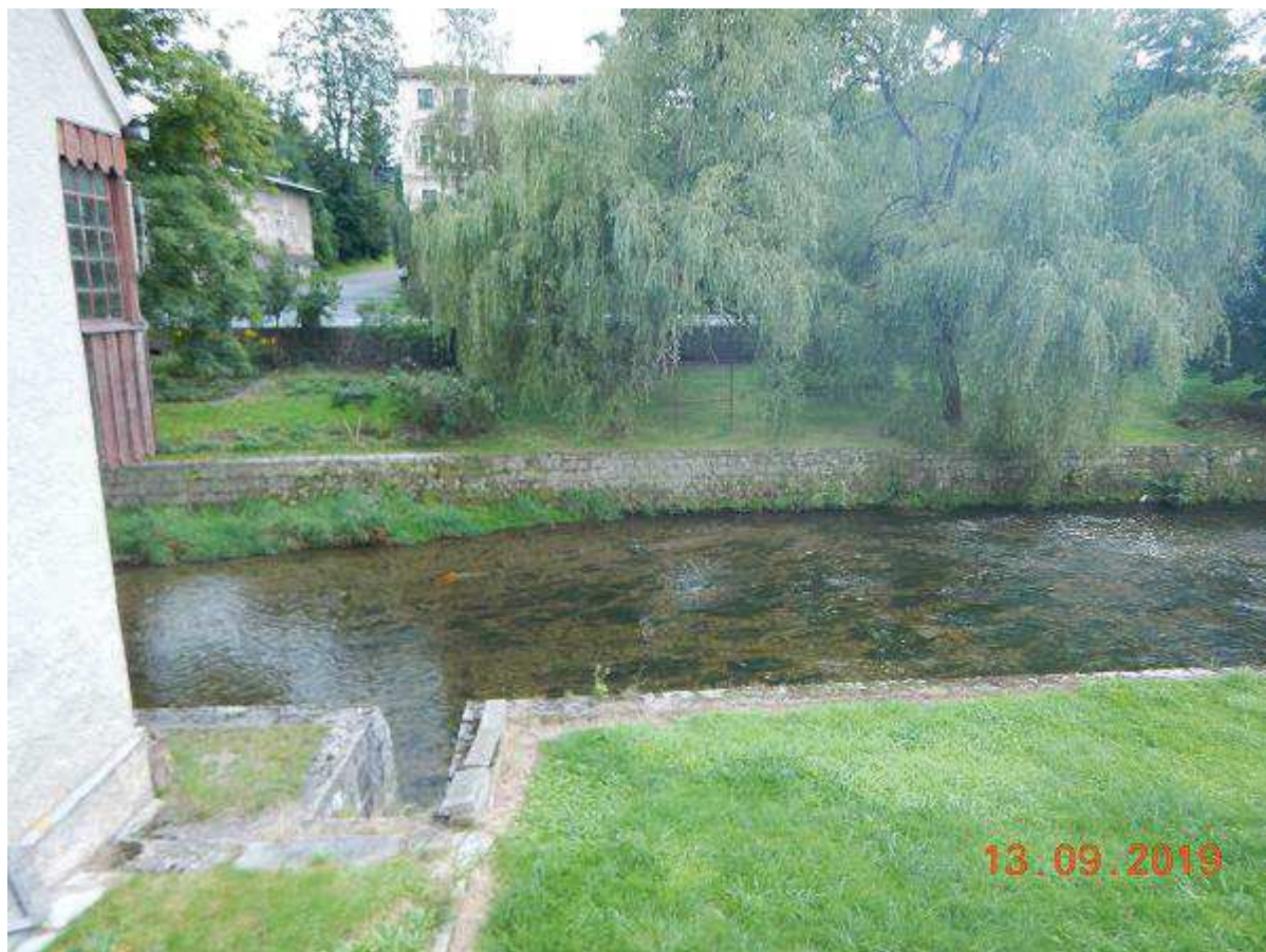
Fot. 62 Reprofilacja brzegowego muru wraz z odsadzką na odc. km 24+030 ÷ 24+350 i muru dolinowego na odc. km 24+030 ÷ 24+200 (BL)
