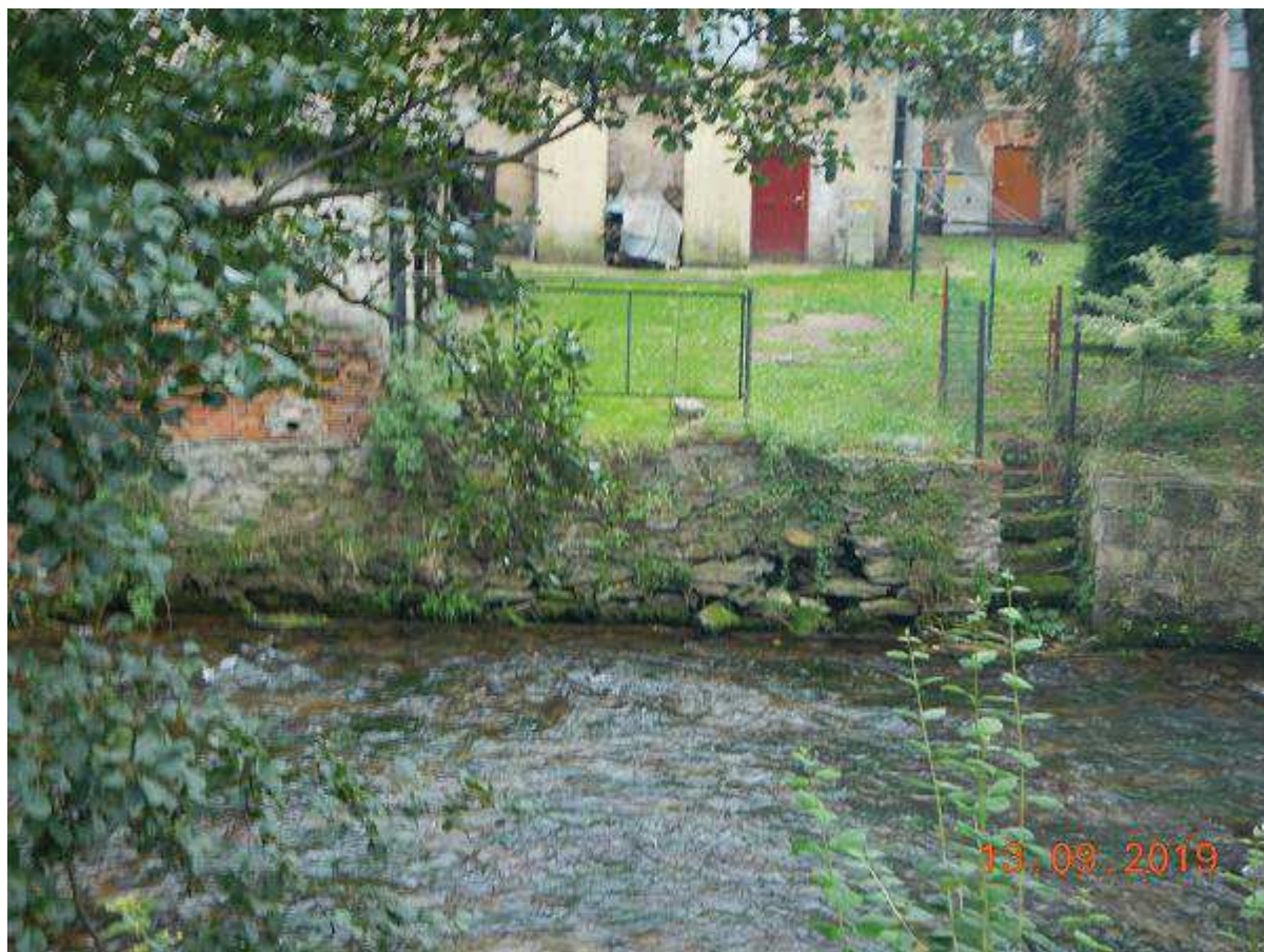
Fot. 27 Rozbiórka i odbudowa odcinka lewobrzeżnego muru powyżej mostu M-24 km 23+213 ÷ 23+240
