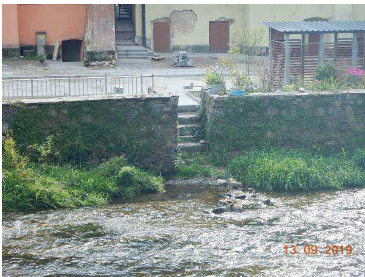
Fot. 30 Rozbiórka i odbudowa lewobrzeżnego muru (od schodów w górę rzeki) na odc. km 23+280 ÷ 23+506 z usunięciem odkładu
