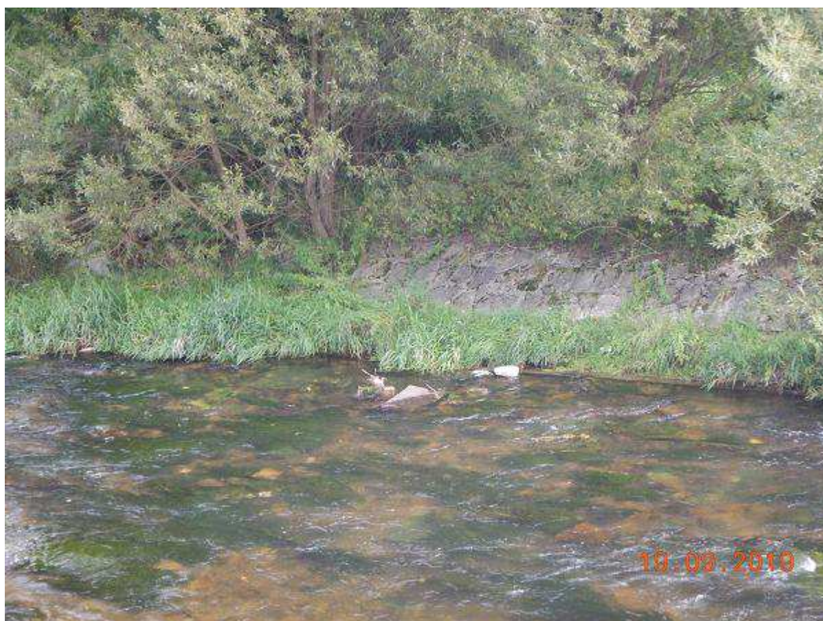
Fot. 12 Reprofilacja umocnień kamiennych prawobrzeżnej skarpy z usunięciem drzew i krzaków na odc. km 22+830 ÷ 22+845
