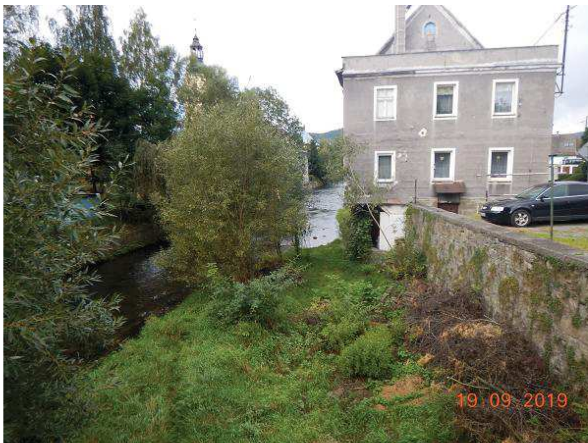
Fot. 23 Usunięcie odkładu wzdłuż brzegu prawego dla udroźnienia światła mostu M-24 w km 23+200 [widok z mostu od DW]
