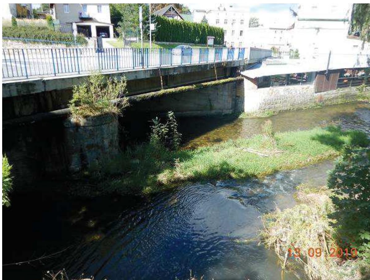
Fot. 65 Widok mostu M-28 od wody dolnej w km 24+350. Udrożnienie światła i wzmocnienie umocnień dennych filara i przyczółków
