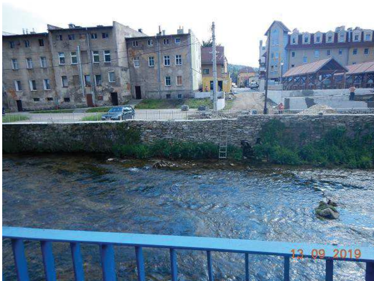
Fot. 31 c.d. Rozbiórka i odbudowa lewobrzeżnego muru na odc. km 23+280 ÷ 23+506 z usunięciem odkładu
