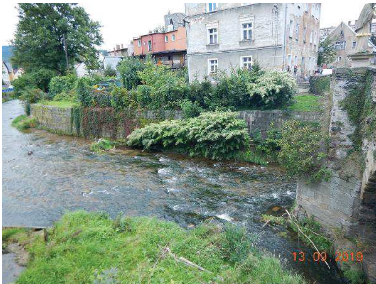
Fot. 39 Reprofilacja muru lewobrzeżnego z odsadzką na odc. km 23+511 ÷ 23+556 [widok od GW mostu M-25]
