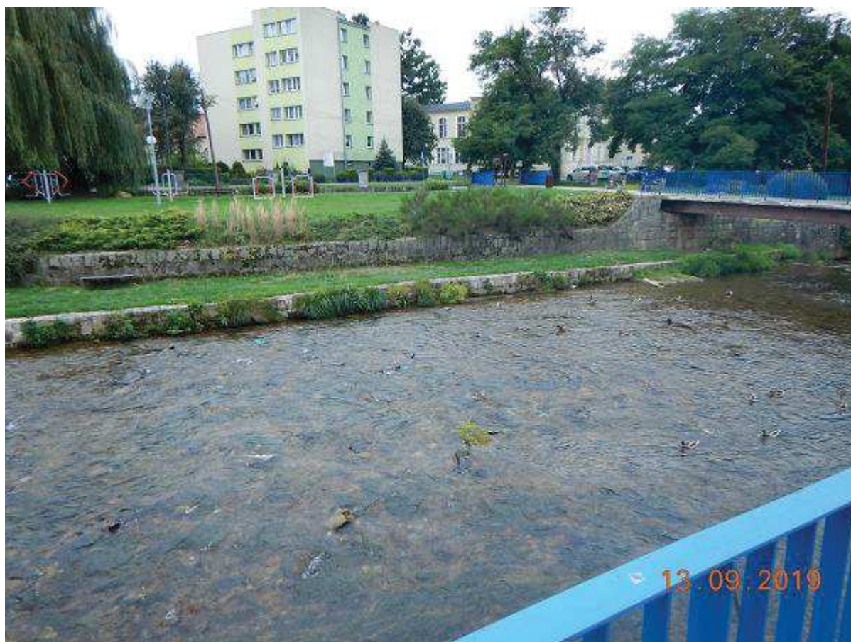
Fot. 50 Reprofilacja murów korytowych i brzegowych rzeki w obrębie węzła wodnego km 23+685 ÷ 23+800 [widok na BL]
