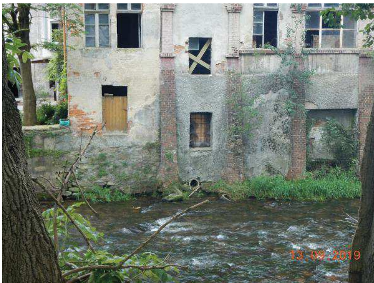
Fot. 28 Budowa nowego muru między przyporami ściany budynku w rzece BL na odc. km 23+240 ÷ 23+260
