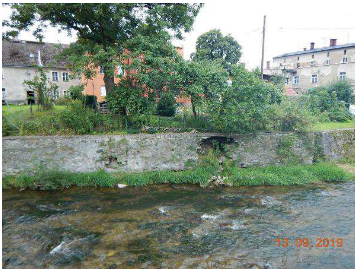
Fot. 40 Rozbiórka i odbudowa lewobrzeżnego muru na odc. km 23+556 ÷ 23+620 z usunięciem odkładu w stopie
