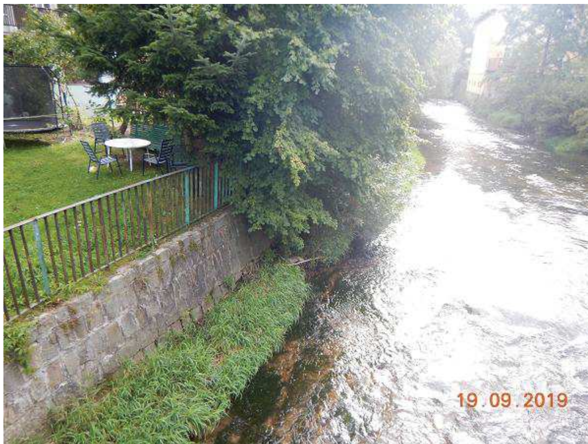
Fot. 21 Reprofilacja muru prawobrzeżnego na odcinku km 22+850 ÷ 23+000. Usunięcie drzew i zakrzaczeń. [widok koryta od DW]
