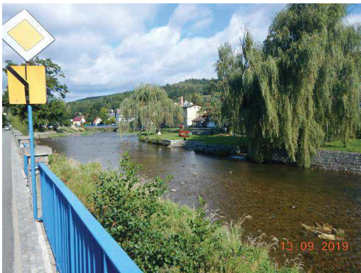
Fot. 53 Reprofilacja prawobrzeżnego muru brzegowego na odc. km 23+800 ÷ 23+927 (do mostu M-27)
