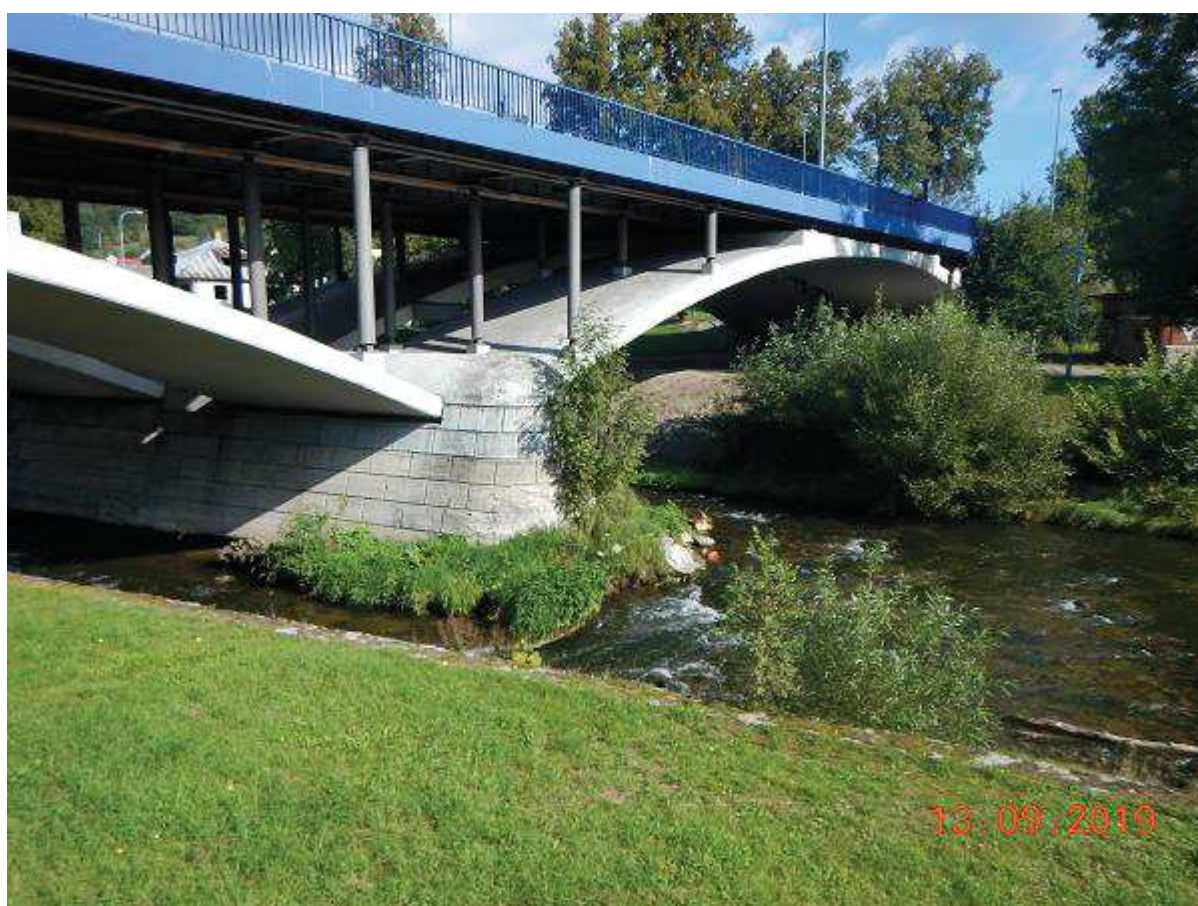
Fot. 57 Wzmocnienie umocnień dennych w stopie filara nurtowego mostu M-27 w km 23+927 [widok od GW]
