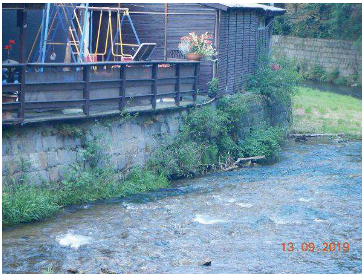
Fot. 63 c.d. Reprofilacja brzegowego muru wraz z odsadzką i odcinkowym usunięciem odkładu na odc. km 24+030 ÷ 24+350 [widok na BL]
