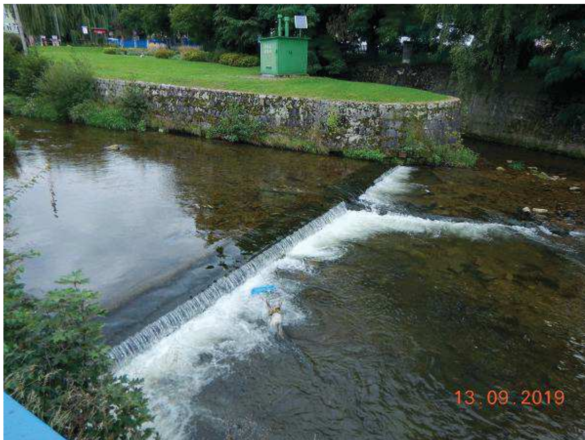
Fot. 46 Remont progu dolnego w zakresie korony przelewu w obrębie węzła wodnego km 23+685 ÷ 23+800 [widok od DW]
