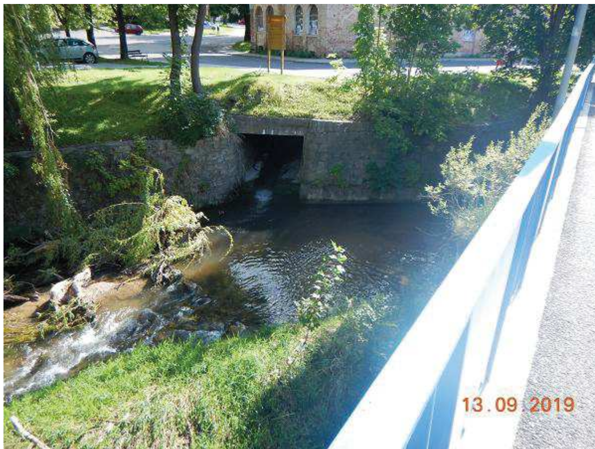
Fot. 64 Remont odcinka ujściowego koryta potoku Grodzkiego w km 24+350 (BP)
