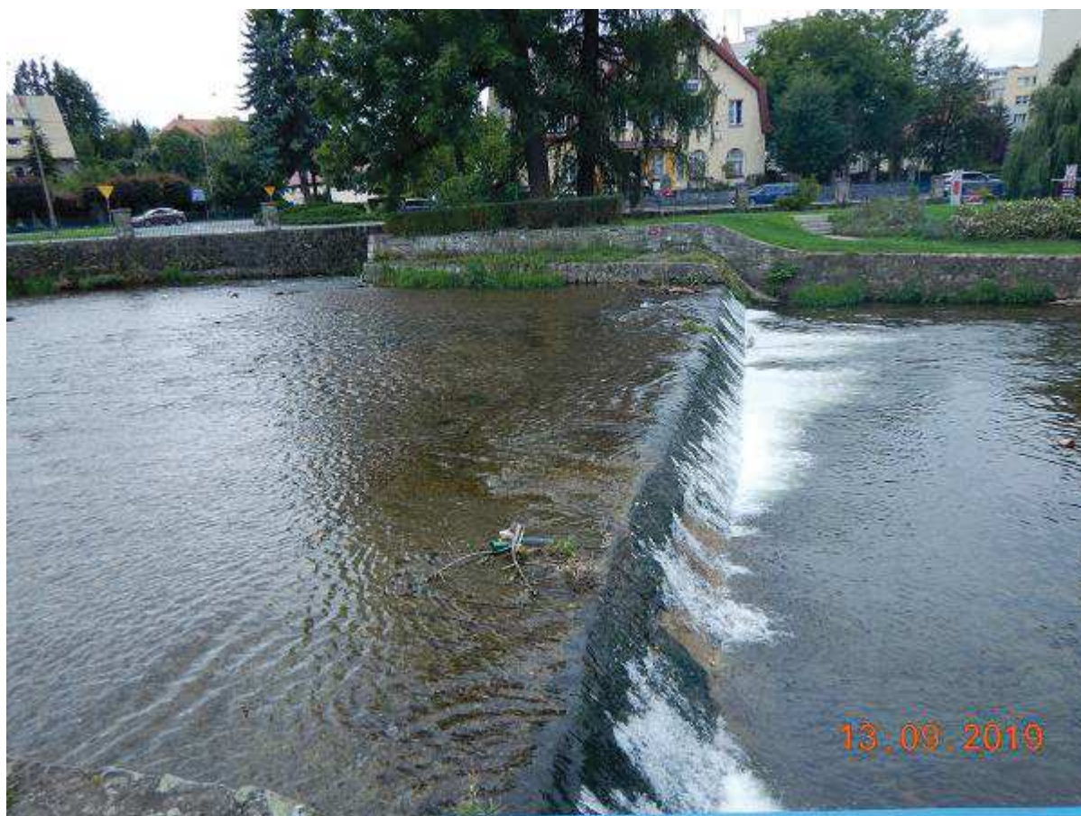
Fot. 48 Remont korpusu jazu w zakresie korony progu górnego w obrębie węzła wodnego km 23+685 ÷ 23+800
