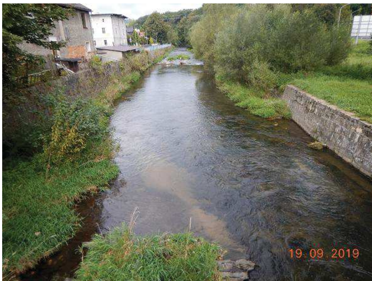
Fot. 14 Reprofilacja murów lewo- i prawobrzeżnego na odcinku poniżej kładki M-23 km 22+904 [widok od DW kładki]
