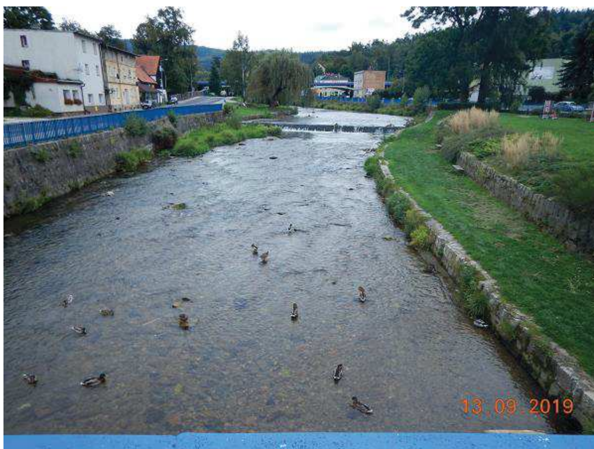
Fot. 51 c.d. Reprofilacja murów korytowych i brzegowych rzeki w obrębie węzła wodnego km 23+685 ÷ 23+800 [widok w górę rzeki]
