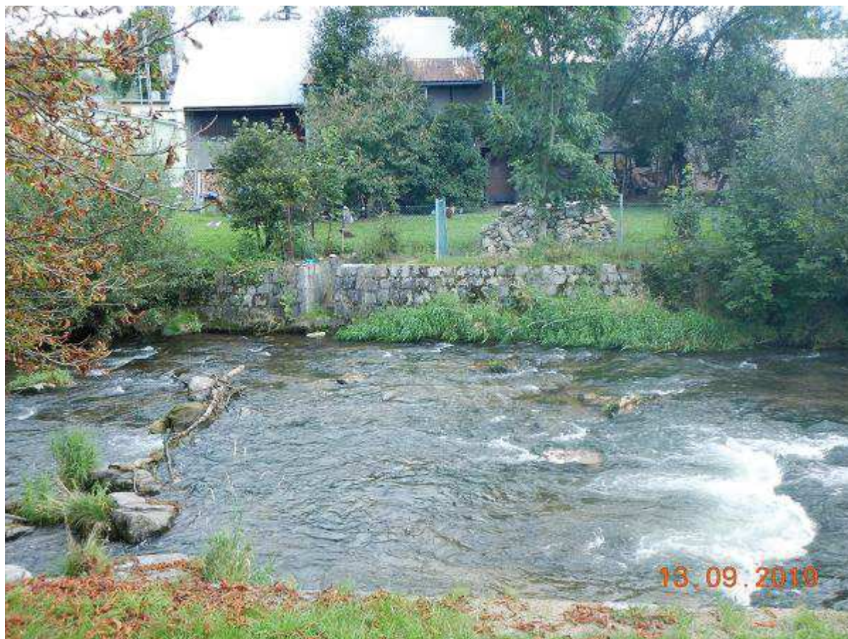
Fot. 58 Reprofilacja muru prawobrzeżnego z usunięciem odsypiska wraz z zakrzaczeniami na odc. km 23+942 ÷ 24+350 [widok z BL]
