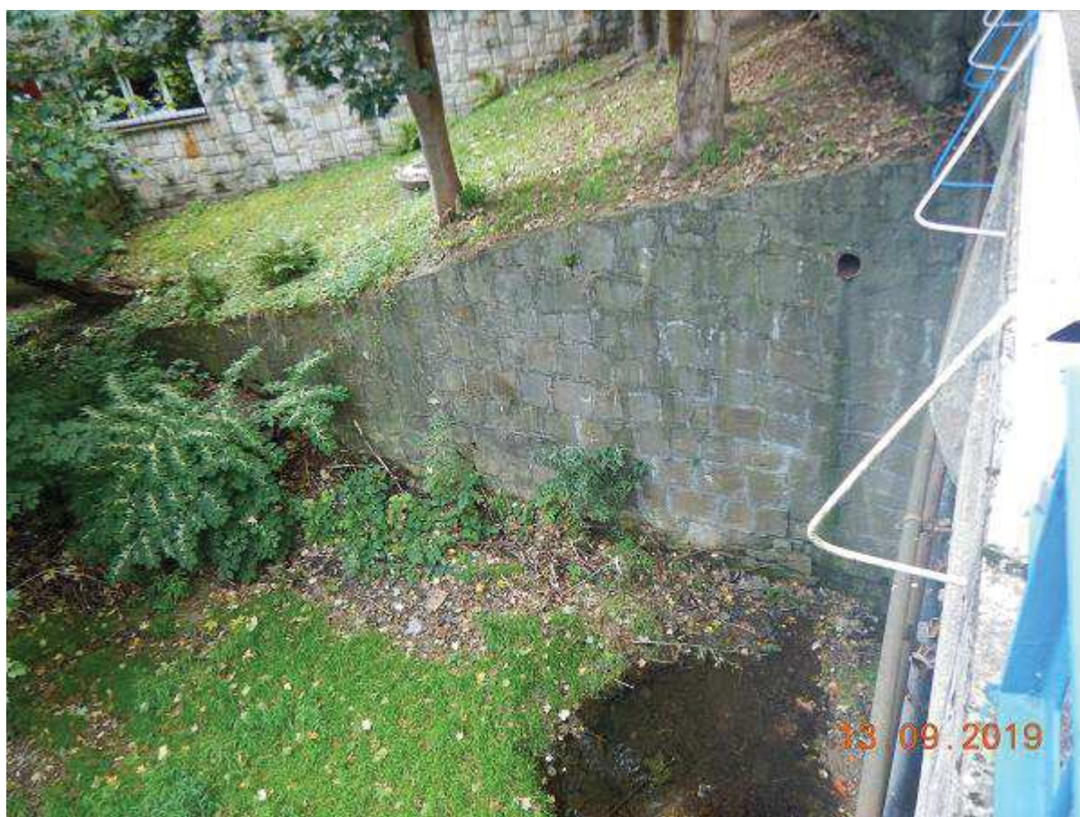
Fot. 71 Most M-30 w km 24+667 widok od górnej wody na brzeg lewy – reprofilacja skrzydełka i usunięcie odkładu z przęsła lewego
