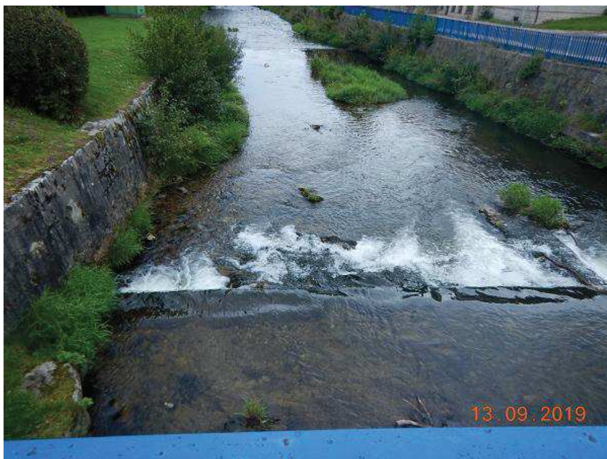
Fot. 47 Remont progu pośredniego w zakresie korony przelewu w obrębie węzła wodnego km 23+685 ÷ 23+800 [widok od GW]
