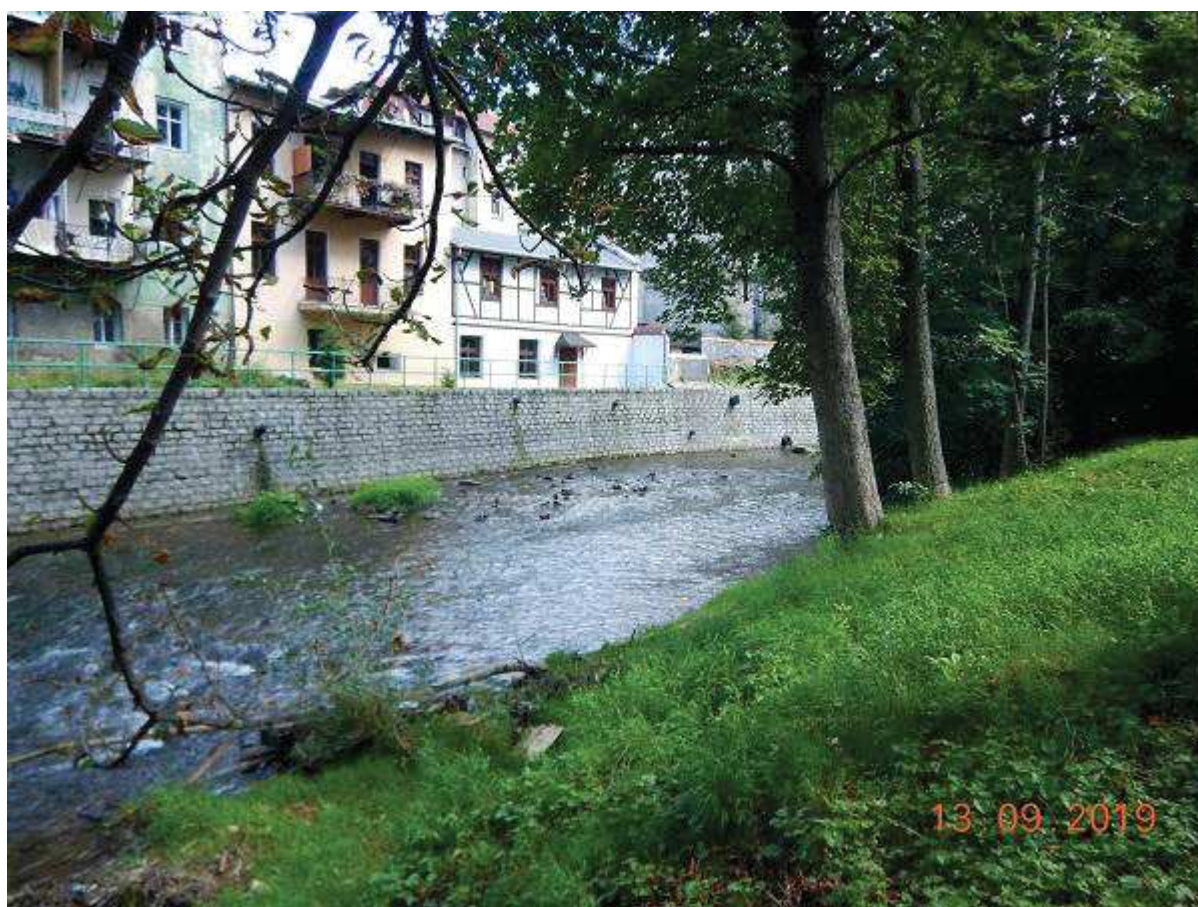
Fot. 77 Ukształtowanie linii brzegu lewego i budowa umocnienia skarpy (układany narzut kamienny z klinowaniem) odc. km 24+840 ÷ 25+261
