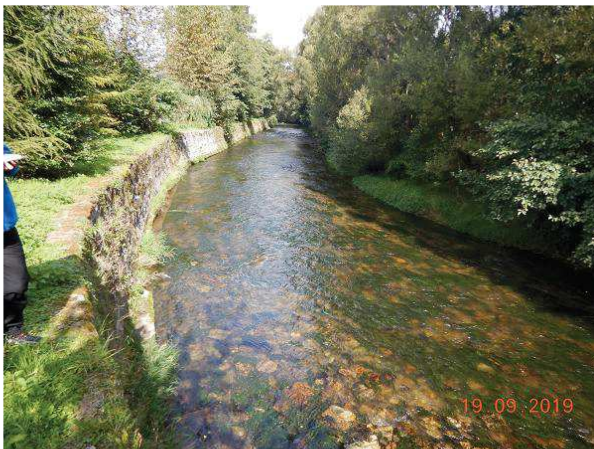
Fot. 6 Reprofilacja kamiennego muru lewobrzeżnego na odc. km 21+945 ÷ 22+422 [widok koryta od GW]
