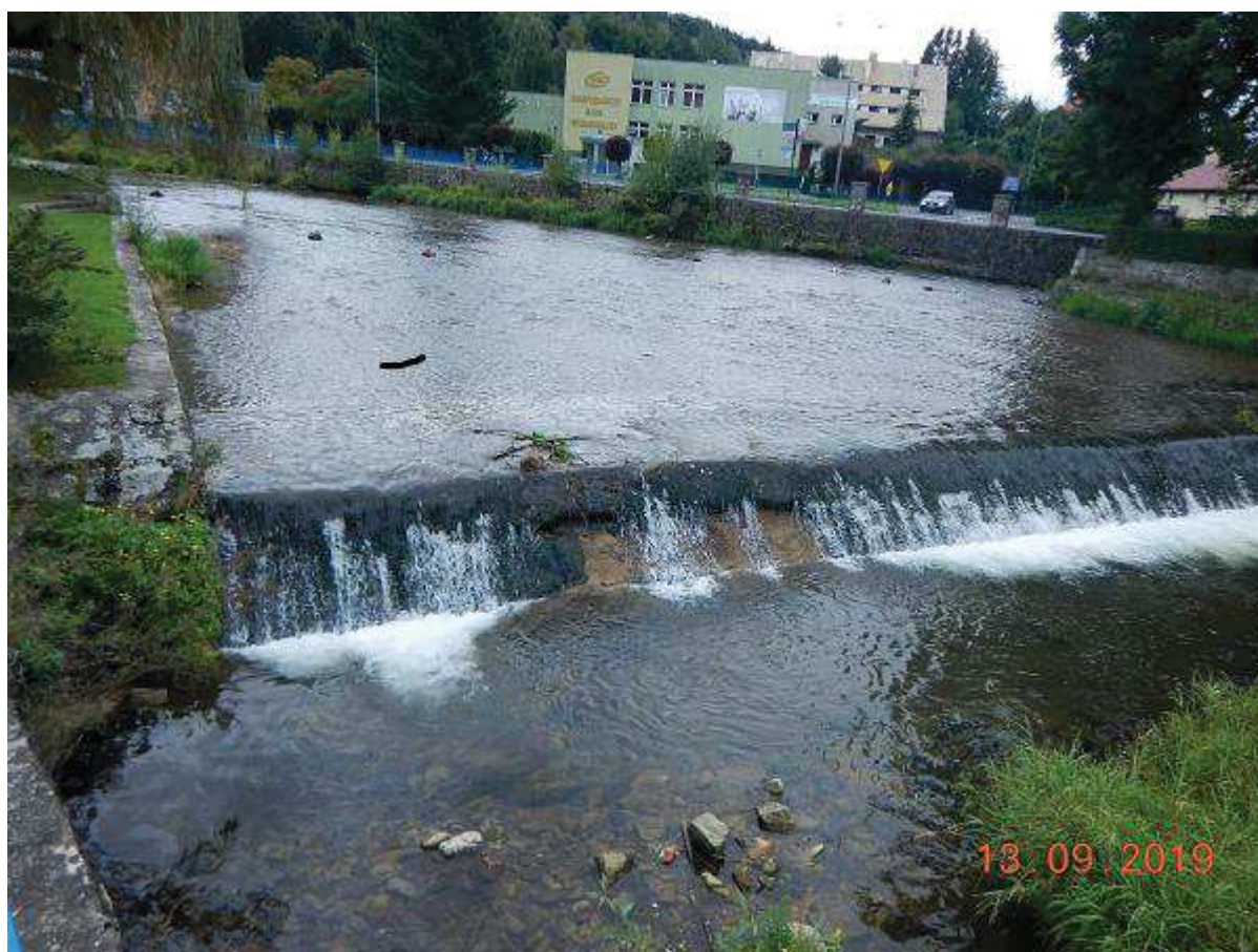
Fot. 49 c.d. Remont korpusu jazu w zakresie korony progu górnego w obrębie węzła wodnego km 23+685 ÷ 23+800 [widok od DW]
