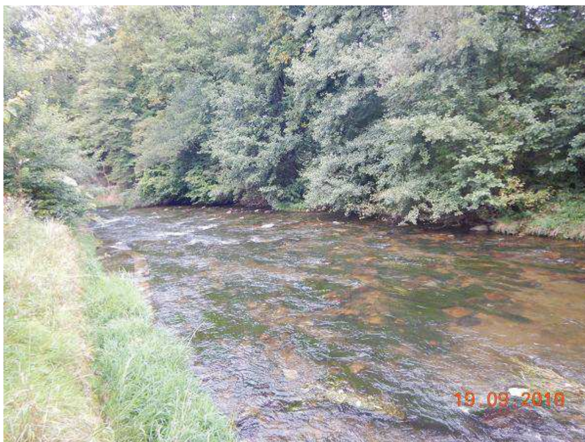
Fot. 10 Jw. ukształtowanie linii brzegu prawego i lewego z budową umocnienia skarp, km 22+425 ÷ 22+655 (BP) 22+640 (BL) [widok od GW]
