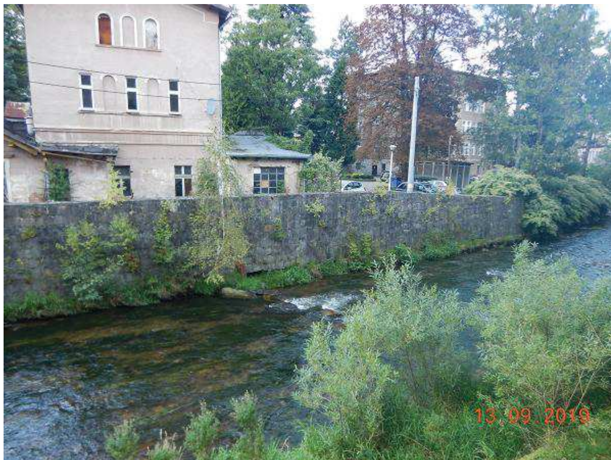
Fot. 76 Reprofilacja muru lewobrzeżnego wraz z odsadzką w dnie na odc. km 24+760 ÷ 24+840 [widok od GW z BL]
