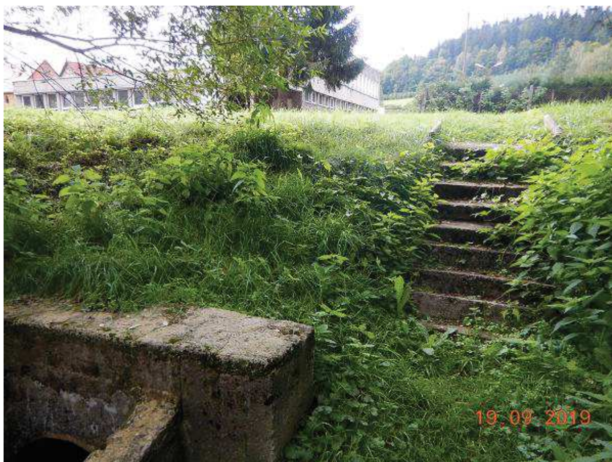
Fot. 4 Przebudowa wylotu wód z oczyszczalni ścieków w km 21+842 [widok od strony koryta na BL]
