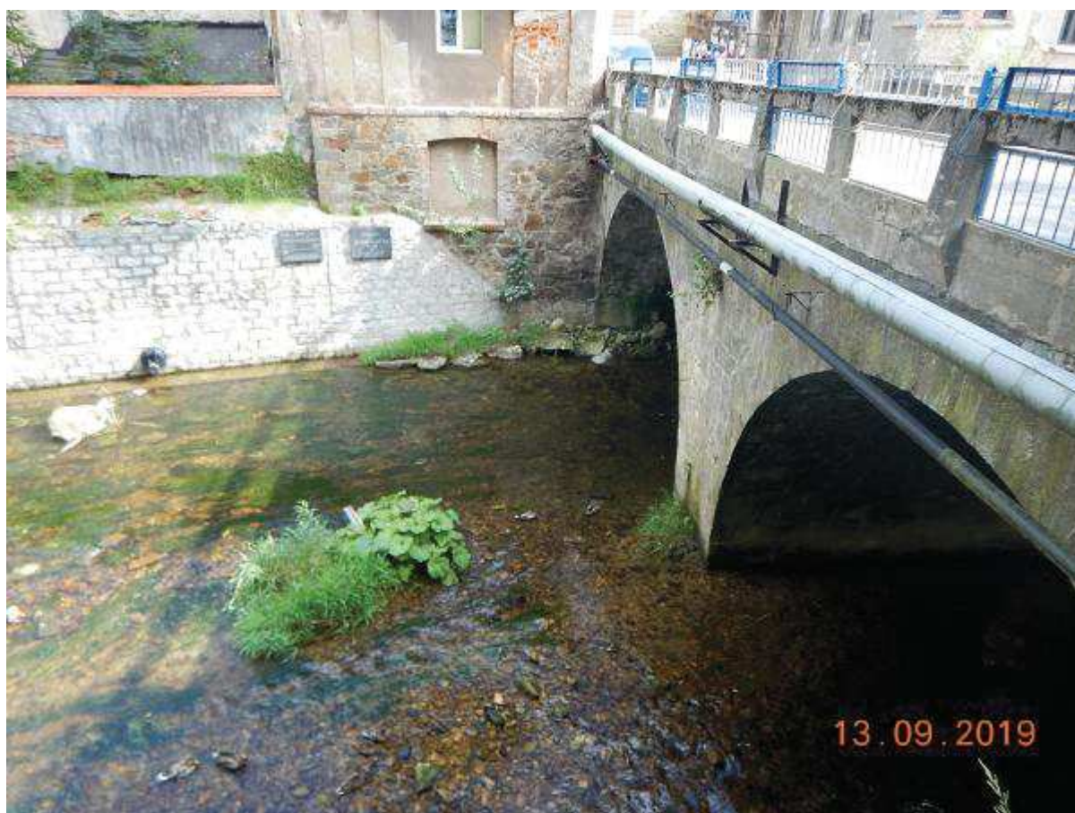
Fot. 69 Most M-30 w km 24+685 widok od dolnej wody na brzeg prawy
