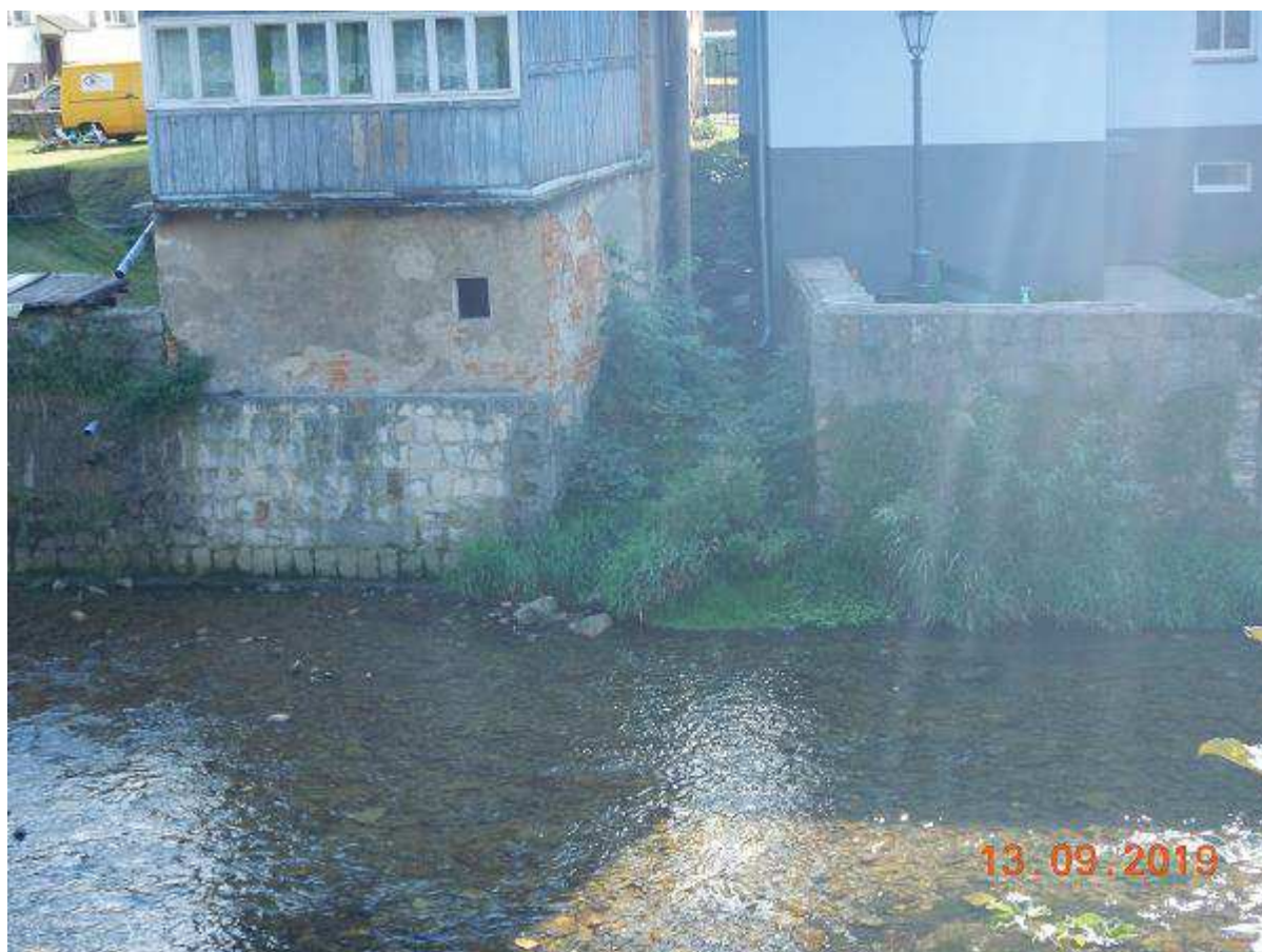
Fot. 35 Budowa nowego odcinka muru dł. ca 4,0 m w km 23+455
