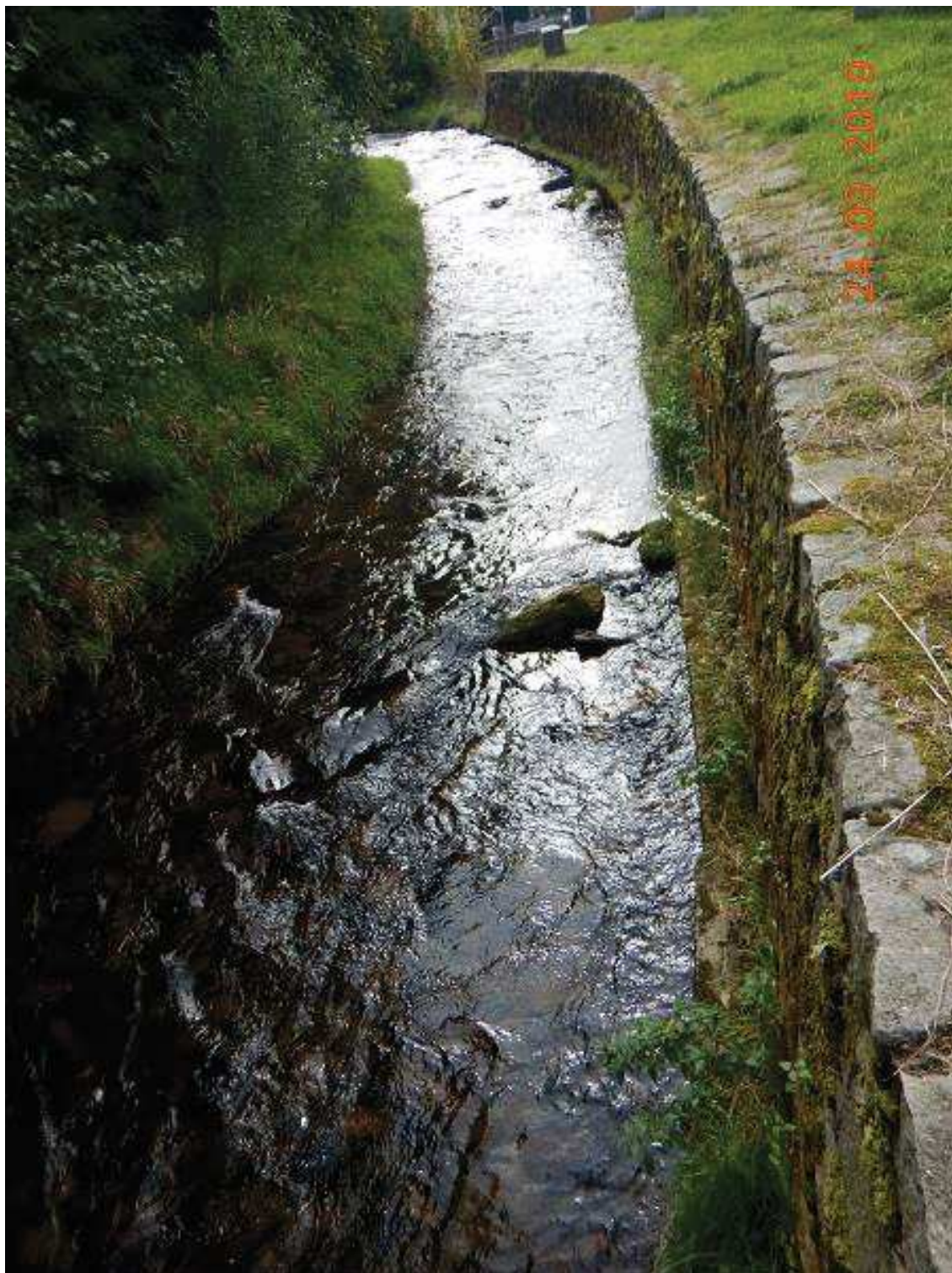
Fot. 14 c.d. Reprofilacja muru lewobrzeżnego na odcinku km 30+970 ÷ 31+270 [widok od DW, odcinek końcowy muru]
