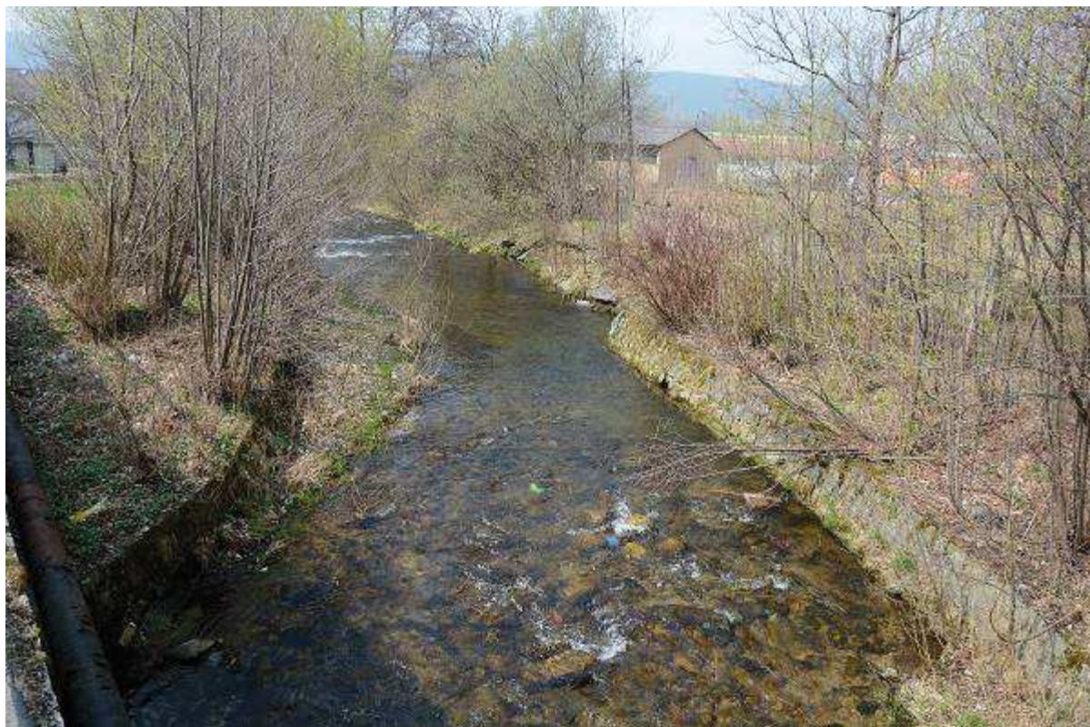
Fot. 23 Reprofilacja murów korytowych poniżej mostu M-40 w km 31+458 z udrożnieniem światła lewego i przebudową światła prawego mostu dla przepuszczenia wielkich wód pod mostem. [widok koryta od DW mostu]
