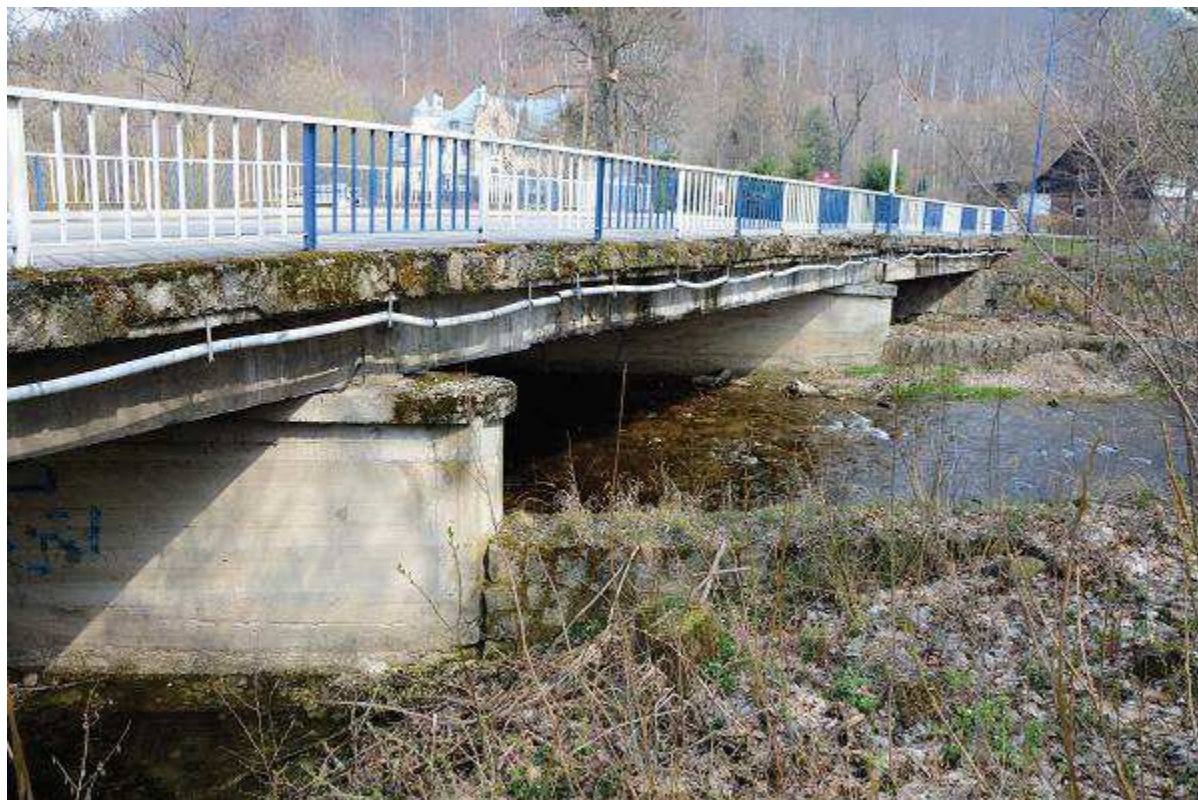
Fot. 24A Most M-40 w km 31+473 udrożnienie światła lewego mostu i wzmocnienie ubezpieczeń dennych przy filarach i przyczółkach mostu Przebudowa koryta i murów dla umożliwienia przepuszczenia WWQ prawym światłem mostu [widok od GW mostu]
