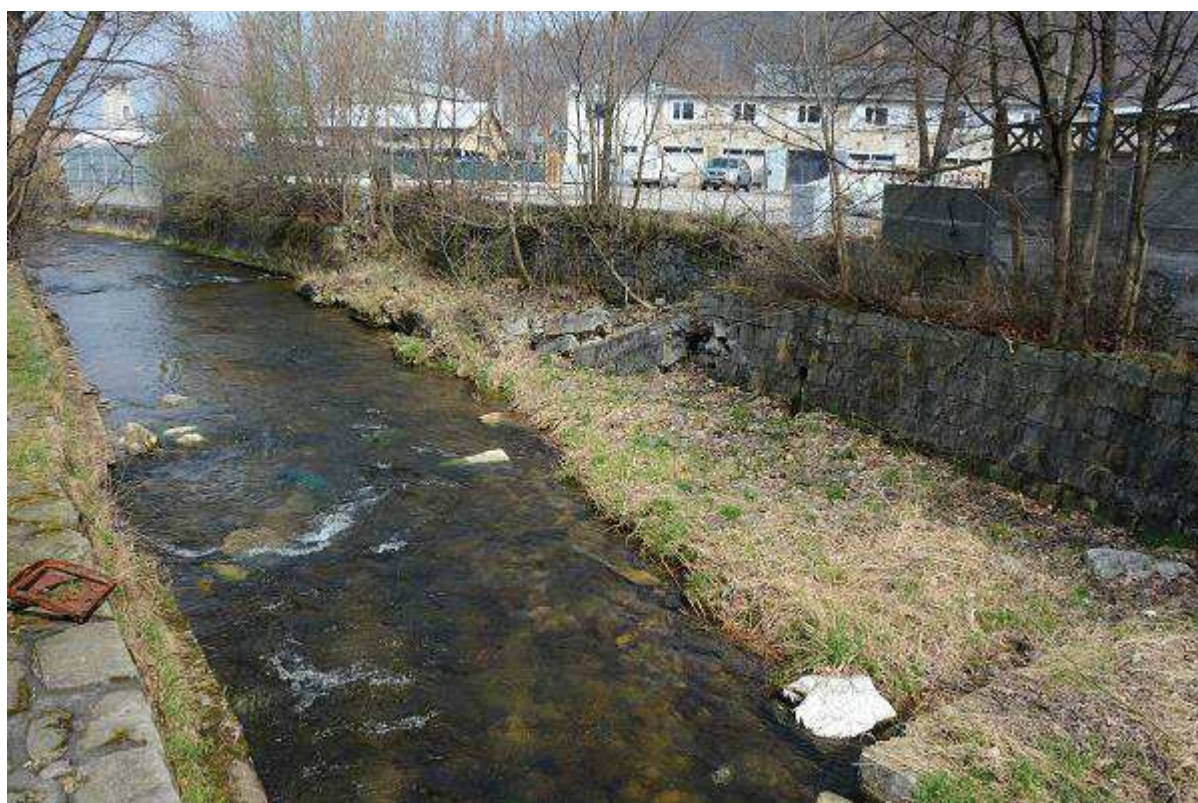
Fot. 16 Rozbiórka zawalonego prawego muru na odc. km 31+185 ÷ 31+215 z odbudową odc. dł. ca 30 m muru brzegowego. Likwidacja odsypiska. [widok koryta od GW]
