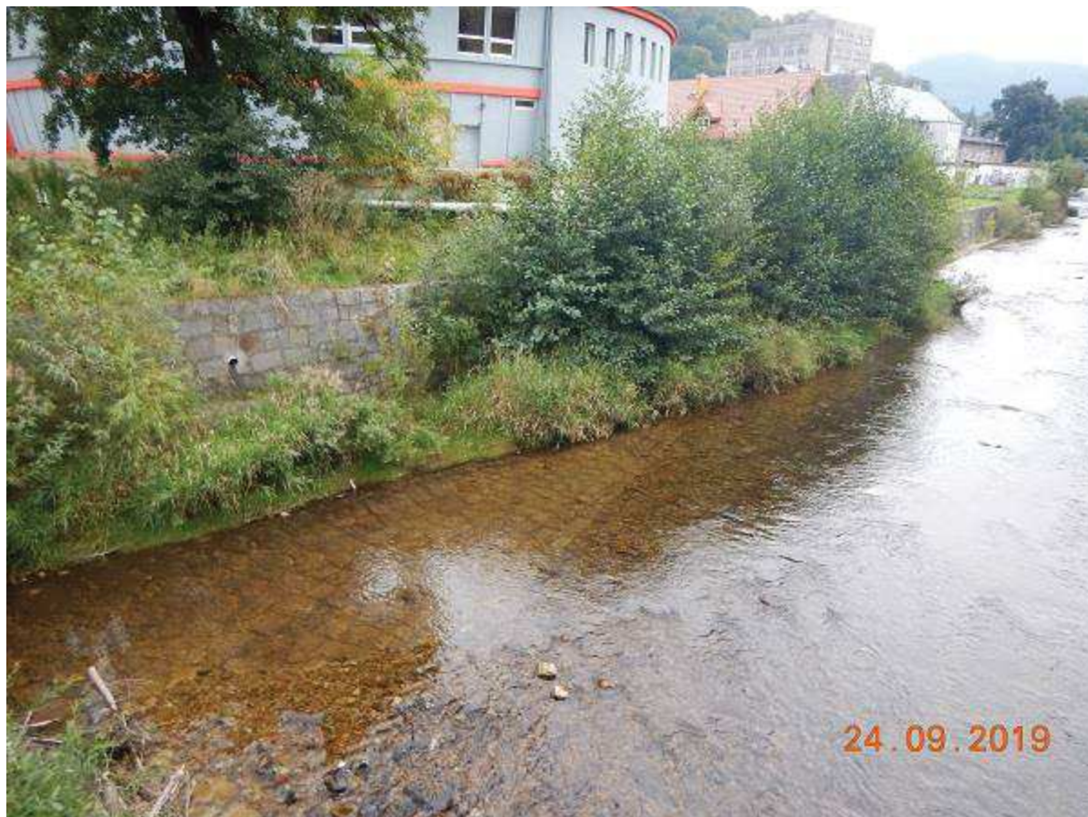
Fot. 5 Wykonanie robót w zakresie usunięcia namuliska wzdłuż brzegu prawego powyżej mostu M-38 dla udrożnienia jego światła [widok koryta od GW mostu]
