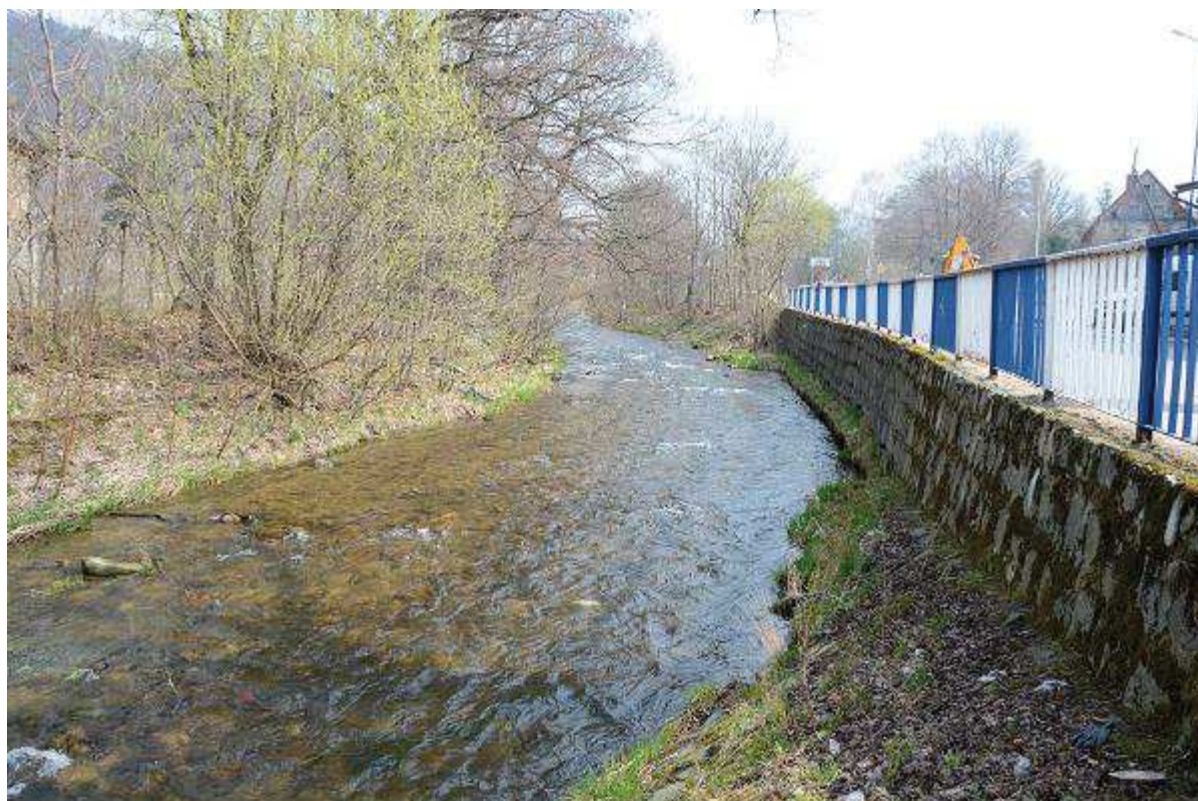
Fot. 20 Reprofilacja muru lewobrzeżnego z odbudową odsadzki na odcinku km 31+315 ÷ 31+360 [widok koryta od DW]
