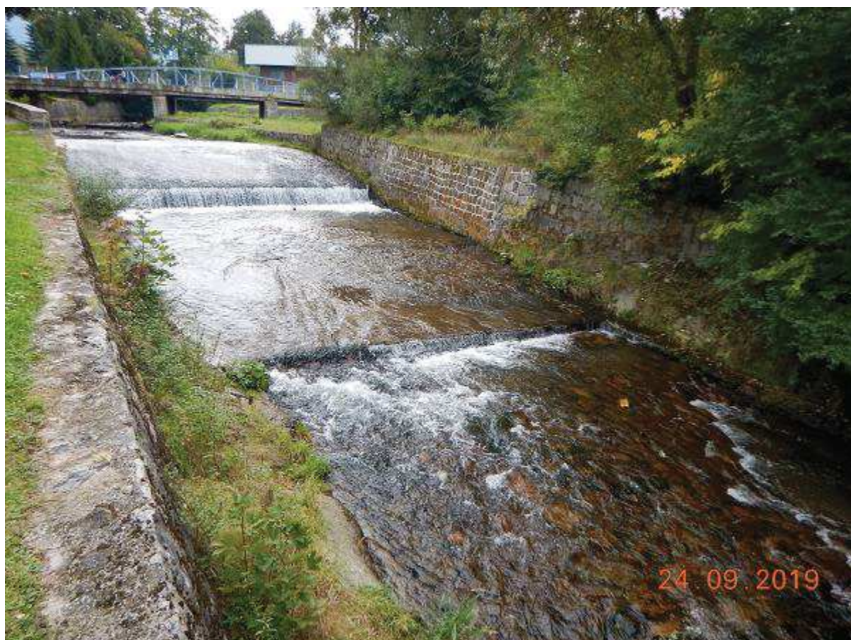
Fot. 8 Rozbiórka stopnia i wykonanie bystrza (budowa nowego urządzenia wodnego) [widok od DW]
