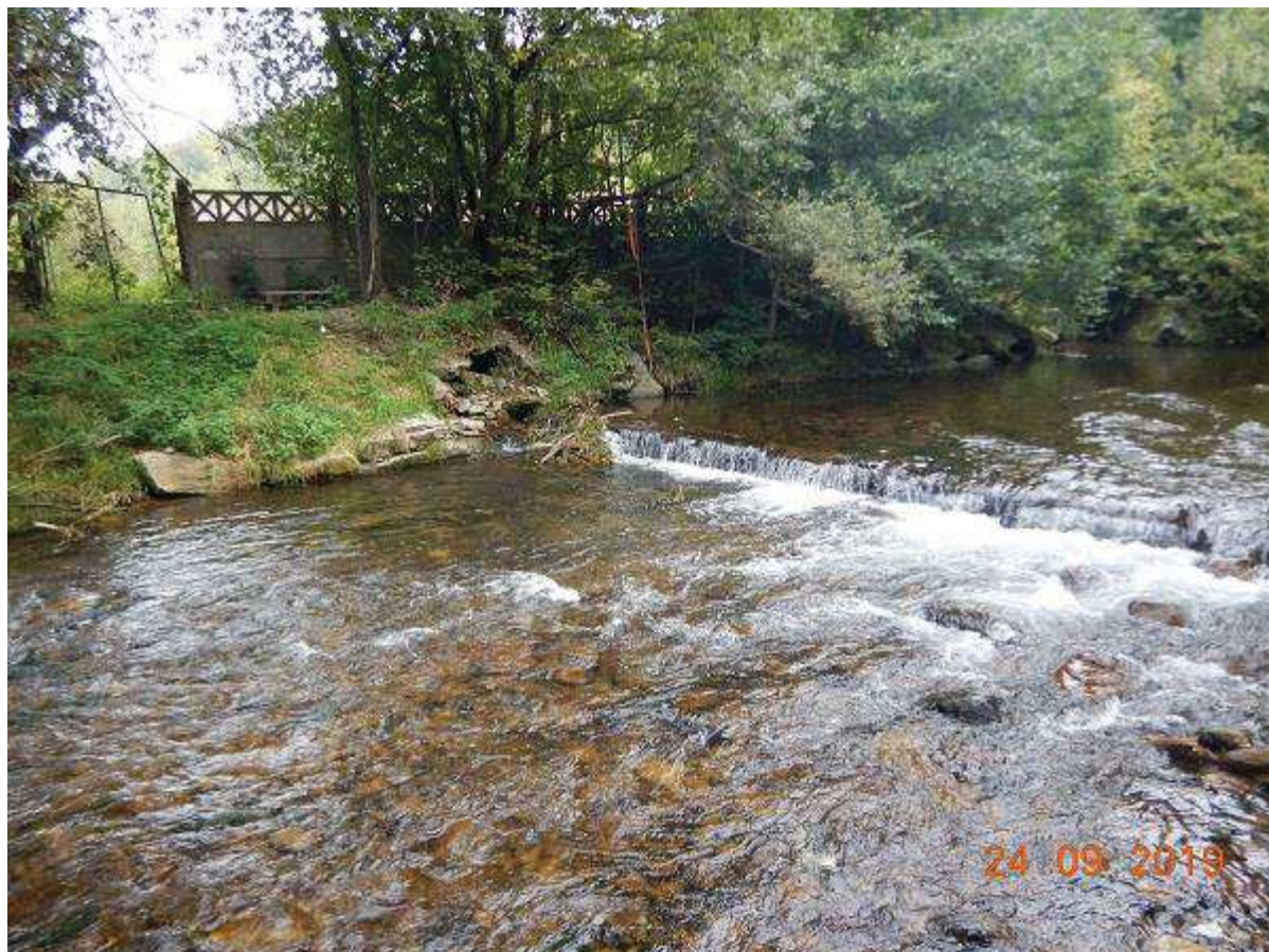
Fot. 21 Odbudowa istniejących i budowa nowych umocnień brzegowych (lewobrzeżnych) w obrębie progu dennego w km 31+400
