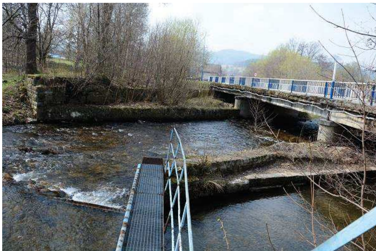
Fot. 25 Reprofilacja murów brzegowych koryta z rozbiorą obiektów ujęcia wody pitnej (BP) powyżej mostu M-40 w km 31+473. Przebudowa koryta i murów dla umożliwienia przepuszczenia WWQ prawym światłem mostu. [widok od GW mostu]
