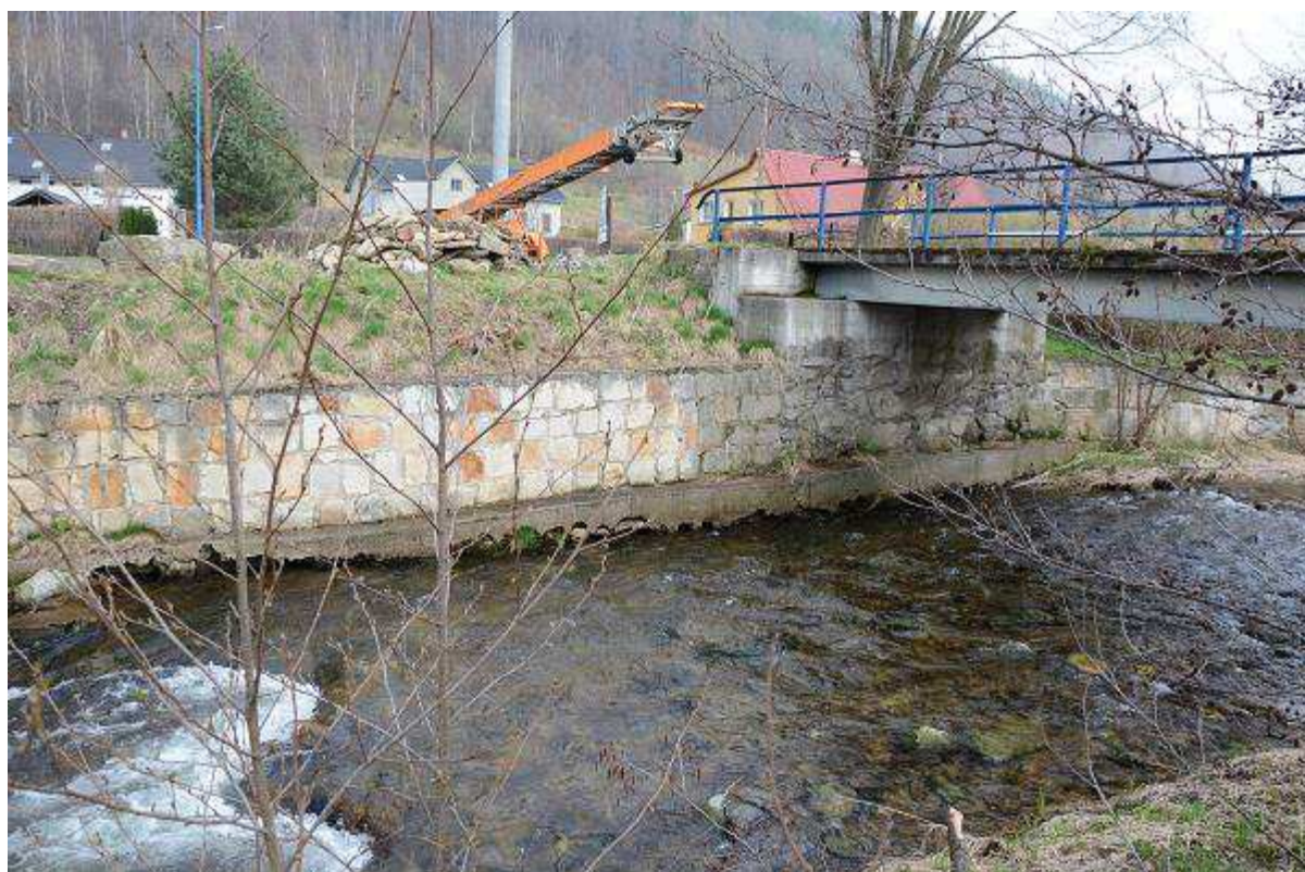
Fot. 29 Rozbiórka i odbudowa muru prawobrzeżnego (skrzydełka) poniżej i reprofilacja muru skrzydełka powyżej mostu M-41 na odc. km 31+735 ÷ 31+800
