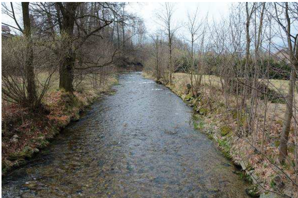
Fot. 33 Reprofilacja umocnień brzegowych z ukształtowaniem linii brzegu i odcinkową budową umocnienia skarp: lewobrzeżnej na odc. km 32+010 ÷ 32+230 i prawobrzeżnej na odc. km 32+155 ÷ 32+280 [widok koryta od GW]
