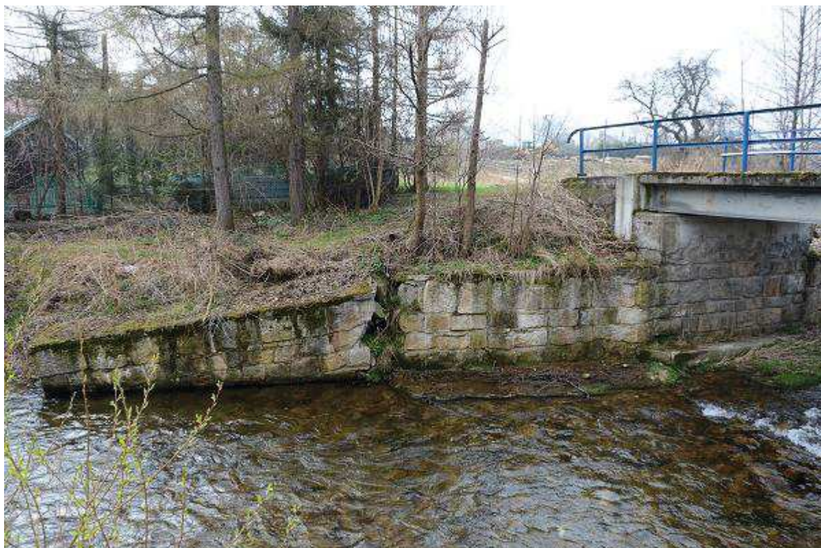
Fot. 31 Rozbiórka i odbudowa lewobrzeżnego (skrzydełka) powyżej mostu M-41 km 31+770
