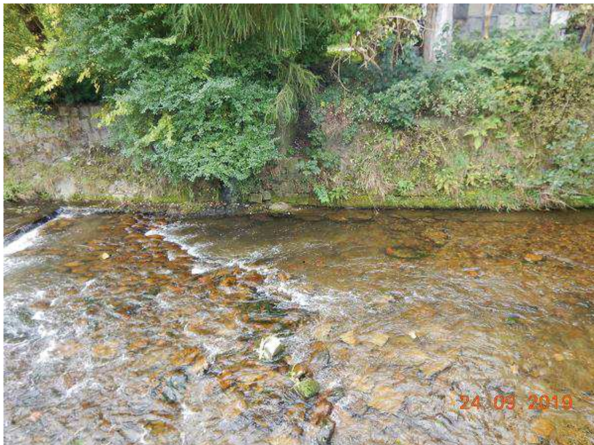
Fot. 7 Rozbiórka prawego muru na odc. 30+870 ÷ 30+880 z odbudową zniszczonego ciągu schodów i odbudowa muru dł. ca 10 m
