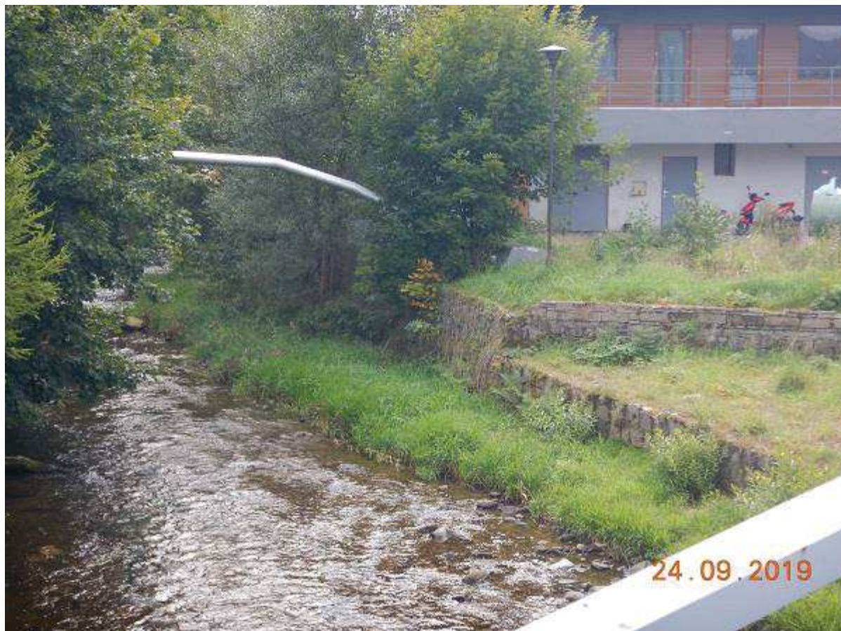
Fot. 12 c.d. Reprofilacja lewobrzeżnych murów korytowych i brzegowych powyżej mostu M-39 na odc. km 30+946 ÷ 30+970
