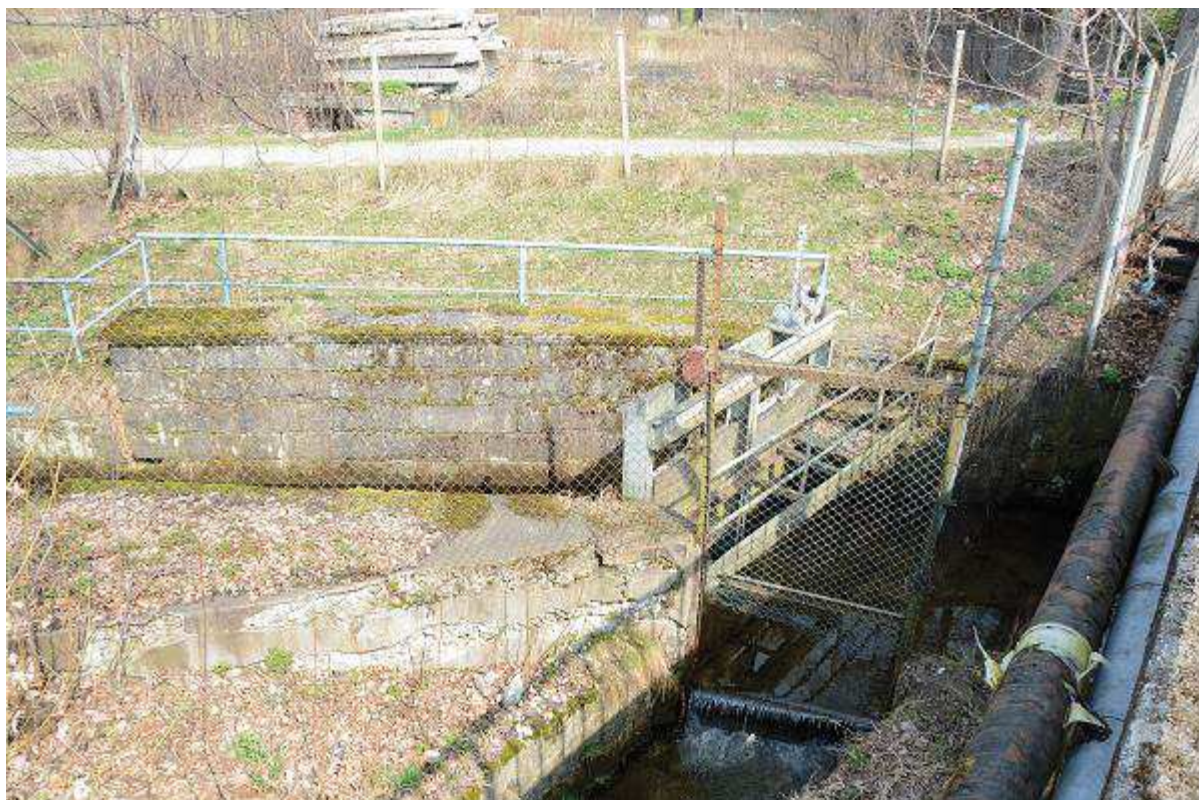
Fot. 24 Rozbiórka obiektów ujęcia wody pitnej (BP) poniżej mostu M-40 w km 31+458 [widok koryta od DW mostu]
