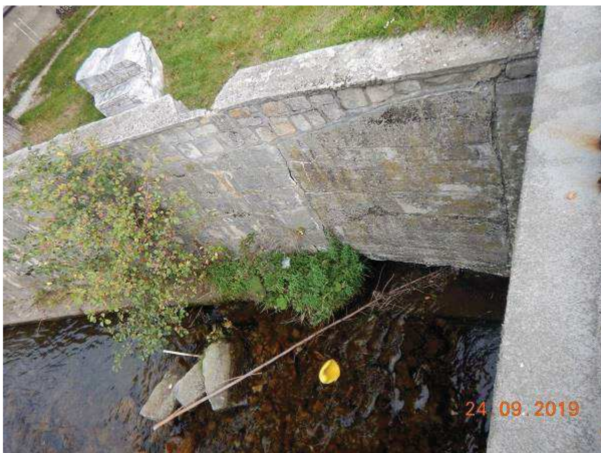
Fot. 10 Reprofilacja prawobrzeżnego muru brzegowego (skrzydełka) poniżej mostu M-39 na odc. km 30+920 ÷ 30+935 [widok z mostu]
