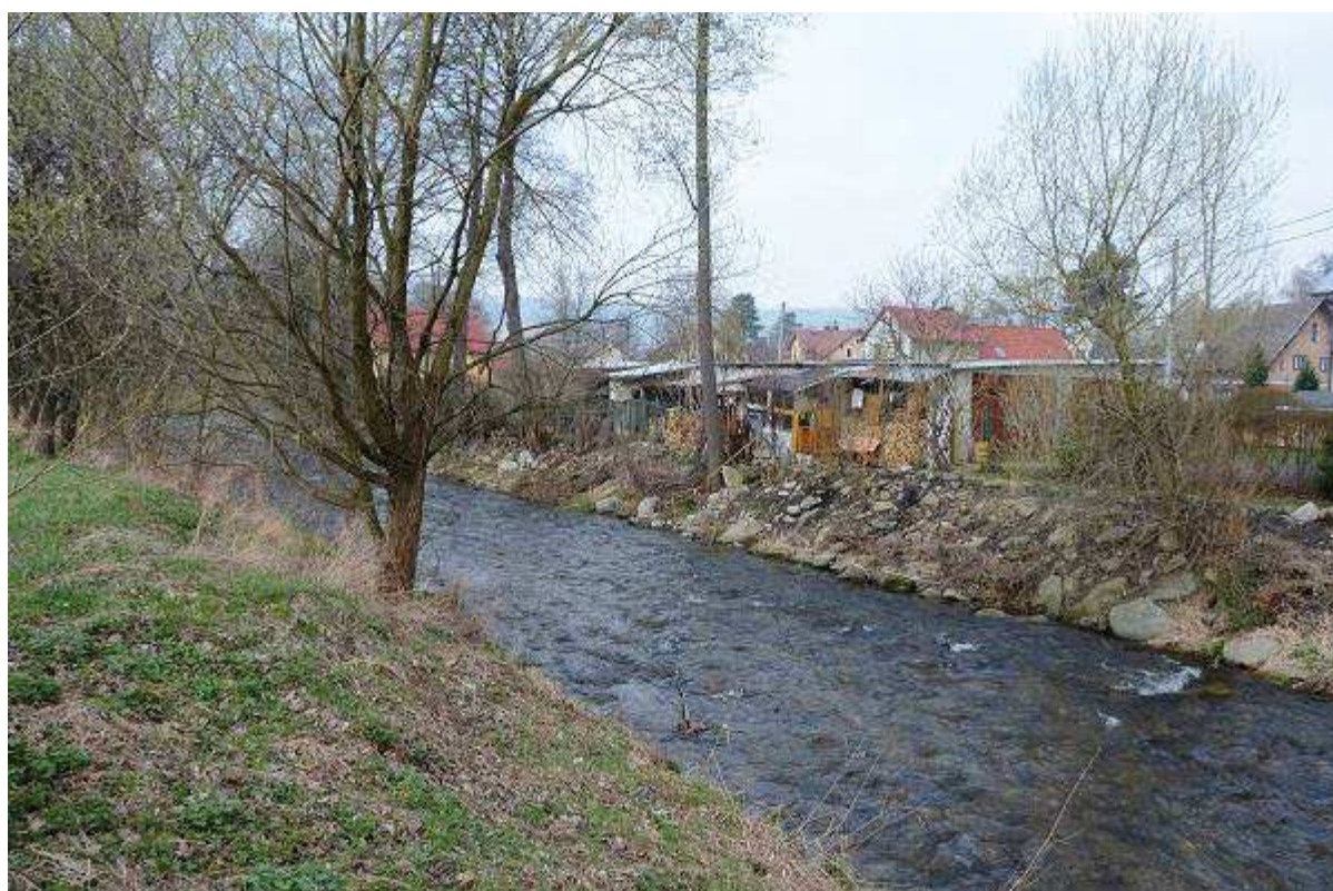
Fot. 27 c.d. Budowa prawobrzeżnego muru brzegowego na odcinku km 31+490 ÷ 31+735 [widok koryta od GW]
