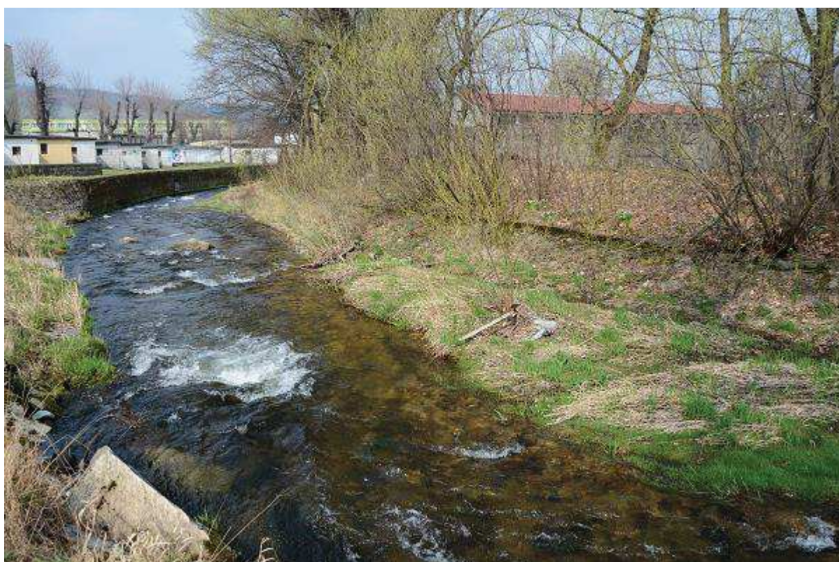
Fot. 18 Reprofilacja umocnień kamiennych skarpy prawobrzeżnej z usunięciem odsypiska w korycie na odc. km 31+245÷31+400 [widok koryta od GW]
