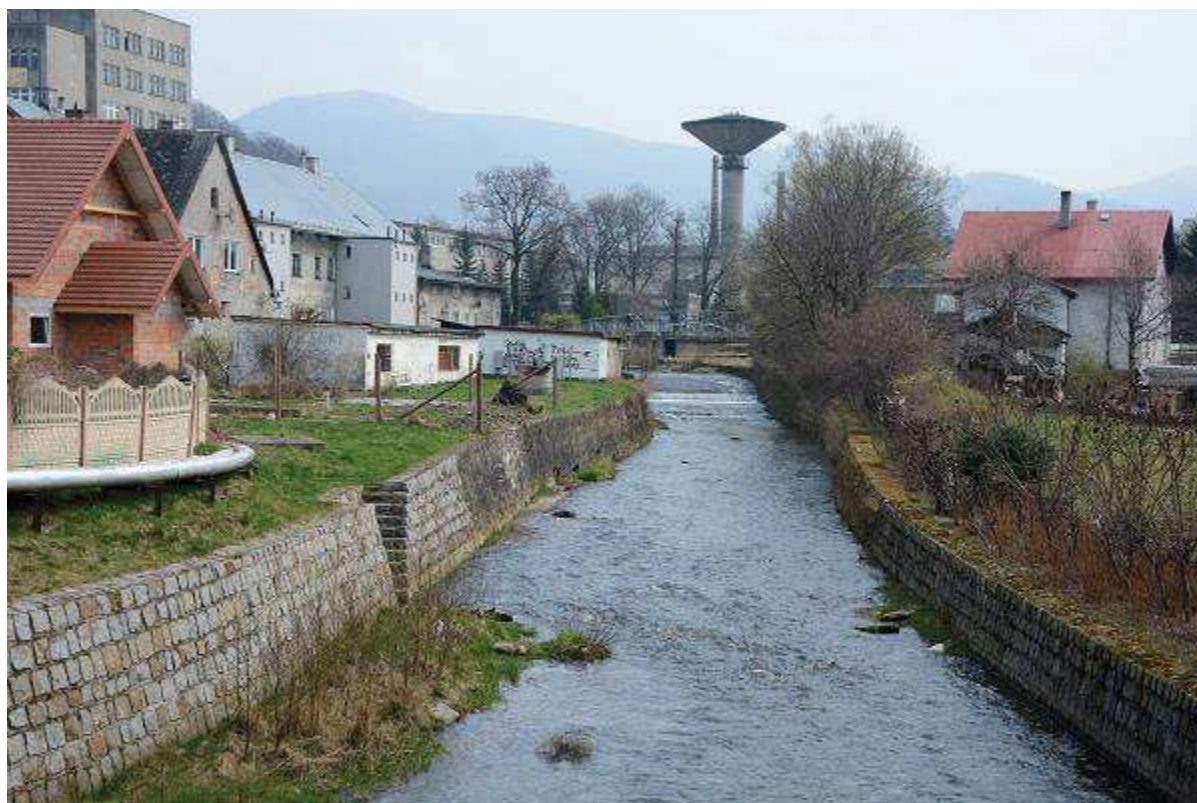
Fot. 6 Reprofilacja murów: lewo- i prawobrzeżnego powyżej mostu M-38 na odc. km 30+745 ÷ 30+900 [widok koryta od DW]
