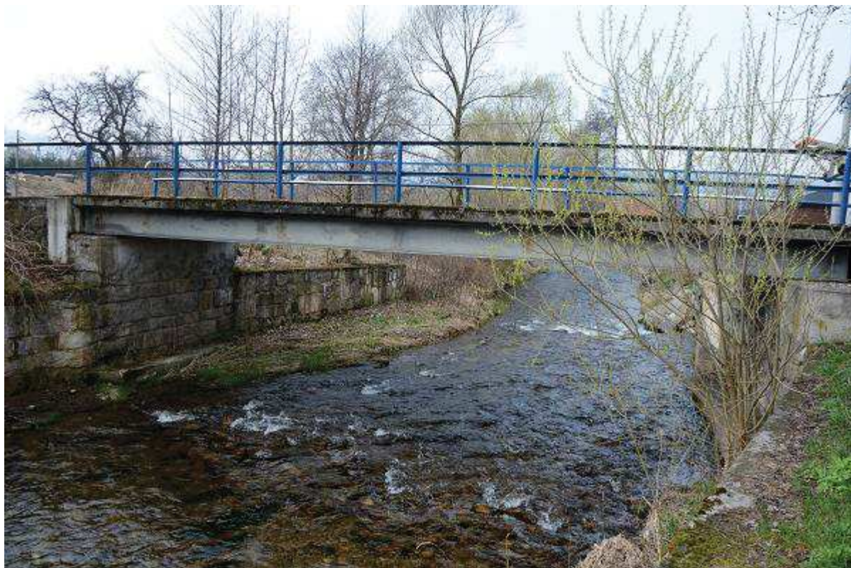
Fot. 30 Reprofilacja muru lewobrzeżnego (skrzydełka) poniżej mostu M-41 km 31+765 [widok koryta od GW]
