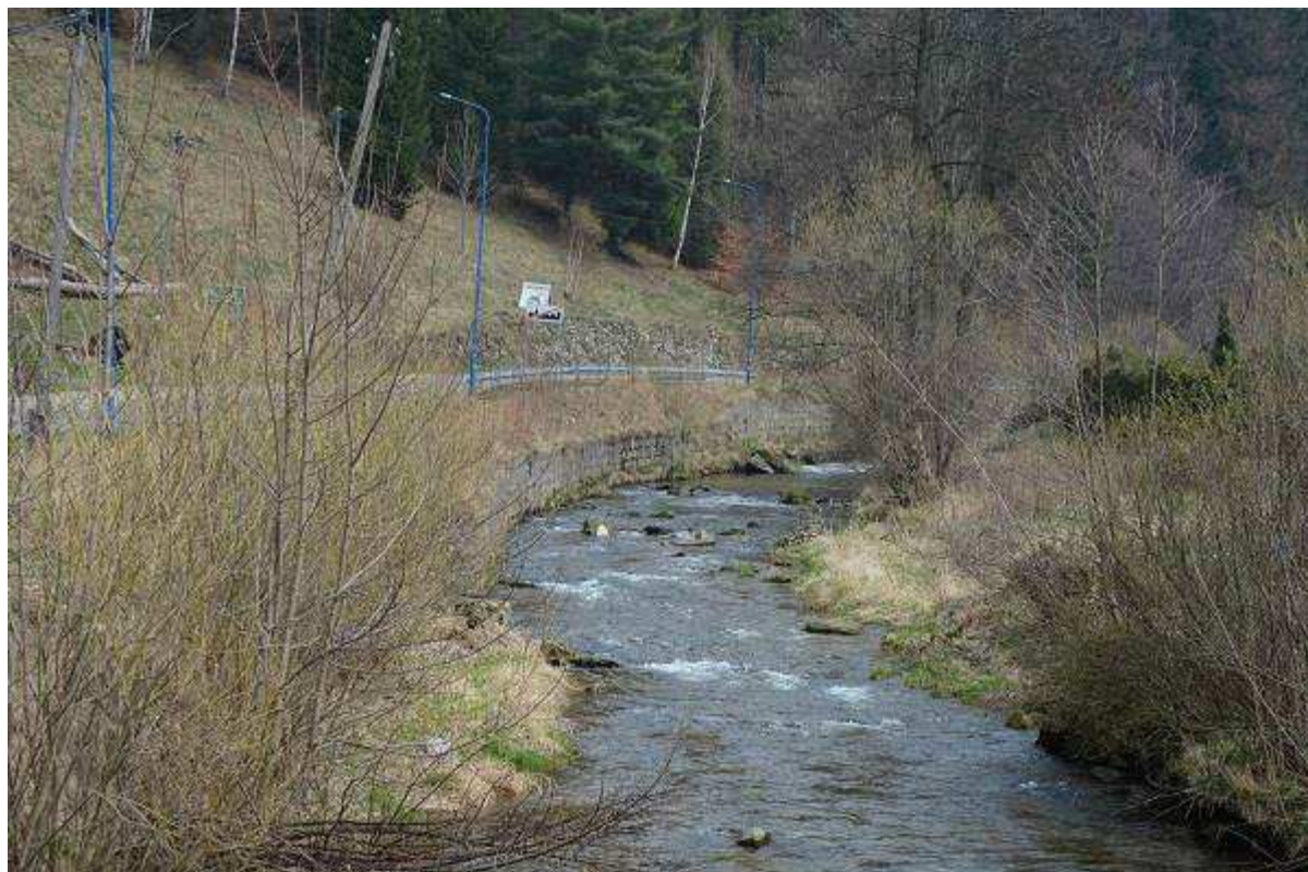
Fot. 34 Reprofilacja muru prawobrzeżnego z odbudową odsadzki na odcinku km 32+280 ÷ 32+345 [widok koryta od DW]
