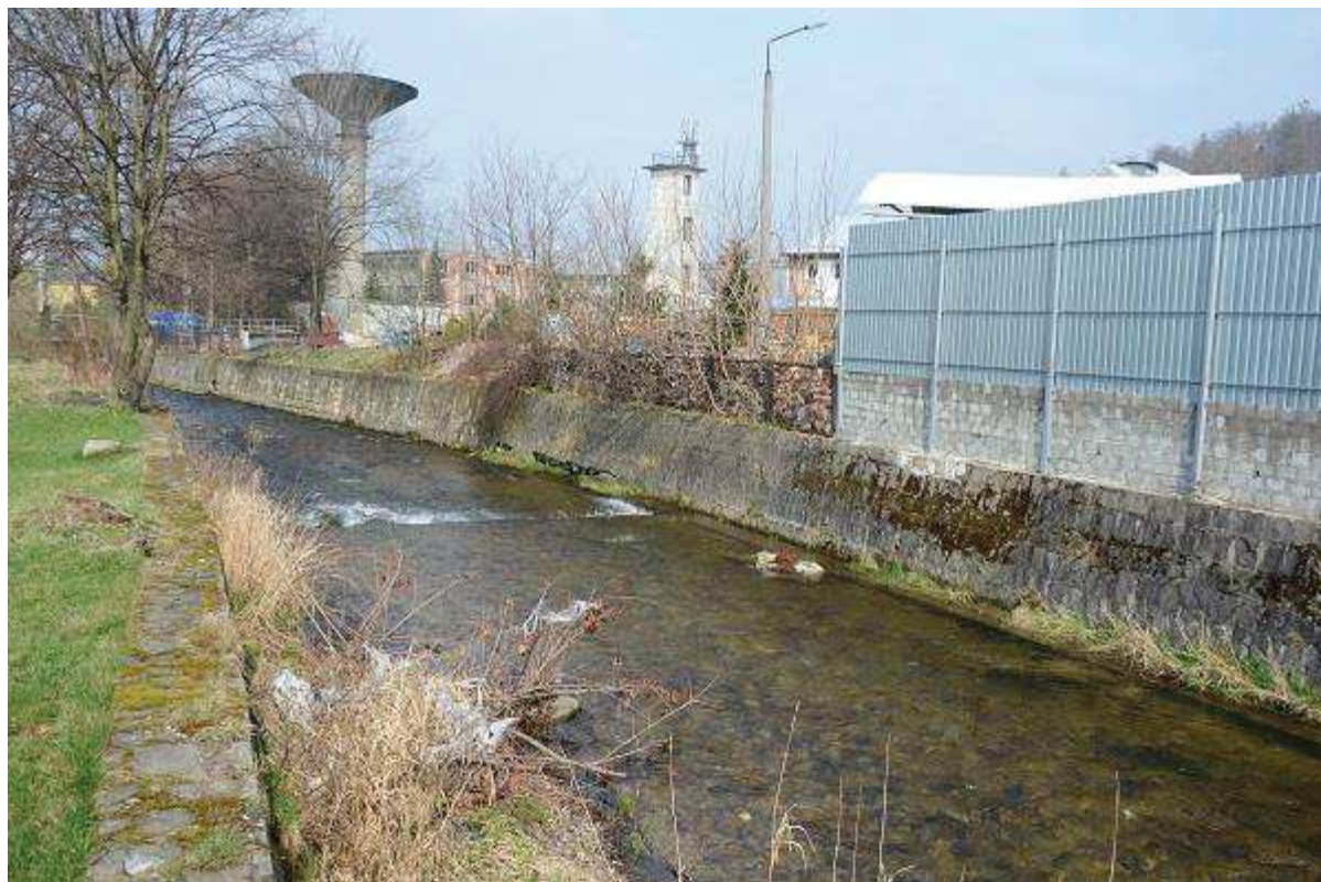
Fot. 15 Reprofilacja muru prawobrzeżnego na odcinku km 30+946 ÷ 31+185 [widok koryta od GW]
