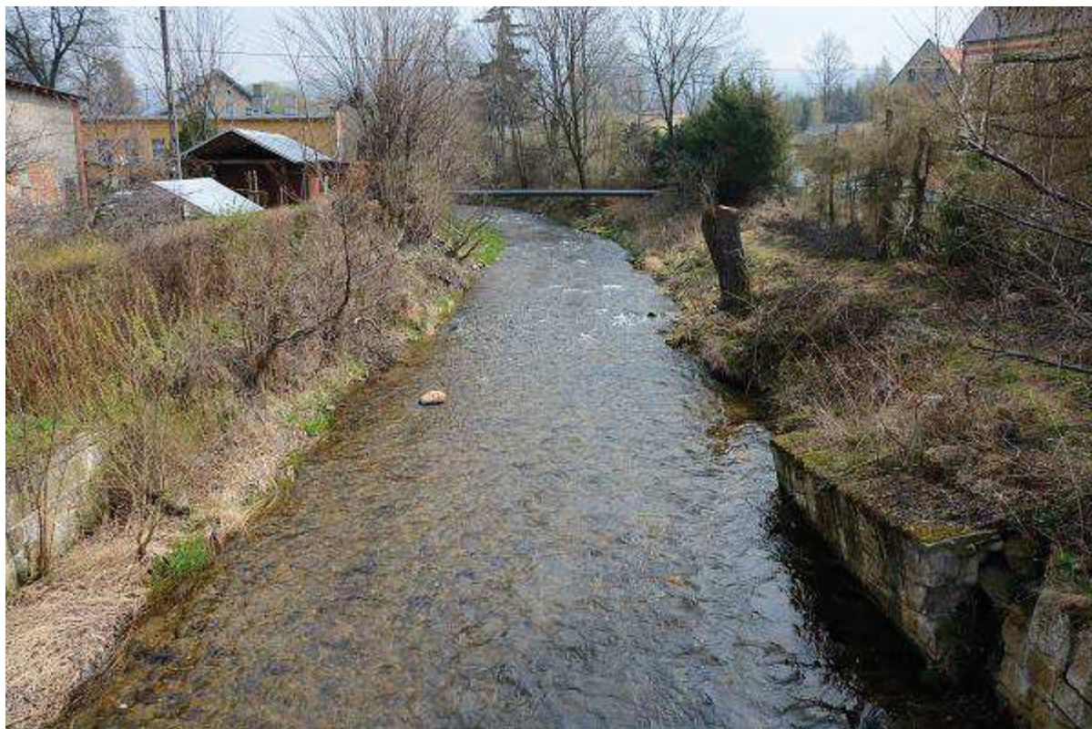
Fot. 32 Ukształtowanie linii brzegów i budowa umocnień skarp: lewobrzeżnej na odc. km 31+795 ÷ 32+010 i prawobrzeżnej na odc. km 31+800 ÷ 32+010 [widok koryta od DW]
