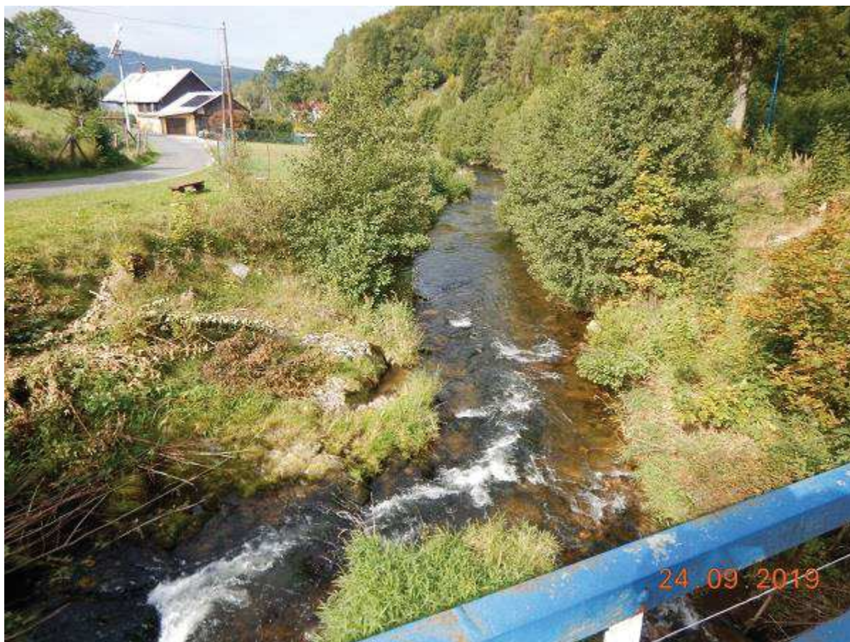
Fot. 37 Ukształtowanie linii brzegów i budowa umocnień skarpy lewo- i prawobrzeżnej poniżej mostu M-43 km 32+485 [widok od DW mostu] KONIEC OPRACOWANIA km 32+485
