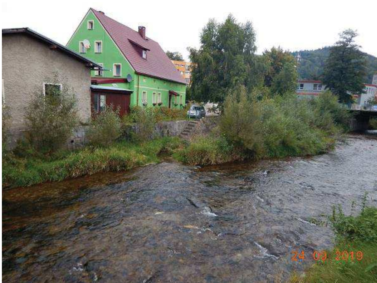
Fot. 4 Wykonanie robót w zakresie usunięcia namuliska wzdłuż brzegu prawego, poniżej mostu M-38 dla udrożnienia jego światła [widok koryta od DW mostu]
