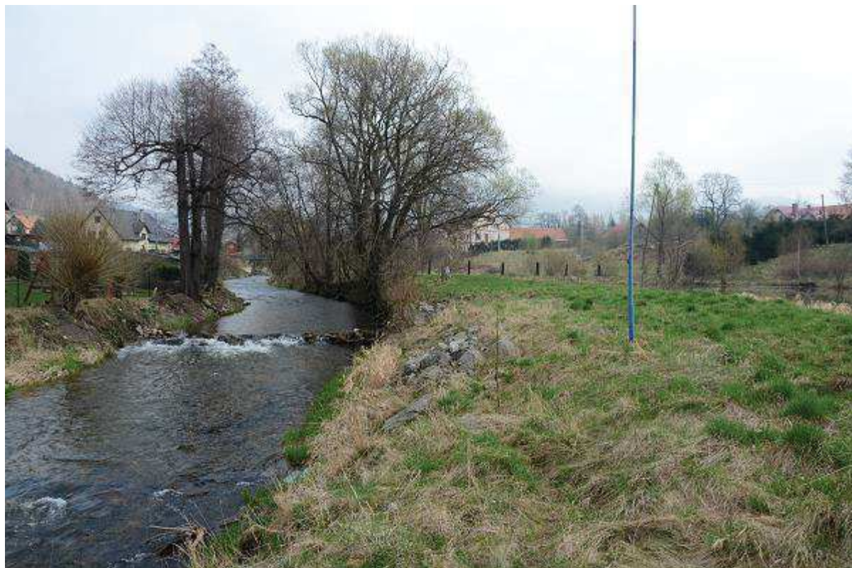
Fot. 28 Reprofilacja lewobrzeżnych umocnień brzegowych z ukształtowaniem linii brzegu i odcinkową budową umocnienia skarpy km 31+490 ÷ 31+625. Budowa prawobrzeżnego muru brzegowego na odcinku km 31+490 ÷ 31+735 [widok koryta od DW]
