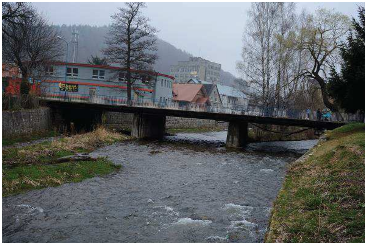
Fot. 10A Most M-39 brak działań [widok mostu od DW]
