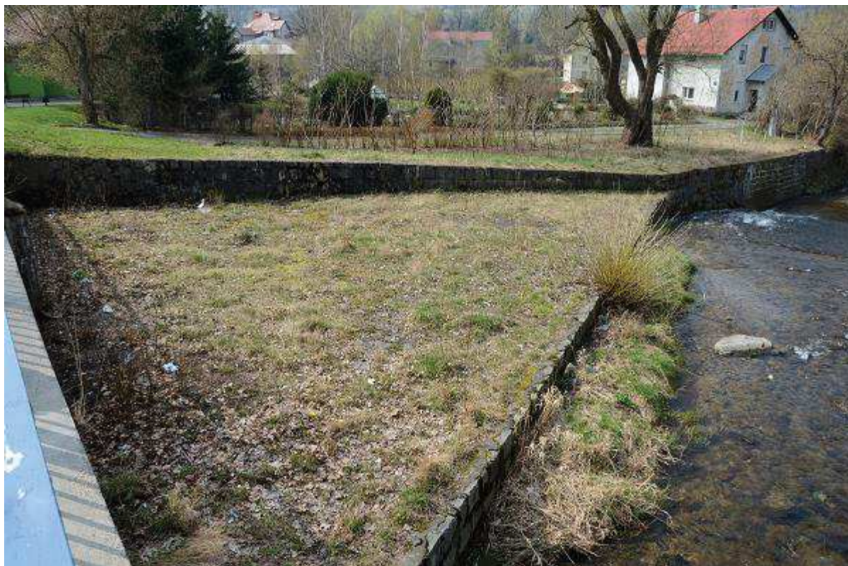
Fot. 9 Reprofilacja lewobrzeżnych murów korytowych i brzegowych poniżej mostu M-39 na odc. km 30+920 ÷ 30+935 [widok z mostu]
