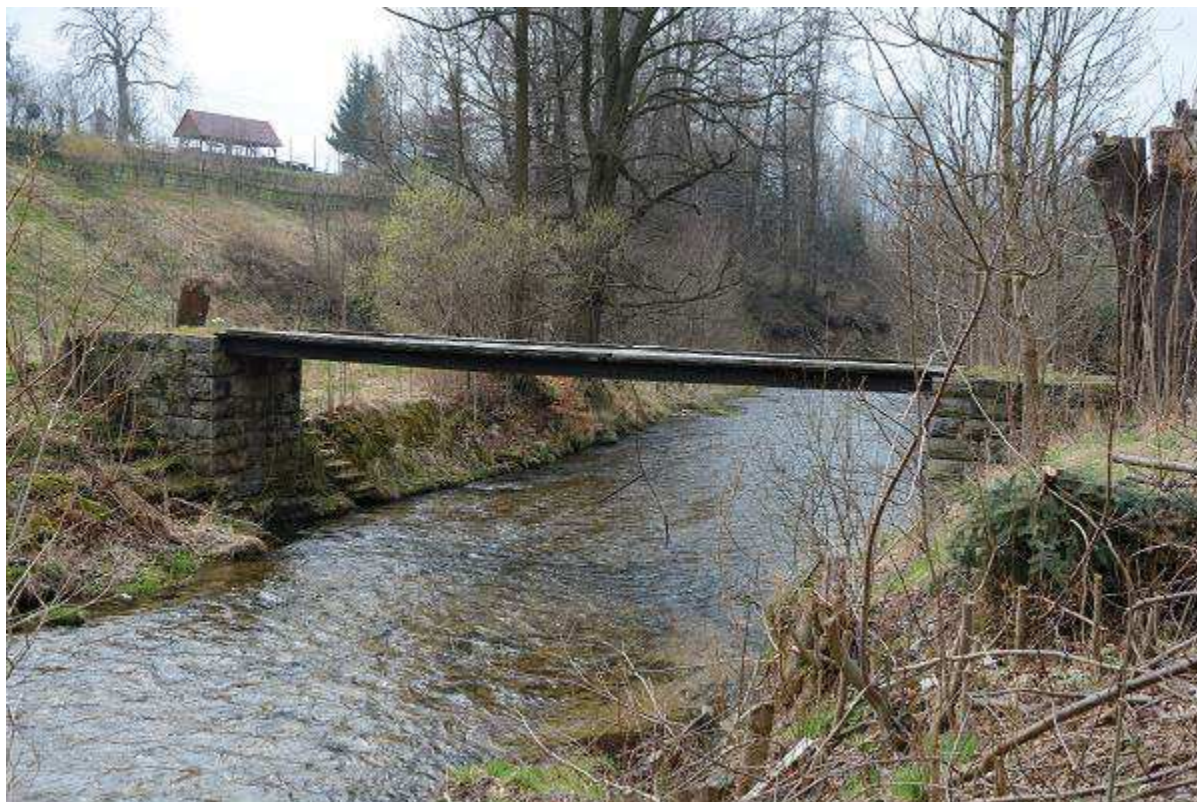
Fot. 36 Reprofilacja brzegowych murów (przyczółków) kładki, umocnień skarpowych z kamienia i schodów [widok od GW]
