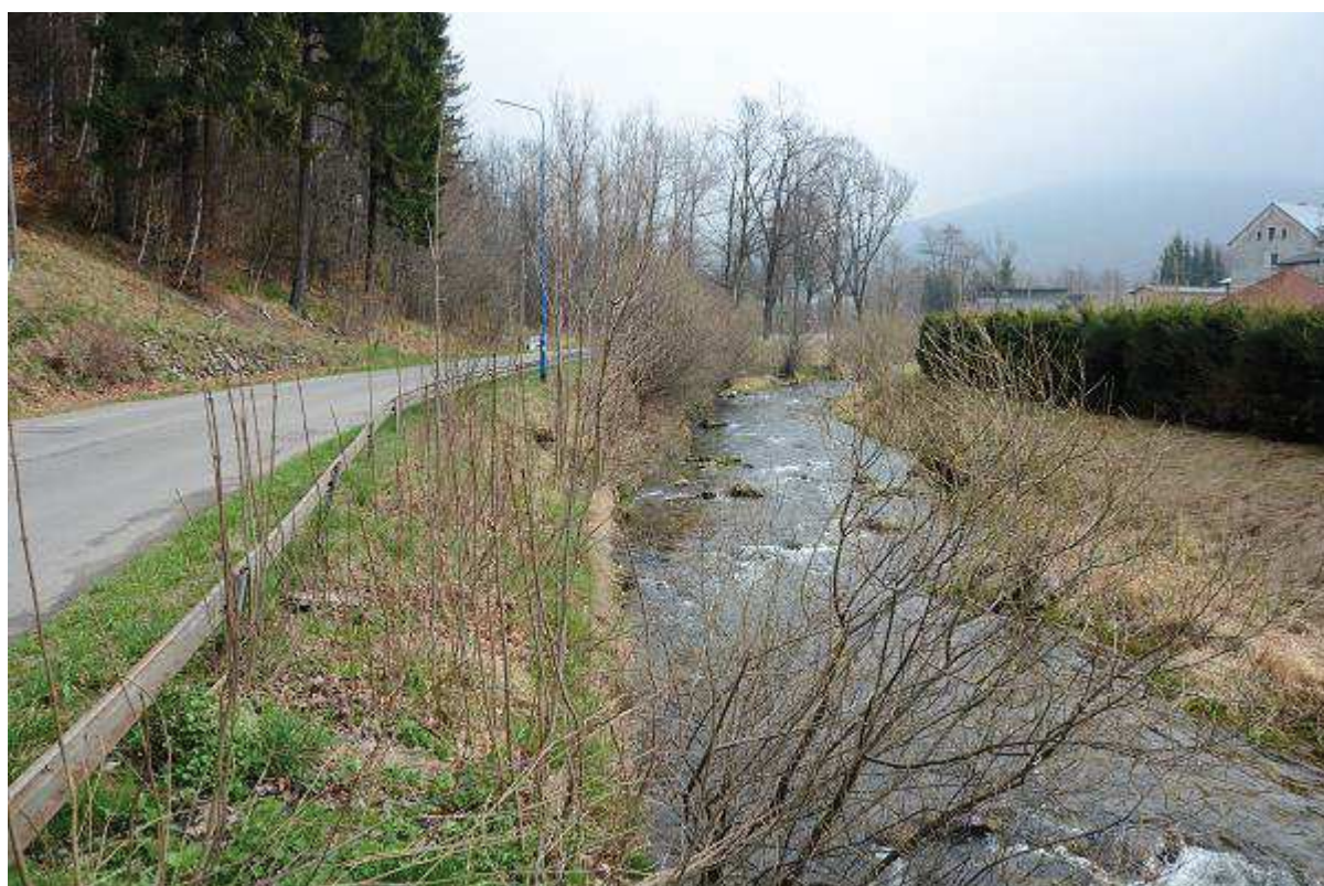
Fot. 35 Ukształtowanie linii brzegu i budowa umocnień skarpy prawobrzeżnej na odc. km 32+345 ÷ 32+485 [widok koryta od DW]
