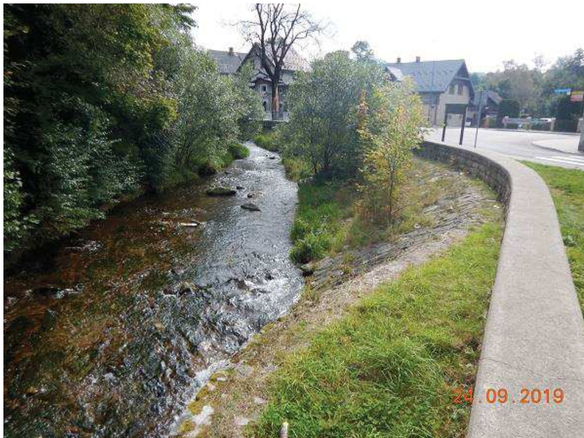
Fot. 19 Reprofilacja lewobrzeżnych umocnień kamiennych skarpy i muru terenowego na odc. km 31+270 ÷ 31+315. Oczyszczenie ubezpieczeń z krzewów i zakrzaczeń. [widok koryta od DW]
