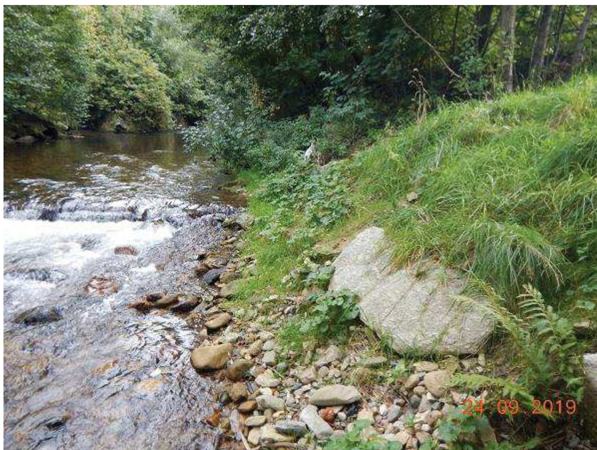
Fot. 22 Budowa umocnień brzegowych (lewobrzeżnych) w obrębie progu dennego w km 31+400
