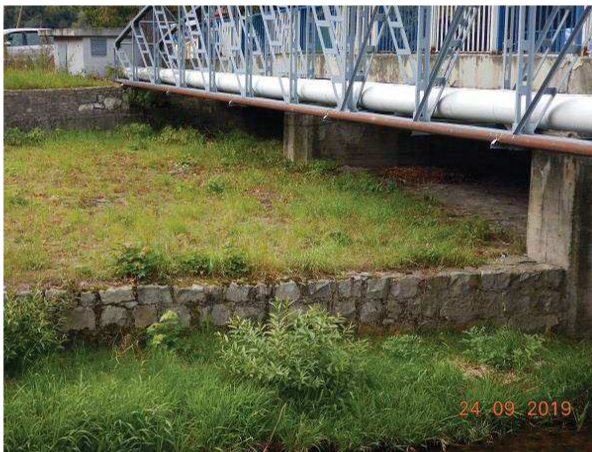
Fot. 11 Reprofilacja lewobrzeżnych murów korytowych i brzegowych powyżej mostu M-39 na odc. km 30+946 ÷ 30+970
