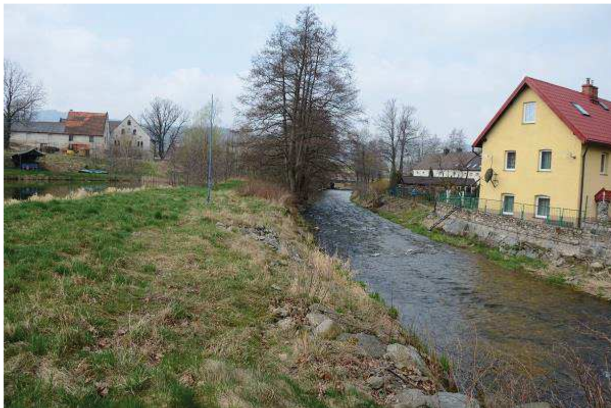
Fot. 26 Budowa prawobrzeżnego muru brzegowego na odcinku km 31+490 ÷ 31+735. Reprofilacja lewobrzeżnych umocnień brzegowych z ukształtowaniem linii brzegu i odcinkową budową umocnienia skarpy km 31+490 ÷ 31+625 [widok koryta od GW]
