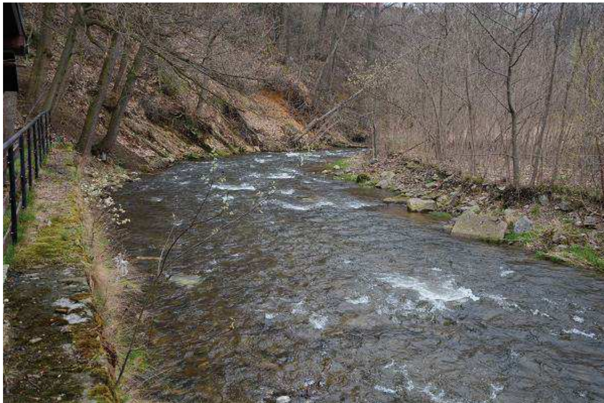
Fot. 1 Umocnienie skarpy brzegu lewego (łuk wklęsły) na odc. km 30+500 ÷ 30+585 [widok koryta od GW] oraz istn. brzegowy mur lewobrzeżny do reprofilacji na odc. km 30+585 ÷ 30+732 (do mostu dr. M-38)
