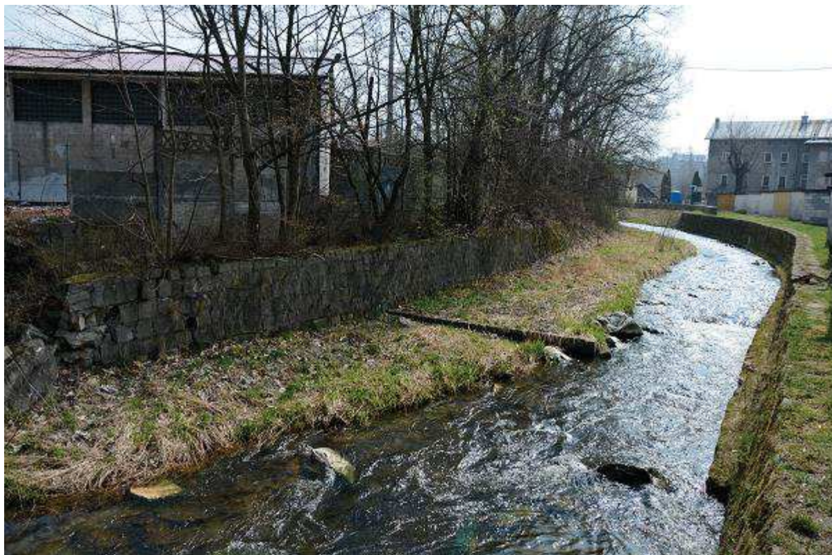
Fot. 17 Reprofilacja muru prawobrzeżnego z usunięciem odsypiska w korycie na odcinku km 31+215 ÷ 31+245 [widok koryta od DW]
