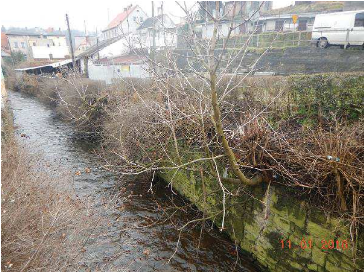
Fot. 7 Reprofilacja muru na odcinku 0+129 – 0+324 (BP)
