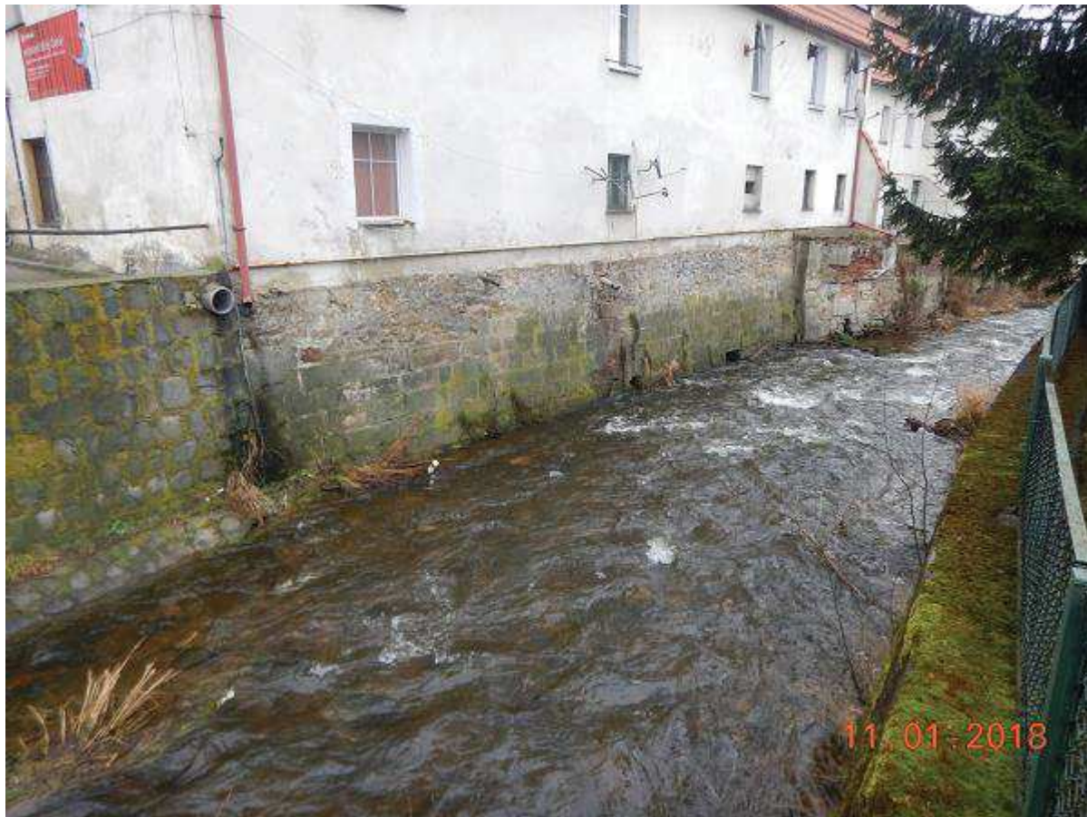
Fot. 1 Reprofilacja muru na odcinku 0+005 – 0+115 (BL) - ujściowy odcinek potoku Bystrzyca
