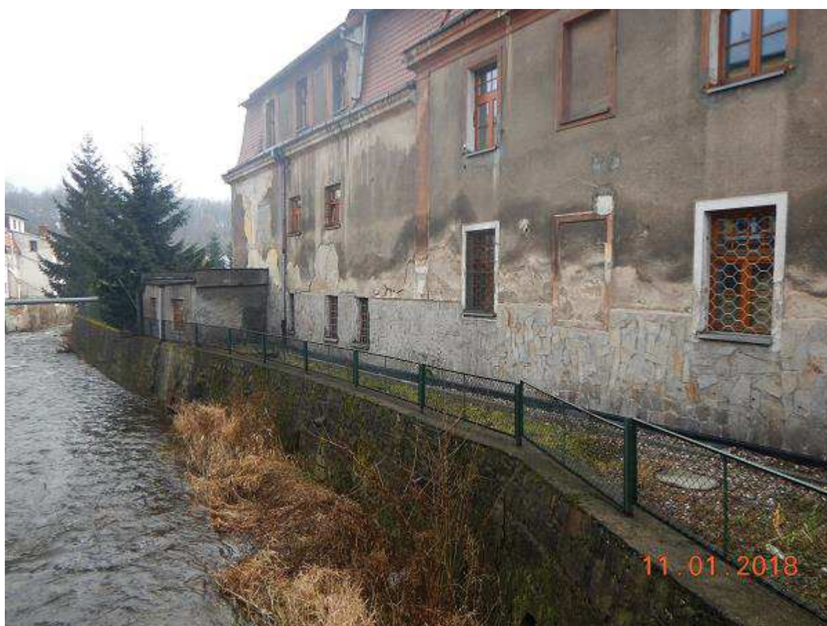
Fot. 4 Reprofilacja muru na odcinku 0+017 – 0+118 (BP) - ujściowy odcinek potoku Bystrzyca
