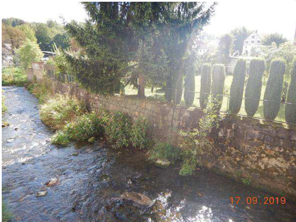
Fot. 3 Reprofilacja muru na odcinku 0+017 – 0+118 (BP) - ujściowy odcinek potoku Bystrzyca
