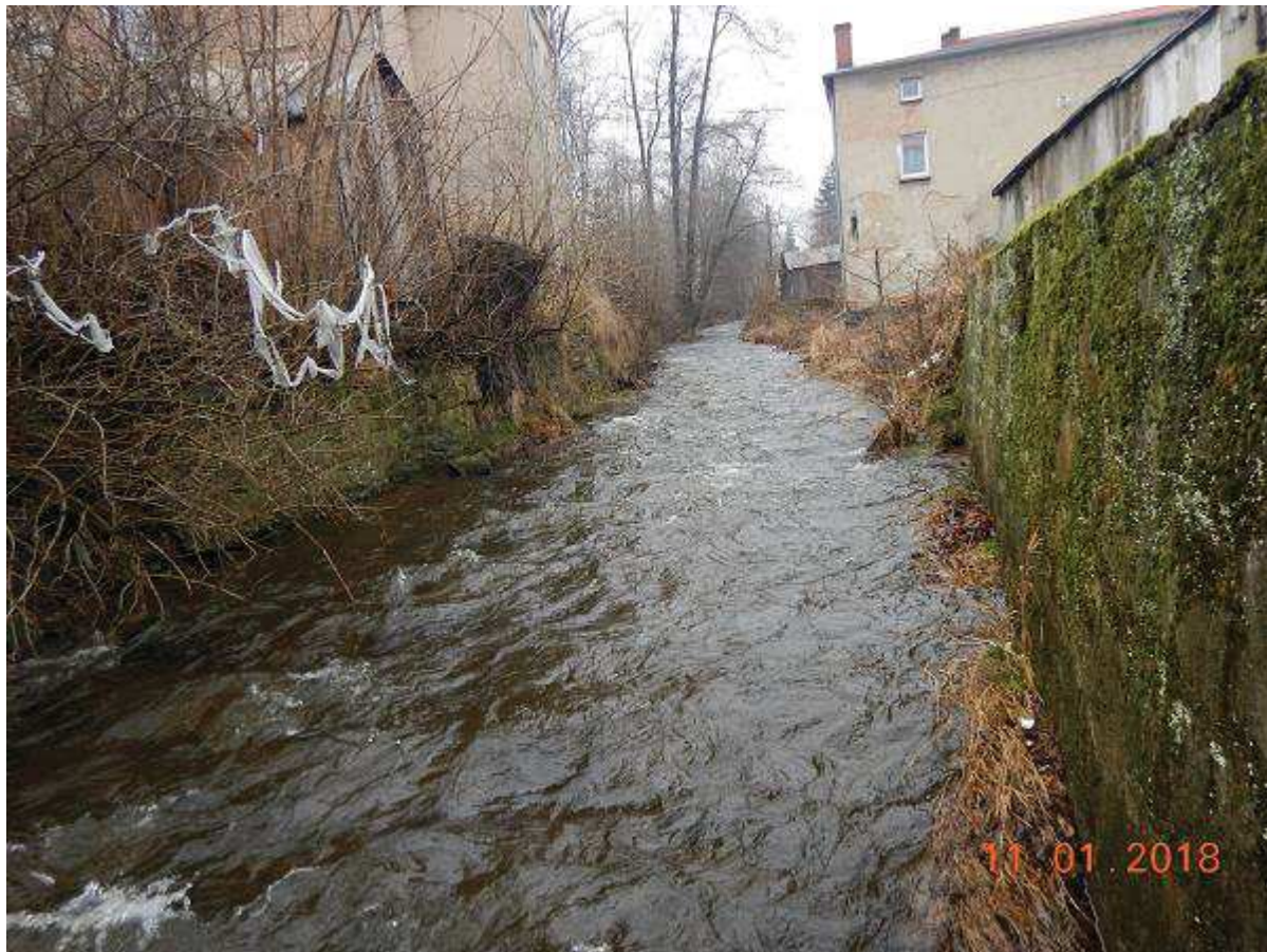
Fot. 9 Refilacja muru na odcinku 0+129 – 0+324 (BP) i Refilacja muru na odcinku 0+298 – 0+322 (BL)
