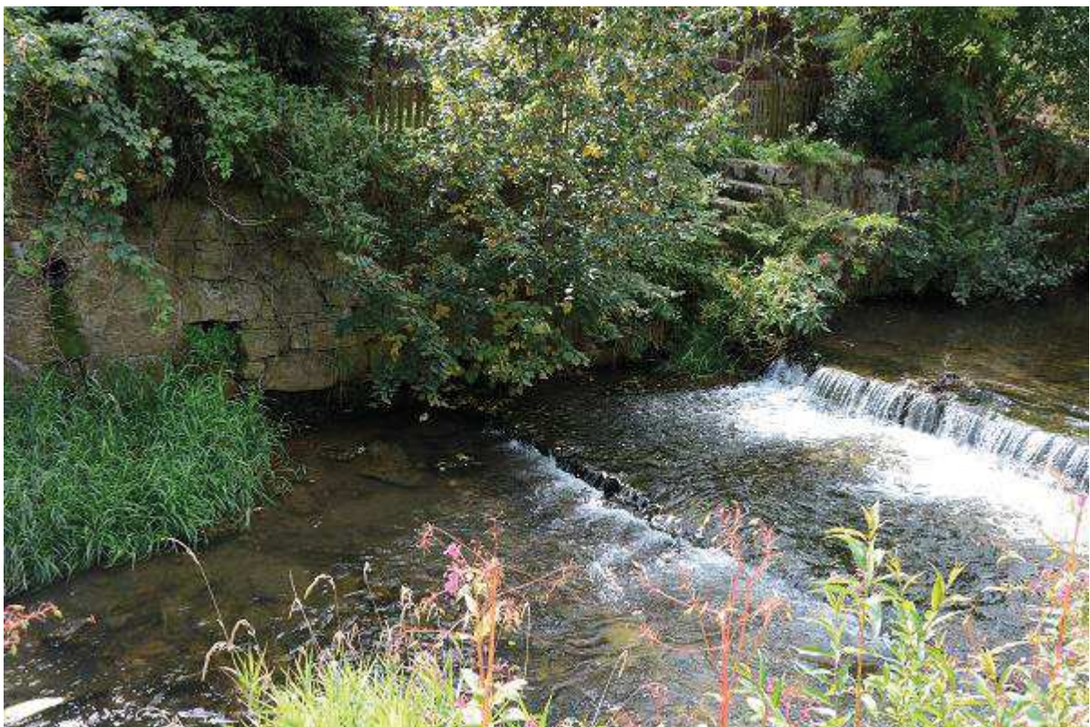
Fot. 6 Reprofilacja muru na odcinku 0+129 – 0+324 (BP)
