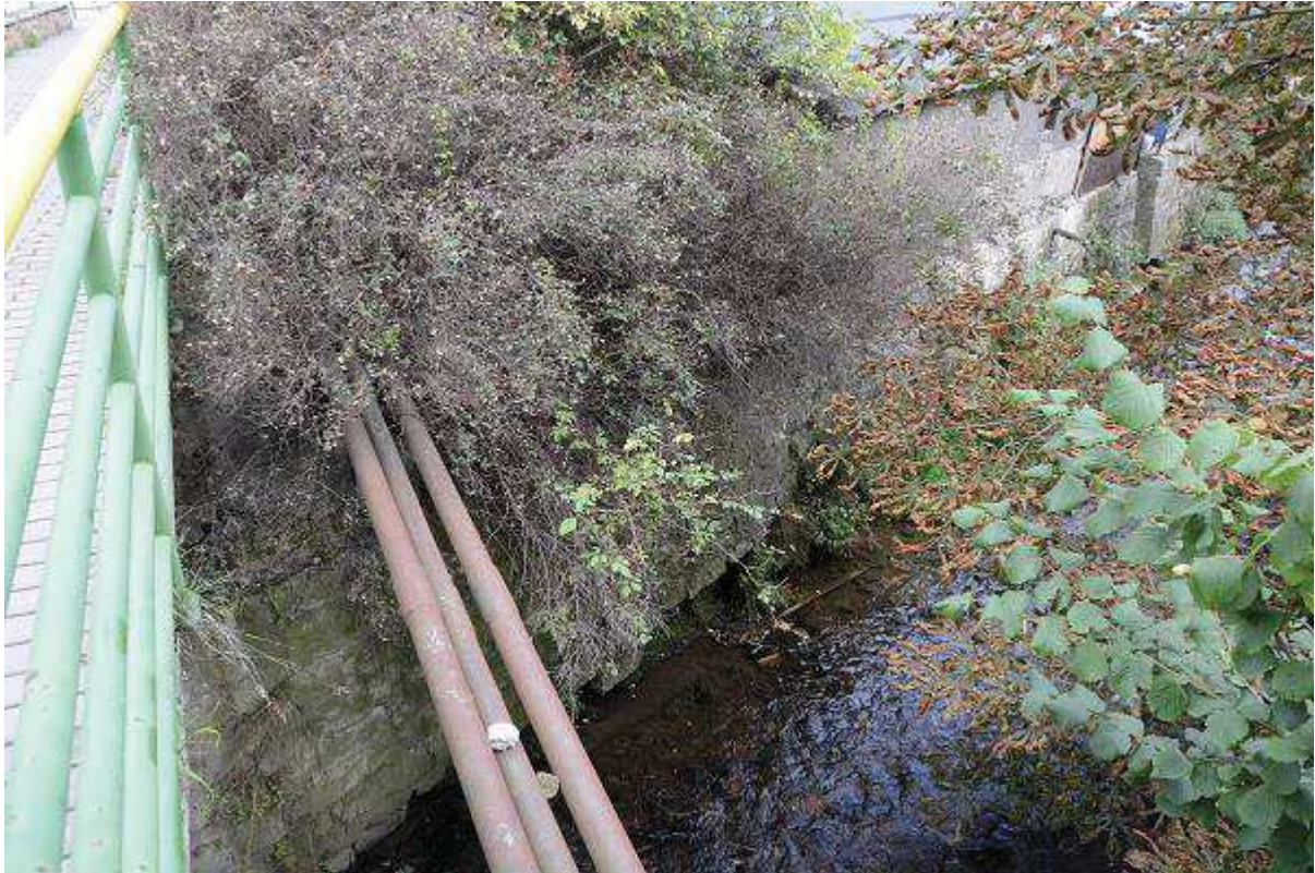
Fot. 11 Reprofilacja muru na odcinku 0+129 – 0+297 (BL)
