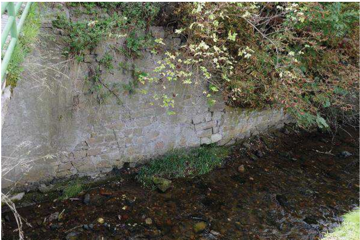
Fot. 8 Reprofilacja muru na odcinku 0+129 – 0+324 (BP)
