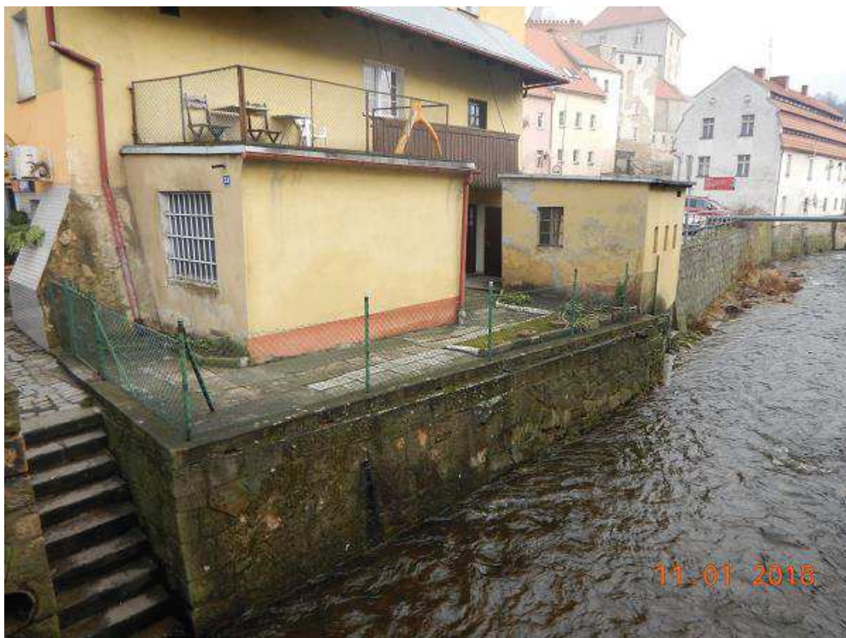
Fot. 2 Reprofilacja muru na odcinku 0+005 – 0+115 (BL) - ujściowy odcinek potoku Bystrzyca
