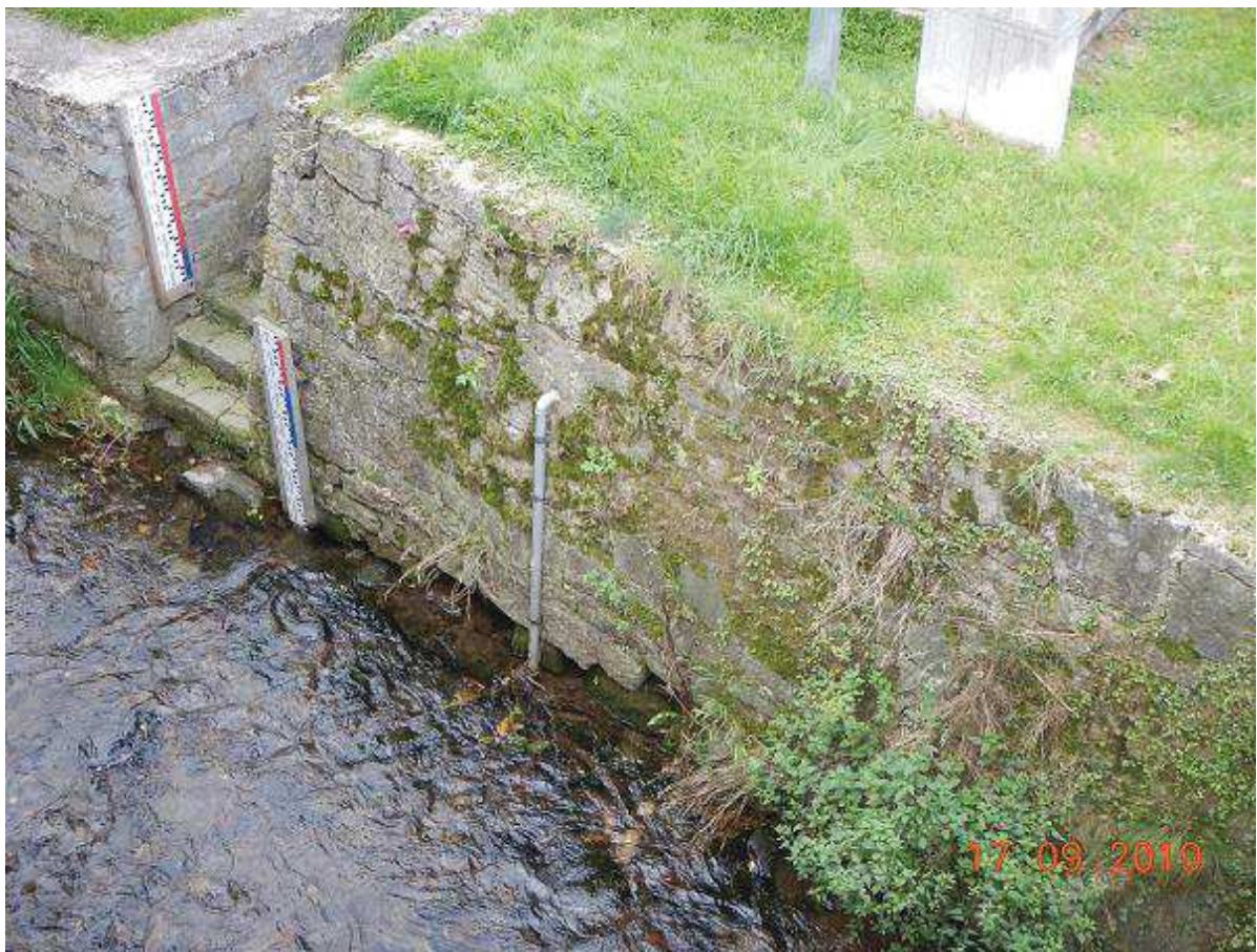
Fot. 12 Reprofilacja muru na odcinku 0+129 – 0+297 (BL)
