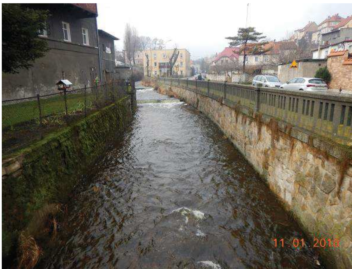
Fot. 10 Refilacja muru na odcinku 0+129 – 0+297 (BL)
