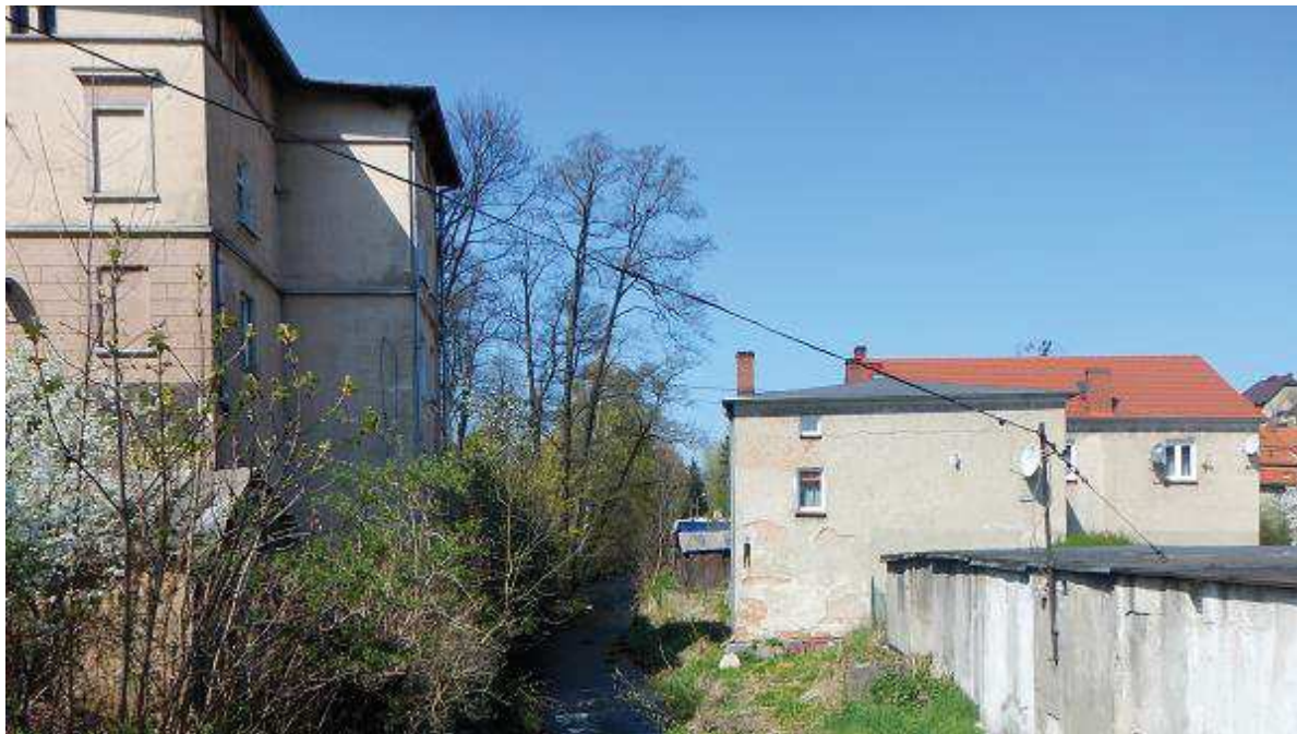
Fot. 13 Reprofilacja muru na odcinku 0+298 – 0+322 (BL)
