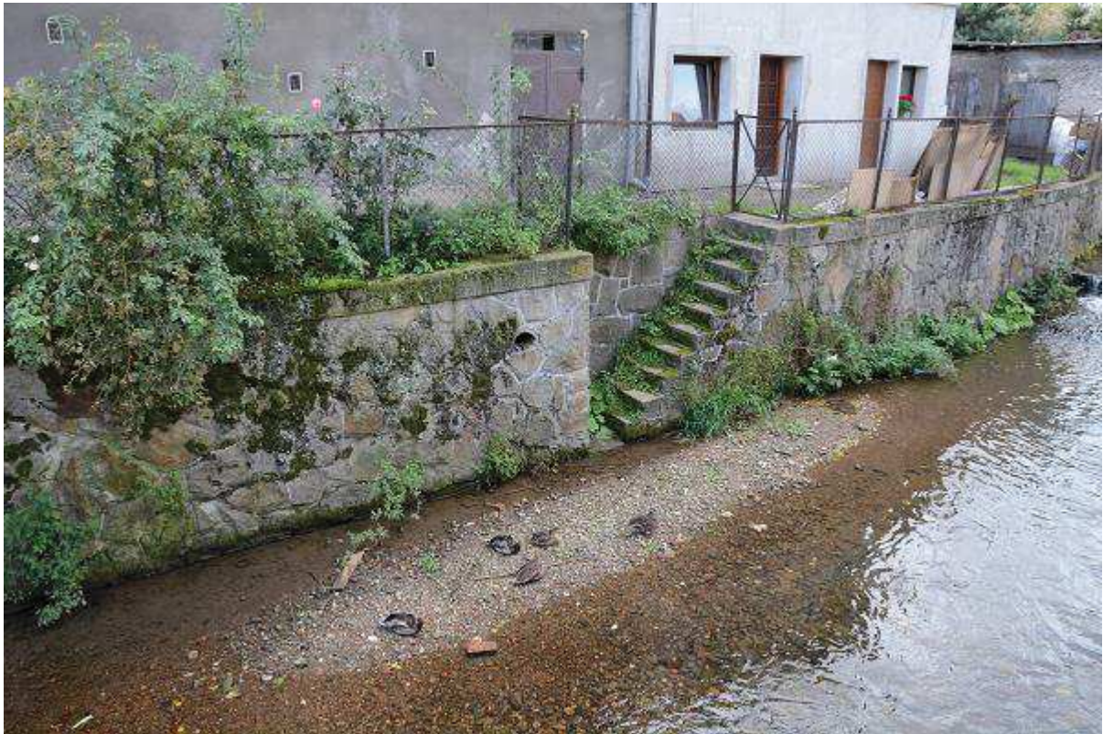
Fot. 5 Reprofilacja muru na odcinku 0+129 – 0+324 (BP)
