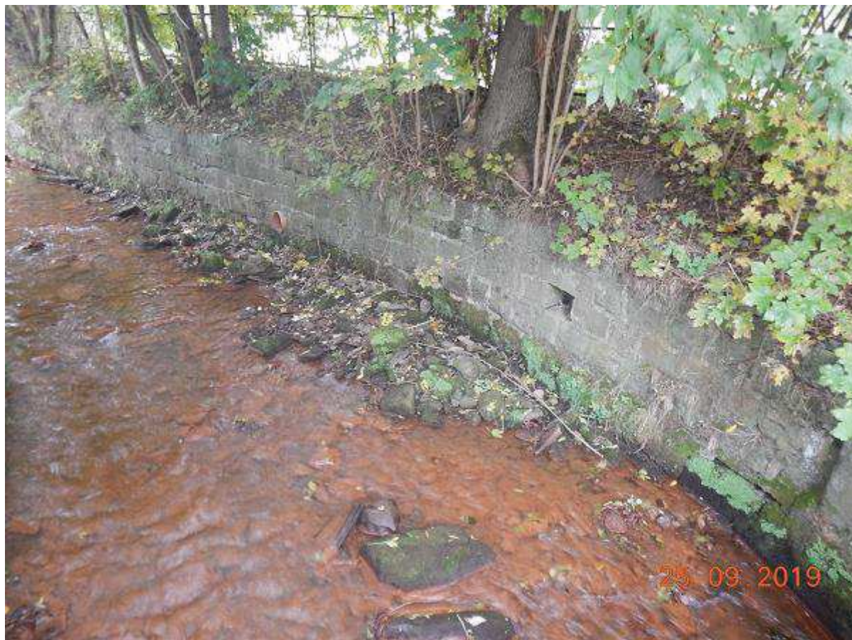
Fot. 38 Rozbiórka i odbudowa muru na odcinku 27+556 – 27+583 (BL)
