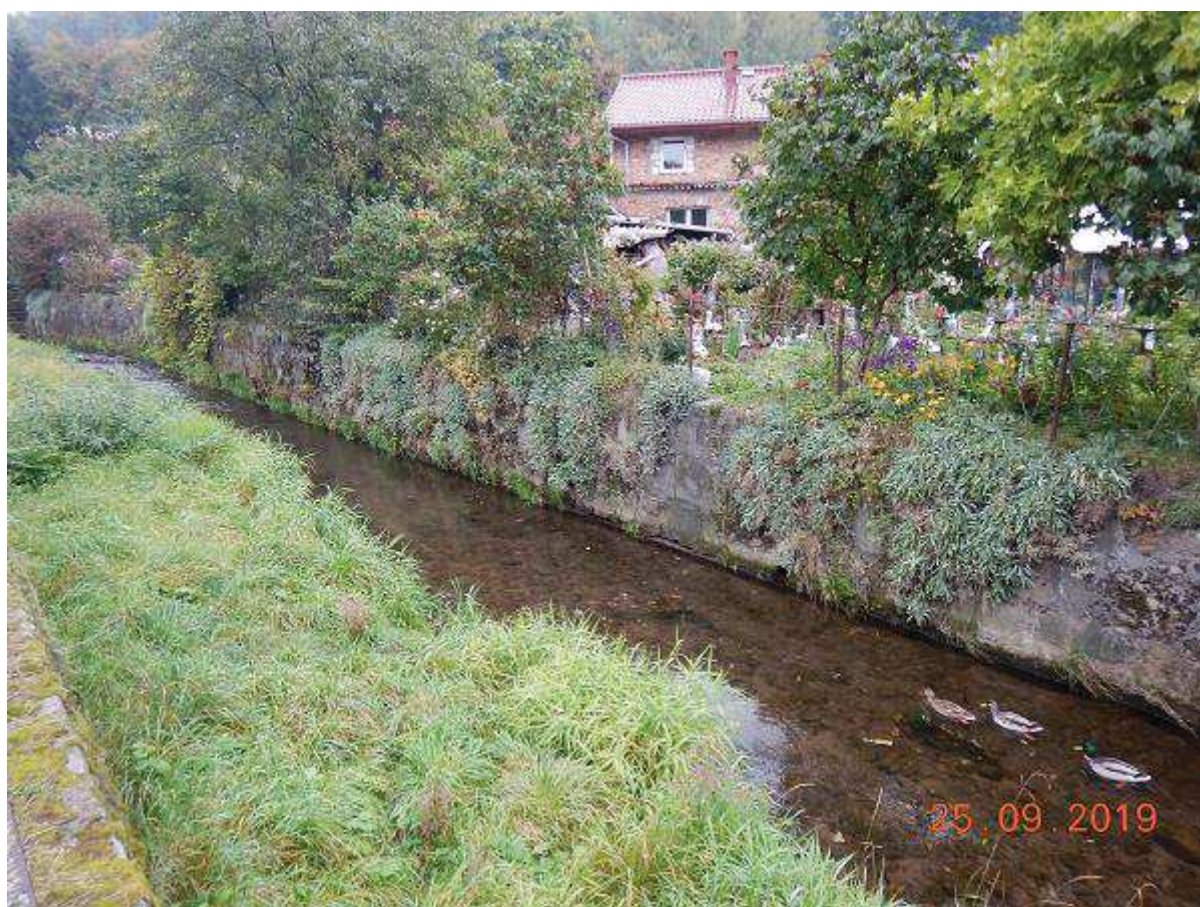
Fot. 9 Przebudowa ubezpieczeń dennych, wykonanie zabudowy progowej oraz reprofilacja muru na odcinku 26+156 - 26+376 (BL)
