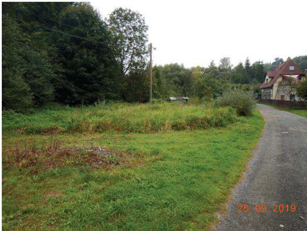
Fot. 16 Budowa otwartego kanału ulgi (26+111 – 26+545)
