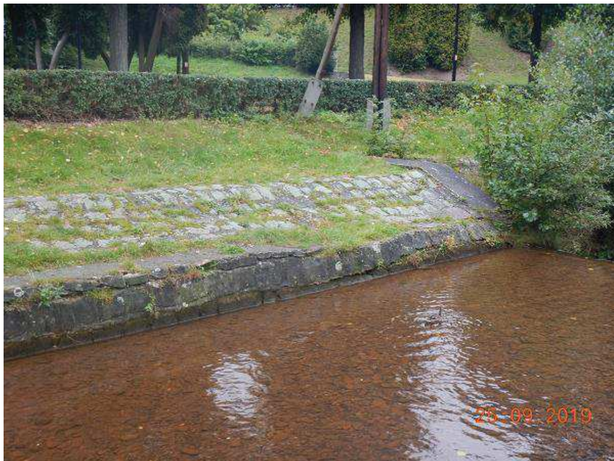
Fot. 26 Przebudowa progu H-45 w km 27+048 na bystrze
