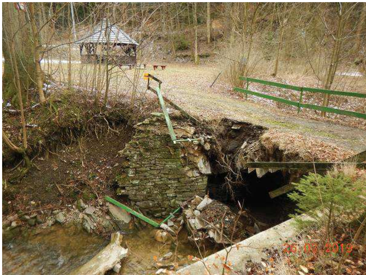
Fot. 72 Rozbiórka mostu M-74 w km 30+206 w związku z budową zapory przeciwrumowiskowej
