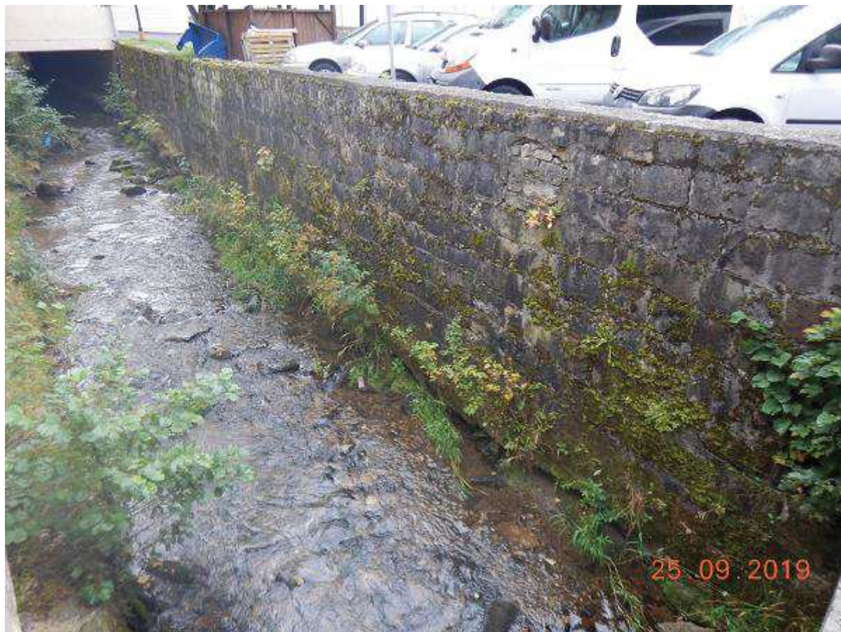
Fot. 48 Reprofilacja muru wraz z odcinkowym dostosowaniem do historycznej zabudowy na odcinku 28+114 – 28+339 (BL)
