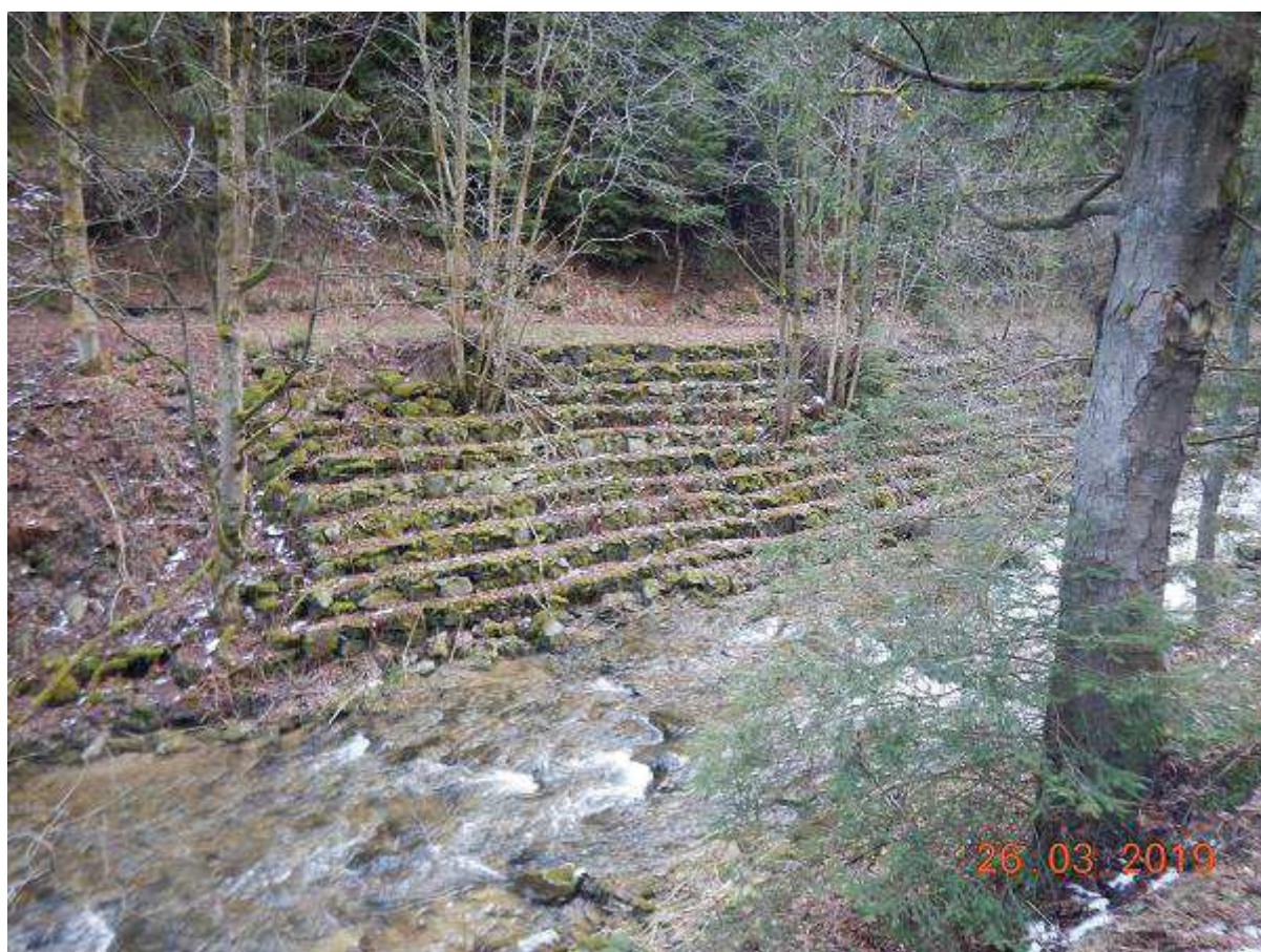
Fot. 68 Rozbiórka gabionów i budowa ubezpieczeń brzegowych na odcinku 29+400 - 29+782 (BP)
