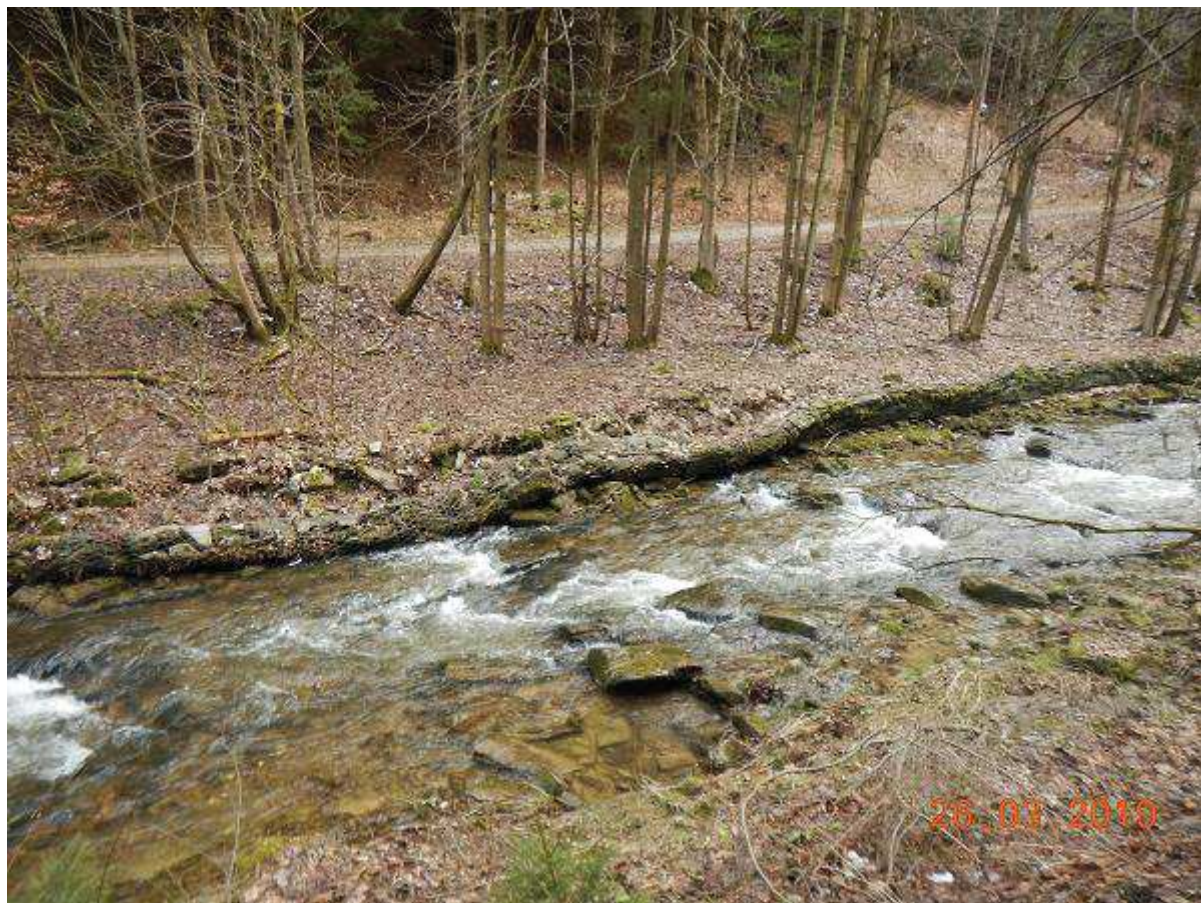
Fot. 67 Rozbiórka gabionów i budowa ubezpieczeń brzegowych na odcinku 29+400 - 29+511 (BP)
