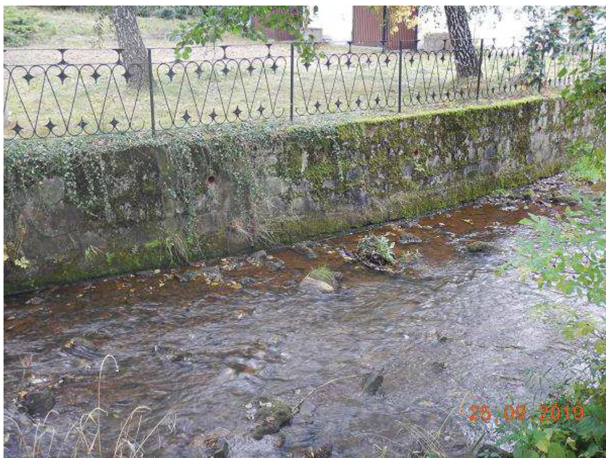
Fot. 25 Reprofilacja muru na odcinku 26+886 – 26+979 (BL)
