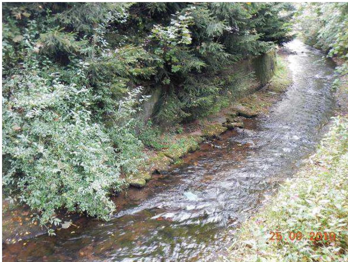
Fot. 10 Przebudowa ubezpieczeń dennych, wykonanie zabudowy progowej oraz reprofilacja muru na odcinku 26+156 - 26+376 (BL)
