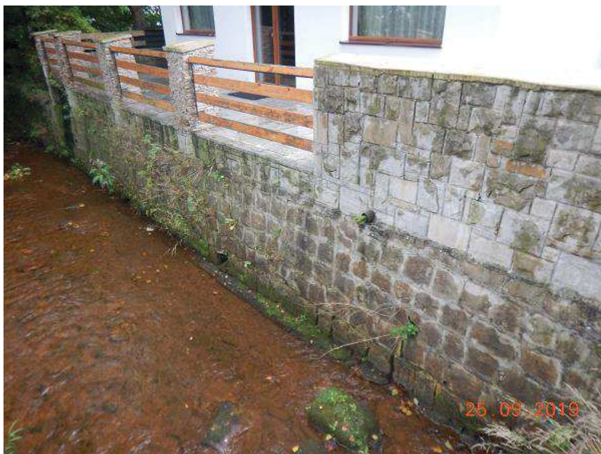
Fot. 35 Reprofilacja muru na odcinku 27+491 – 27+788 (BP)
