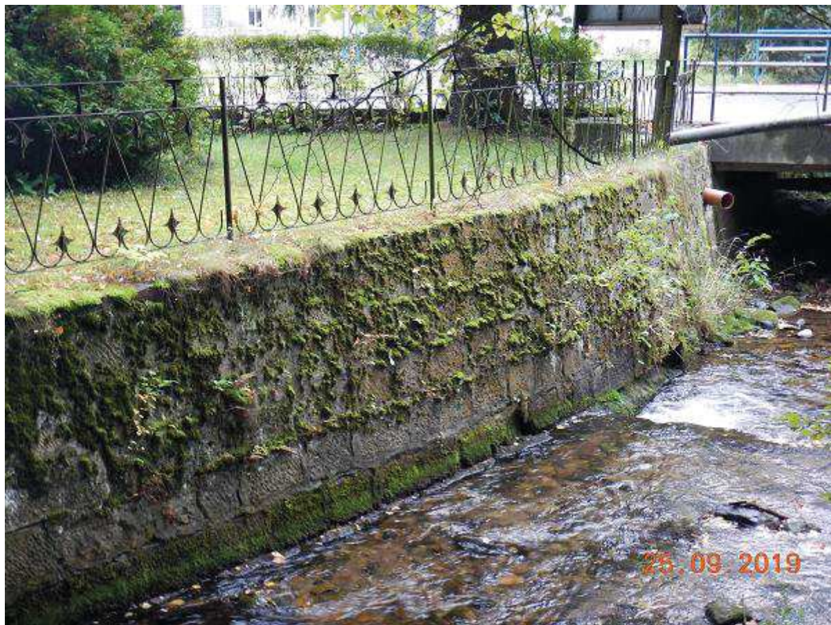
Fot. 59 Reprofilacja muru na odcinku 28+455 - 28+495 (BL)
