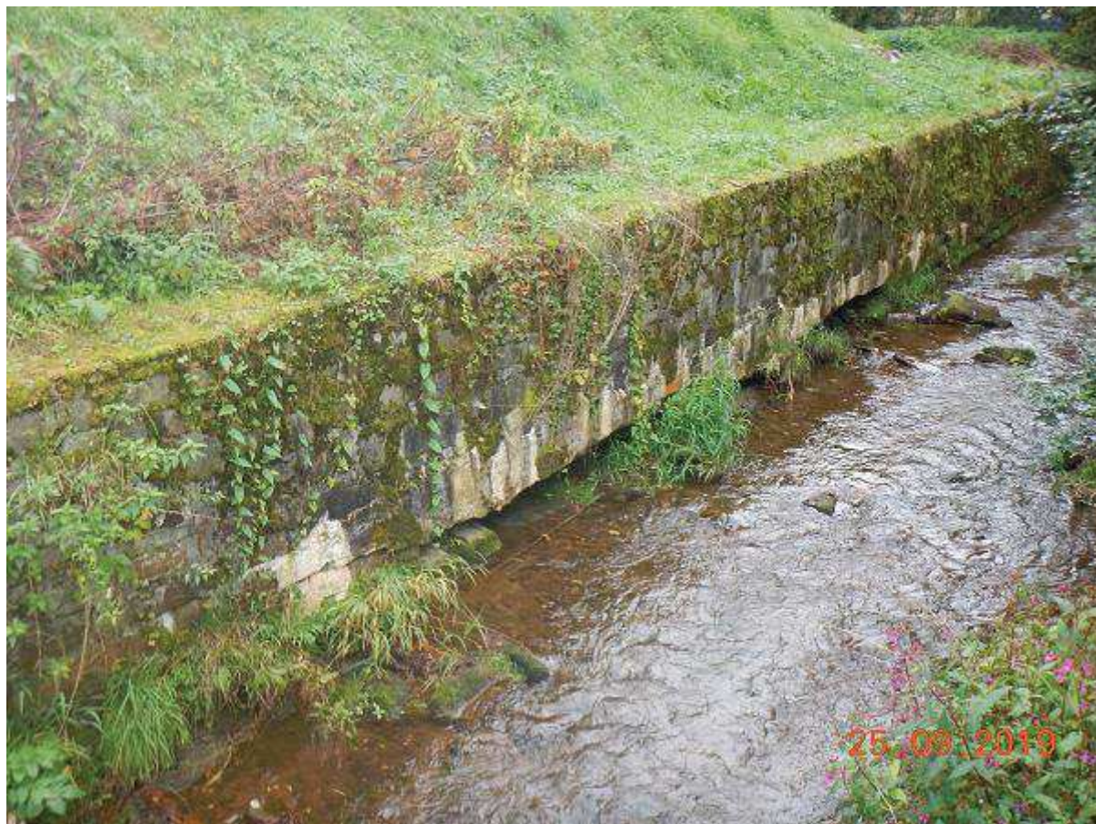
Fot. 36 Reprofilacja muru na odcinku 27+491 – 27+788 (BP)
