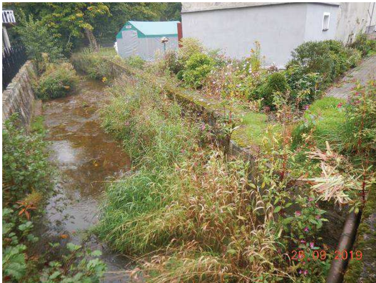
Fot. 34 Reprofilacja muru na odcinku 27+491 – 27+788 (BP)
