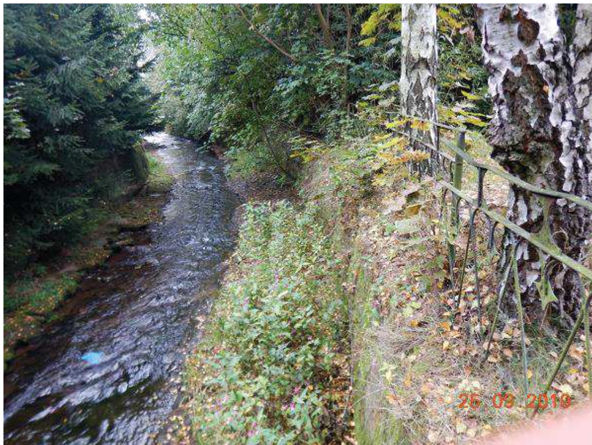
Fot. 8 Przebudowa ubezpieczeń dennych, wykonanie zabudowy progowej oraz reprofilacja muru na odcinku 26+128 - 26+376 (BP)
