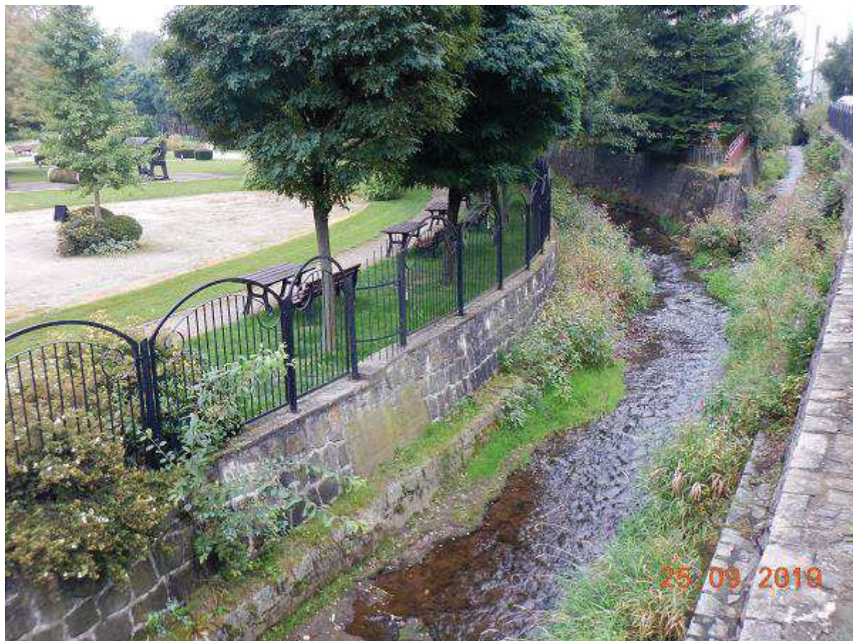
Fot. 12 Przebudowa ubezpieczeń dennych, wykonanie zabudowy progowej oraz nadbudowa muru na odcinku 26+376 - 26+533 (BP)
