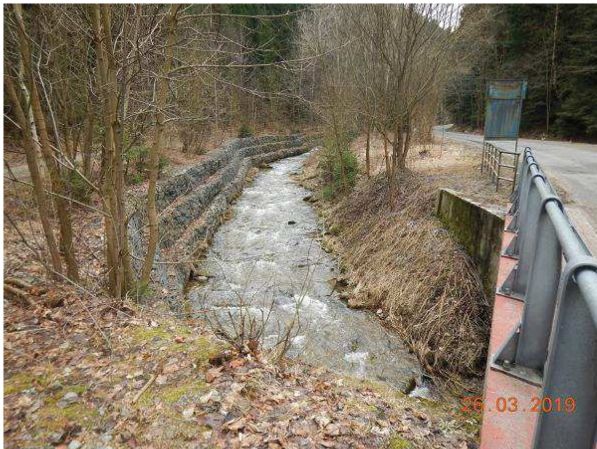
Fot. 65 Budowa zapory przeciwrumowskiej w km 29+308
