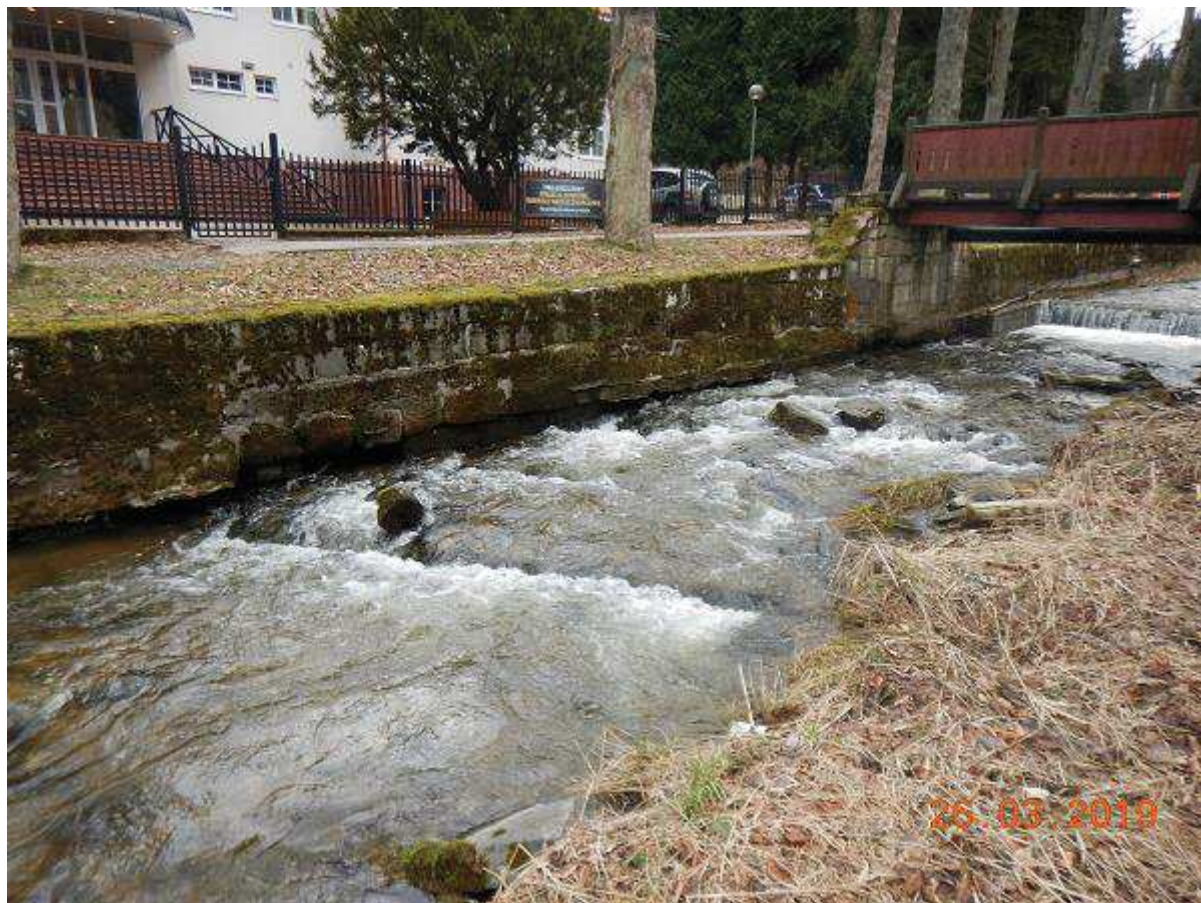
Fot. 61 Reprofilacja muru na odcinku 29+028 – 29+076 (BP)
