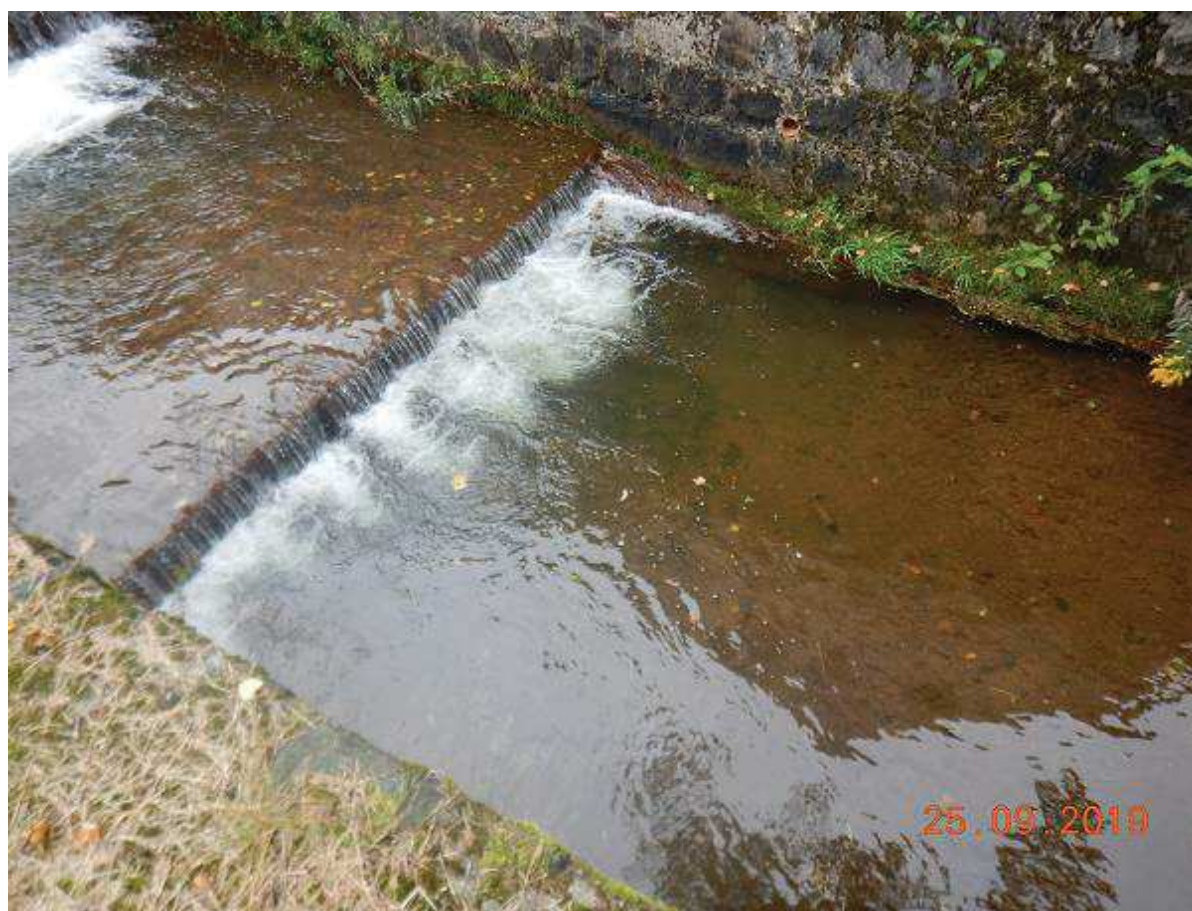
Fot. 37 Przebudowa jazu stałego H-48 w km 27+522 na bystrze
