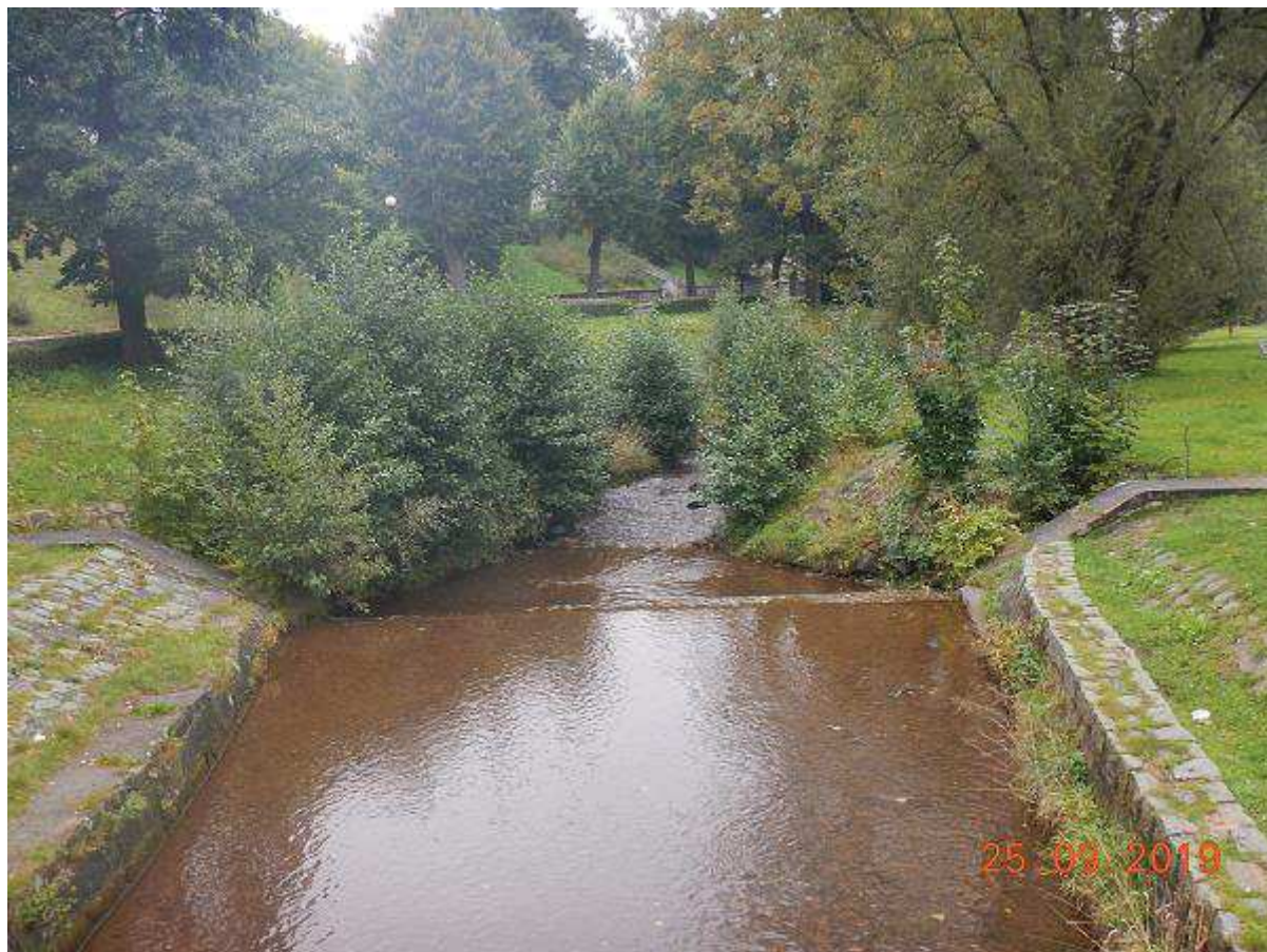
Fot. 28 Przebudowa progu H-45 w km 27+048 na bystrze
