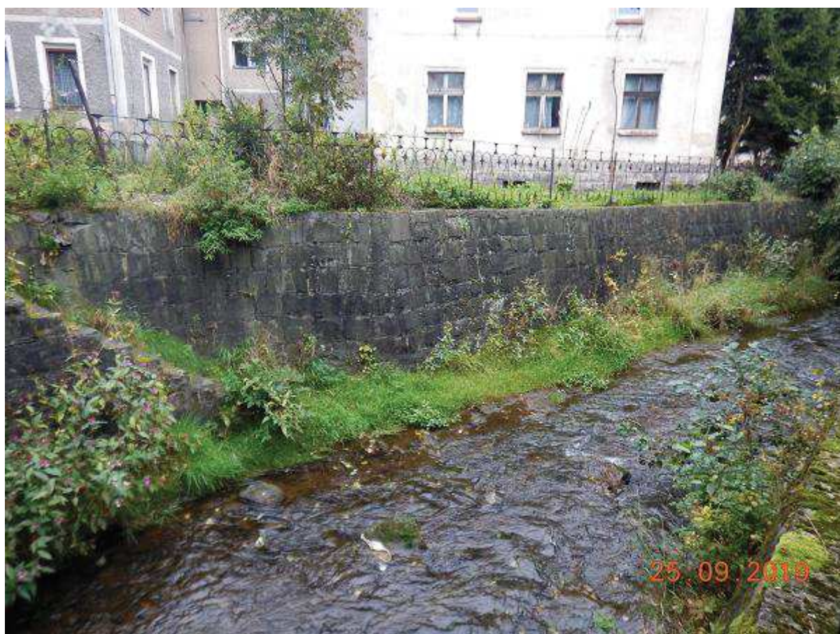
Fot. 13 Przebudowa ubezpieczeń dennych, wykonanie zabudowy progowej oraz reprofilacja muru na odcinku 26+459 - 26+580 (BL)
