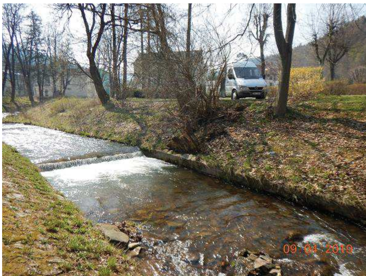
Fot. 33 Przebudowa progu w km 27+421 na bystrze oraz reprofilacja muru na odcinku 27+414 - 27+426 (BL)
