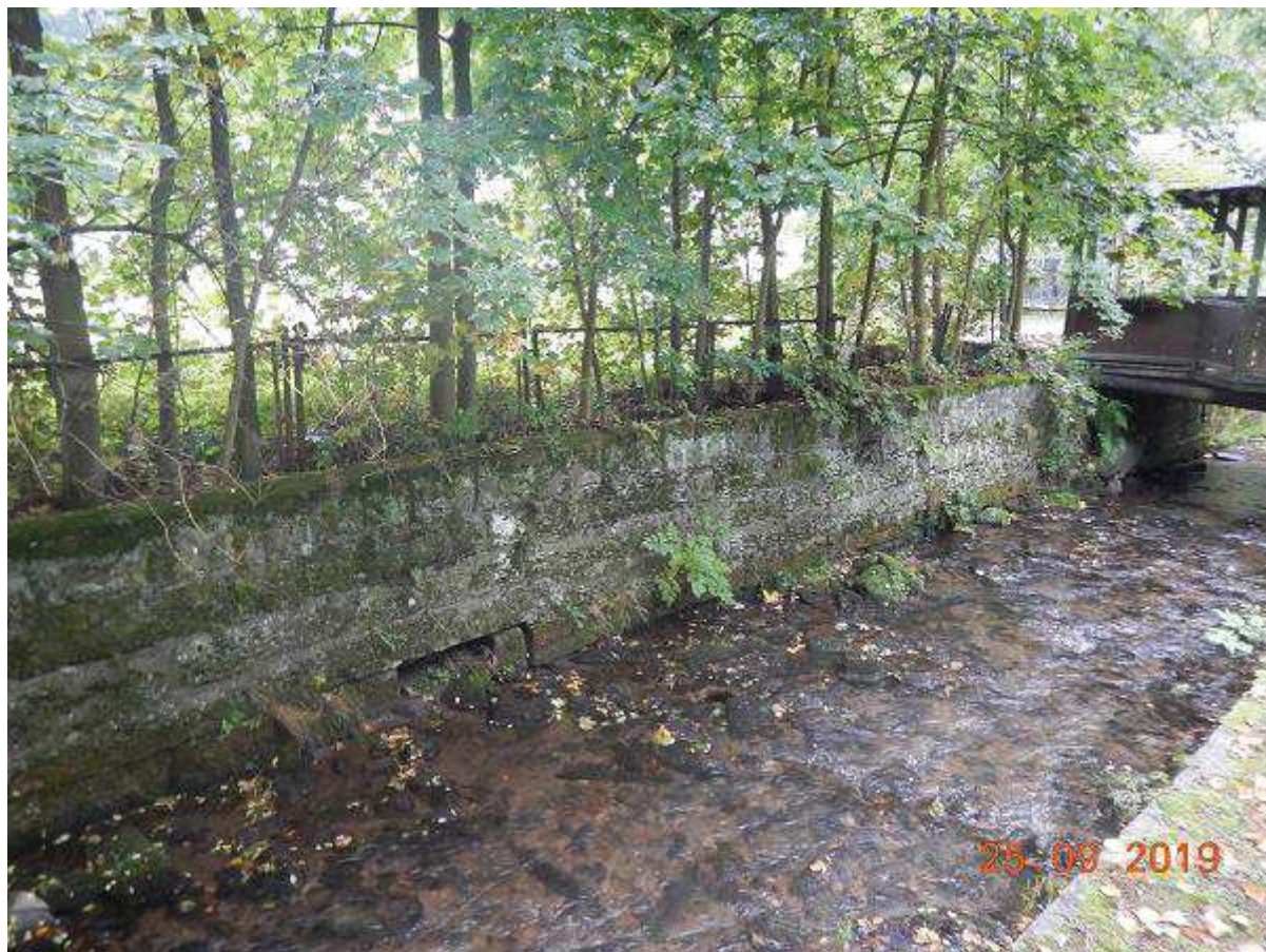
Fot. 54 Rozbiórka i odbudowa muru na odcinku 28+344 - 28+448 (BL)
