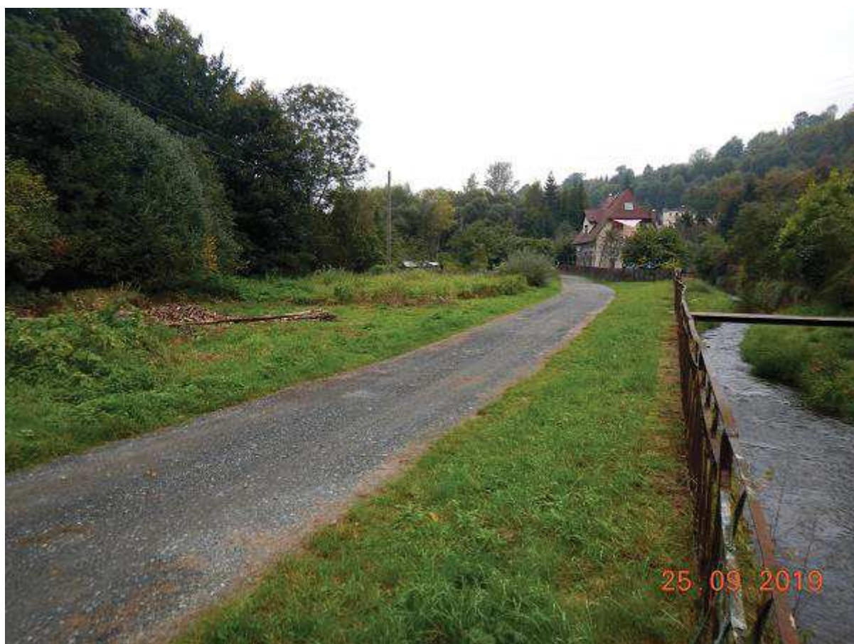
Fot. 17 Budowa mostu w km 0+020 kanału ulgi
