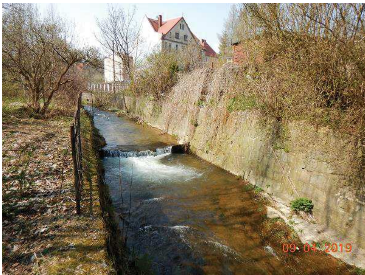
Fot. 21 Remont progu H-44 w km 26+580
