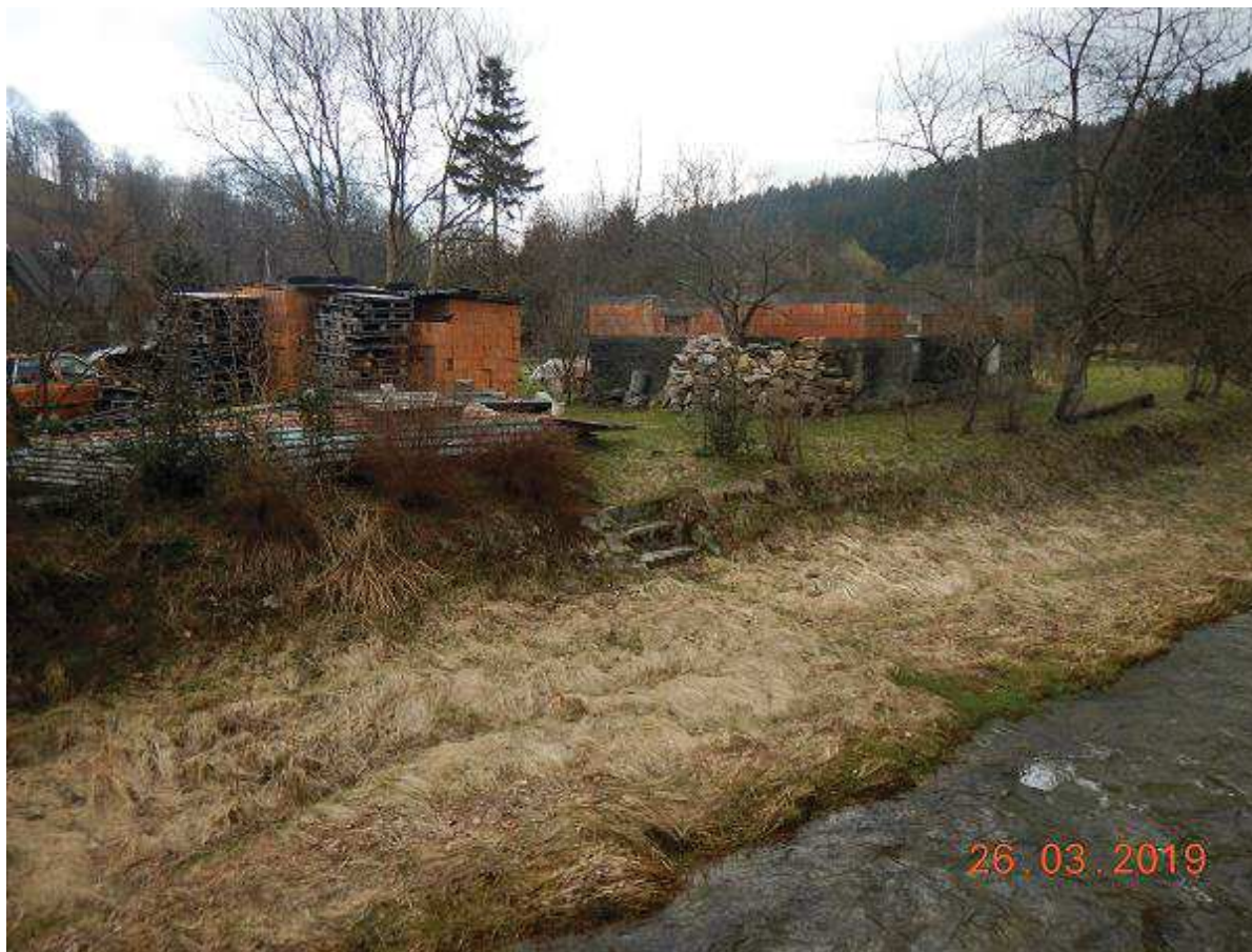
Fot. 5 Budowa muru regulacyjnego na odcinku 25+988 – 26+156 (BL) i ukształtowanie koryta dwudzielnego na odcinku 25+989 - 26+156 (BL) w związku z budową kanału ulgi
