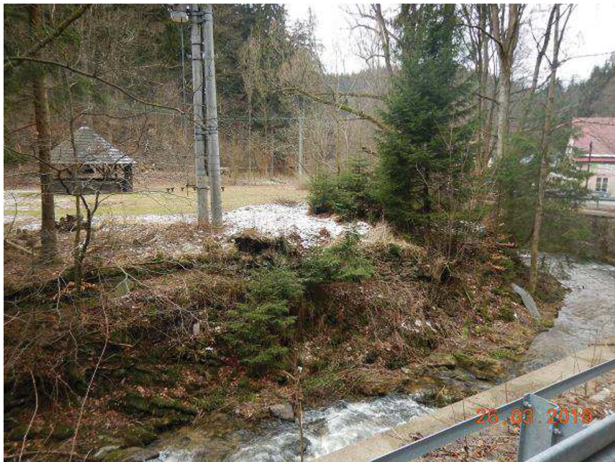
Fot. 74 Przygotowanie terenu powyżej zapory na odcinku 30+208 - 30+260 (BL)
