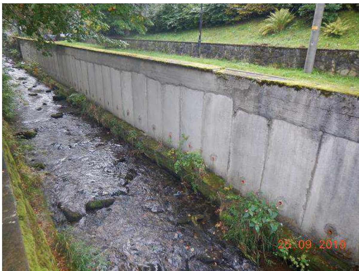
Fot. 49 Reprofilacja muru wraz z odcinkowym dostosowaniem do historycznej zabudowy na odcinku 28+114 – 28+339 (BL)
