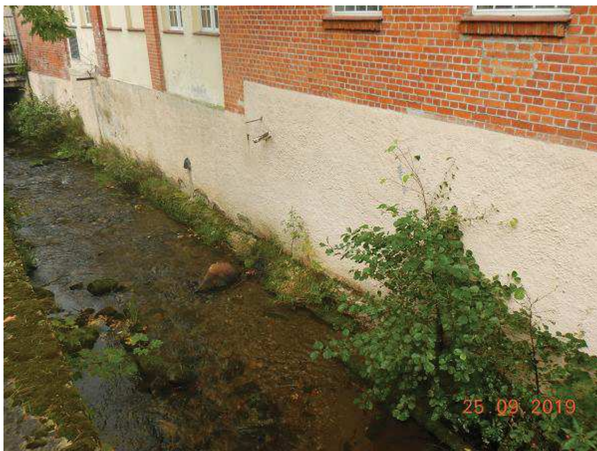
Fot. 51 Reprofilacja muru na odcinku 28+157 – 28+341 (BP)
