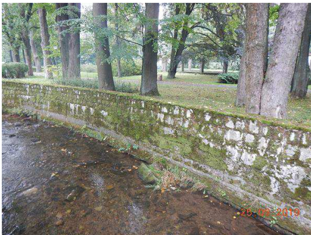
Fot. 58 Reprofilacja muru na odcinku 28+453 - 28+497 (BP)
