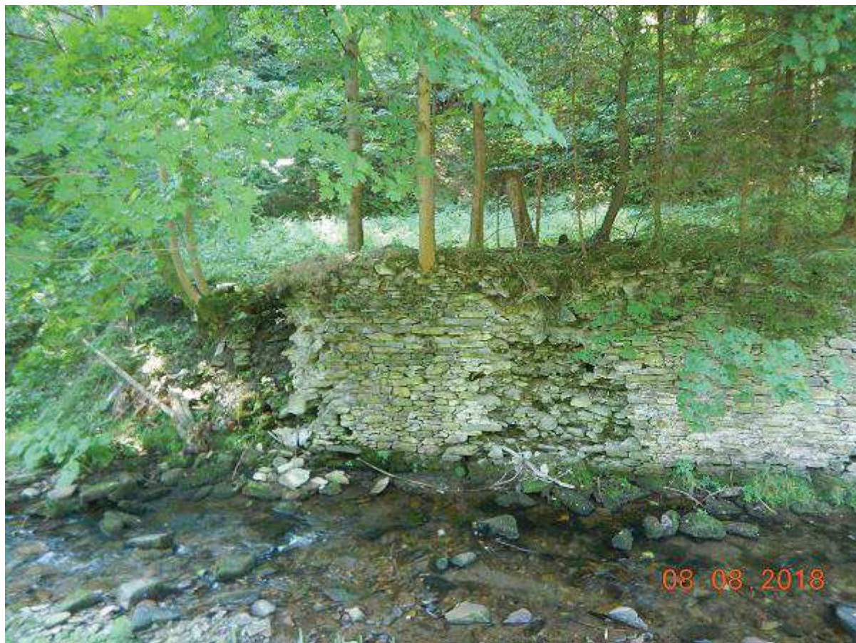
Fot. 69 Rozbiórka fragmentarycznych pozostałości ubezpieczeń brzegowych, zeskarpowanie i ubezpieczenie narzutem kamiennym w km 29+915 – 29+934 (BL)
