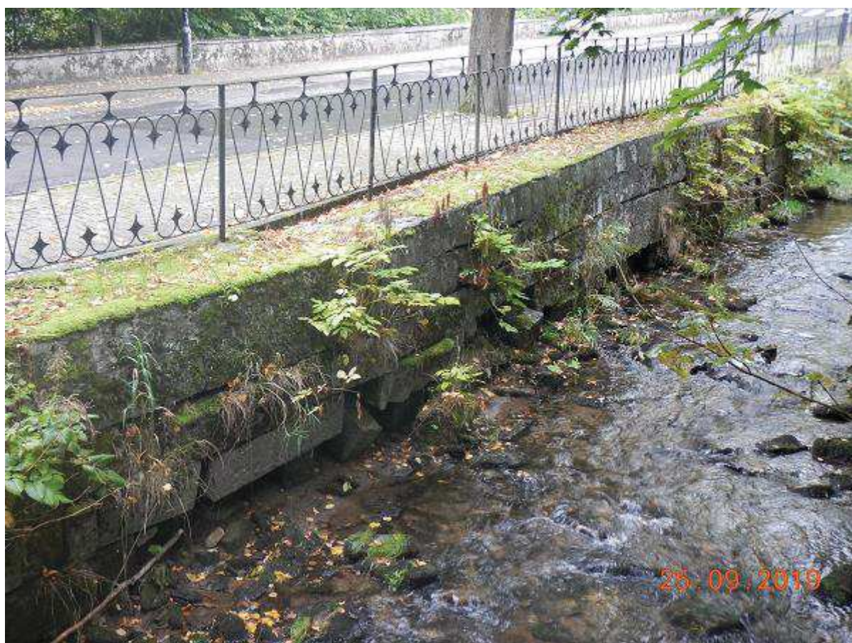
Fot. 55 Rozbiórka i odbudowa muru na odcinku 28+352 - 28+444 (BP)
