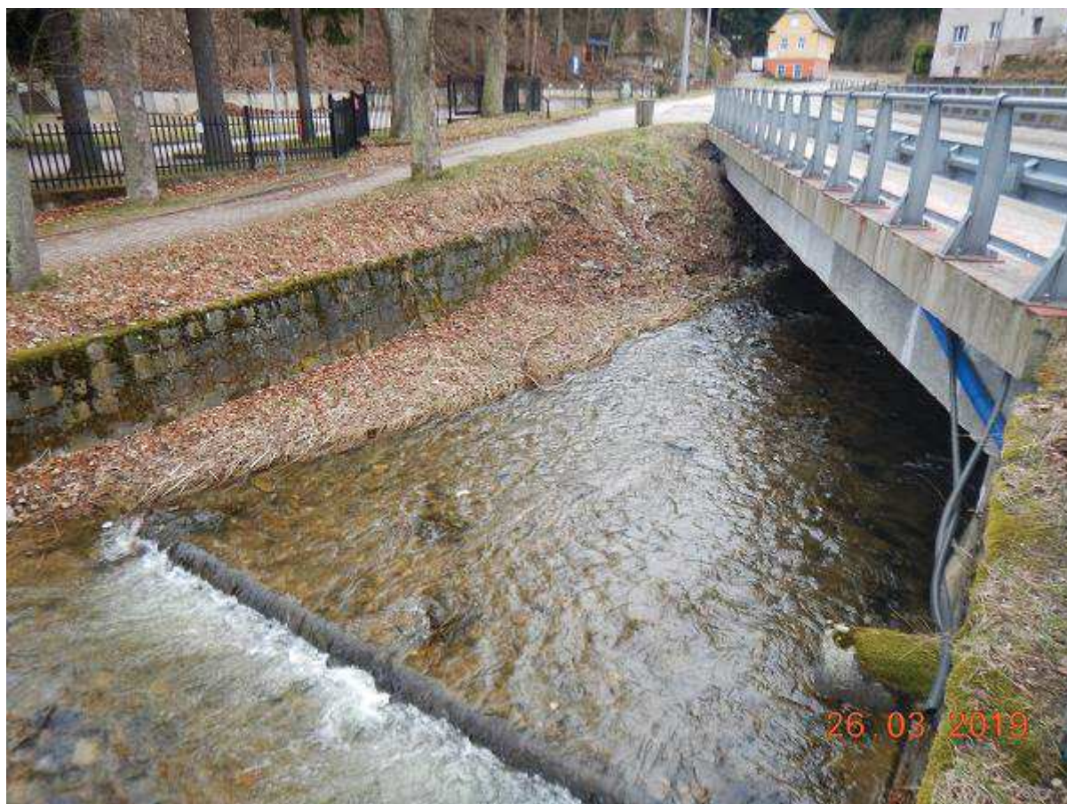
Fot. 62 Budowa muru regulacyjnego na odcinku 29+076 - 29+085 (BP)
