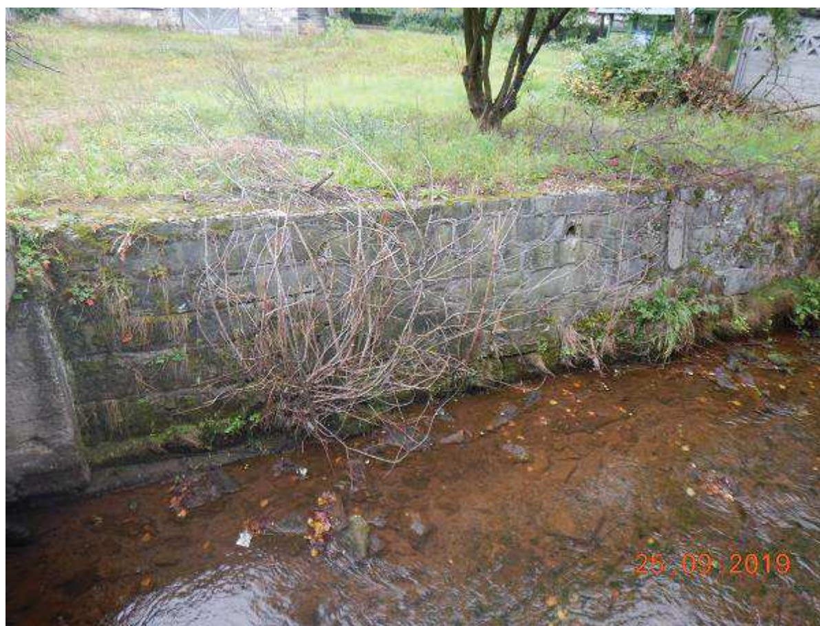
Fot. 39 Reprofilacja muru na odcinku 27+583 – 27+785 (BL)
