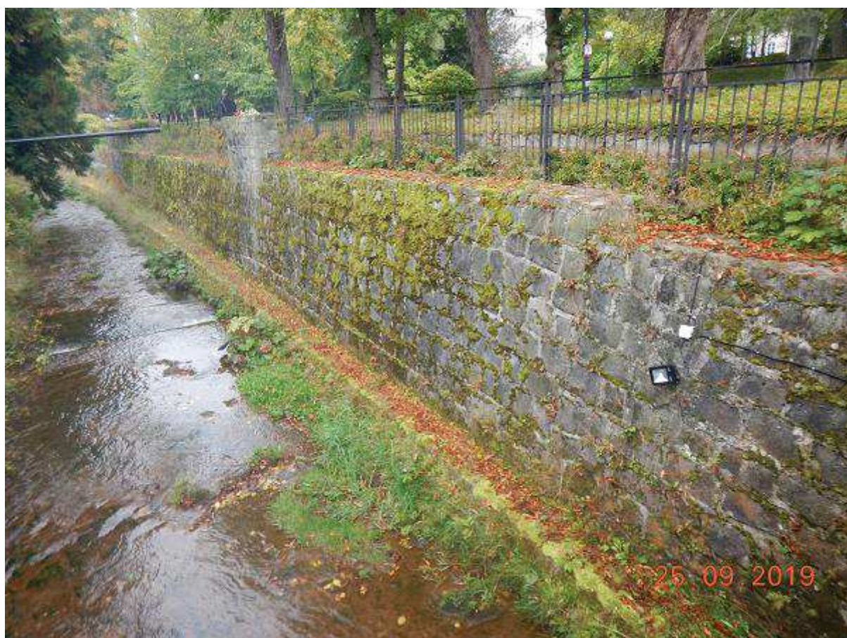
Fot. 45 Reprofilacja muru na odcinku 27+796 – 28+108 (BP)
