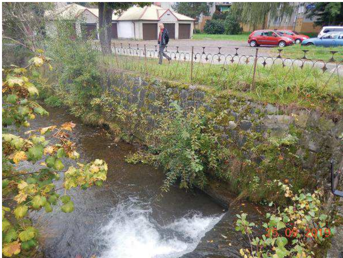
Fot. 24 Reprofilacja muru na odcinku 26+580 - 26+901 (BP)
