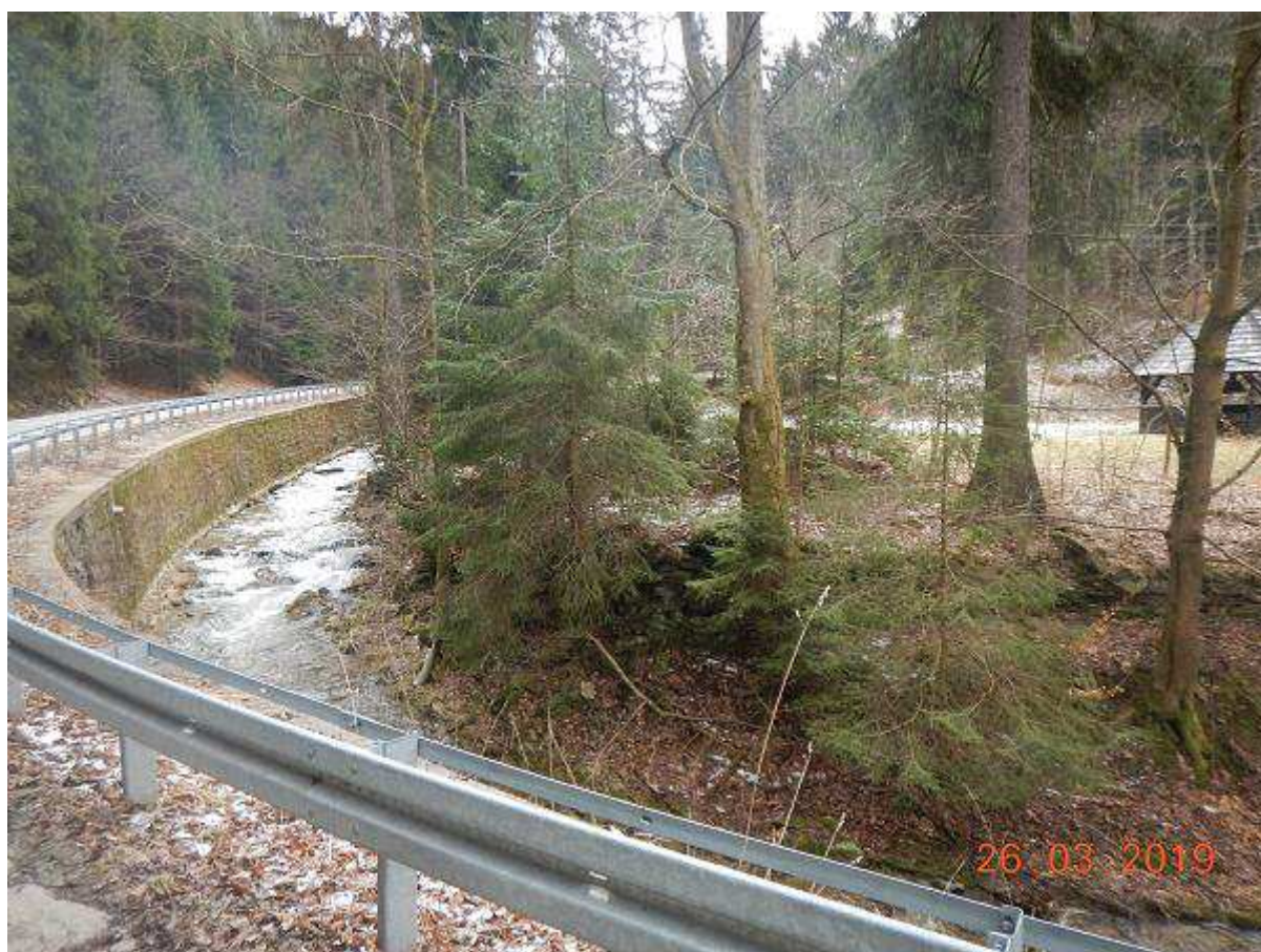
Fot. 73 Przygotowanie terenu powyżej zapory na odcinku 30+208 - 30+260 (BL)
