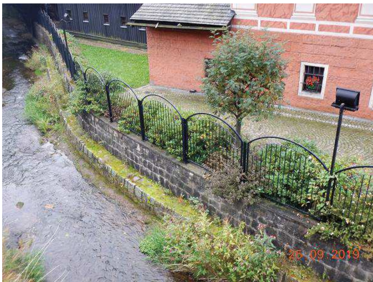
Fot. 11 Przebudowa ubezpieczeń dennych, wykonanie zabudowy progowej oraz nadbudowa muru na odcinku 26+376 - 26+533 (BP)
