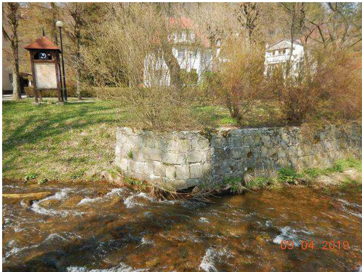
Fot. 30 Rozbiórka i odbudowa muru na odcinku 27+066 – 27+279 (BL)
