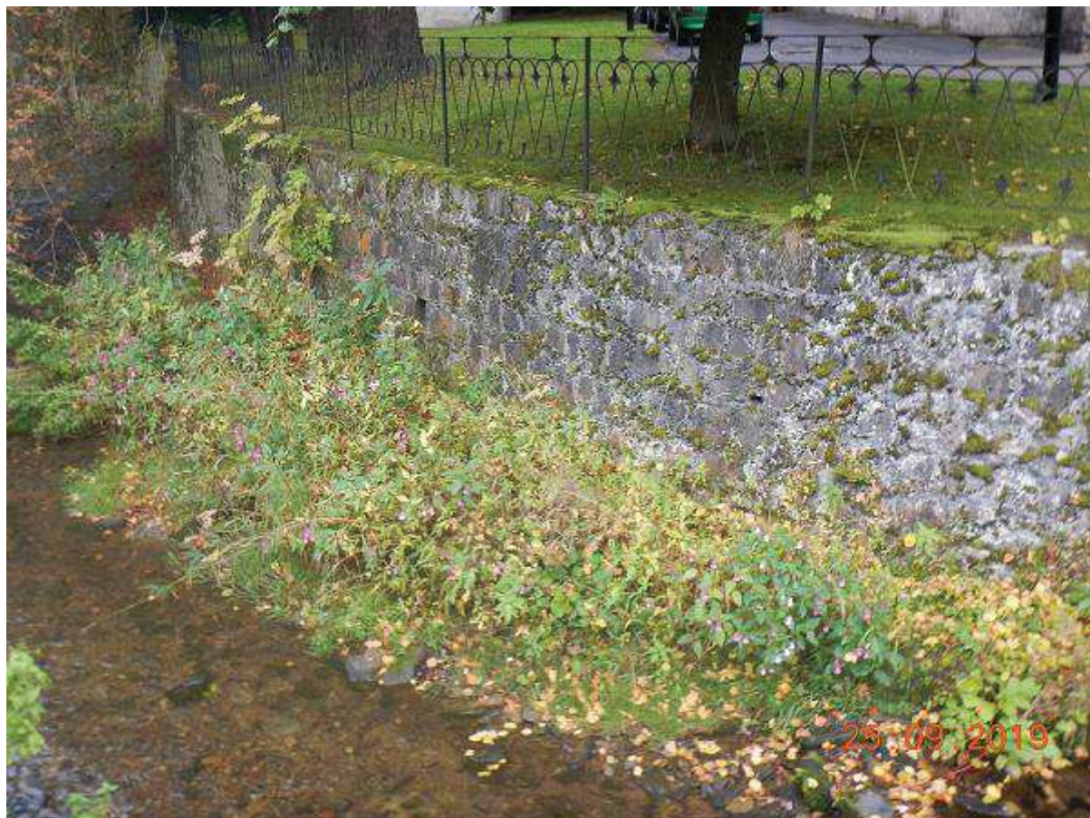
Fot. 46 Reprofilacja muru na odcinku 27+796 – 28+108 (BP)
