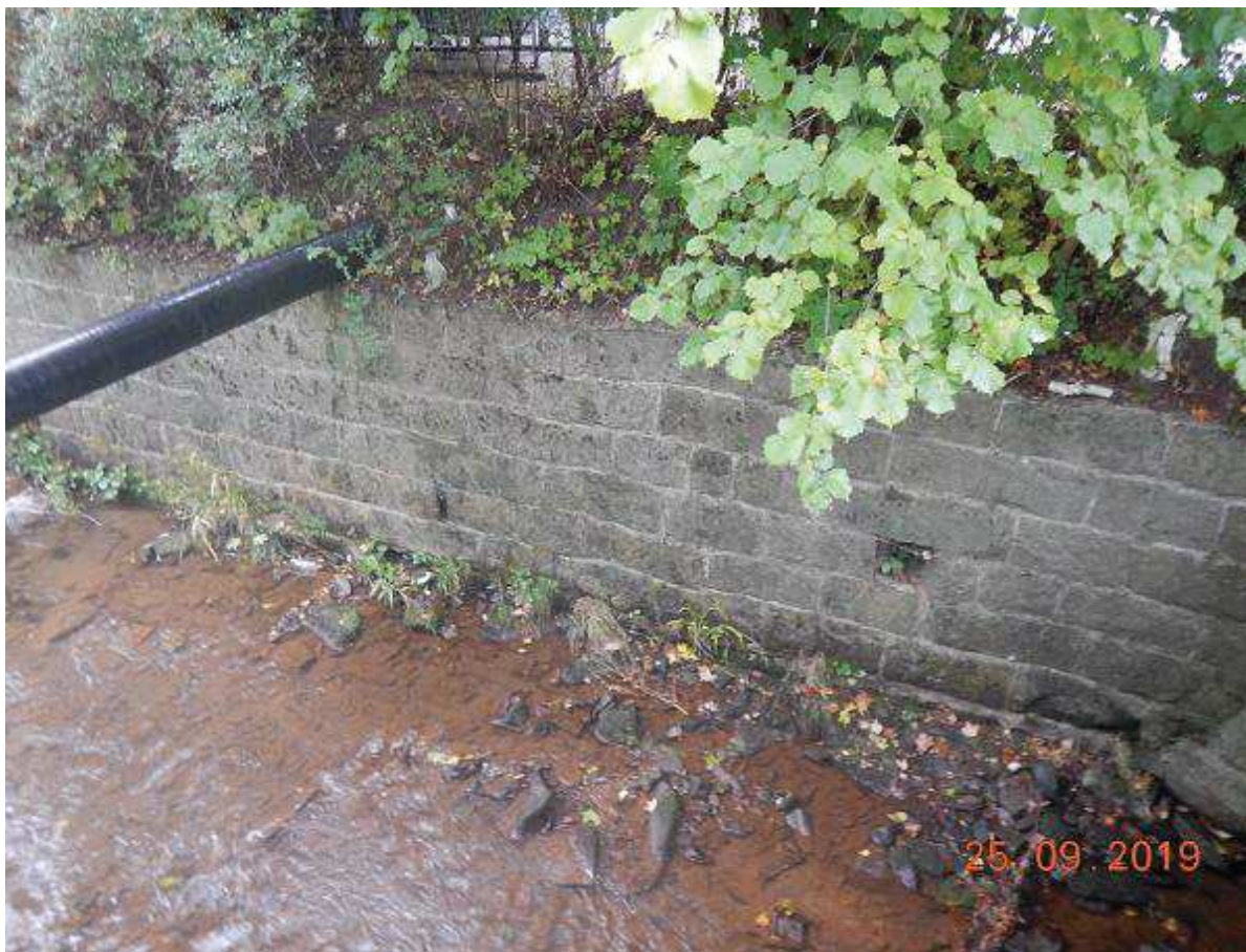
Fot. 41 Reprofilacja muru na odcinku 27+793 – 28+109 (BL)
