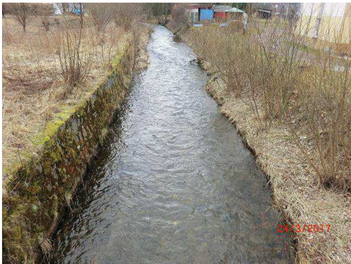
Fot. 4 Budowa muru regulacyjnego na odcinku 25+923 – 26+038 (BP) w ramach ukształtowania koryta dwudzielnego w związku z budową kanału ulgi
