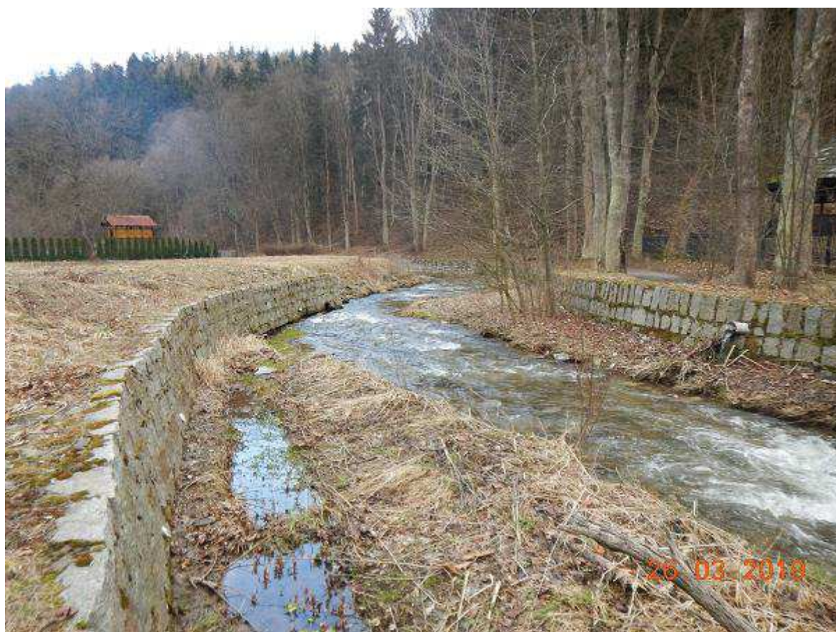
Fot. 60 Reprofilacja muru na odcinku 28+961 – 28+995 (BL)
