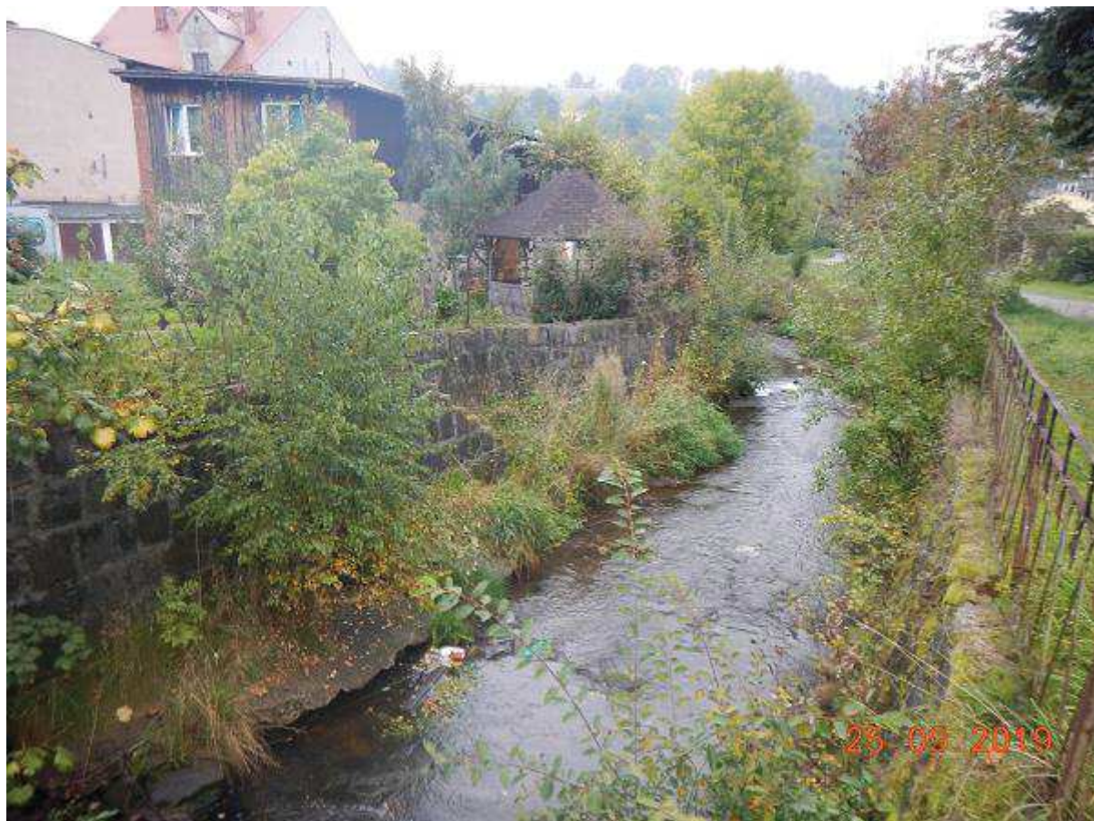
Fot. 22 Reprofilacja muru na odcinku 26+580 – 26+864 (BL)
