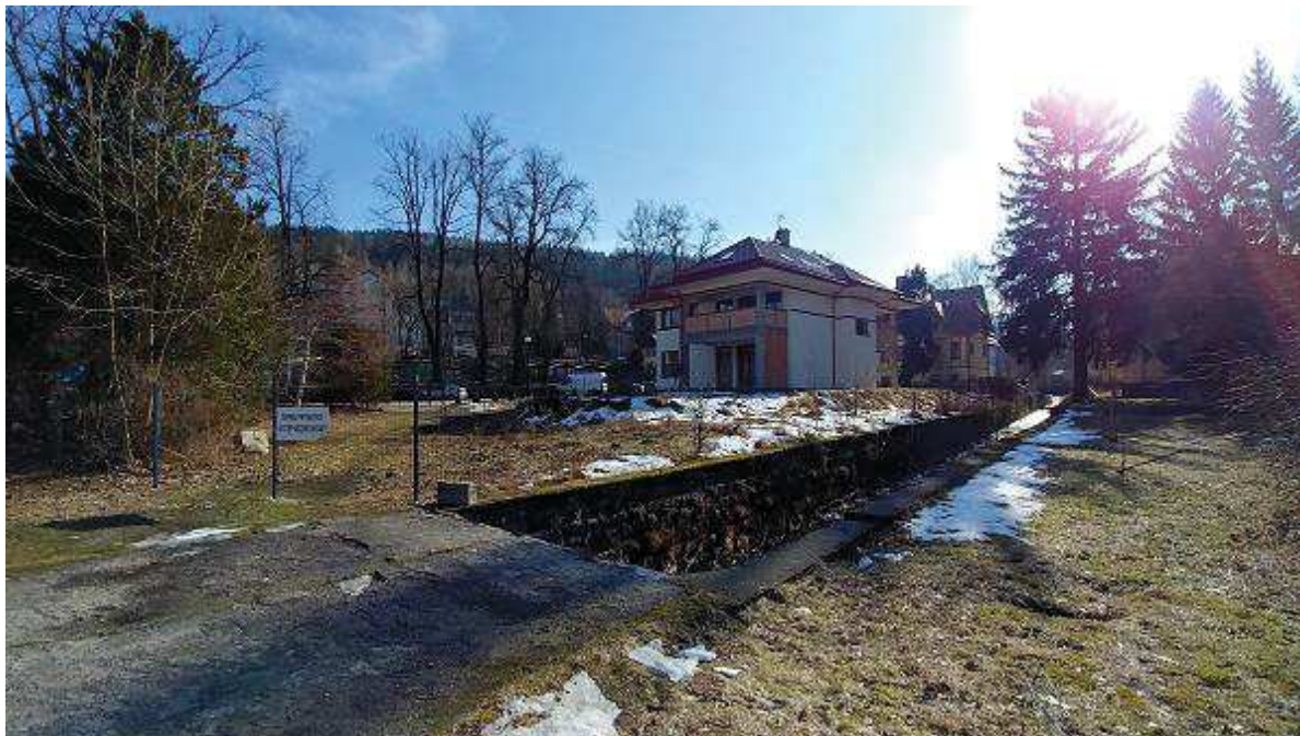
Fot. 40 Rozbiórka mostu M-59 w km 27+685
