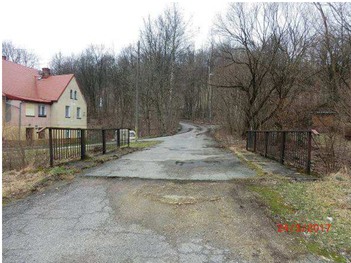
Fot. 3 Przebudowa mostu M-49 w km 25+919 w ramach ukształtowania koryta dwudzielnego w związku z budową kanału ulgi
