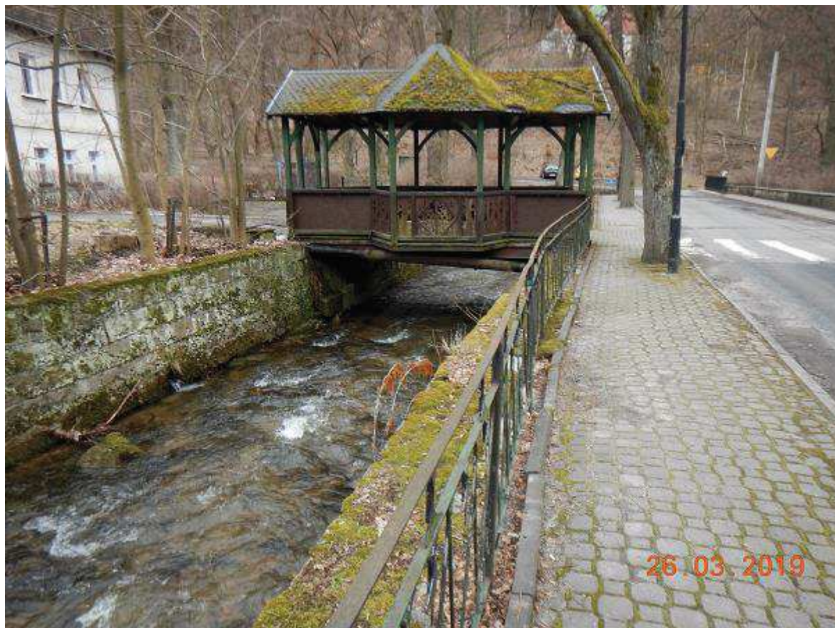
Fot. 57 Rozbiórka i odbudowa kładki M-68 w km 28+381
