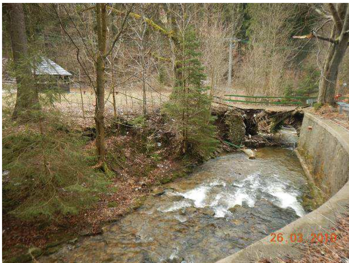
Fot. 71 Budowa zapory przeciwrumowiskowej w km 30+206
