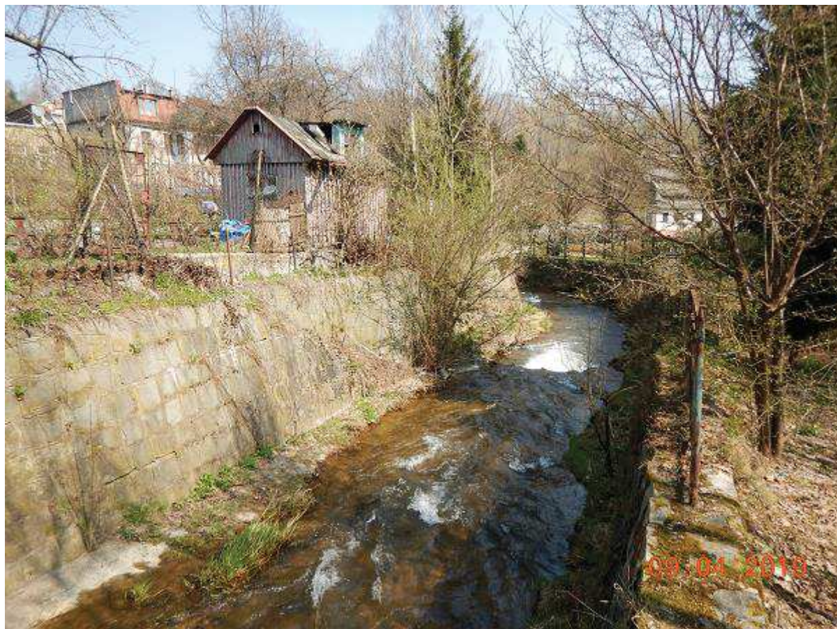
Fot. 14 Przebudowa ubezpieczeń dennych, wykonanie zabudowy progowej oraz reprofilacja muru na odcinku 26+459 - 26+580 (BL)
