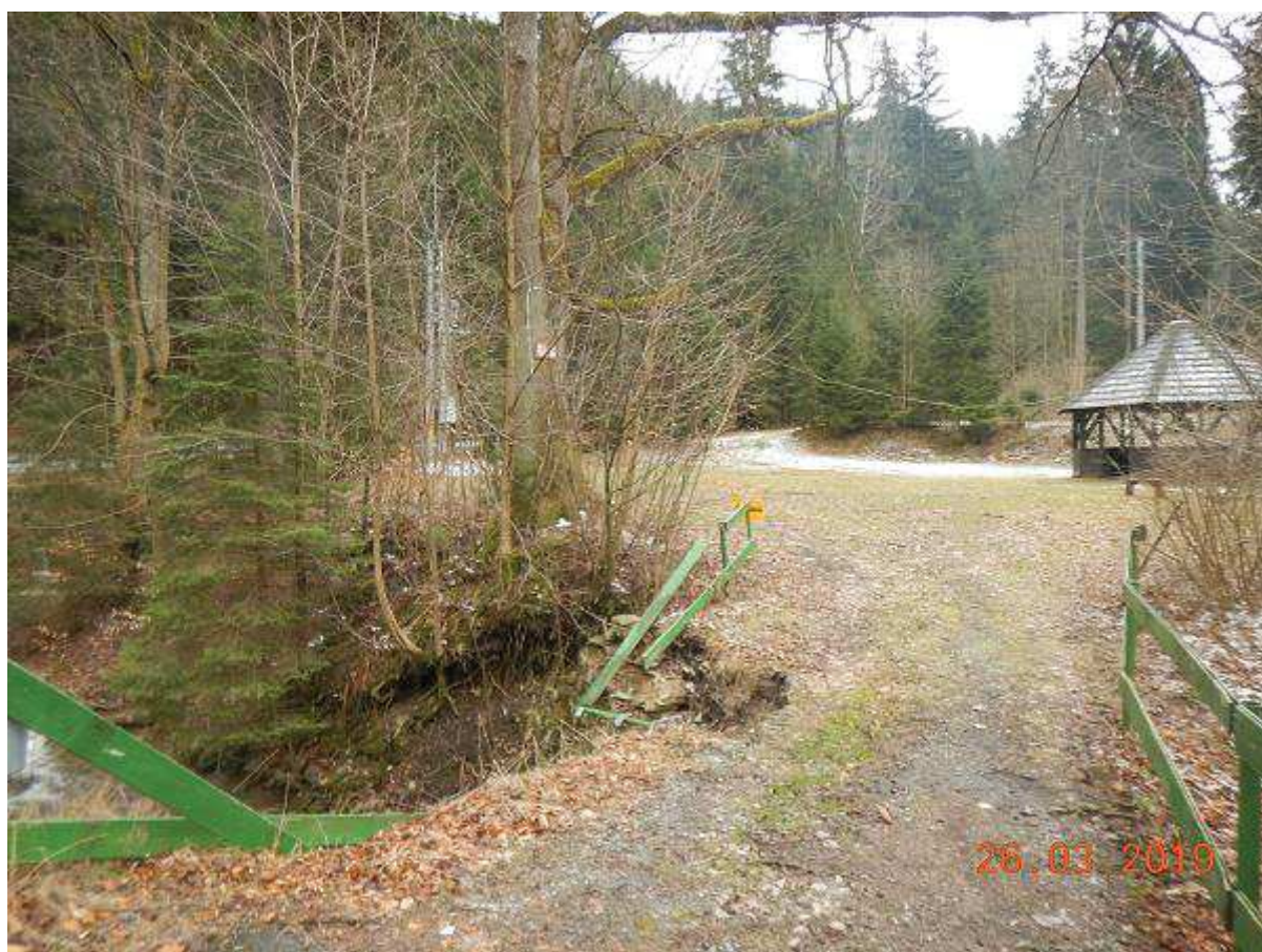
Fot. 75 Rozbiórka mostu M-74 w km 30+206 i budowa drogi serwisowej (zjazd z ul. Wojska Polskiego) w związku z budową zapory przeciwrumowiskowej
