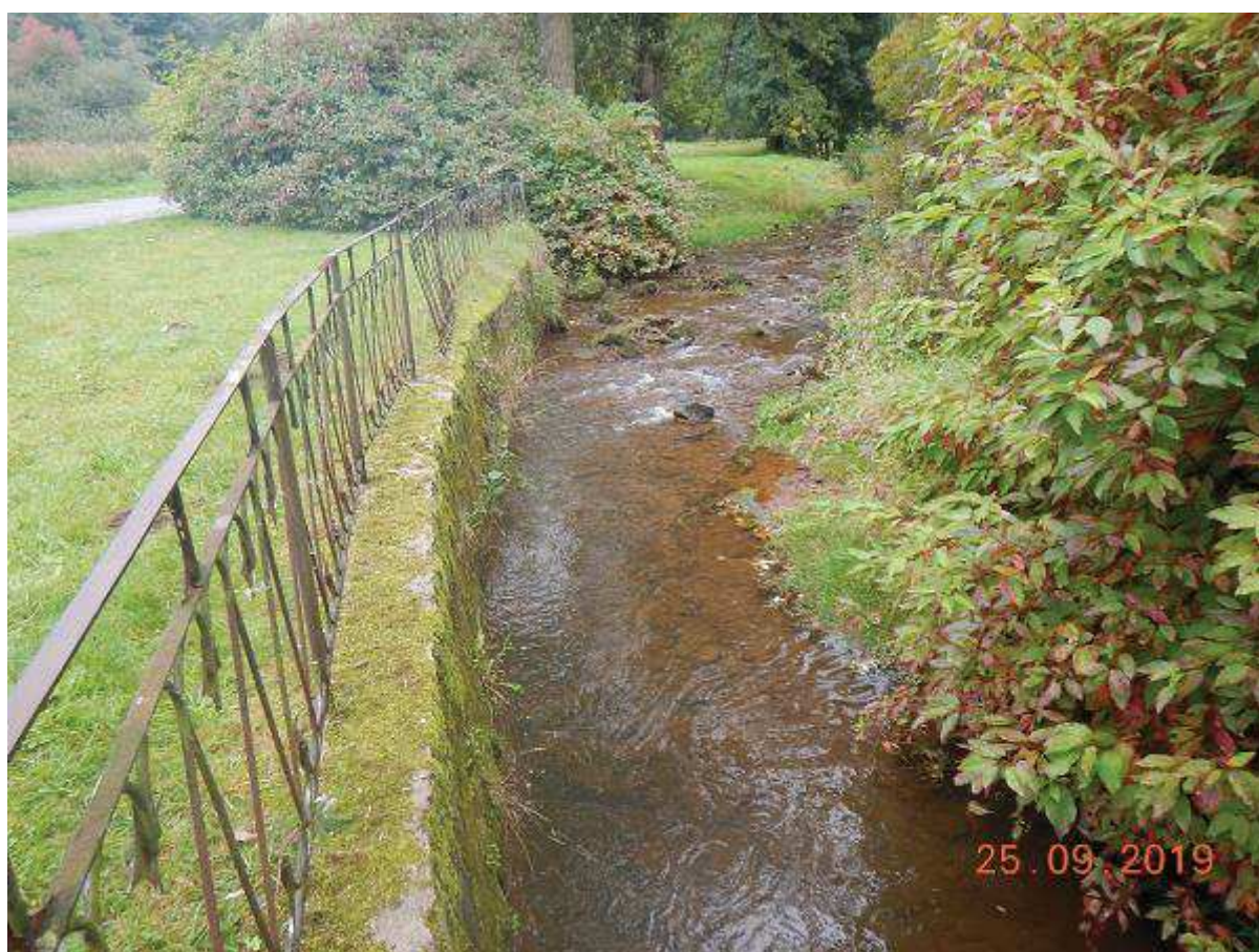
Fot. 31 Reprofilacja muru na odcinku 27+245 – 27+278 (BP)
