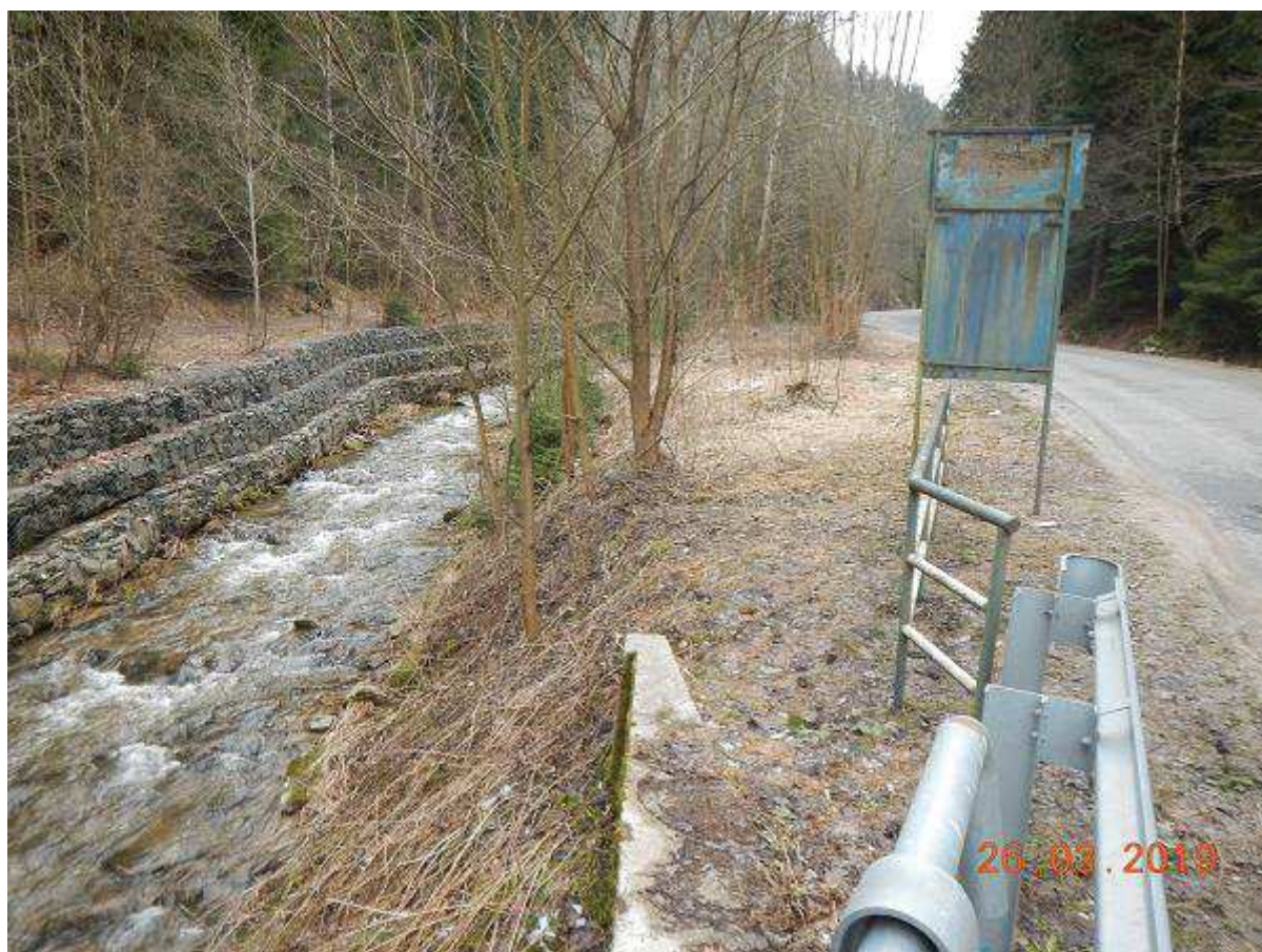
Fot. 64 Budowa muru regulacyjnego na odcinku 29+287 - 29+352 (BL) w związku z budową zapory przeciwrumowiskowej
