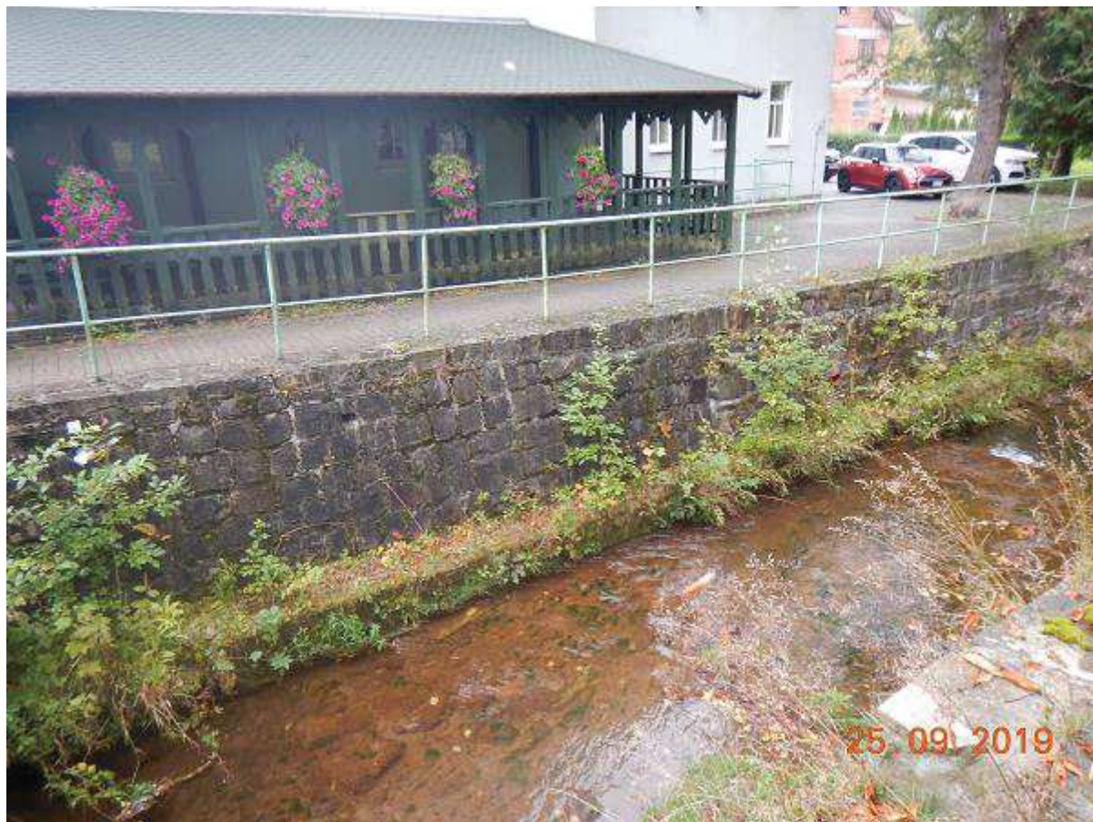
Fot. 42 Reprofilacja muru na odcinku 27+793 – 28+109 (BL)
