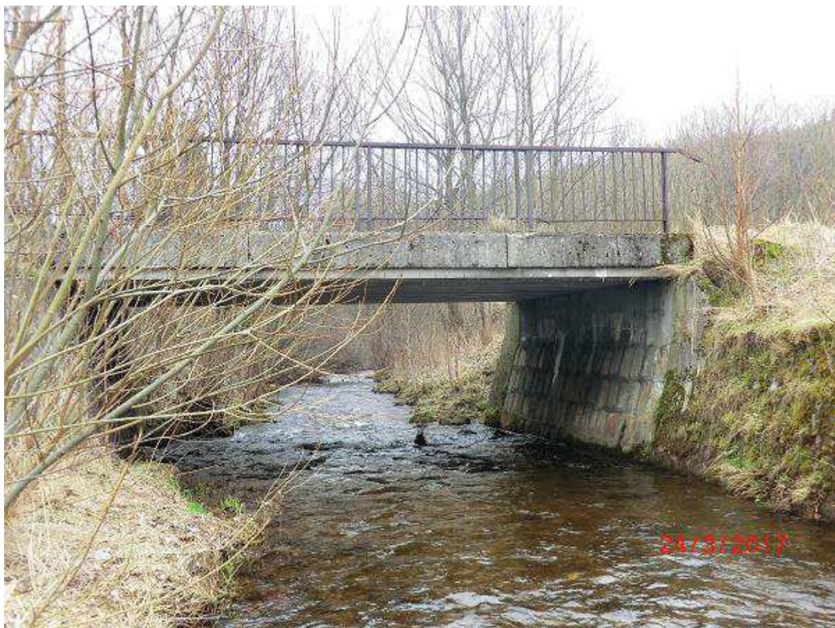
Fot. 2 Ukształtowanie koryta dwudzielnego na odcinku 25+819 - 26+037 (BP) oraz przebudowa mostu M-49 w związku z budową kanału ulgi
