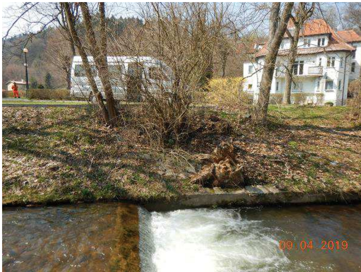
Fot. 32 Reprofilacja muru na odcinku 27+414 - 27+426 (BL)
