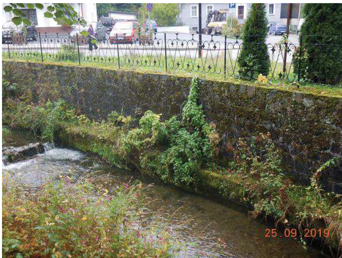
Fot. 43 Reprofilacja muru na odcinku 27+793 – 28+109 (BL)
