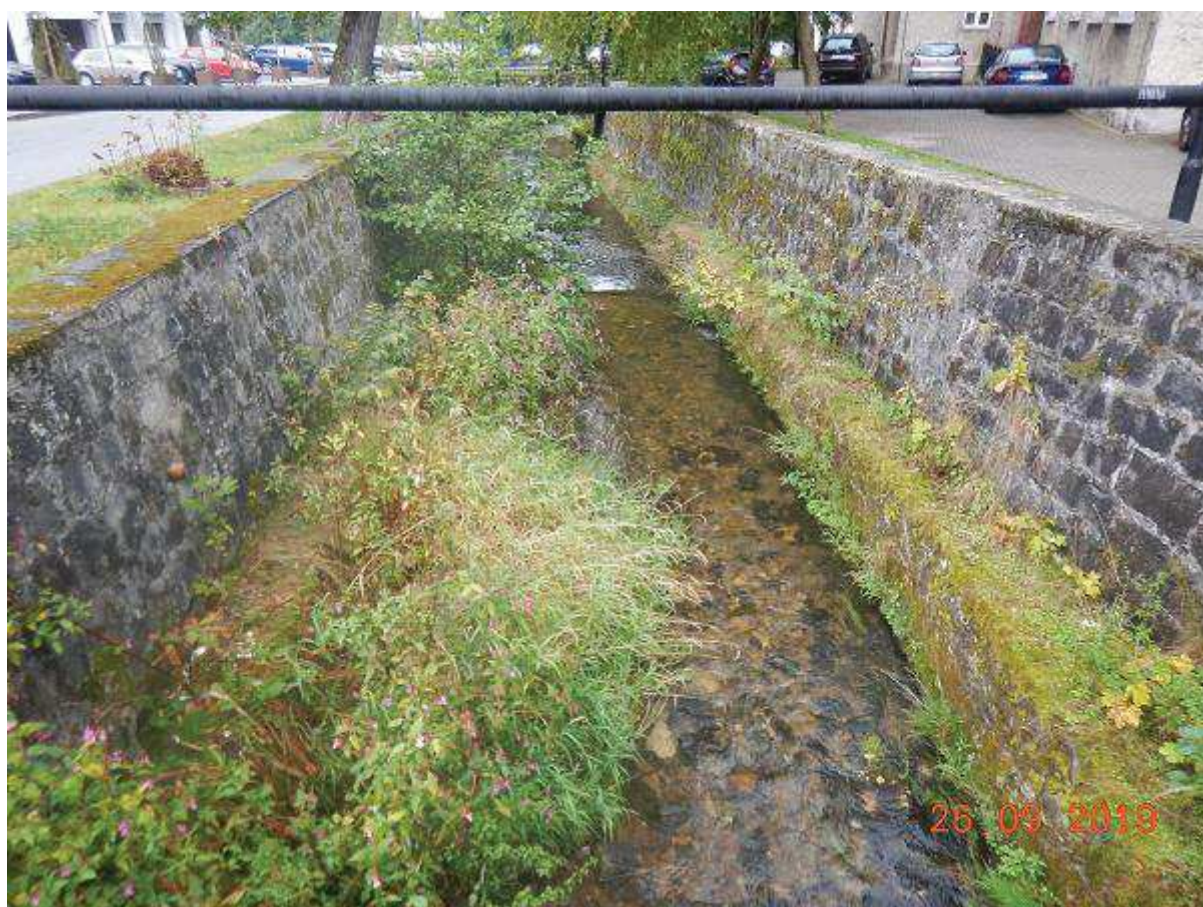
Fot. 47 Reprofilacja muru na odcinku 28+114 – 28+145 (BP)
