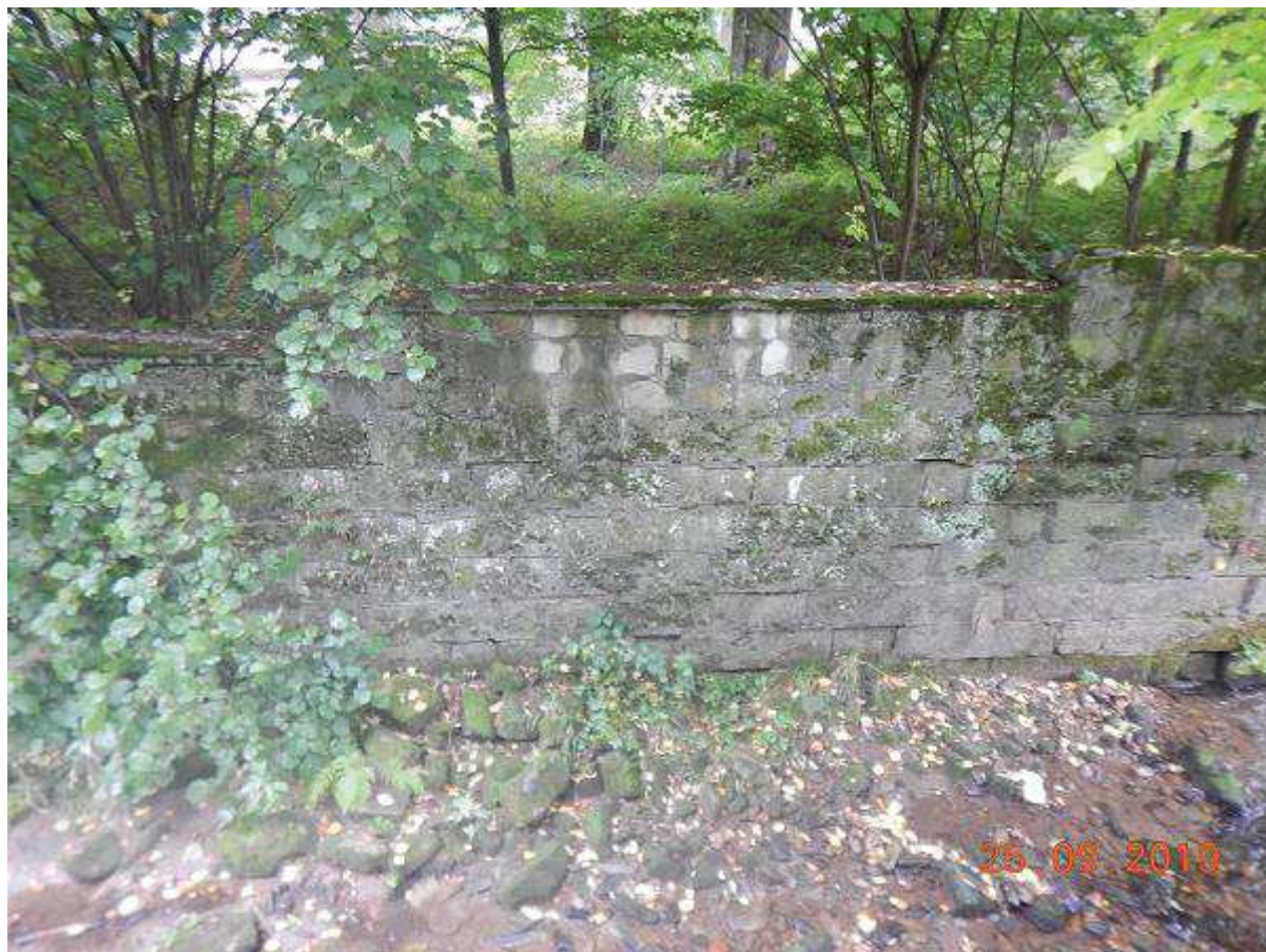
Fot. 52 Reprofilacja muru na odcinku 28+157 – 28+341 (BP)
