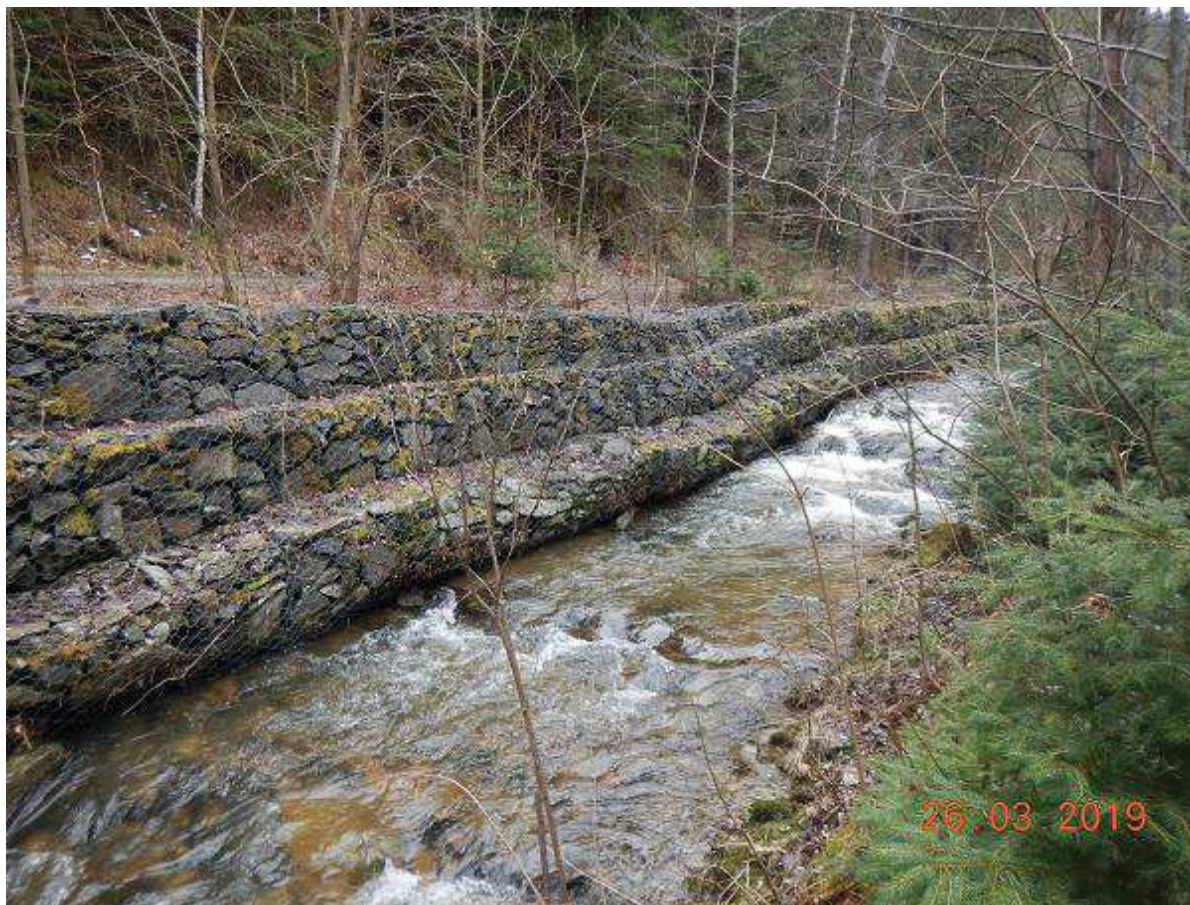
Fot. 63 Rozbiórka gabionów i budowa muru regulacyjnego na odcinku 29+283 - 29+400 (BP) w związku z budową zapory przeciwrumowiskowej
