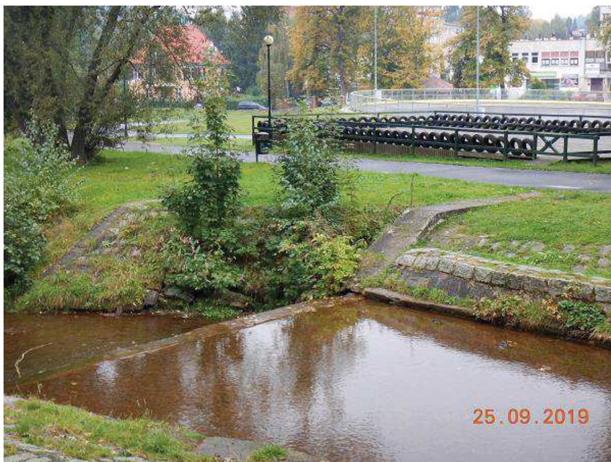
Fot. 27 Przebudowa progu H-45 w km 27+048 na bystrze
