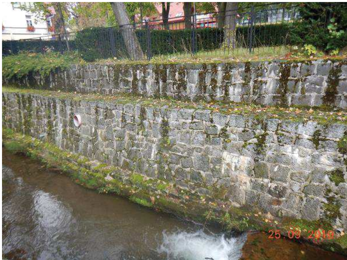
Fot. 44 Reprofilacja muru na odcinku 27+796 – 28+108 (BP)
