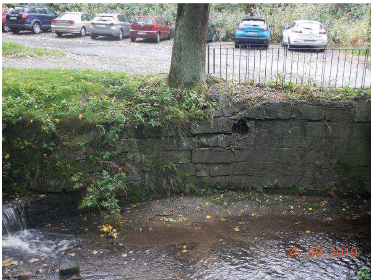
Fot. 53 Rozbiórka i odbudowa muru na odcinku 28+344 - 28+448 (BL)
