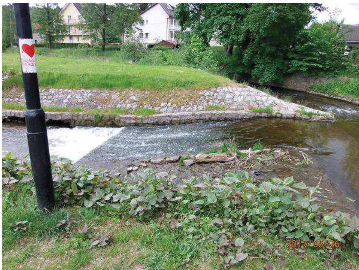
Fot. 23 - Rozdział wód na koryto A i B. Próg w km 14+498 - Koryto A
