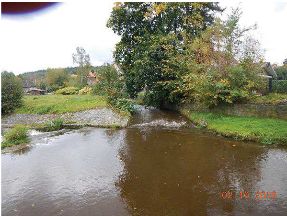
Fot. 25 - Rozdział wód na koryto A i B - km 15+510
