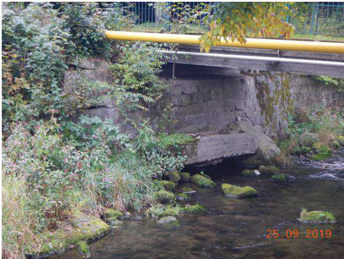
Fot. 32 - Reprofilacja prawego muru pod mostem M-28 w km 16+207
