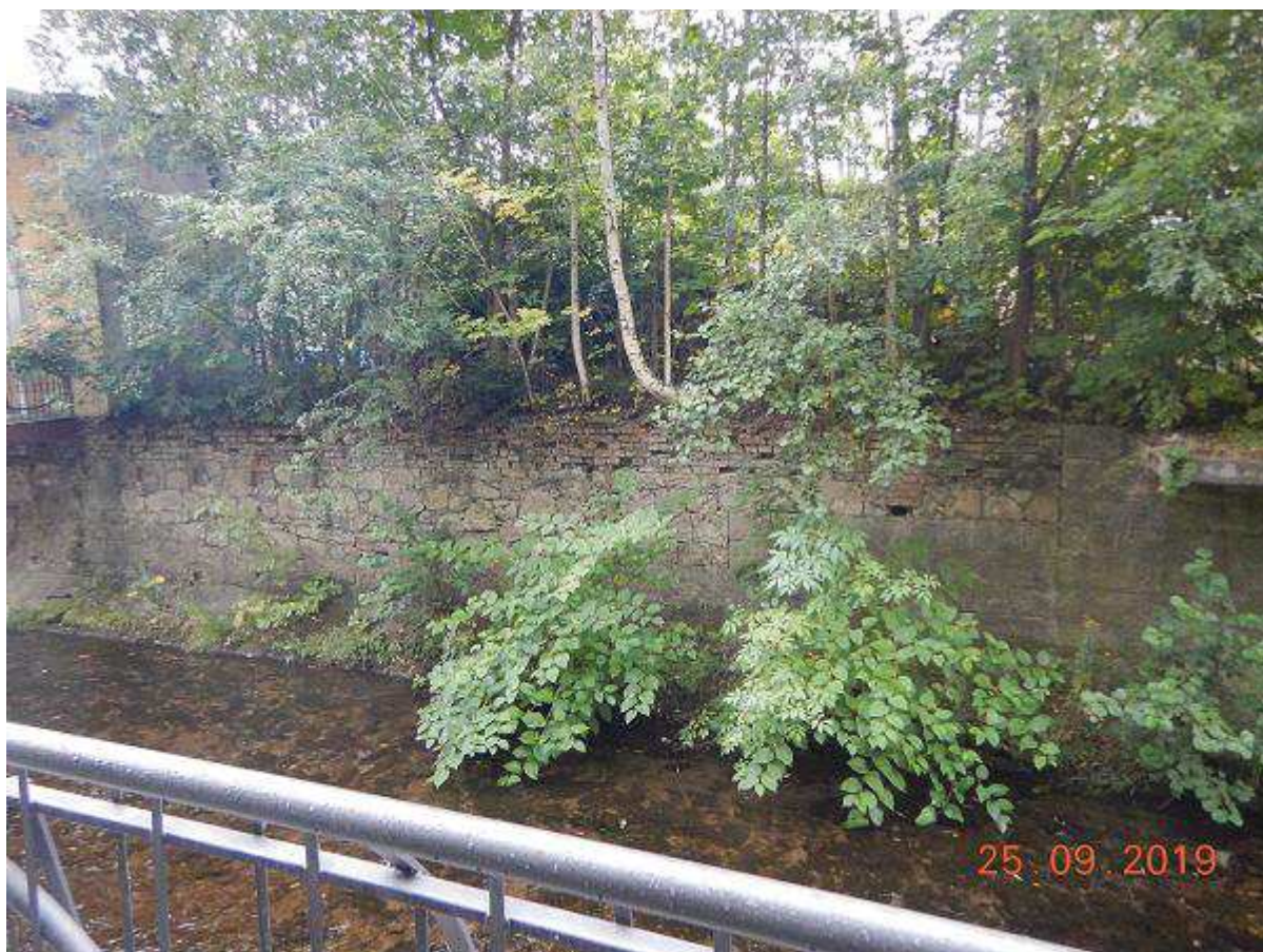
Fot. 17 - Reprofilacja muru prawego (koryto A) powyżej mostu M-24A.
