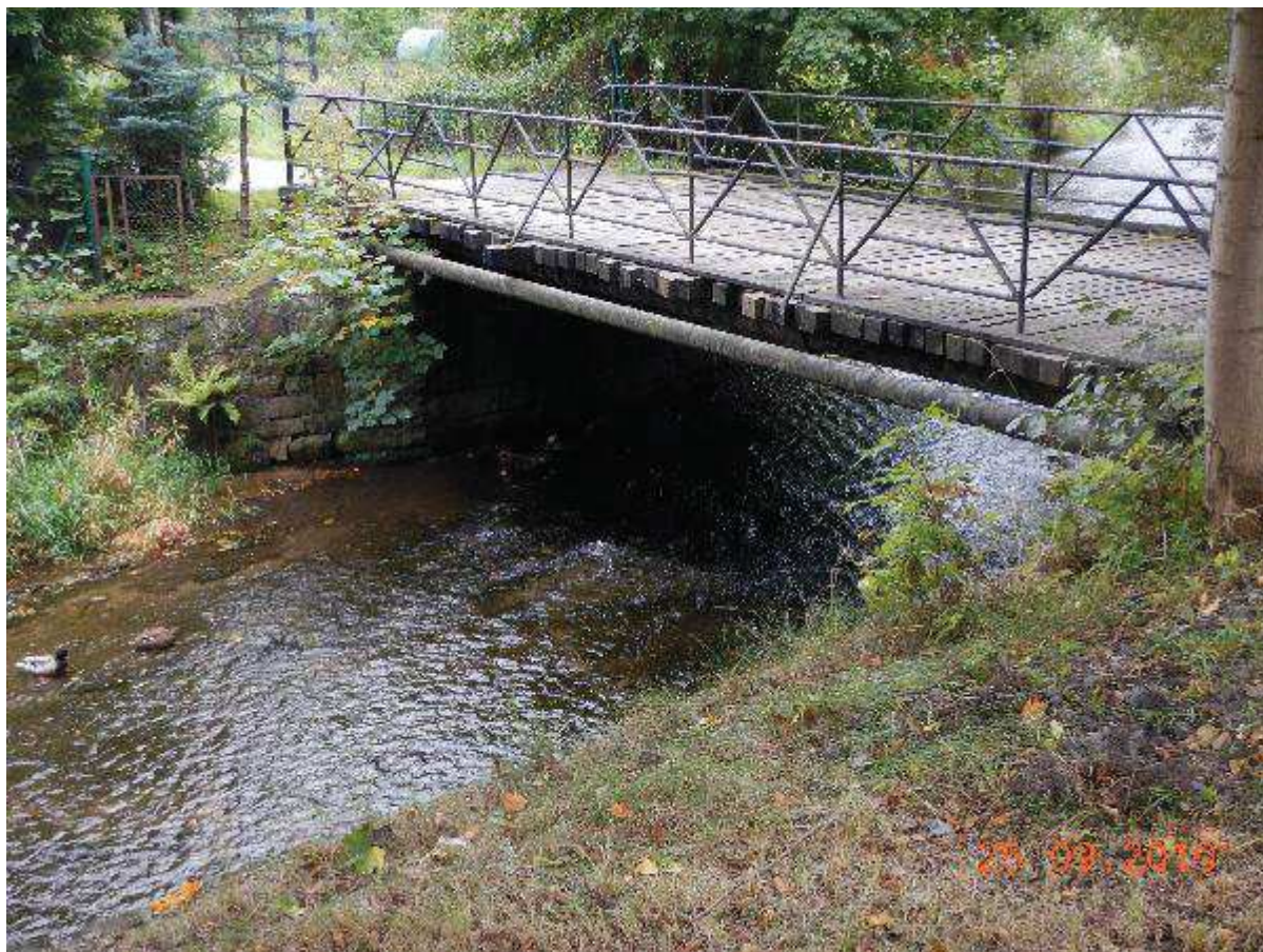
Fot. 1 - Reprofilacja muru poniżej mostu M-18 (km 14+083)
