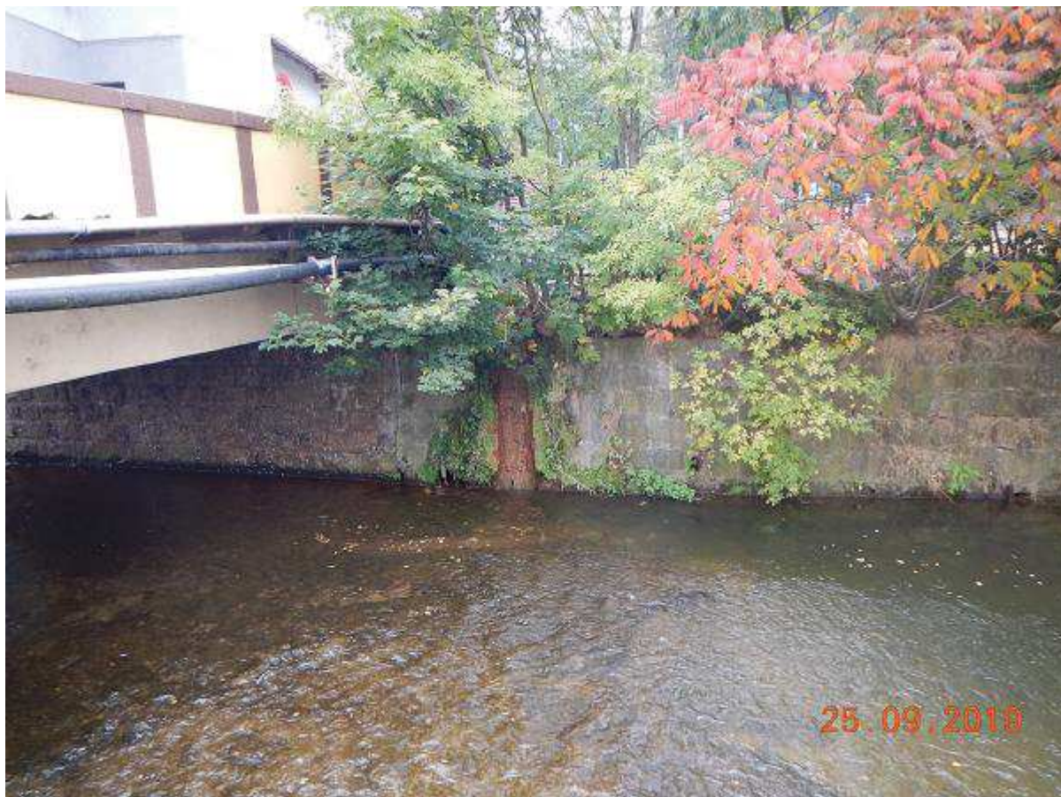
Fot. 11 - Reprofilacja muru lewego poniżej mostu M-20 (km 14+686)
