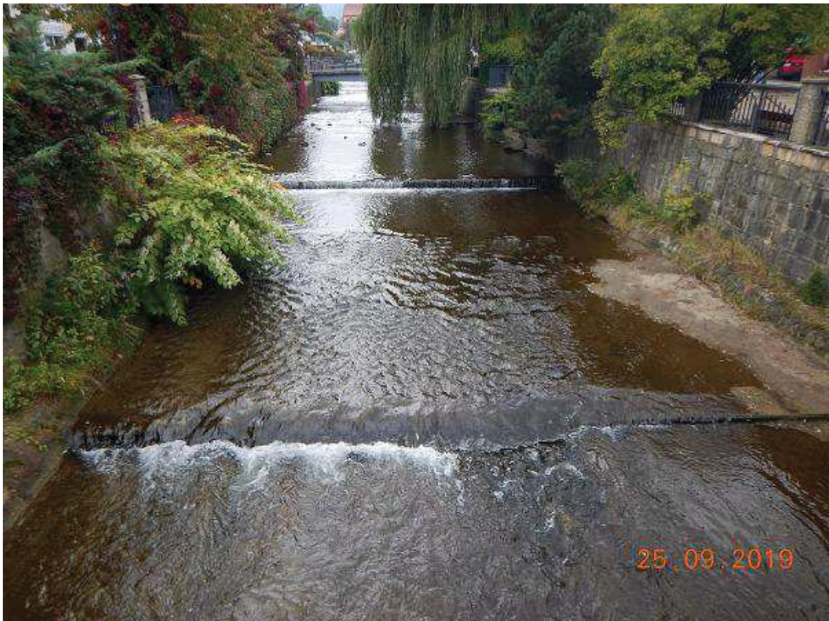
Fot. 13- Reprofilacja murów na odcinku w km 14+686 - 15+020 (między mostami M-20 - M-24A - koryto wzdłuż deptaku)
