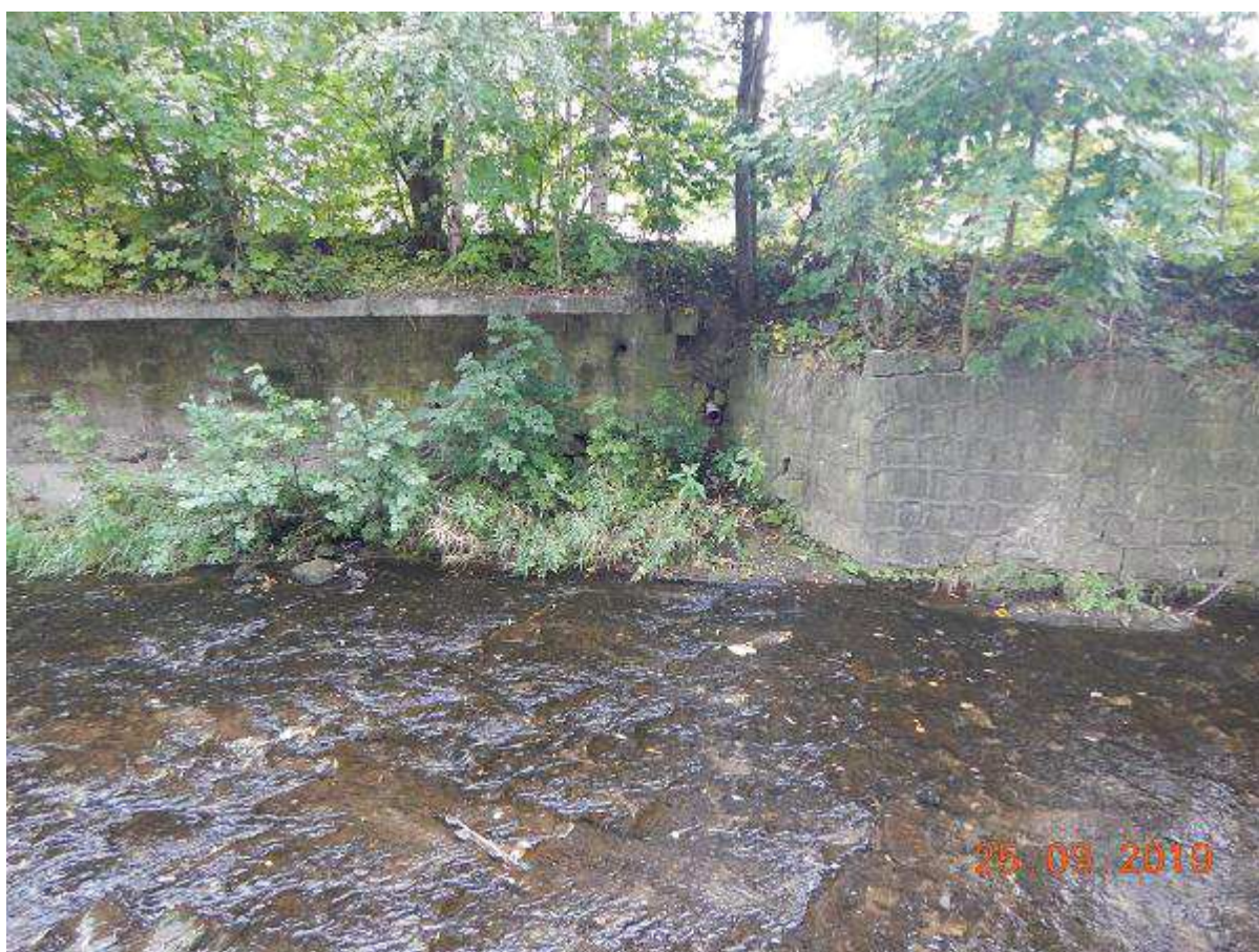
Fot. 18 - Reprofilacja muru prawego (koryto A) powyżej mostu M-24A.
