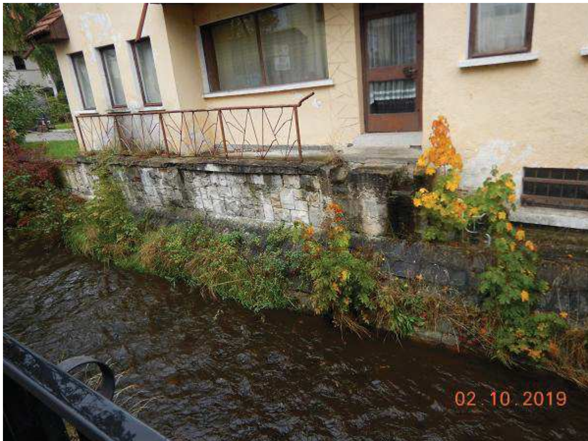
Fot. 20 - Koryto B – Reprofilacja muru i ubezpieczeń skarpowych. Brzeg lewy w km 0+080
