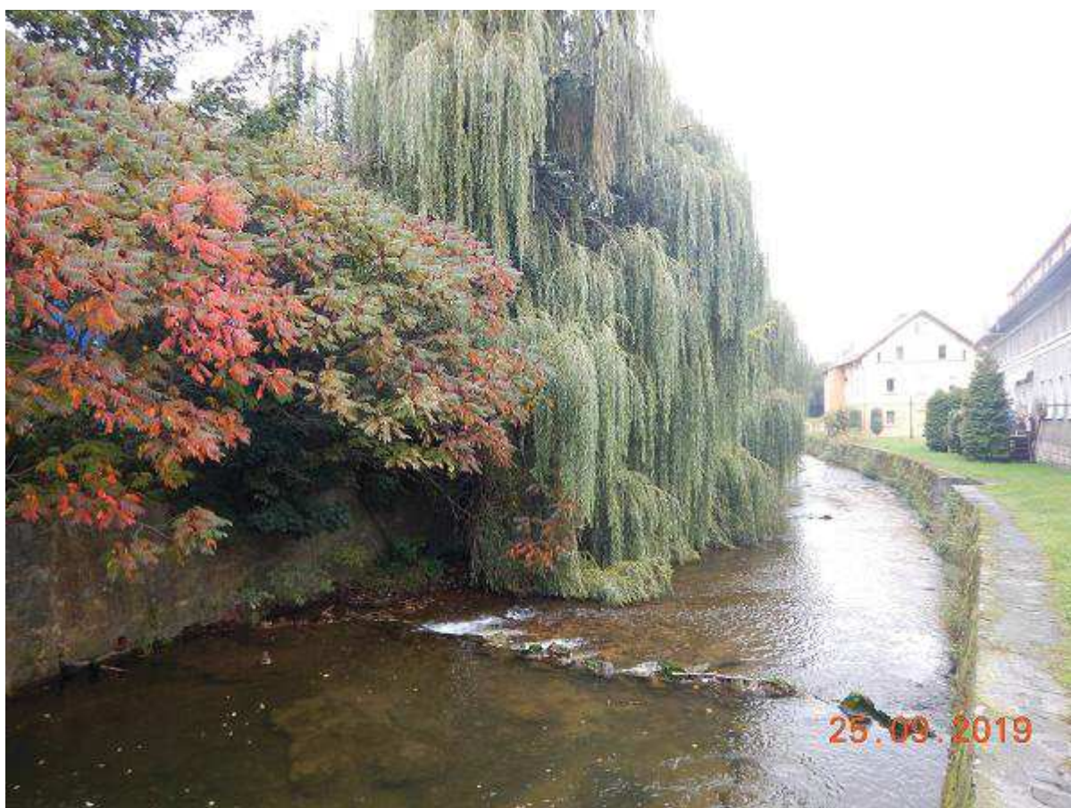
Fot. 8 - Reprofilacja murów na odcinku w km 14+532 - 14+686 (między mostami M-19 - M-20)- widok z mostu M-20 w dół rzeki.
