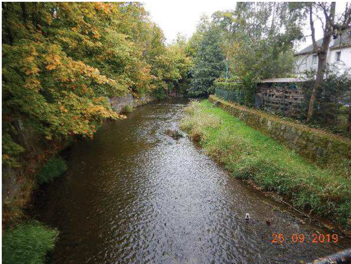
Fot. 2 - Reprofilacja murów na obu brzegach poniżej mostu M-18 (km 14+083)
