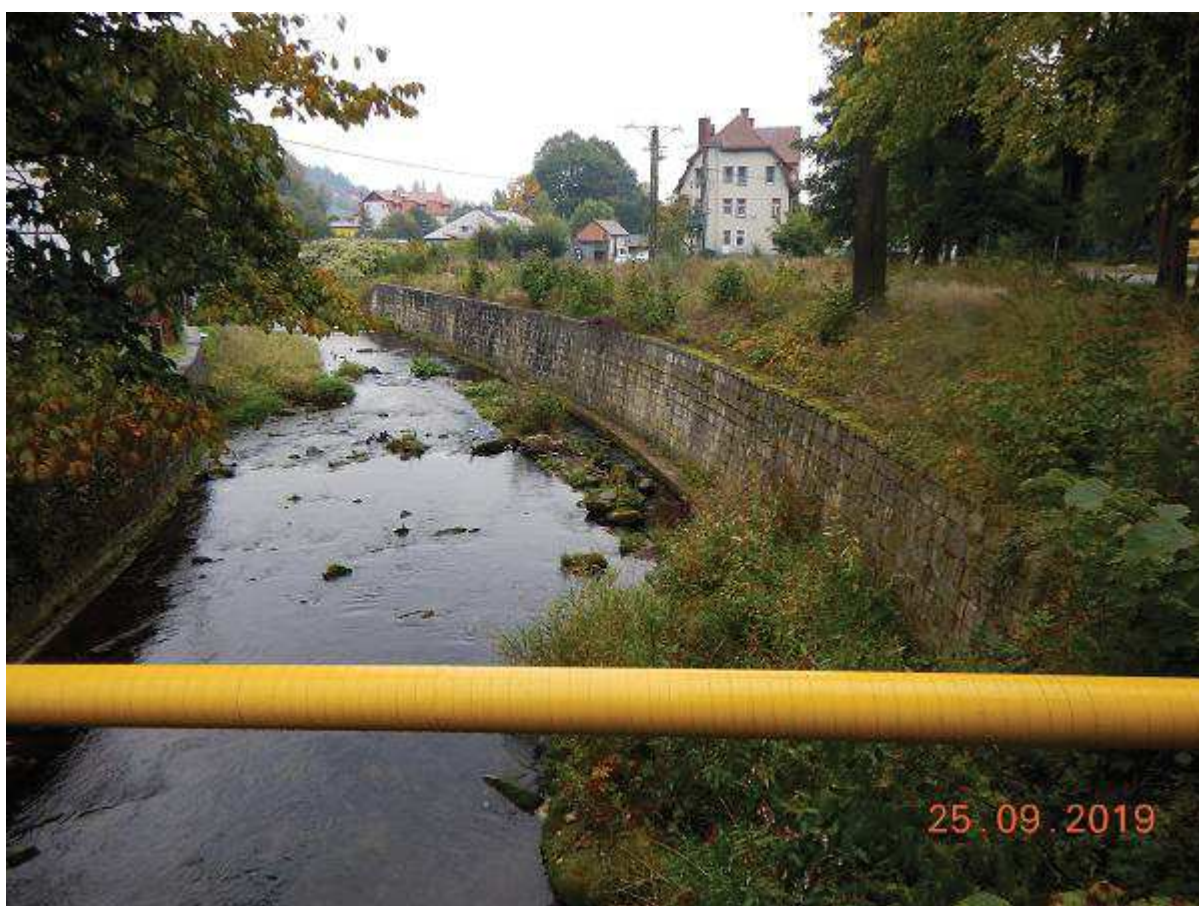
Fot. 30 - Reprofilacja murów poniżej mostu M-28 - km 16+207
