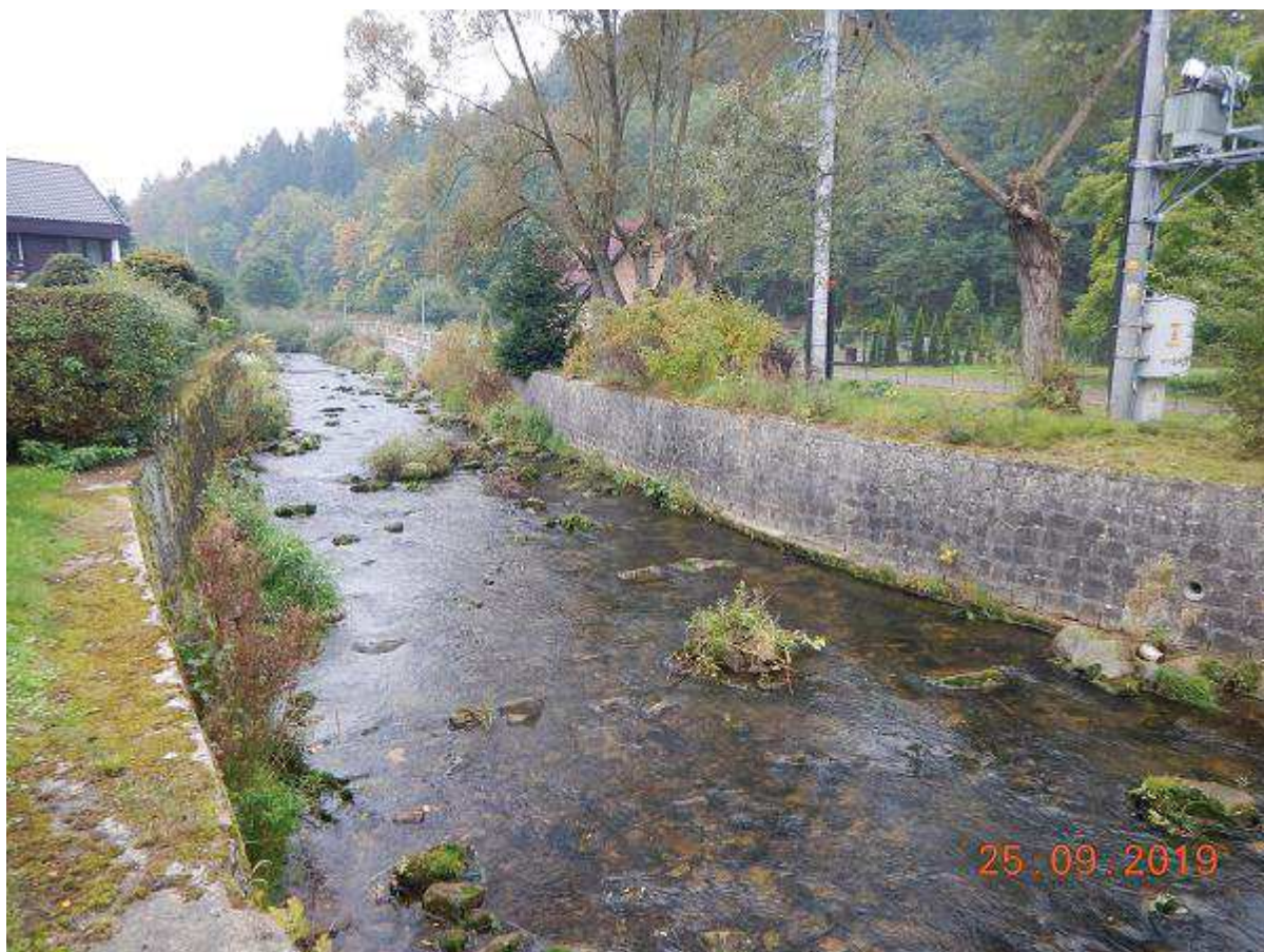
Fot. 29 - Reprofilacja murów powyżej mostu M-27. Mur na brzegu lewym w km 15+570
