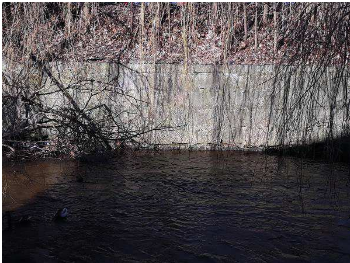
Fot. 10 - Reprofilacja muru lewego na odcinku w km 14+532 - 14+686 (między mostami M-19 - M-20)
