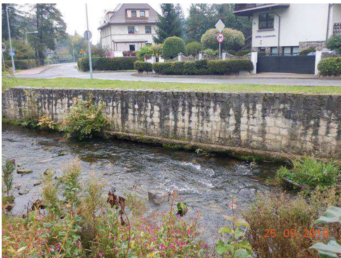
Fot. 28 - Reprofilacja murów powyżej mostu M-27. Mur na brzegu prawym w km 15+570
