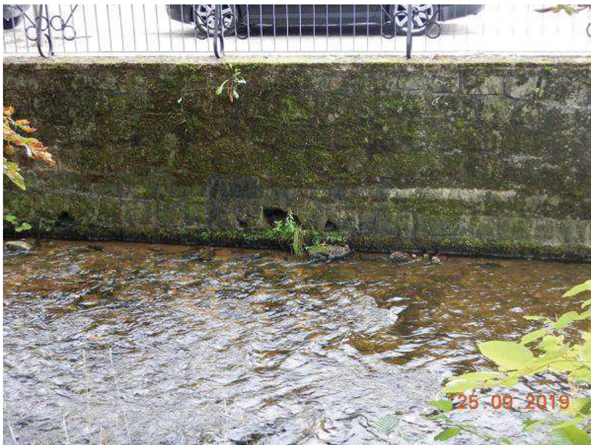
Fot. 21 - Koryto B - Reprofilacja muru. Brzeg prawy w km 0+125
