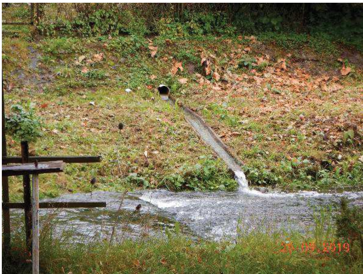
Fot. 6 - Zabudowa wylotu kanalizacji deszczowej w km 14+173 na brzegu lewym i reprofilacja ubezpieczeń skarpowych. Usunięcie odkładu
