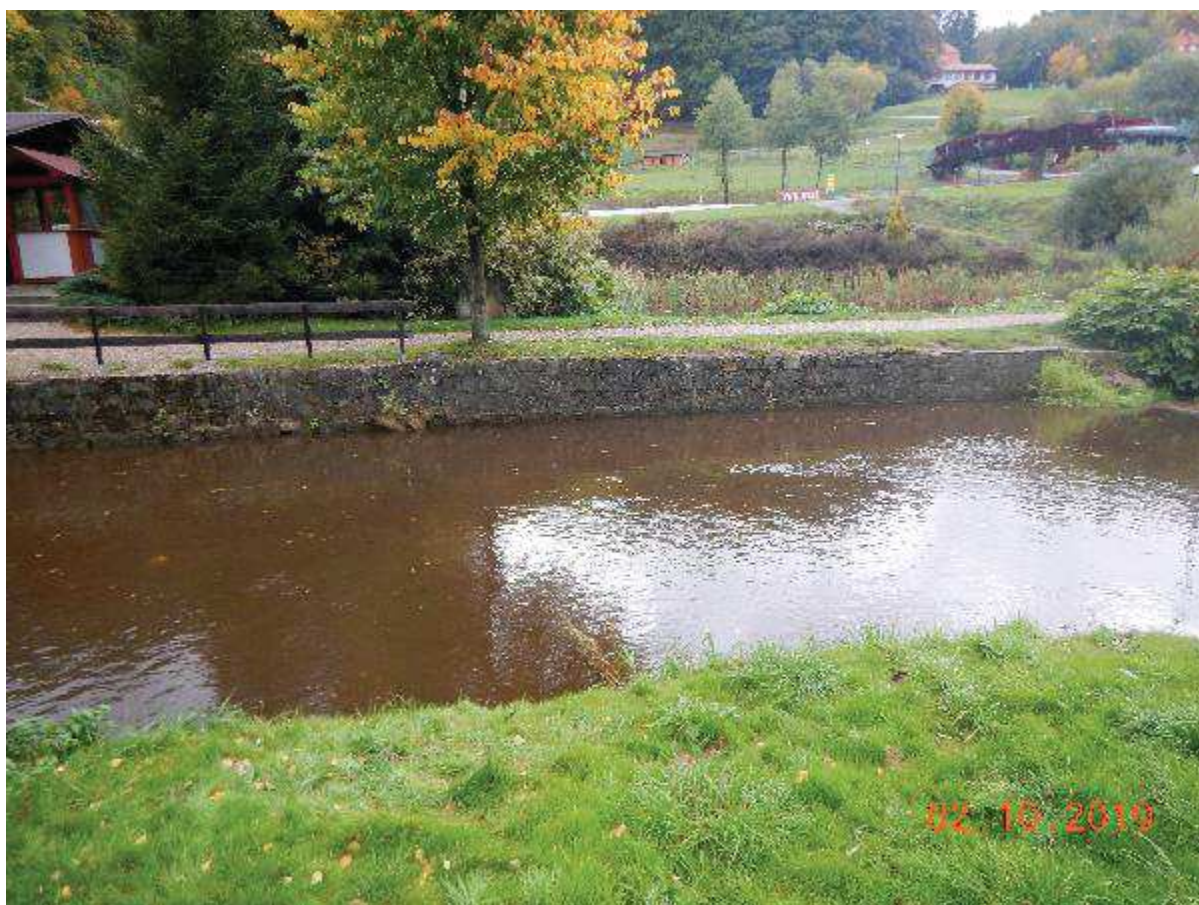
Fot. 26- Reprofilacja muru lewego powyżej progu H-23 (km 15+498)
