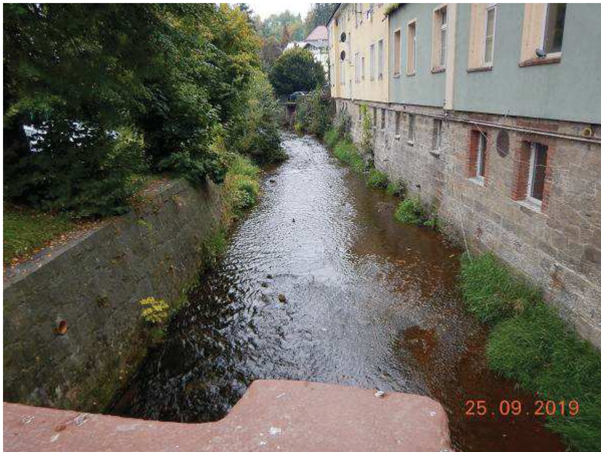
Fot. 12 - Reprofilacja murów na odcinku w km 14+686 - 15+020 (między mostami M-20 - M-24A) - widok z mostu M-20 w górę rzeki
