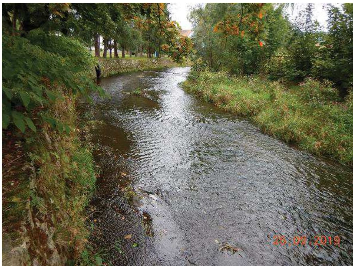
Fot. 5 - Reprofilacja murów i ubezpieczeń skarpowych na odcinku w km 14+083 - 14+523 (pomiędzy mostami M-18 i M-19). Usunięcie odkładu na brzegu lewym.
