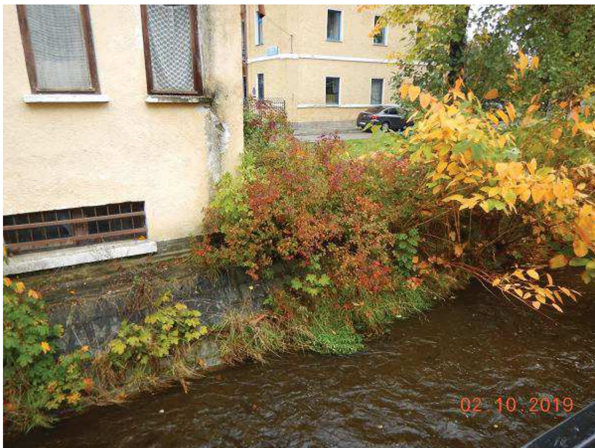
Fot. 19 - Koryto B – Reprofilacja muru i ubezpieczeń skarpowych. Brzeg lewy w km 0+080
