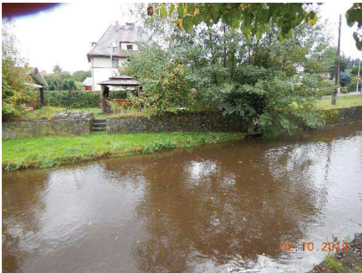
Fot. 27 Reprofilacja muru prawego powyżej progu H-23 (km 15+498)
