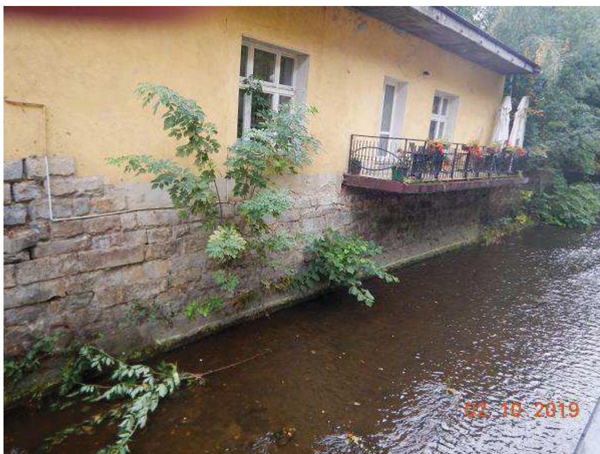
Fot. 16 - Reprofilacja muru prawego (koryto A) powyżej mostu M-24A.
