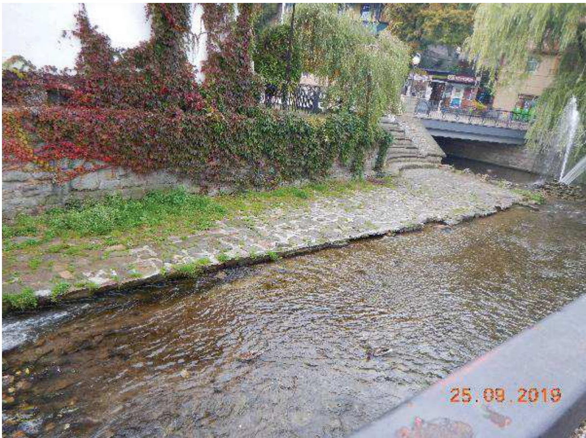
Fot. 14 - Reprofilacja chodnika w korycie cieku (wylot koryta B) - rejon fontanny
