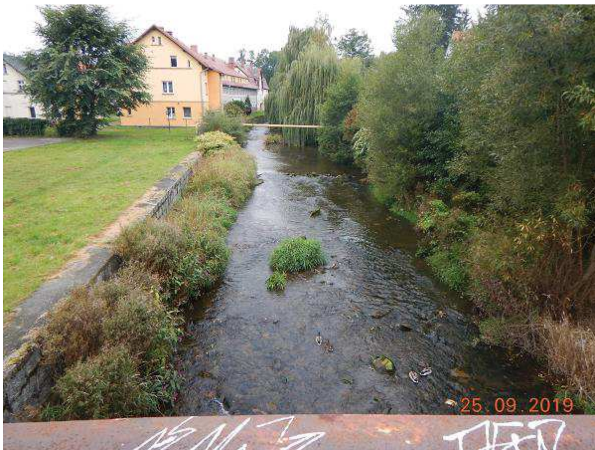
Fot. 7 - Reprofilacja murów na odcinku w km 14+532 - 14+686 (między mostami M-19 - M-20) - widok z mostu M-19 w górę rzeki.
