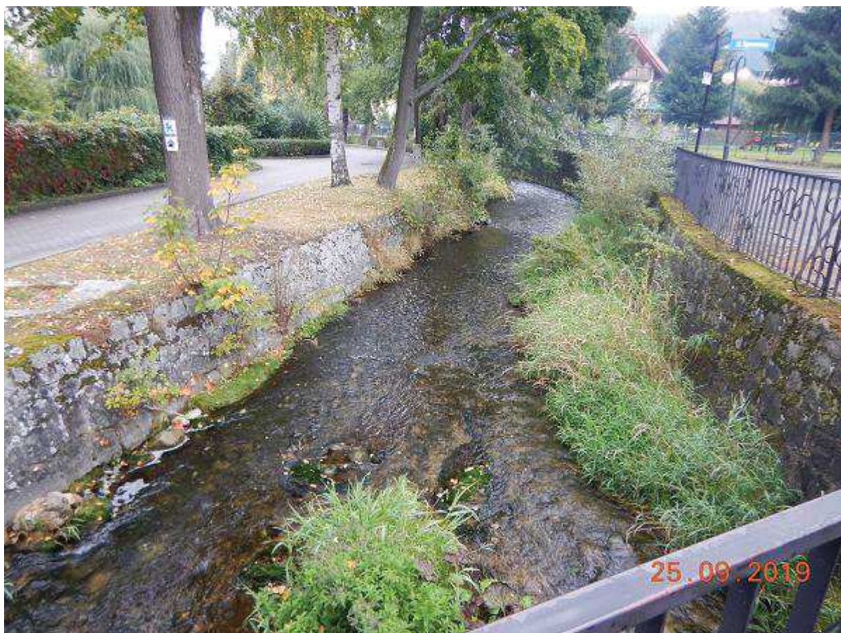
Fot. 22 - Koryto B - reprofilacja murów i ubezpieczeń skarpowych. Widok z mostu M-25B (km 0+280) w dół rzeki
