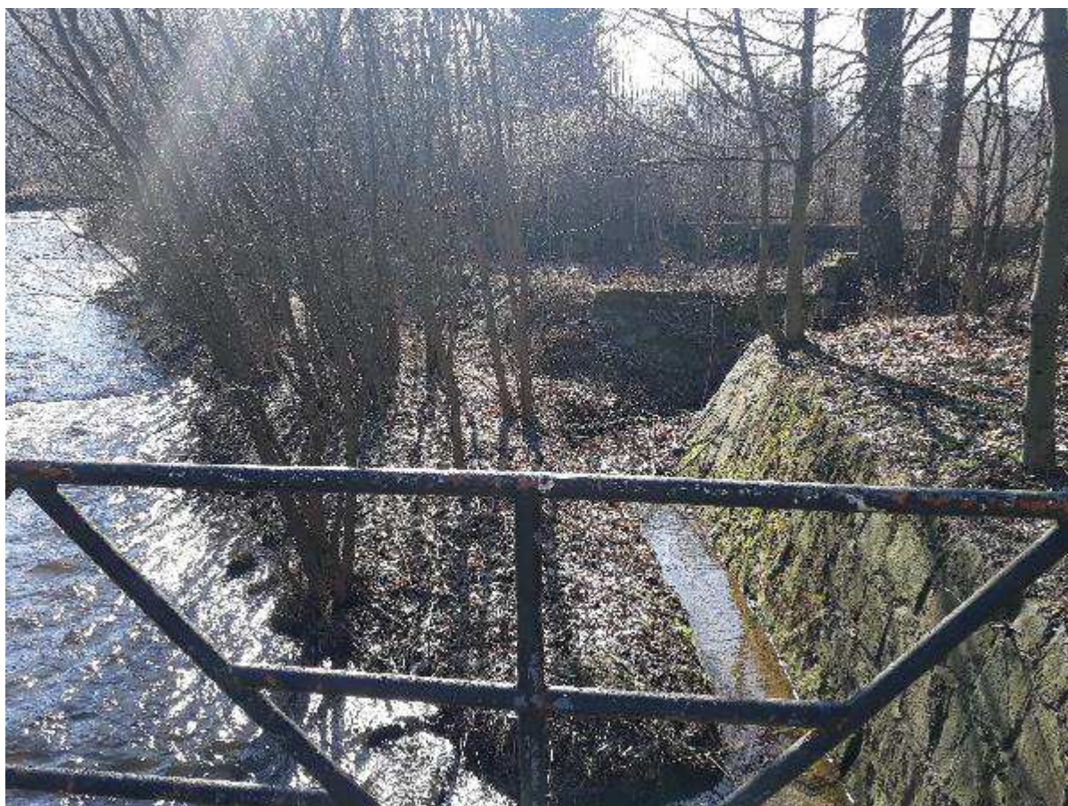
Fot. 4 - Reprofilacja muru i wylotu (km 14+100) na brzegu lewym powyżej mostu M-18 (km 14+083). Usunięcie odkładu
