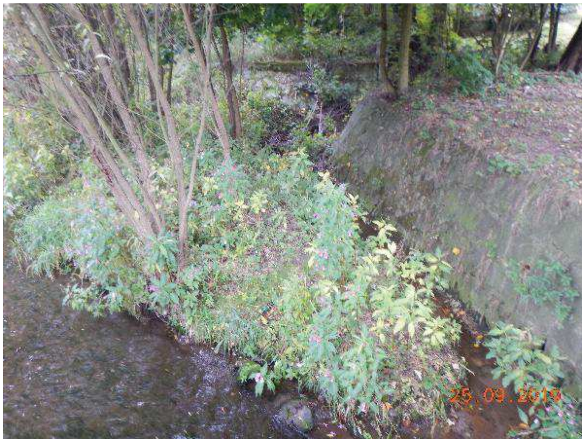
Fot. 3 - Reprofilacja muru i wylotu na brzegu lewym powyżej mostu M-18 (km 14+083). Usunięcie odkładu.
