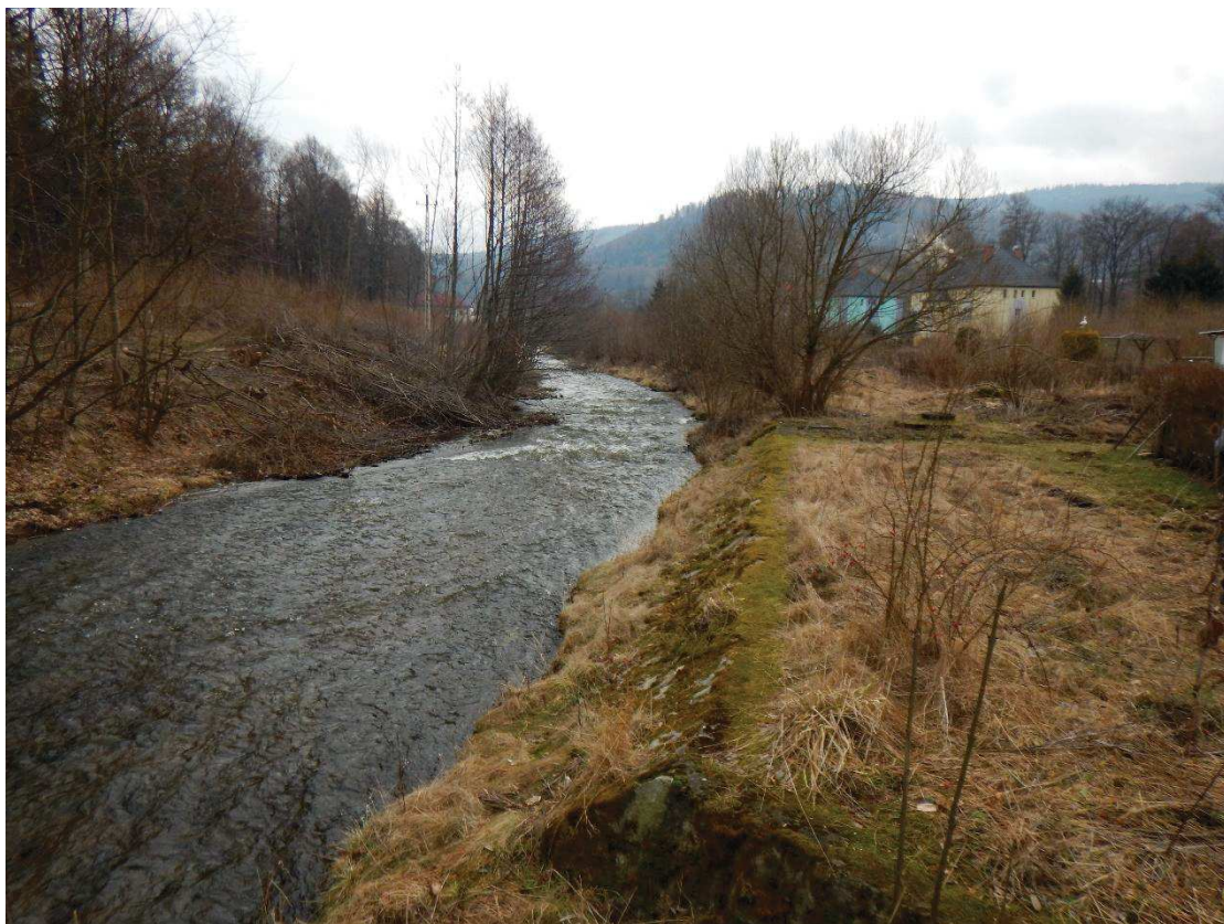
Fot. 5 i 6. Remont ubezpieczeń brzegowych w km 21+190 ÷ 21+710 (BP).
