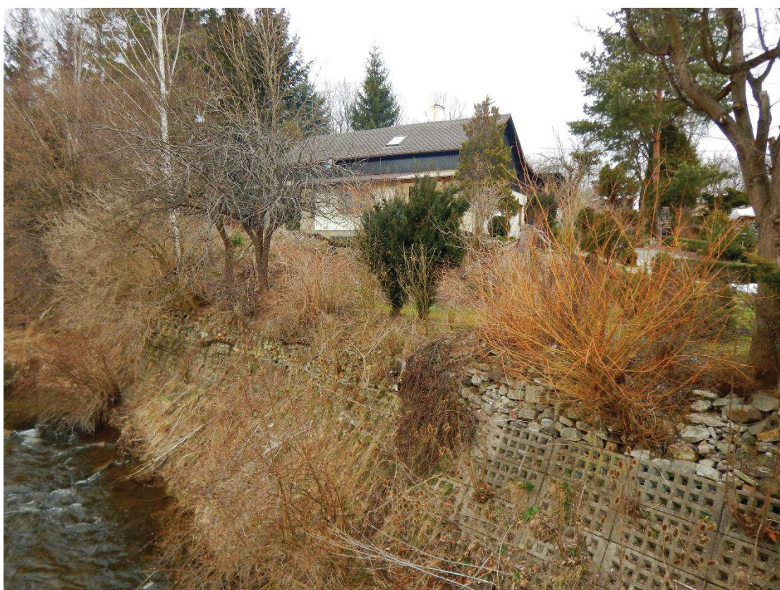
Fot. 10. Rozbiórka i odbudowa muru w km 22+110 ÷ 22+160 (BL).
