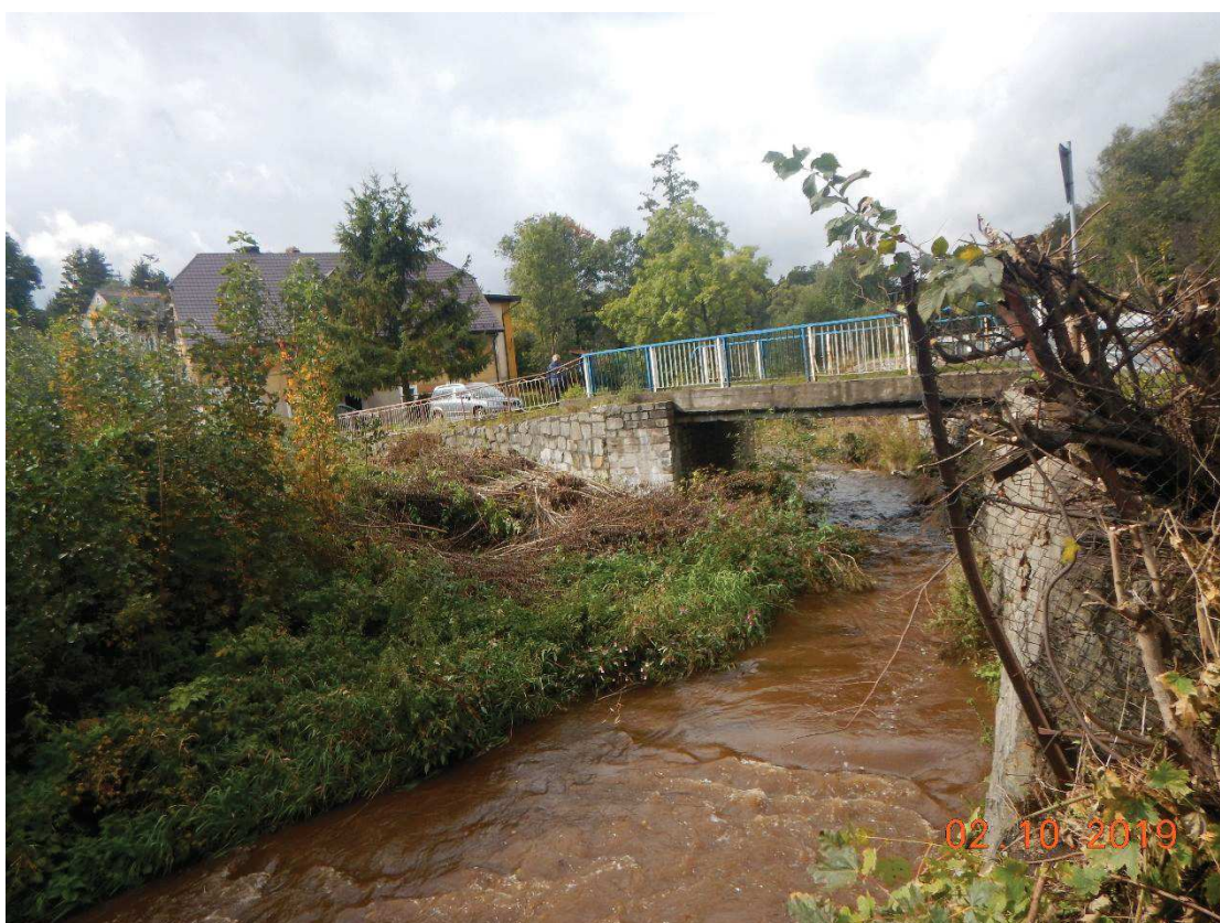
Fot. 20. Przebudowa mostu M-45 w km 23+539. Widok od strony dolnej wody.
