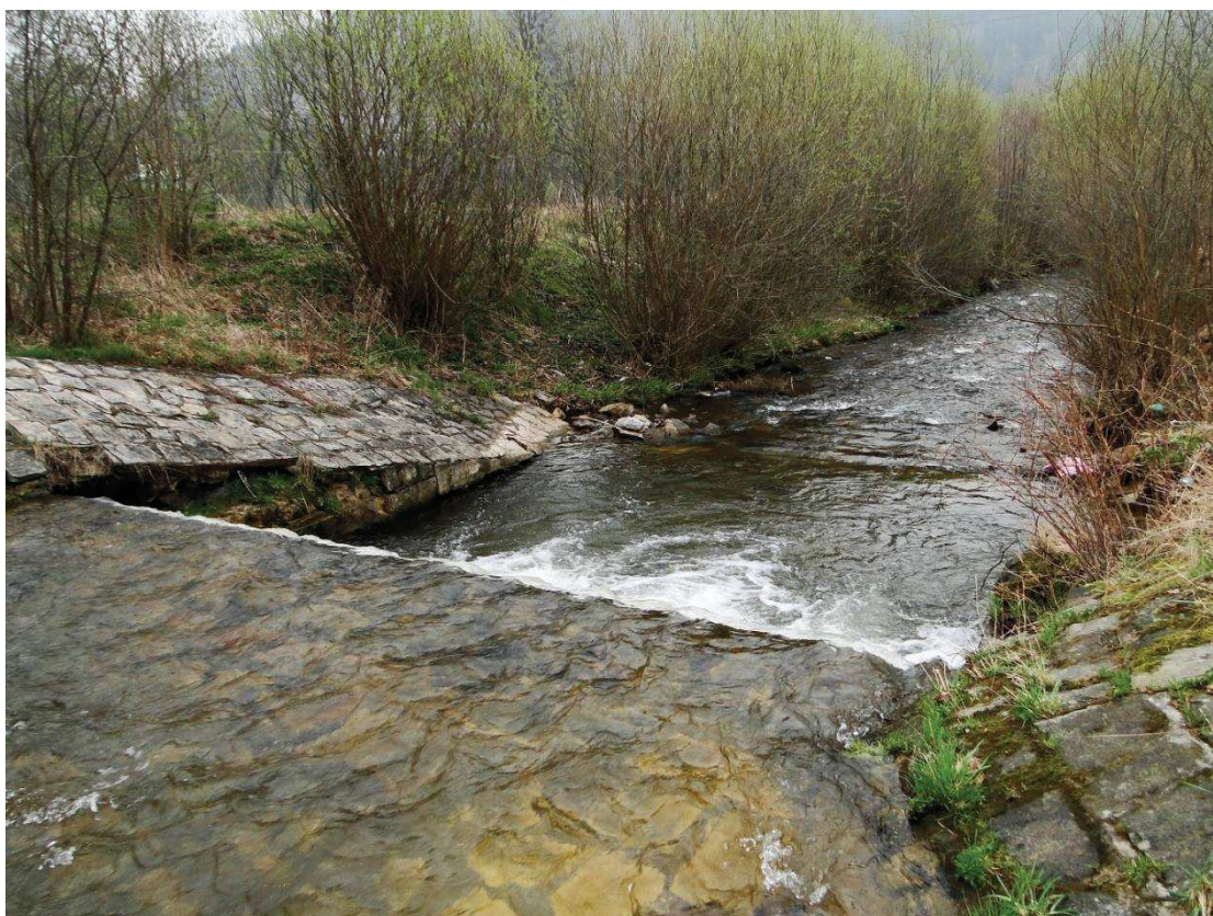
Fot. 9. Przebudowa progu H-40 w km 21+954 na bystrze.
