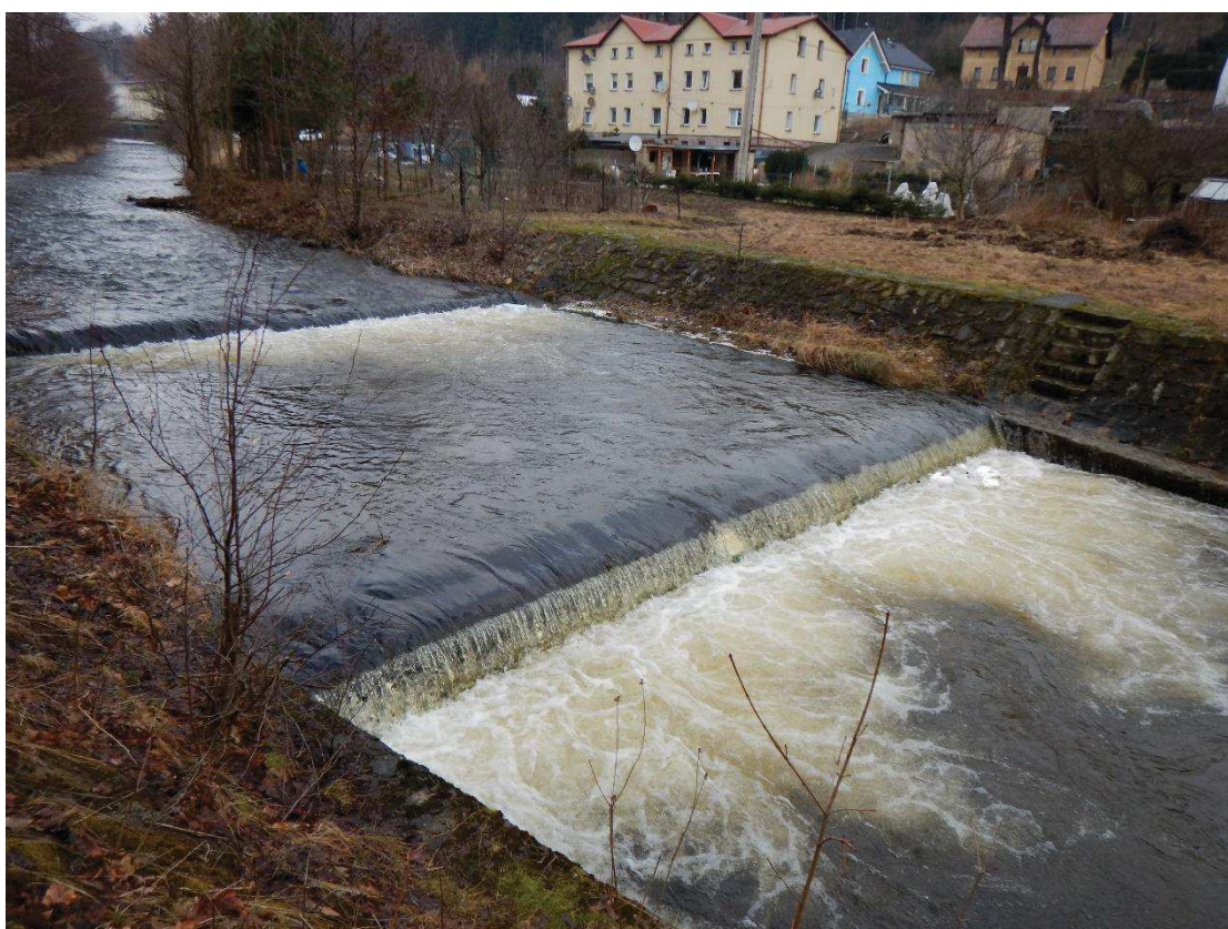
Fot. 2. Przebudowa progów H-36 i H-37 na bystrze w km 21+000 ÷ 21+060.
