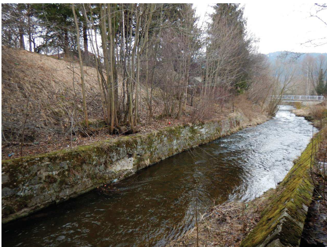
Fot. 12. Rozbiórka i odbudowa muru w km 22+155 ÷ 22+200 (BP i BL).
