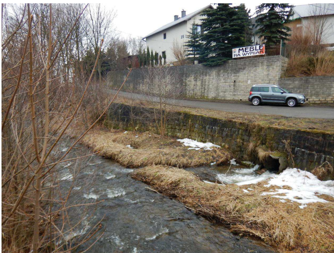
Fot. 18. Reprofilacja muru w km 23+140 ÷ 23+170 (BP).
