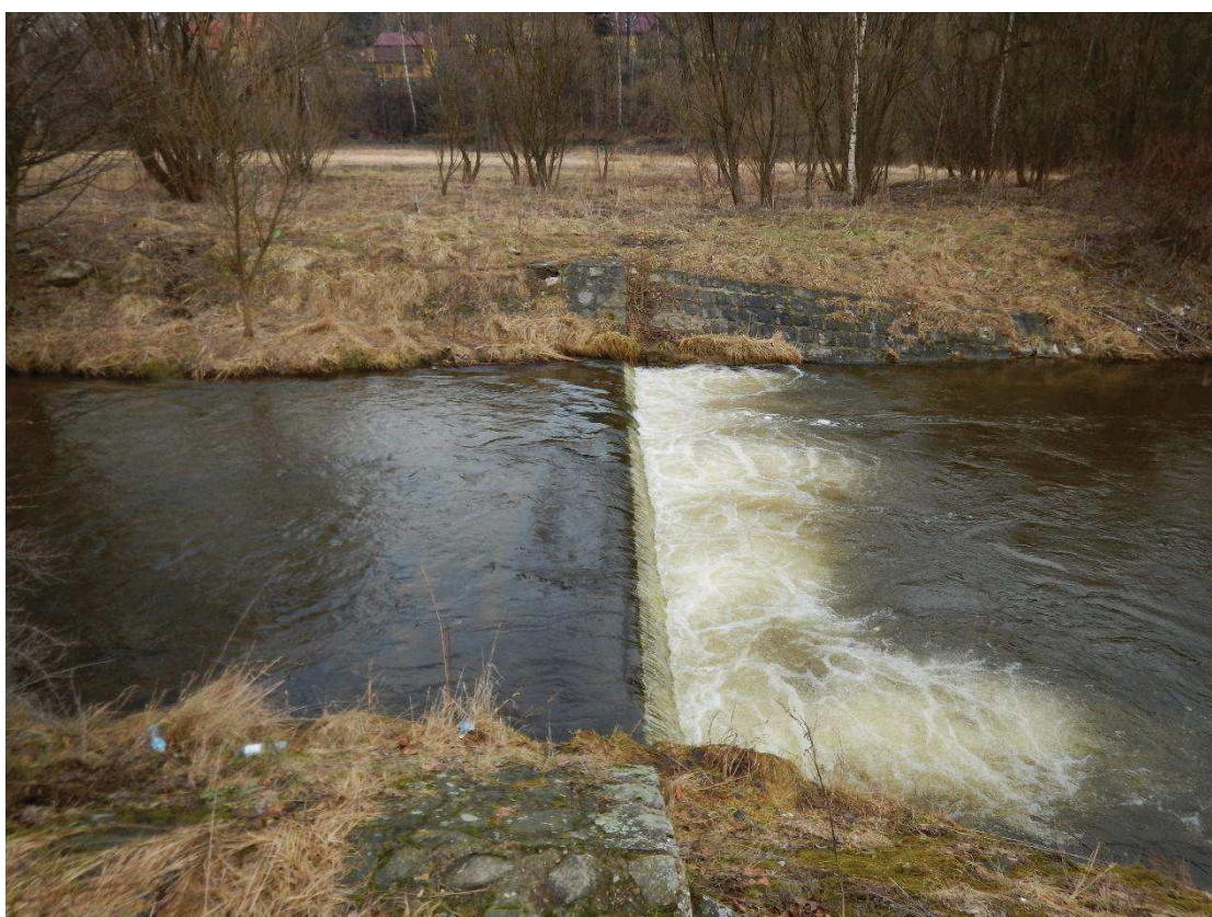
Fot. 8. Przebudowa progu H-39 w km 21+702 na bystrze.
