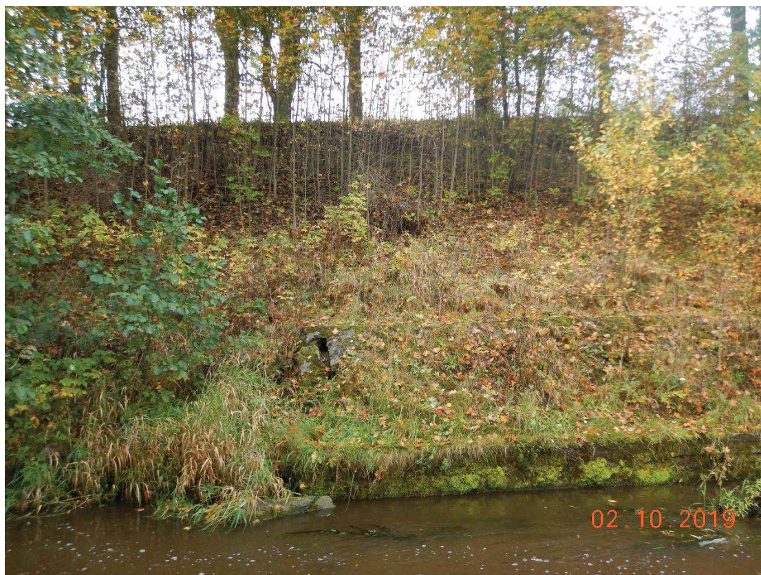
Fot. 3. Przebudowa progów H-36 i H-37 na bystrze w km 21+000 ÷ 21+060 (BP).
