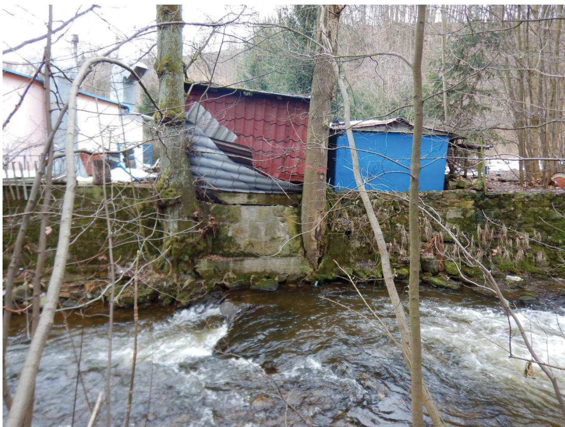
Fot. 23. Rozbiórka i odbudowa muru w km 24+560 ÷ 24+650 (BP).
