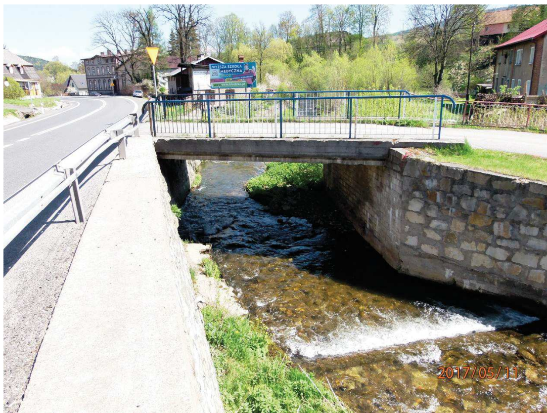
Fot. 21. Przebudowa mostu M-45 w km 23+539. Widok od strony górnej wody.
