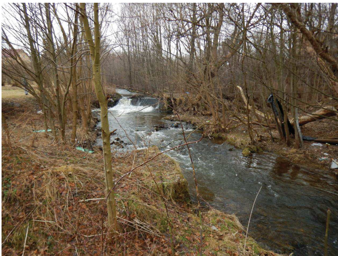
Fot. 13 i 14. Przebudowa jazu H-41 w km 22+230 na bystrze.
