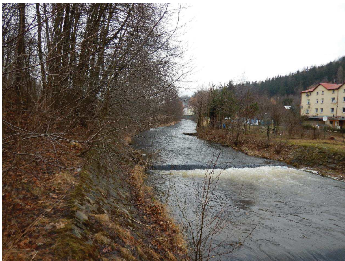
Fot. 1. Remont ubezpieczeń brzegowych w km 21+015 ÷ 21+170 (BP i BL).
