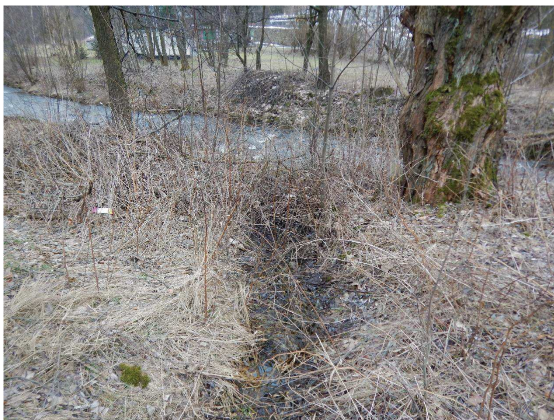
Fot. 22. Remont ujściowego odcinka rowu w km 24+220 (BL).
