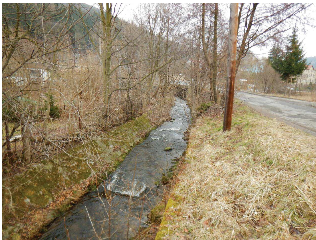
Fot. 4. Remont ujściowego odcinka potoku Szklarska Woda w km 21+180 (BP).
