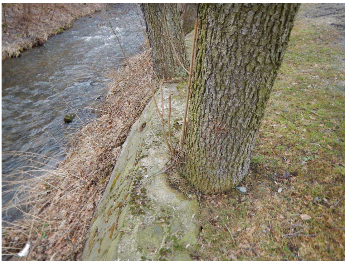
Fot. 19. Rozbiórka i odbudowa muru w km 23+175 ÷ 23+220 (BL).
