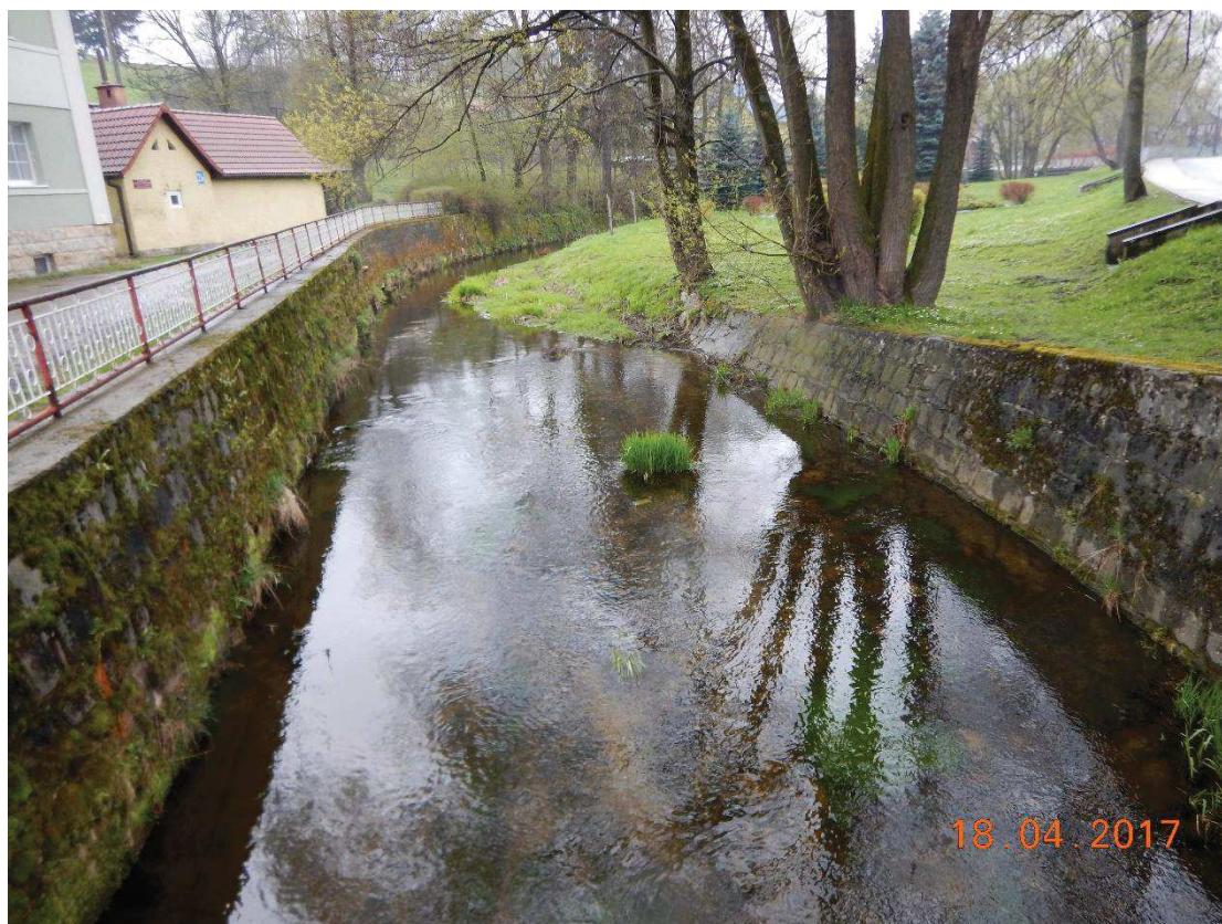
Fot. 11. Reprofilacja muru w km 1+071 – 1+121 (BL i BP)
