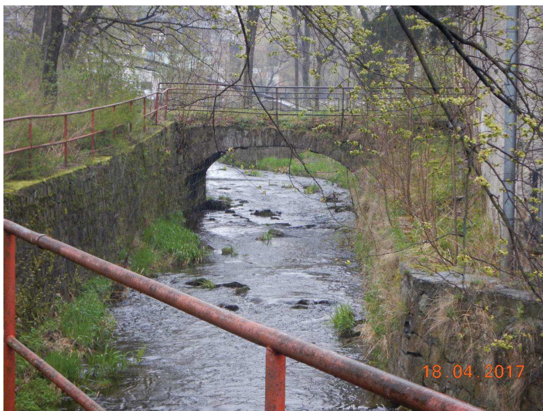
Fot. 4. Remont mostu w km 0+704, widok od strony wody dolnej.
