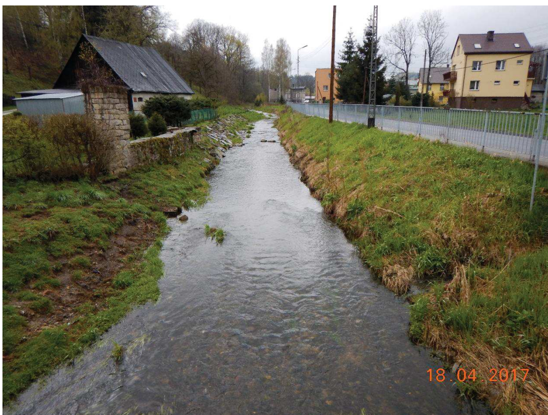
Fot. 16. Remont ubezpieczeń brzegowych w km 1+750 – 1+780 (BP).
