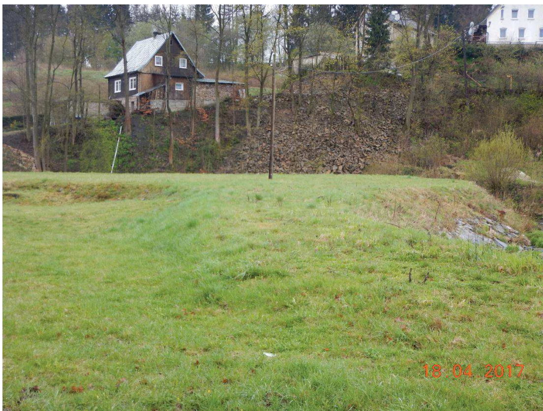
Fot. 15. Remont ubezpieczeń brzegowych w km 1+513 – 1+600 (BP).
