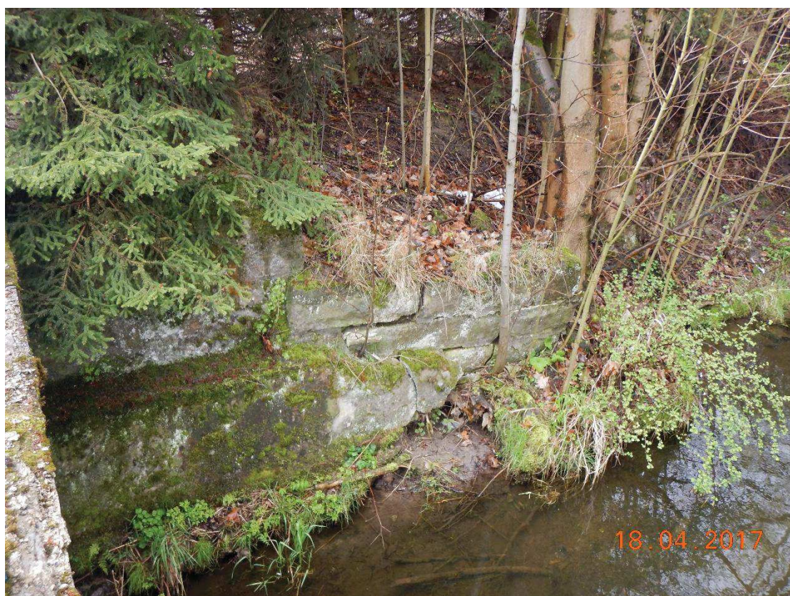
Fot. 14. Przebudowa muru w km 1+471 – 1+513 (BP).
