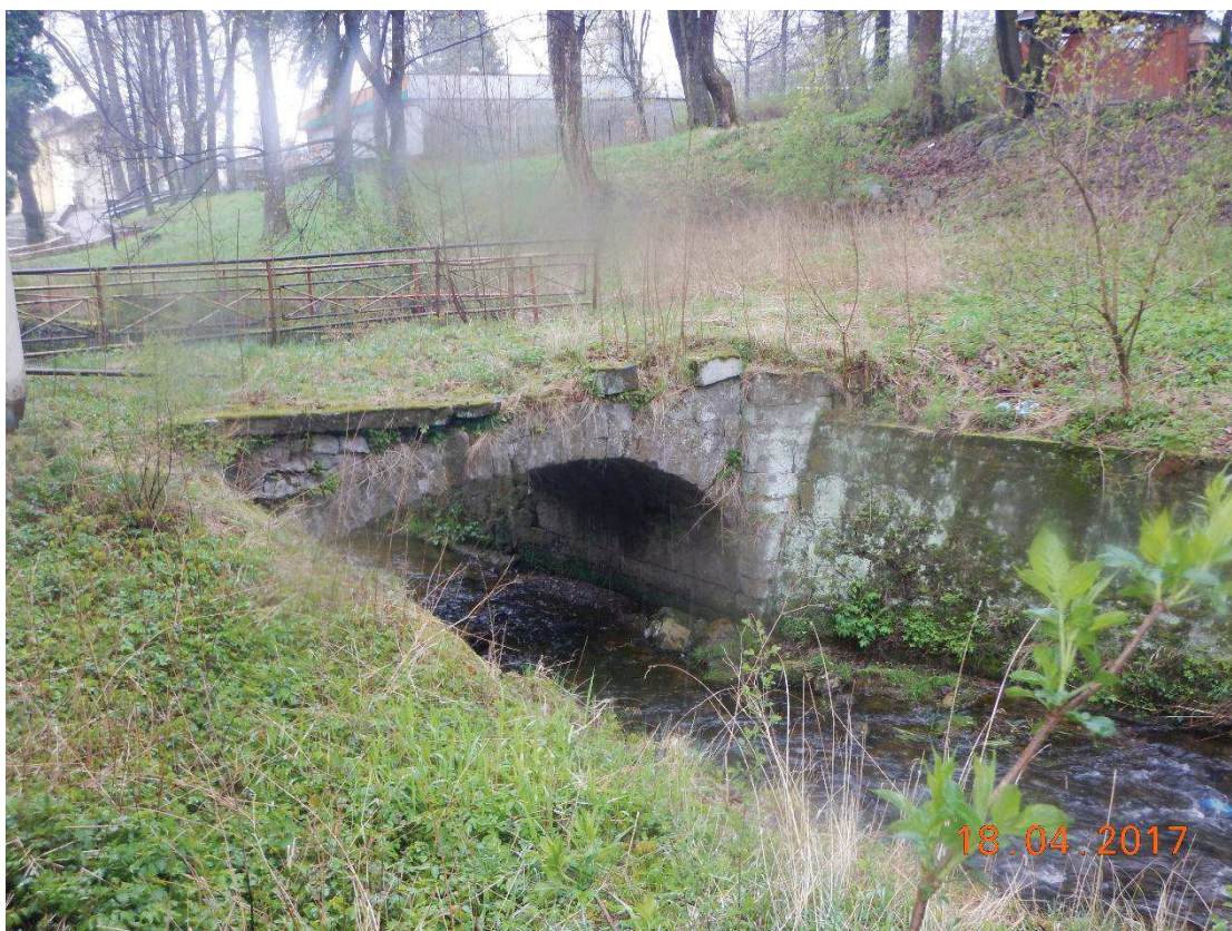
Fot. 5. Remont mostu w km 0+704, widok od strony wody górnej.
