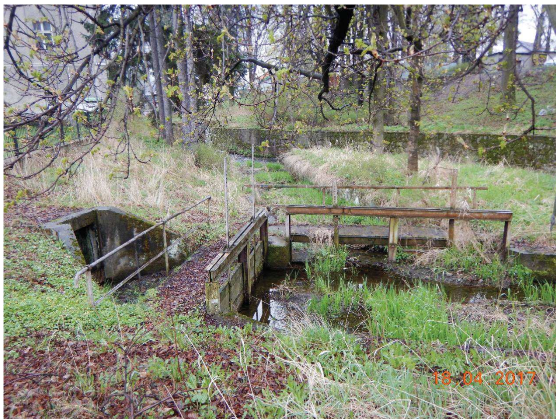
Fot. 7. Przebudowa jazu H-1 w km 0+759 na bystrze, ujęcie wody.
