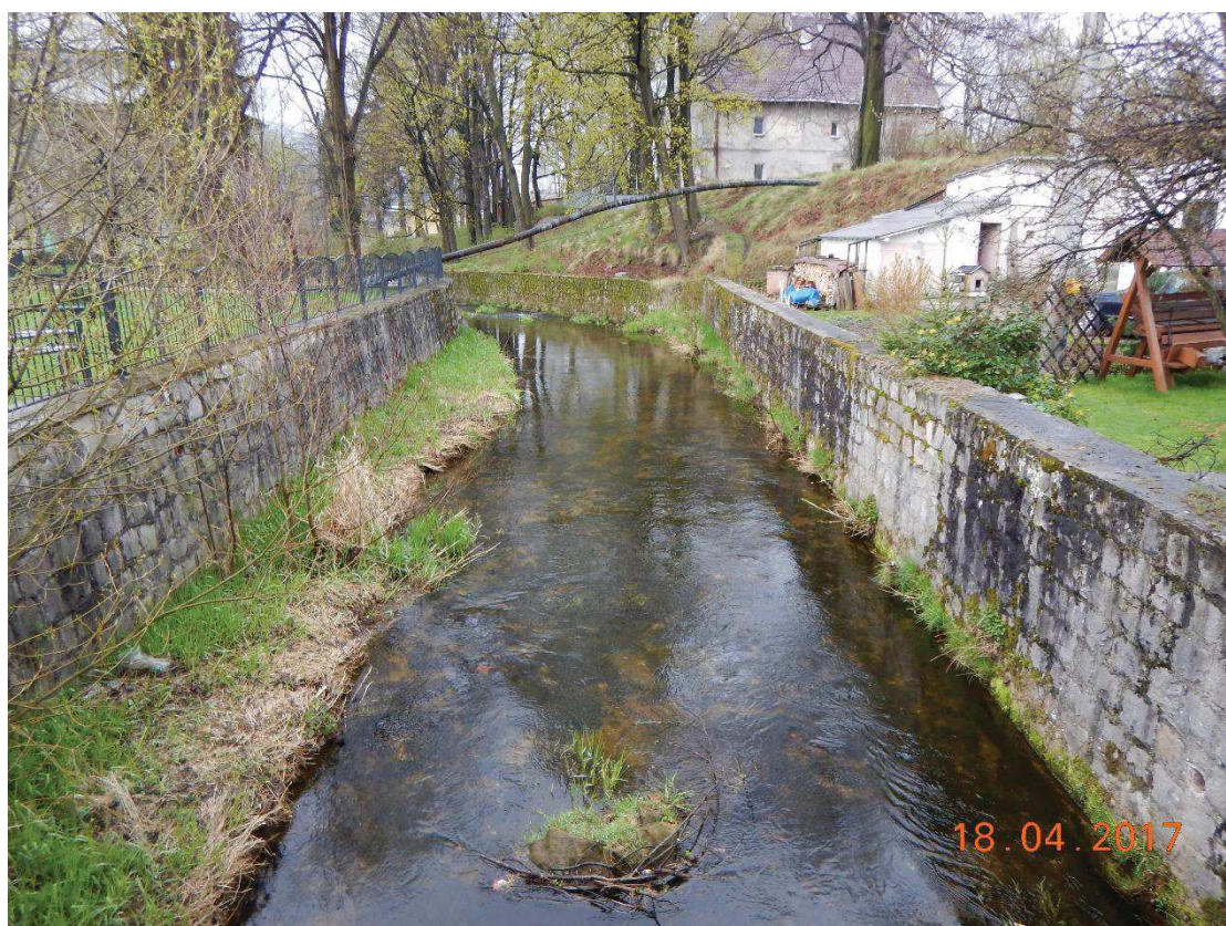
Fot. 8. Reprofilacja muru w km 0+574 – 0+984 (BL i BP)
