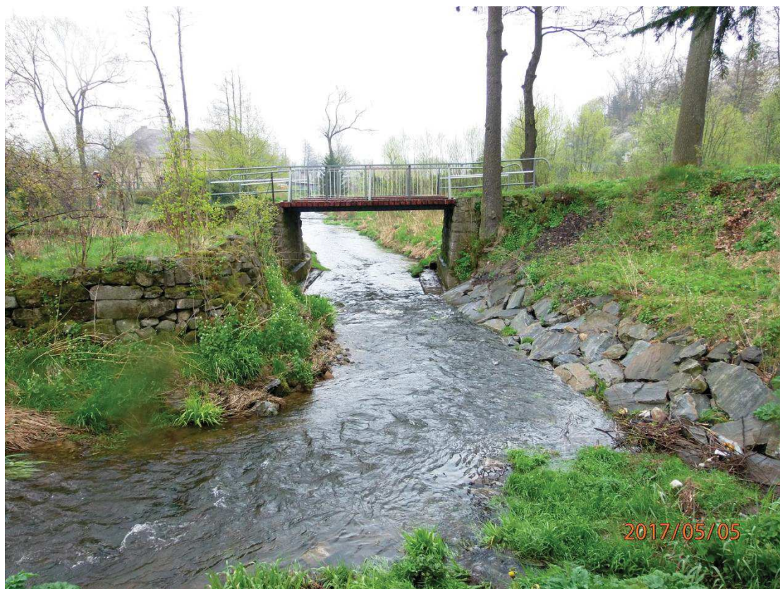
Fot. 17. Remont ubezpieczeń brzegowych w km 2+154 – 2+185 (BL).
