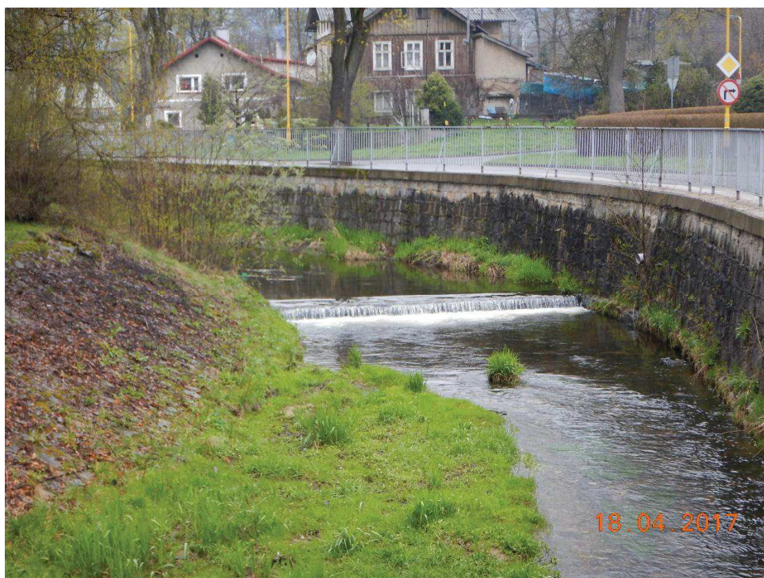
Fot. 10. Przebudowa jazu H-2 w km 1+071 na bystrze, widok od strony wody dolnej.
