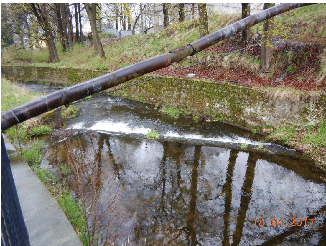
Fot. 6. Przebudowa jazu H-1 w km 0+759 na bystrze, widok od strony wody górnej.
