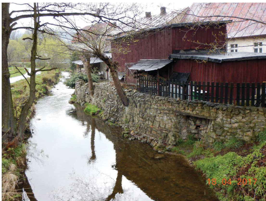
Fot. 18. Rozbiórka i odbudowa muru w km 2+213 – 2+263 (BL).
