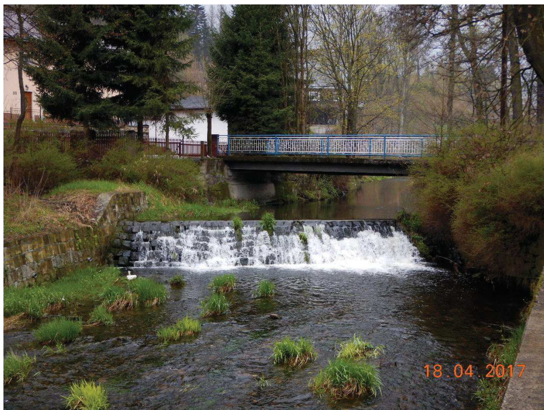
Fot. 13. Przebudowa jazu H-3 w km 1+457 na bystrze, widok od strony wody dolnej.
