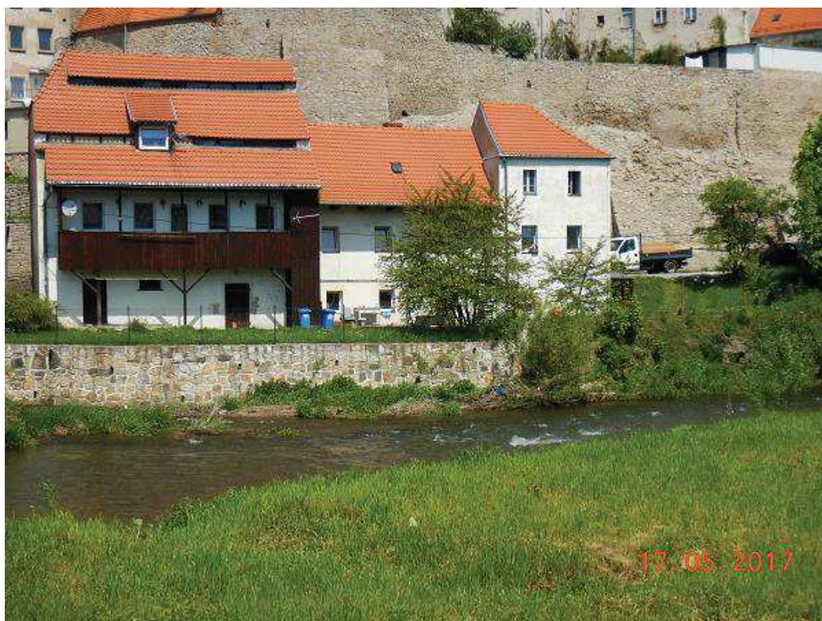
Fot. 18 Reprofilacja muru na odcinku 150+510 - 150+589 (BL) - ujściowy odcinek potoku Bystrzyca
