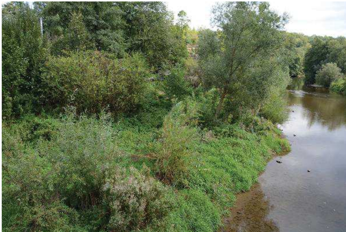
Fot. 13 Udrożnienie koryta w obrębie prawego przęsła mostu M-25 wraz z wykształceniem koryta dwudzielnego na odcinku 149+292 – 149+377 (BP) oraz budowa ubezpieczeń brzegowych na odcinku 149+323 – 149+780 (BP)
