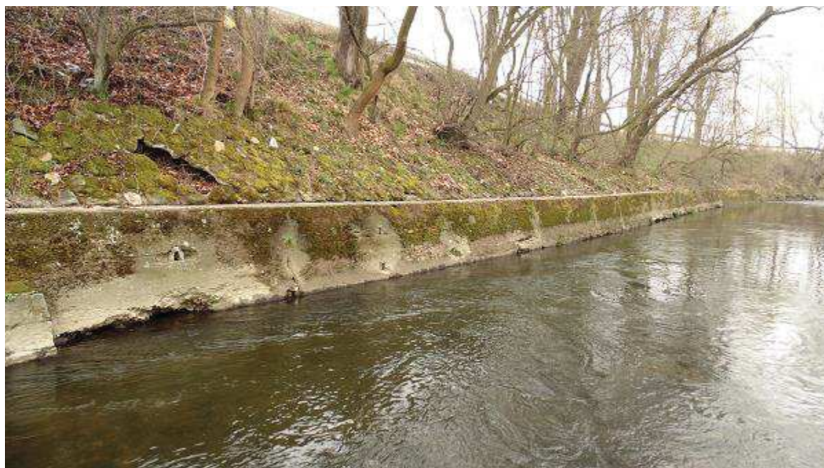
Fot. 2 Reprofilacja muru na odcinku 148+078 – 148+192 (BL)
