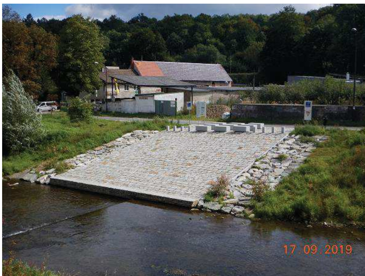
Fot. 22 Konieczna aktualizacja mapy DCP na odcinku 150+610 – 150+650 (BP) – wybudowana przystań kajakowa
