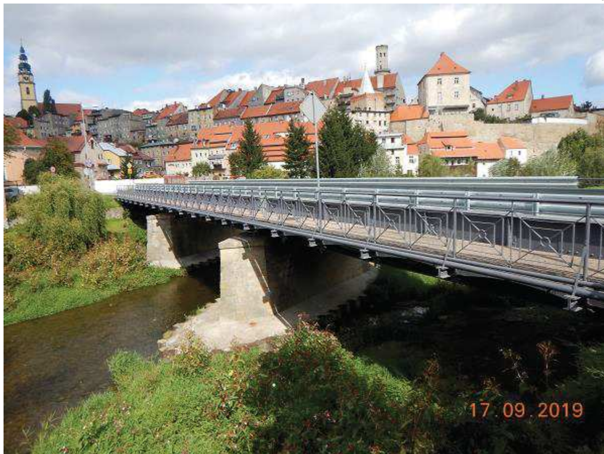
Fot. 23 Udrożnienie koryta w obrębie prawego przęsła mostu M-28 wraz z wykształceniem koryta dwudzielnego na odcinku 150+645 – 150+696 (BP)
