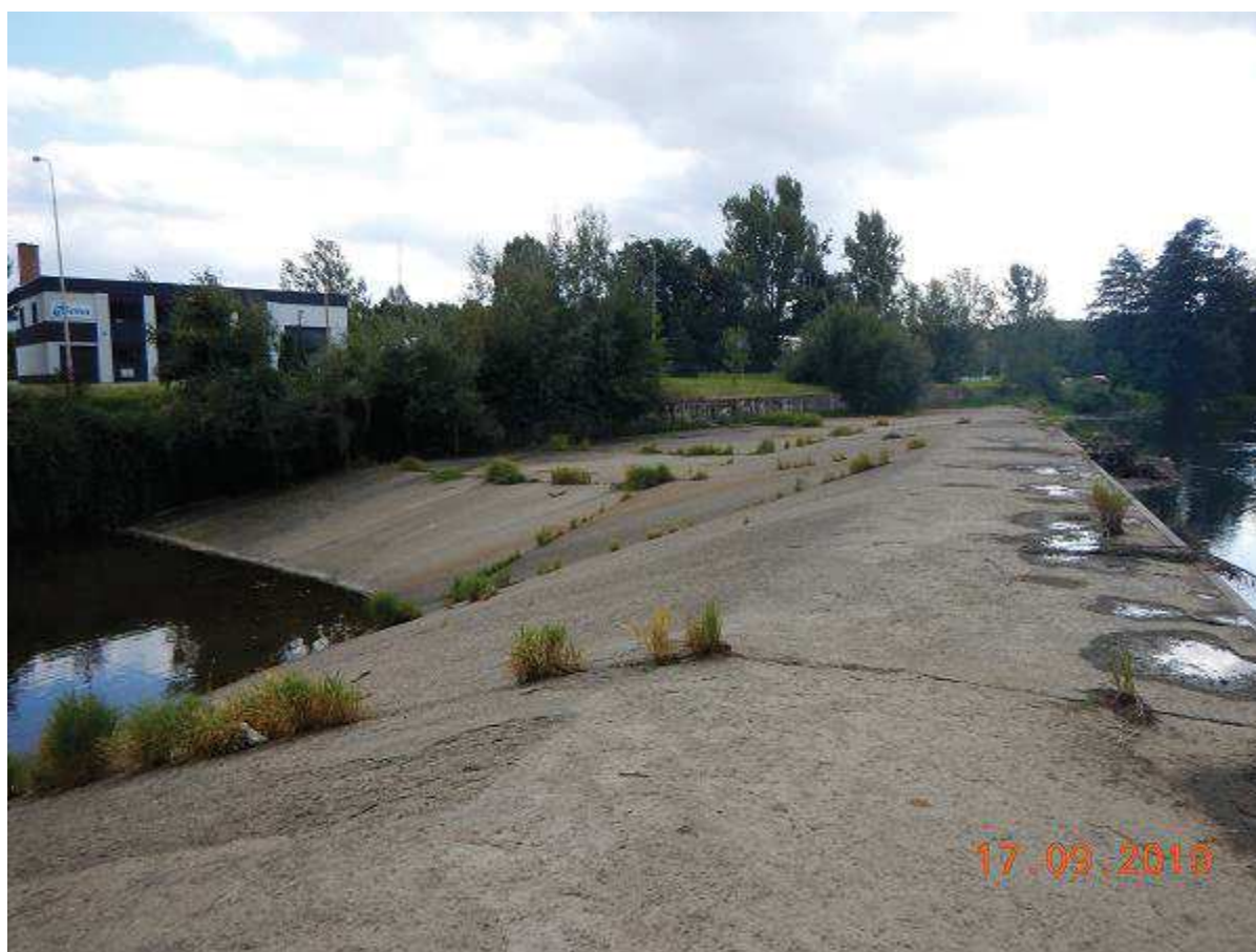
Fot. 10 Remont jazu H-11 w km 148+894 wraz z wykonaniem przepławki dla ryb
