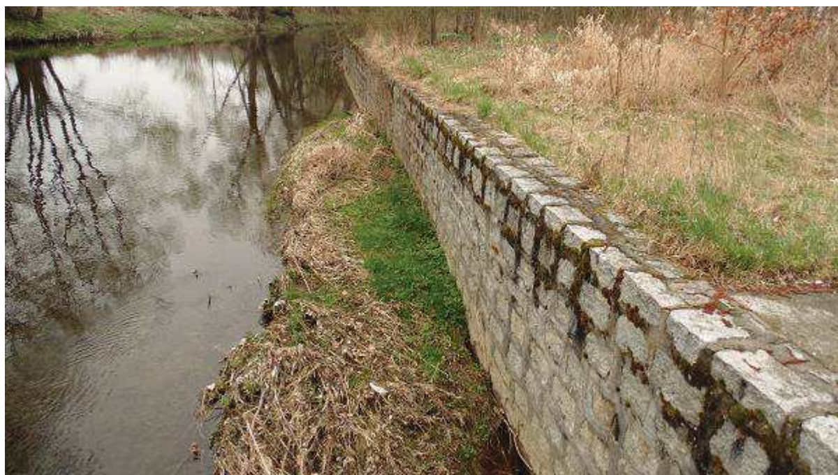
Fot. 30 Reprofilacja muru na odcinku 150+368 – 151+508 (BL)
