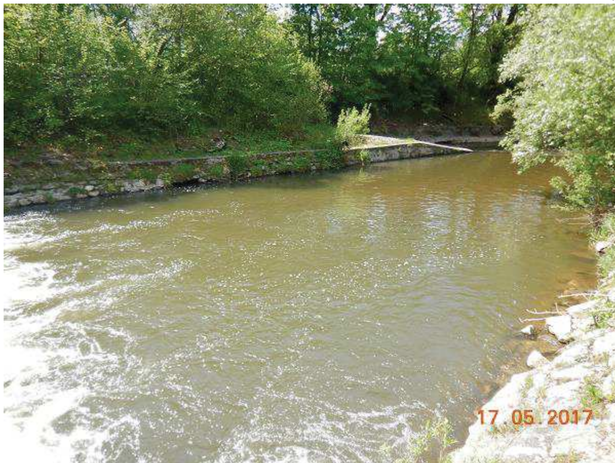
Fot. 3 Reprofilacja muru na odcinku 148+194 – 148+219 (BL)
