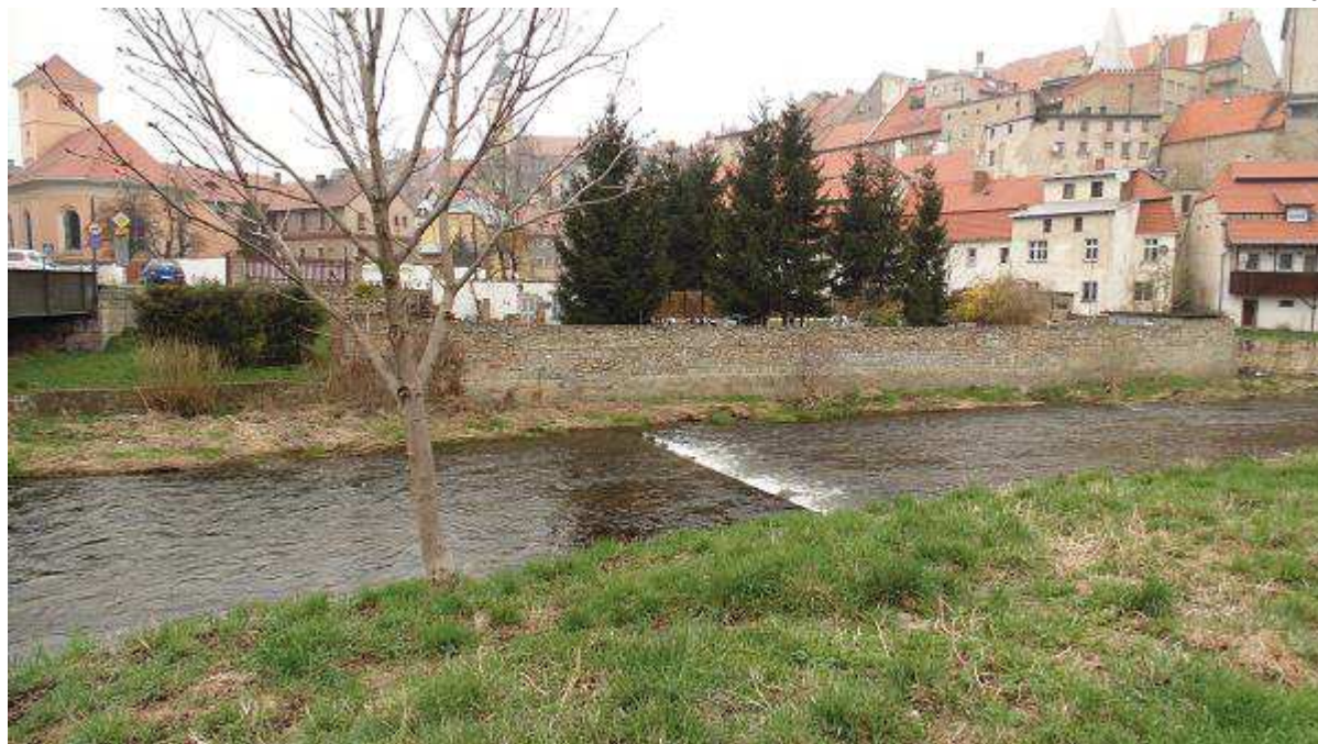
Fot. 21 Udrożnienie koryta w obrębie lewego przęsła mostu M-28 wraz z wykształceniem koryta dwudzielnego na odcinku 150+598 – 150+680 (BL) oraz reprofilacja muru na odcinku 150+589 – 150+651 (BL) - ujściowy odcinek potoku Bystrzyca
