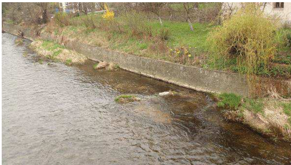
Fot. 24 Reprofilacja muru na odcinku 150+660 – 150+857 (BL)
