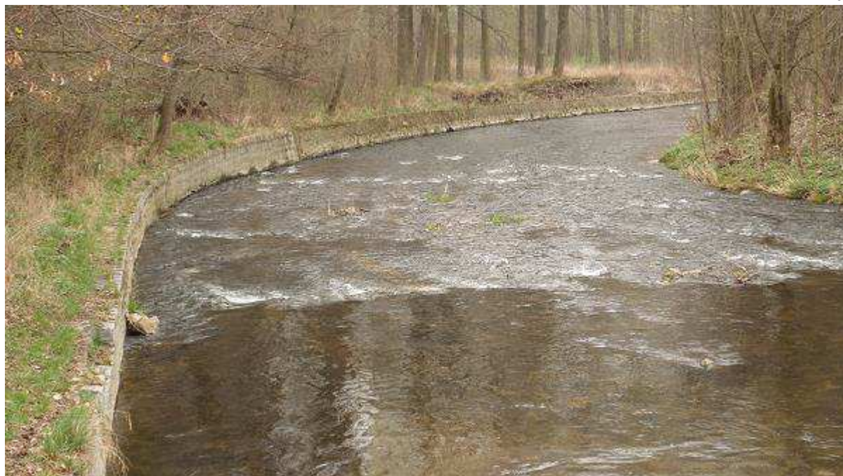
Fot. 29 Reprofilacja muru na odcinku 150+368 – 151+508 (BL)
