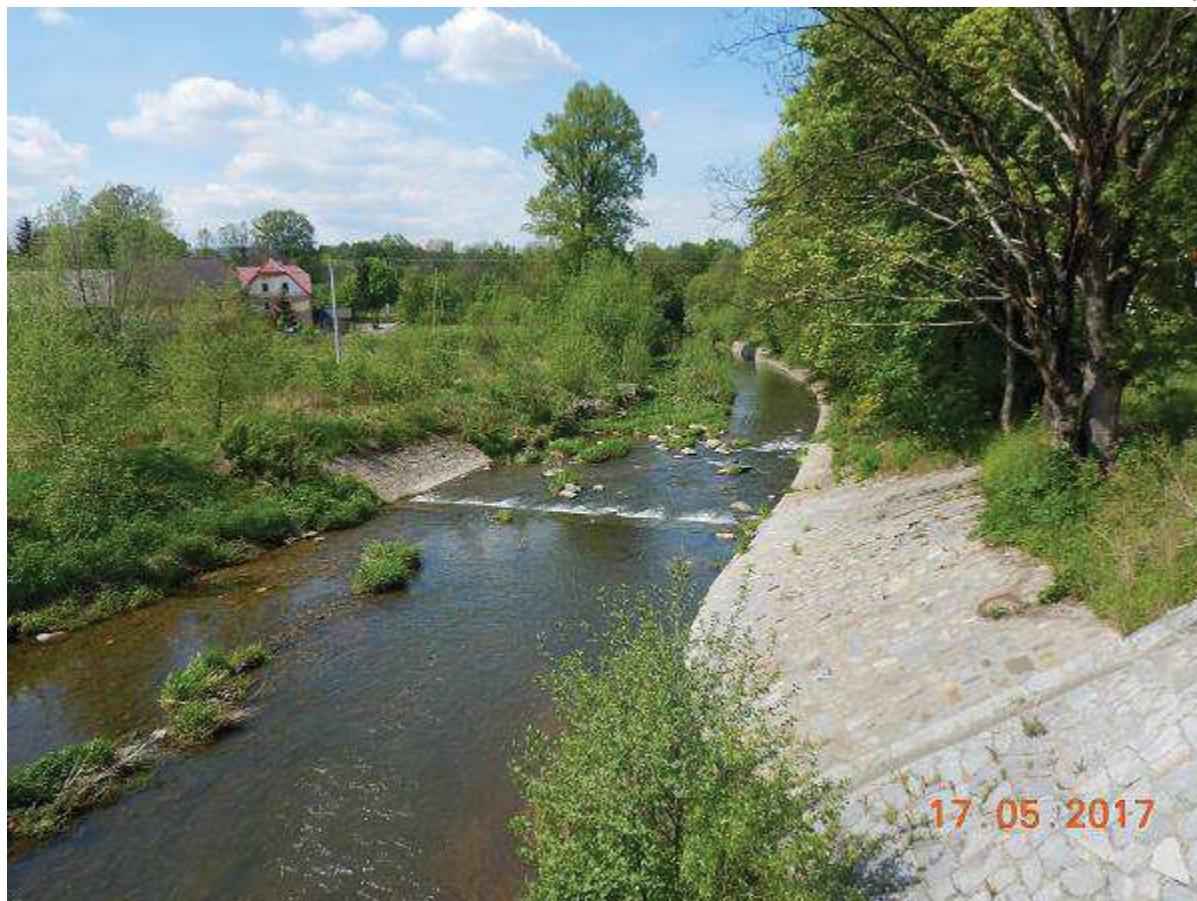
Fot. 7 Udrożnienie koryta poniżej progu H-9 na odcinku 148+277 – 148+350 (BL)
