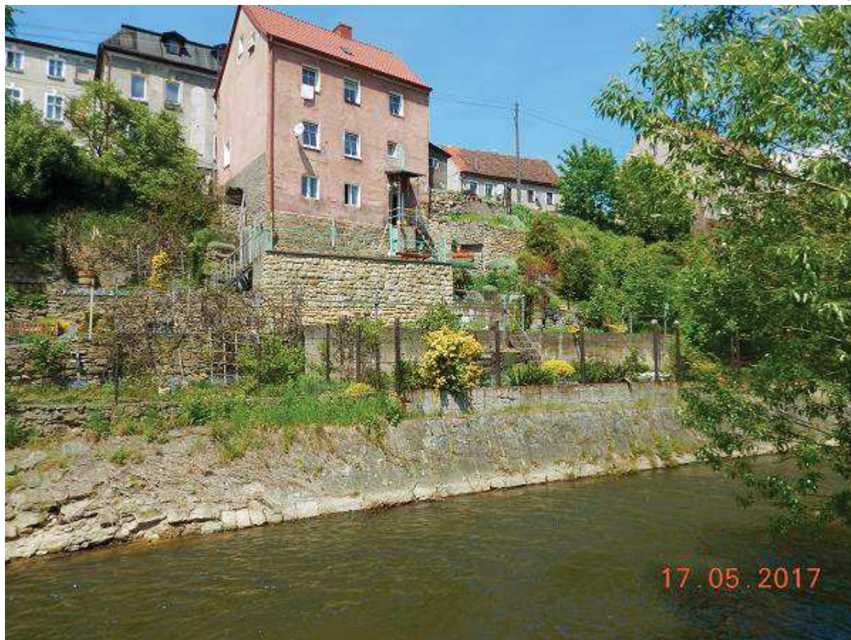
Fot. 25 Reprofilacja muru na odcinku 150+660 – 150+857 (BL)
