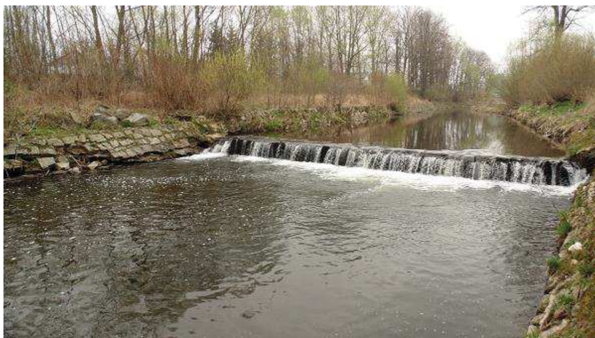
Fot. 6 Przebudowa progu H-9 w km 148+226 na bystrze
