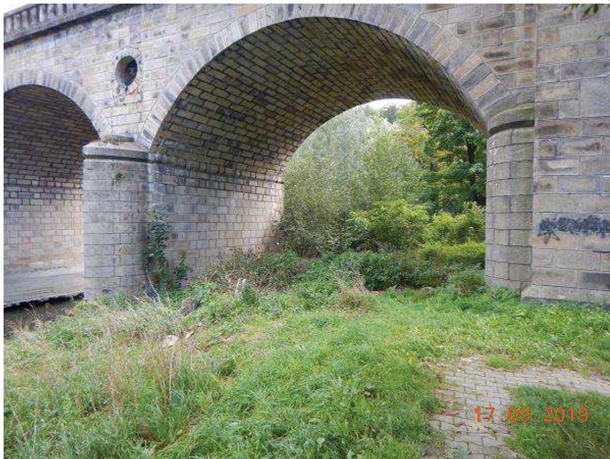
Fot. 17 Reprofilacja skarpy na odcinku 150+425 – 150+457 (BP) oraz udrożnienie koryta w obrębie prawego przęsła mostu M-27 wraz z wykształceniem koryta dwudzielnego na odcinku 150+436 – 150+454 (BP)
