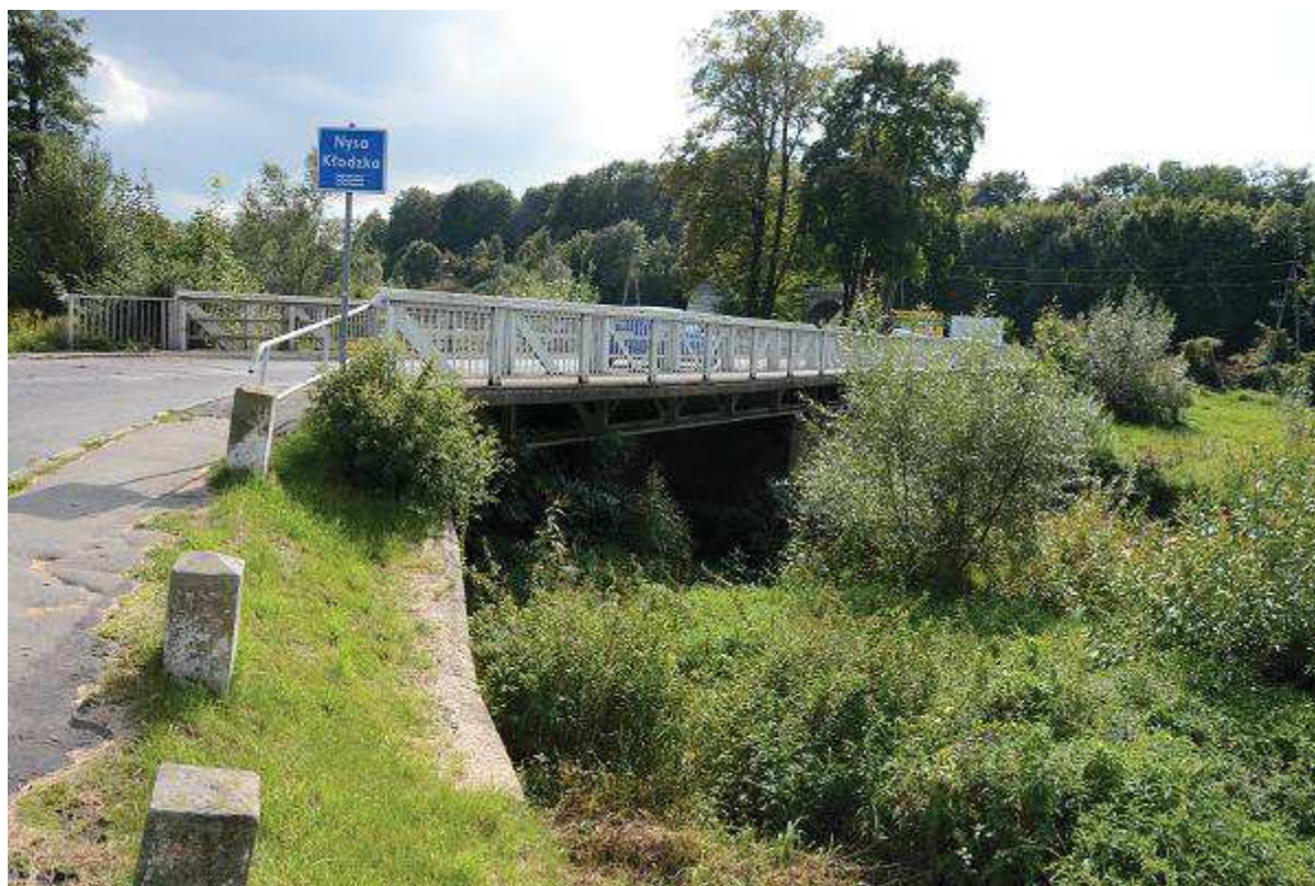
Fot. 12 Udrożnienie koryta w obrębie prawego przęsła mostu M-25 wraz z wykształceniem koryta dwudzielnego na odcinku 149+292 – 149+377
