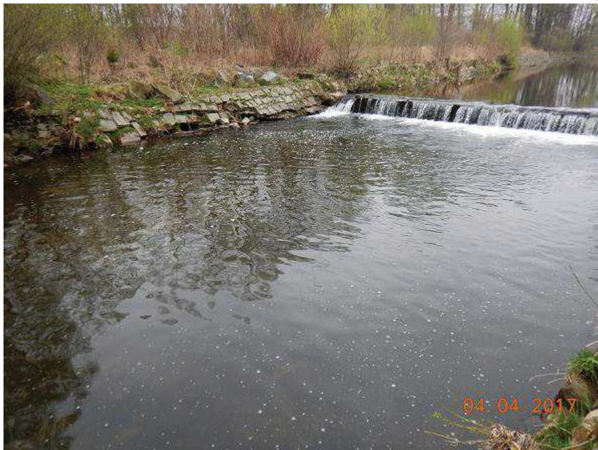
Fot. 5 Reprofilacja skarpy na odcinku 148+213 – 148+235 (BP)
