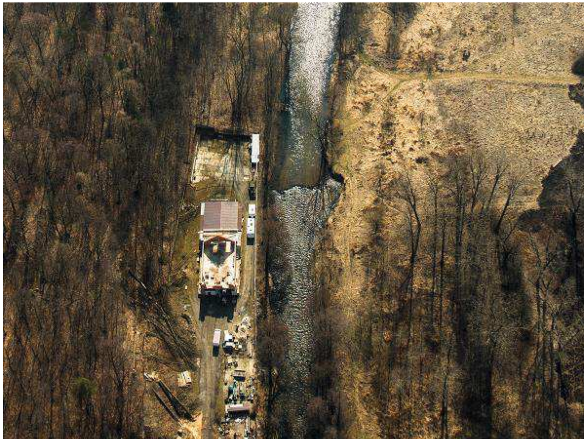
Fot. 15 Budowa ubezpieczeń brzegowych na odcinku 149+712 – 149+779 (BL)
