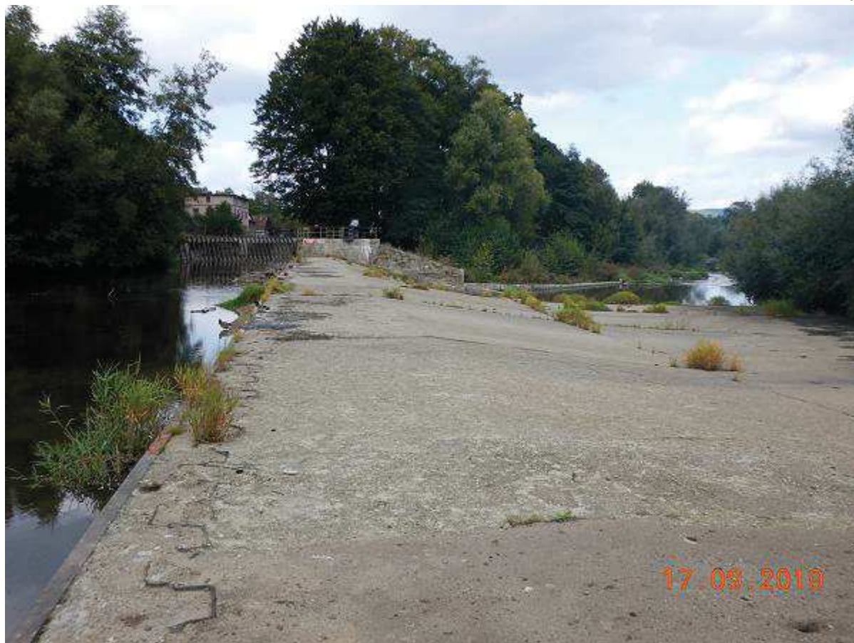
Fot. 11 Remont jazu H-11 w km 148+894 wraz z wykonaniem przepławki dla ryb
