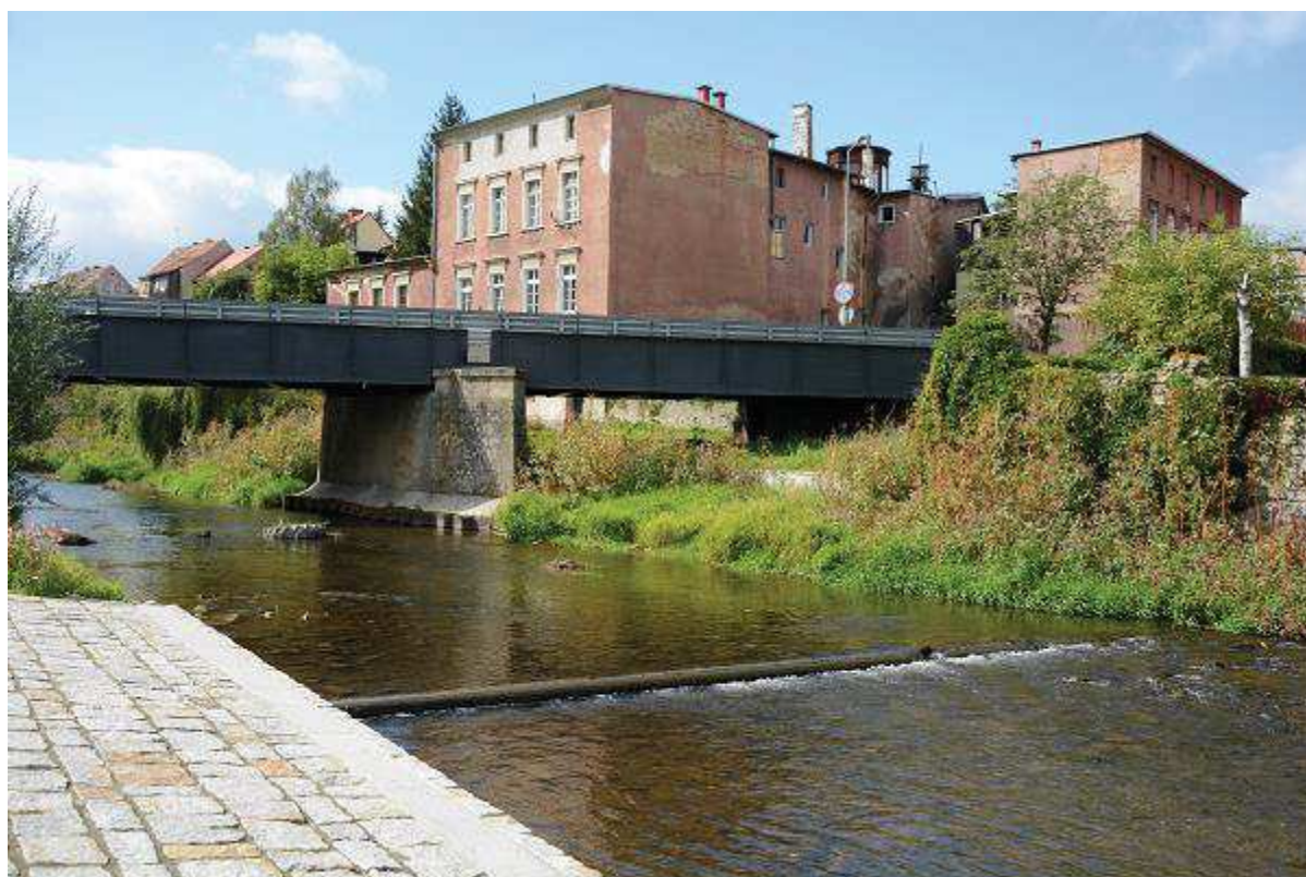
Fot. 20 Udrożnienie koryta w obrębie lewego przęsła mostu M-28 wraz z wykształceniem koryta dwudzielnego na odcinku 150+598 – 150+680 (BL)
