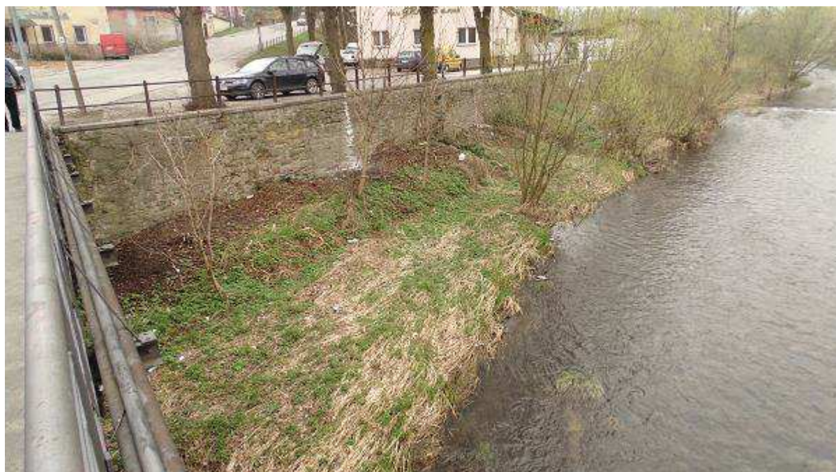
Fot. 26 Reprofilacja muru na odcinku 150+673 – 150+730 (BP)
