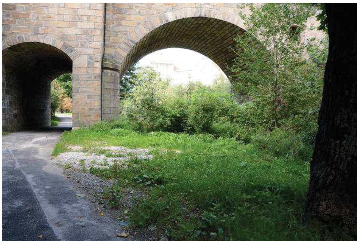
Fot. 16 Reprofilacja skarpy na odcinku 150+425 – 150+457 (BP) oraz udrożnienie koryta w obrębie prawego przęsła mostu M-27 wraz z wykształceniem koryta dwudzielnego na odcinku 150+436 – 150+454 (BP)
