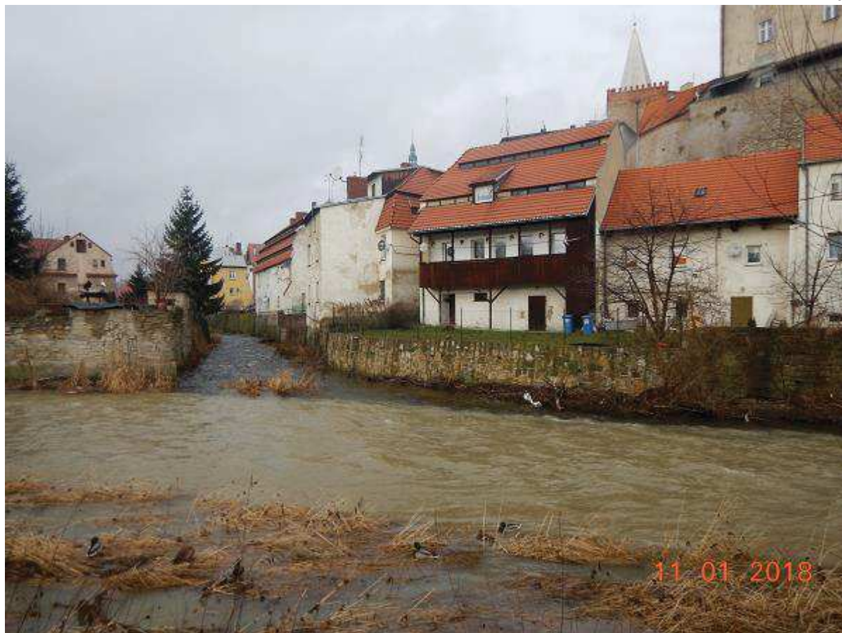
Fot. 19 Reprofilacja muru na odcinku 150+510 - 150+589 (BL) - ujściowy odcinek potoku Bystrzyca oraz reprofilacja muru na odcinku 150+589 – 150+651 (BL) - ujściowy odcinek potoku Bystrzyca
