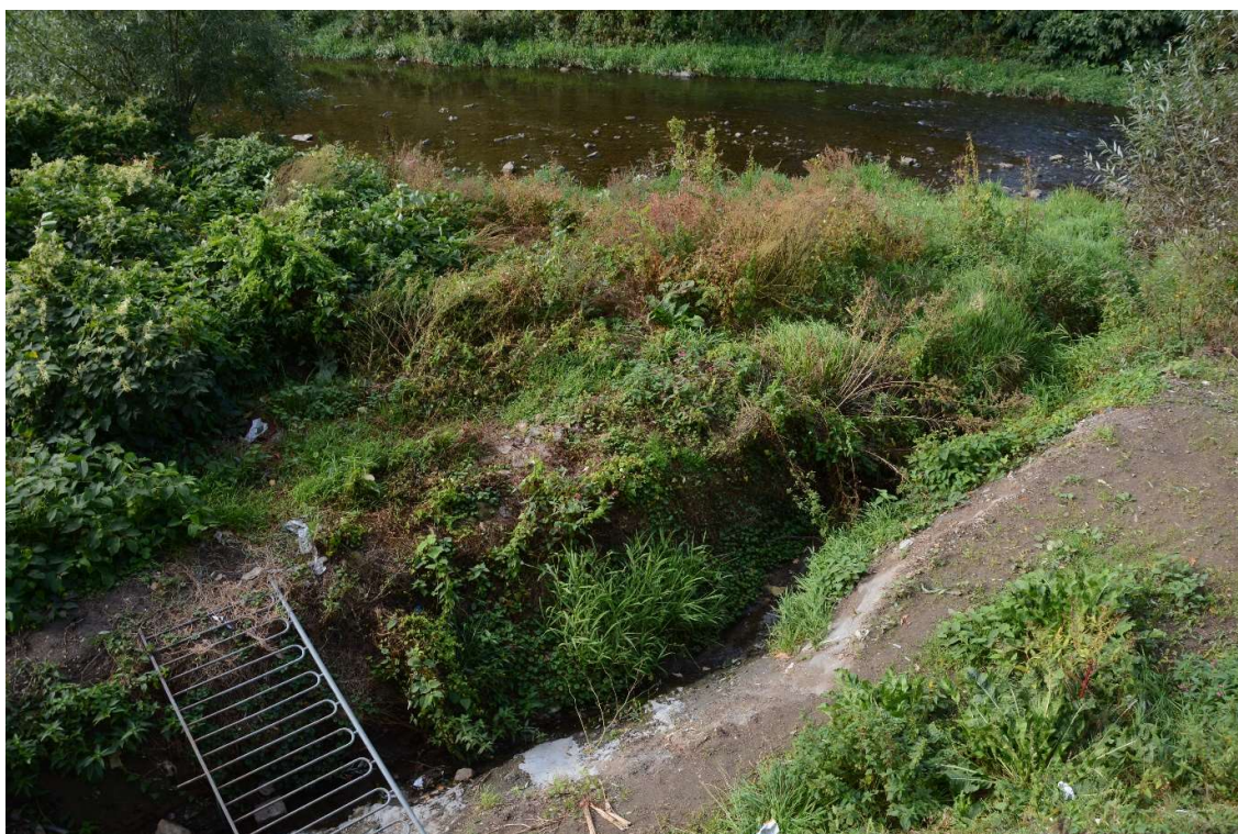
Fot. 16. Ukształtowanie linii brzegowej, remont ujściowego odcinka rowu w km 130+220 – 130+370 (BP).
