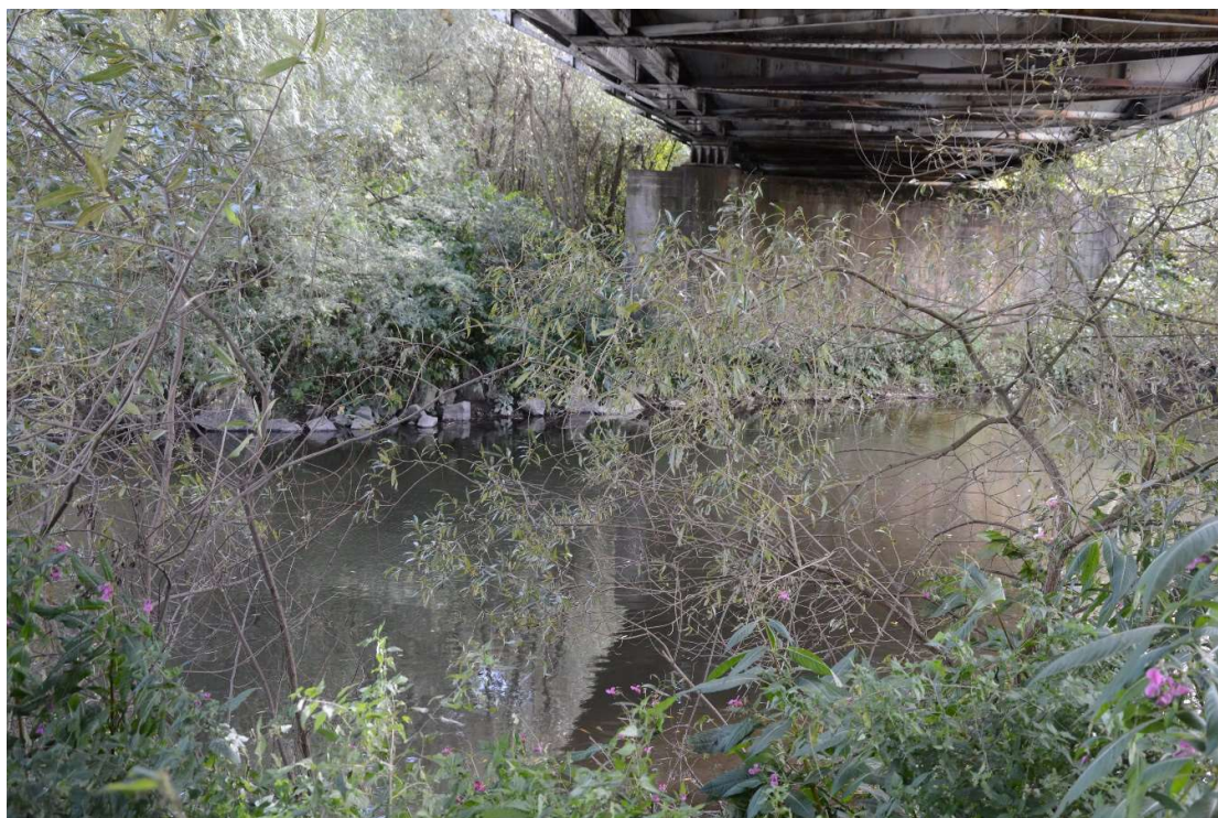
Fot. 4. Udrożnienie światła mostu M-8 w km 128+145.
