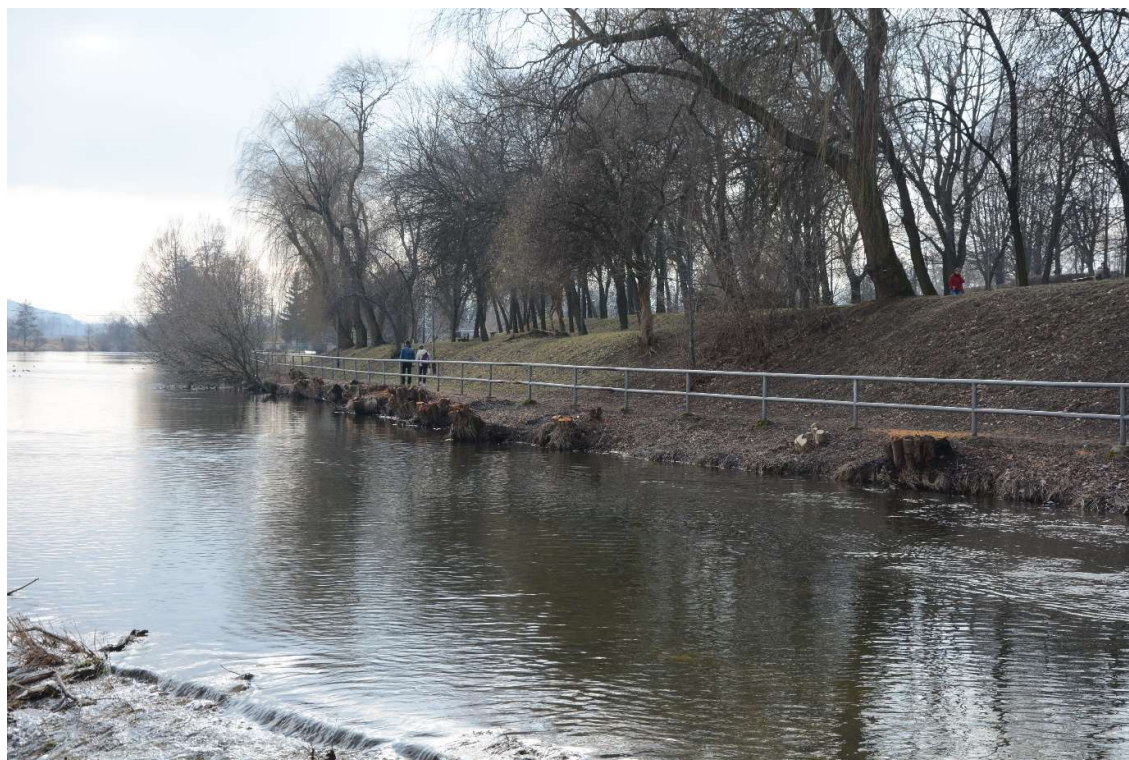
Fot. 27 Budowa muru regulacyjnego w km 130+950 ÷ 131+150 (BL)
