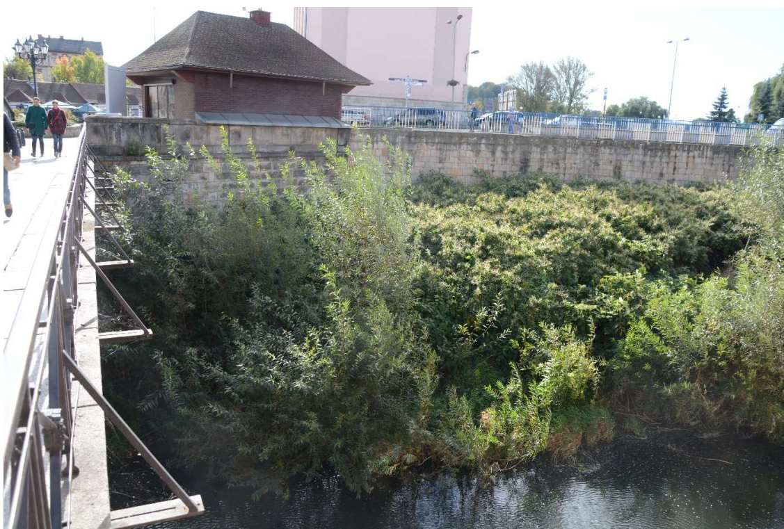
Fot. 14. Udrożnienie światła mostu M-11 w km 130+203.
