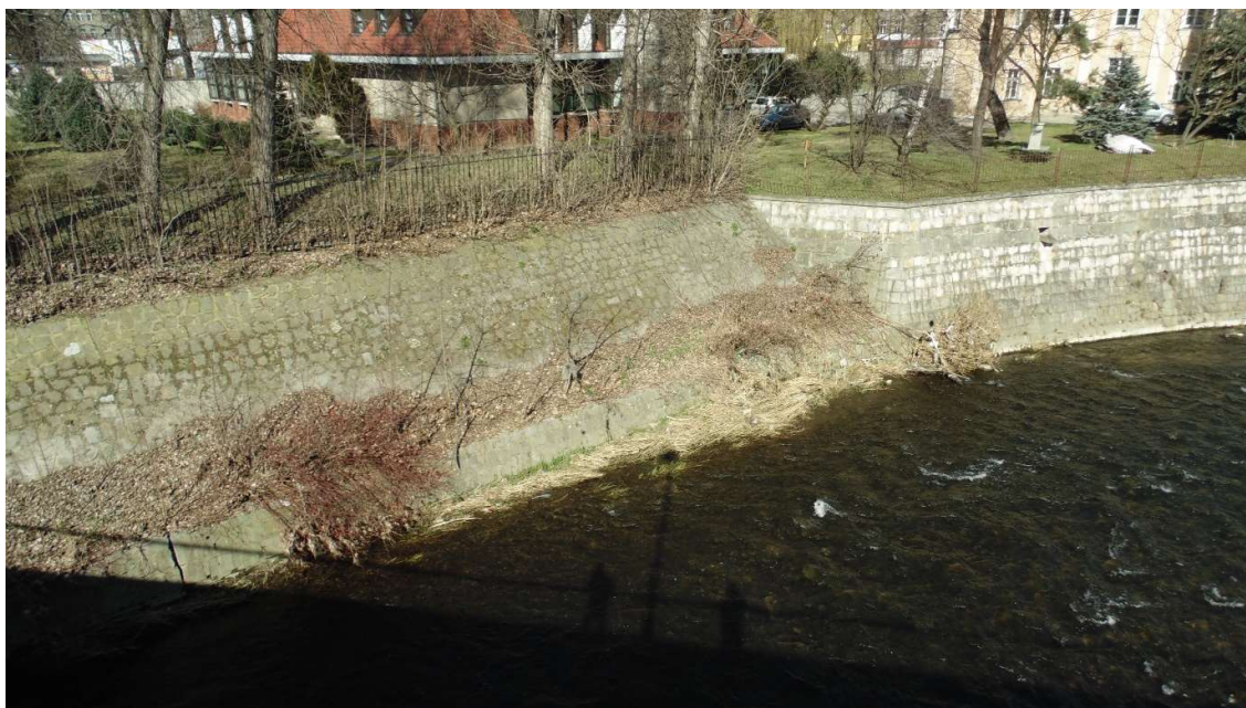
Fot. 15. Remont ubezpieczenia brzegowego w km 130+300÷ 130+380 (BL).
