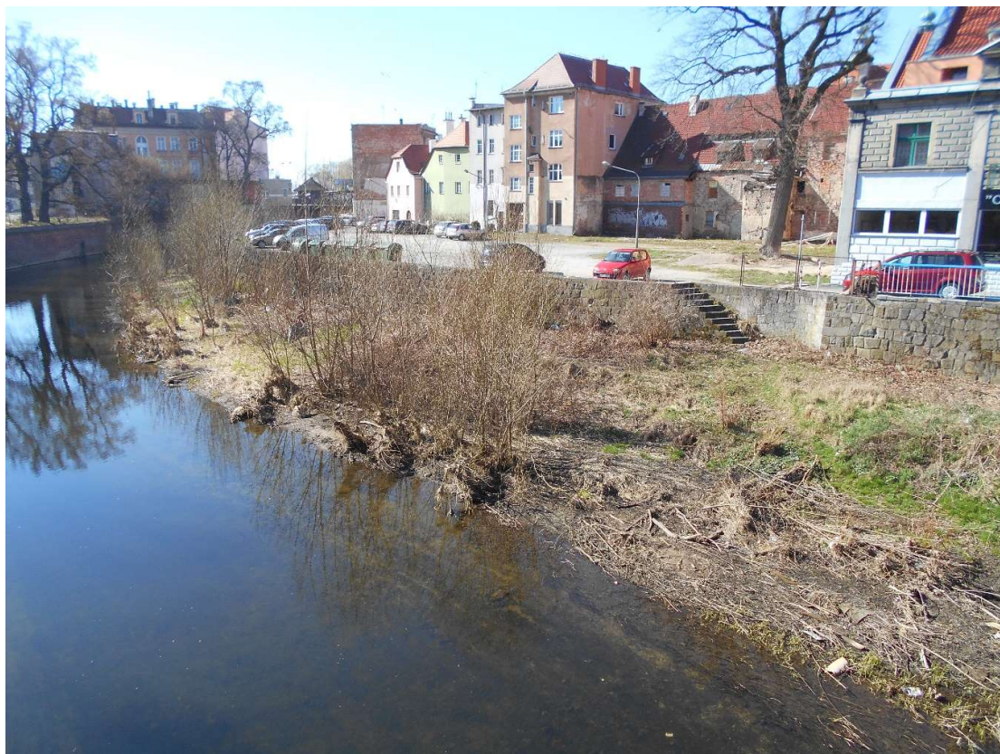
Fot. 10. Reprofilacja muru, ukształtowanie linii brzegowej w postaci półki w km 129+980÷ 130+145 (BL).
