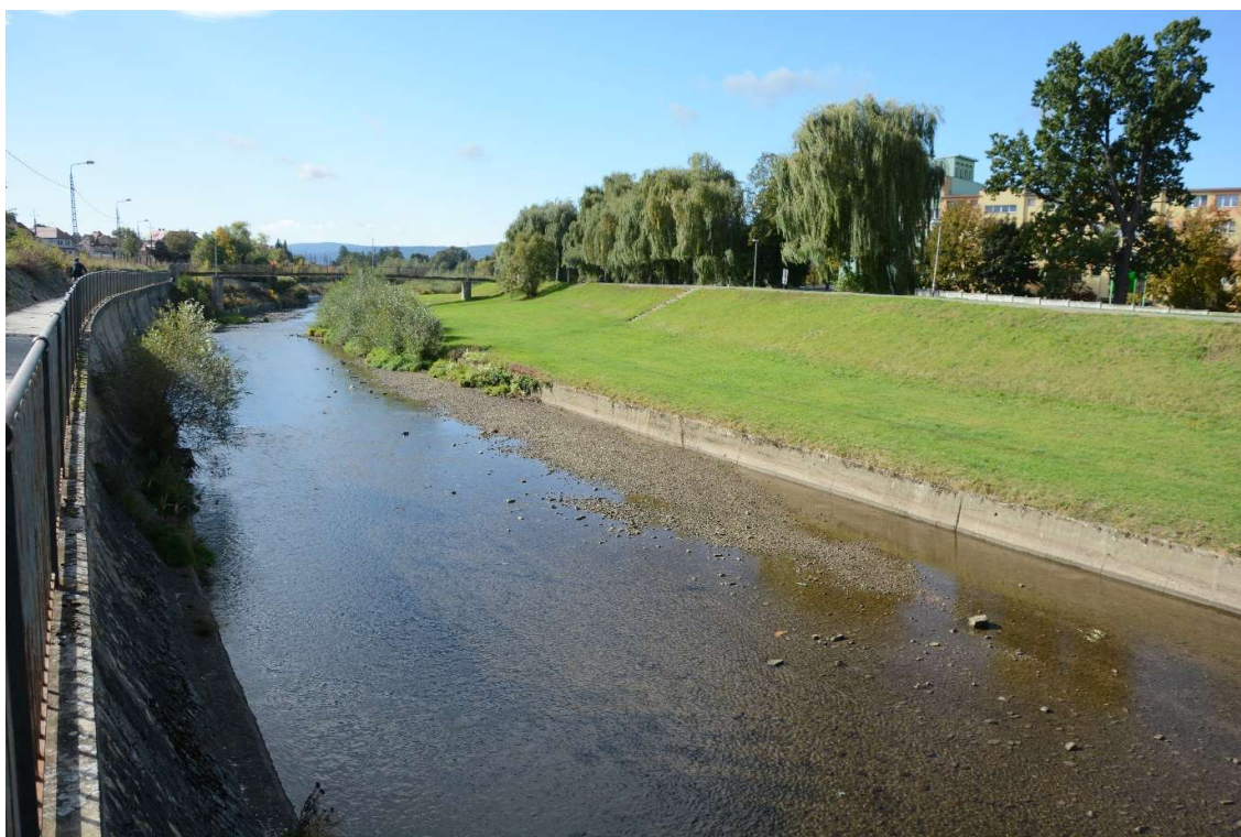
Fot. 18. Rozbiórka i odbudowa muru wraz z budową schodów w km 130+335÷ 130+880 (BL). Remont ubezpieczeń brzegowych w km 130+380÷ 130+625 (BP)
