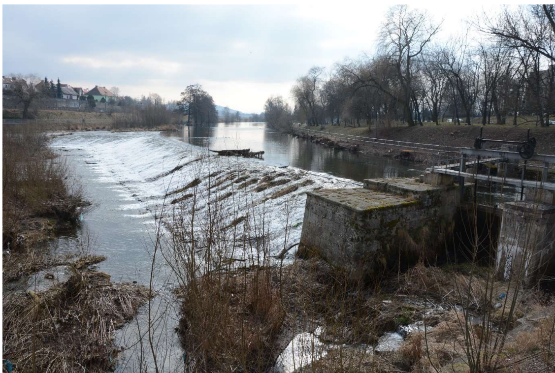
Fot. 24 Przebudowa jazu H-4 wraz z budową przepławki w km 131+050.
