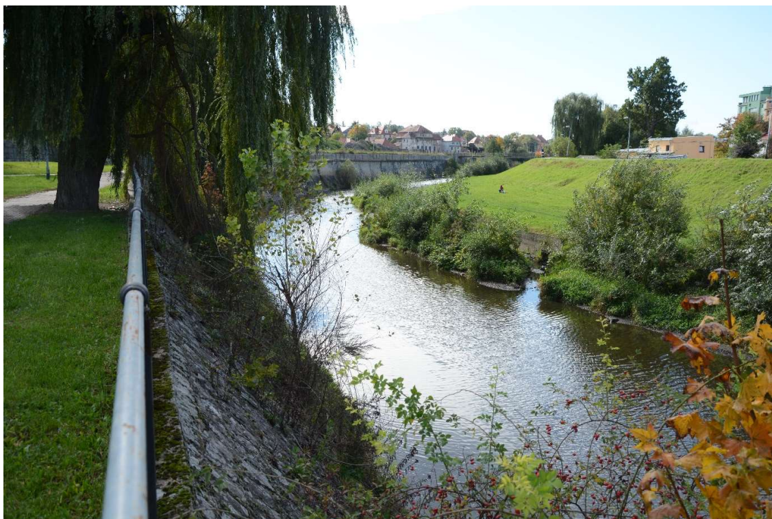
Fot. 17. Rozbiórka i odbudowa muru w km 130+335 ÷ 130+880 (BL). Remont ubezpieczeń brzegowych w km 130+380 ÷ 130+625 (BP)
