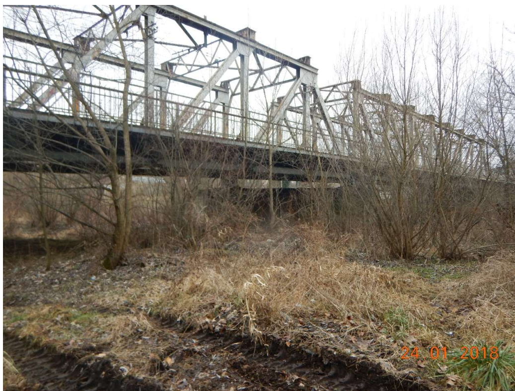
Fot. 3. Udrożnienie światła mostu M-8 w km 128+145.
