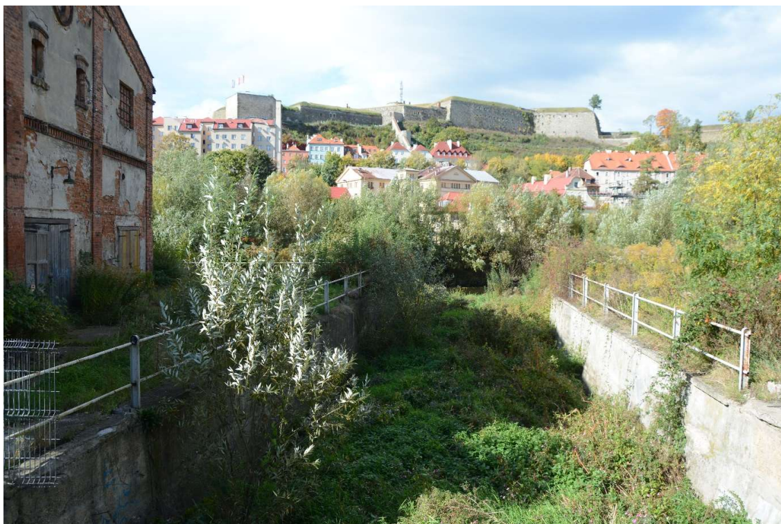
Fot. 8. Remont ujściowego odcinka potoku Jodłownik w km 129+875 (BP), z ukształtowaniem koryta dwudzielnego.
