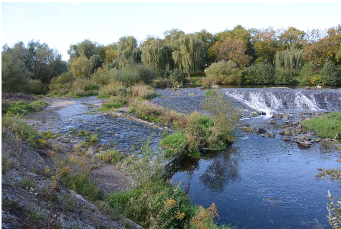
Fot. 23 Przebudowa jazu H-4 wraz z budową przepławki w km 131+050.
