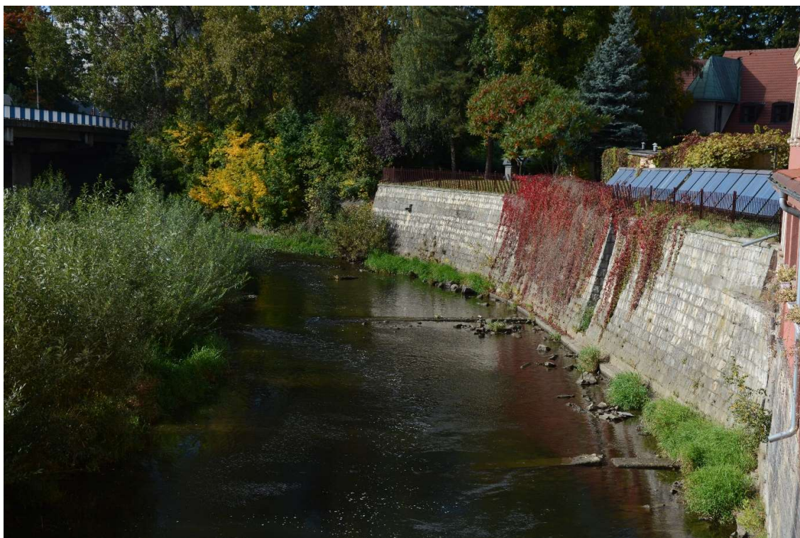
Fot. 13. Reprofilacja muru i odbudowa gurtów w km 130+145÷ 130+300 (BL).
