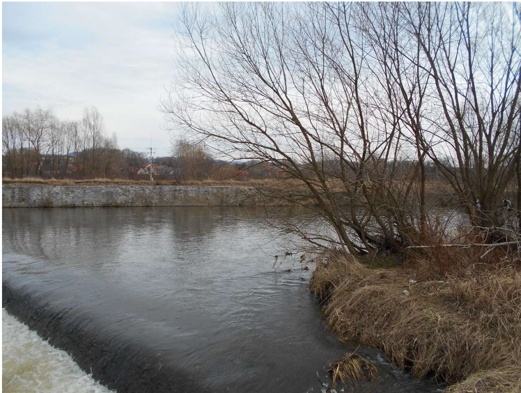
Fot. 1. Remont ubezpieczeń brzegowych i usunięcie odsypiska w km 127+433 ÷ 127+520 (BL). Reprofilacja muru w km 127+433 ÷ 127+500 (BP)
