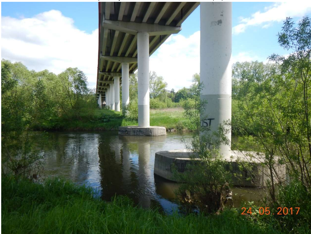
Fot. 2. Udrożnienie światła mostu M-7 w km 127+781.
