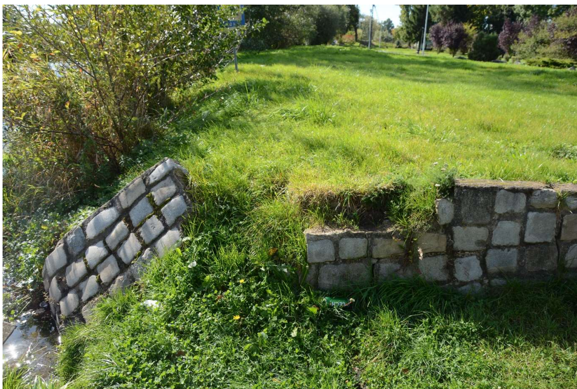
Fot. 26 Przebudowa slipu w km 131+300 (BL)
