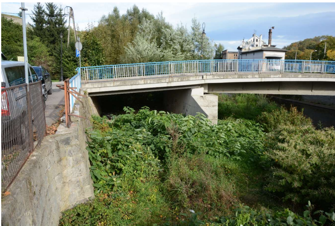
Fot. 9. Udrożnienie światła mostu M-10 w km 130+028.
