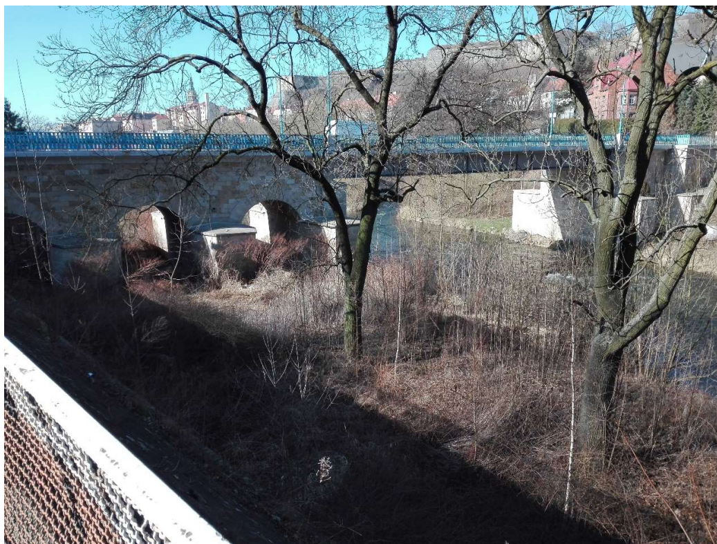
Fot. 6. Udrożnienie światła mostu M-9 w km 129+567.
