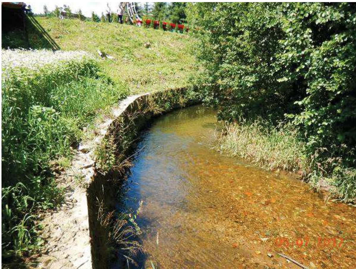
Fot. 21 - Km 174+160 – widok w dół rzeki. Reprofilacja muru na brzegu lewym. Uformowanie skarpy na brzegu prawym
