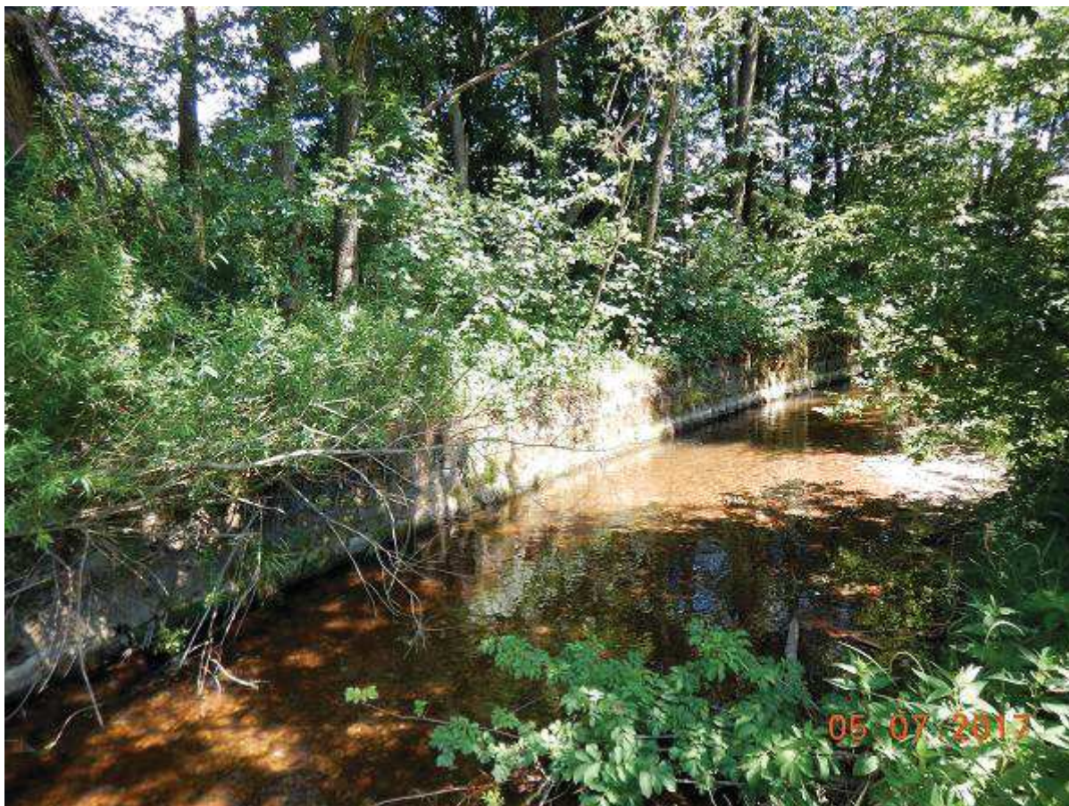
Fot. 22 – Reprofilacja muru prawego w km 174+165 ÷ 174+205
