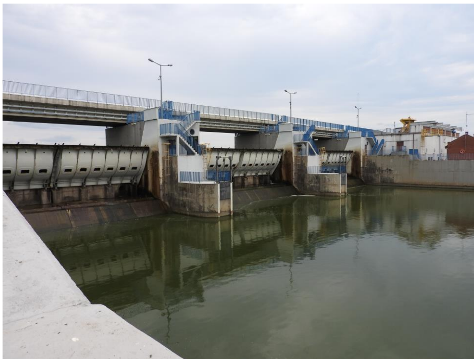
Zapora czołowa zbiornika wodnego Nysa.
