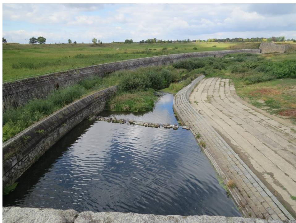
Kanał ulgi służący do bezpiecznego przeprowadzenia wód wezbraniowych.
