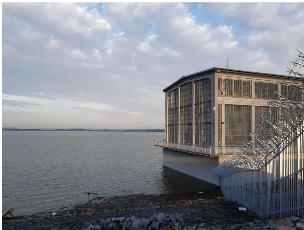
Budynek elektrowni wodnej zbiornika wodnego Otmuchów
