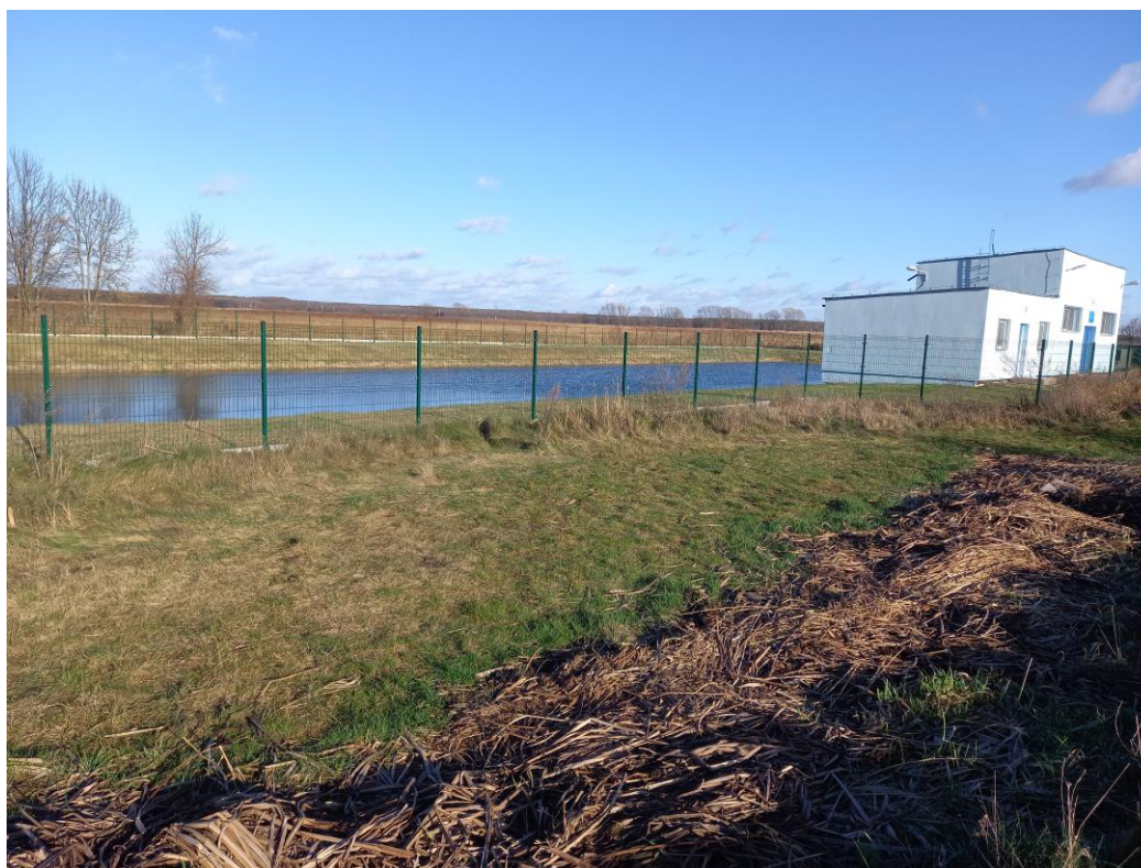
Przepompownia Tarnowa Łąka.
