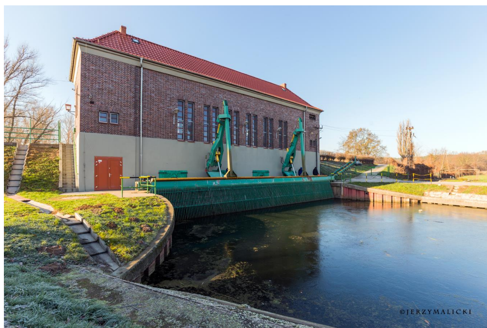
Budynek przepompowni Sadowa.
