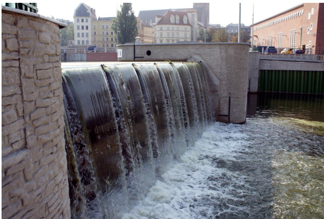
Dwuprzęsłowy jaz Elektrowni Wodnej Wrocław I.
